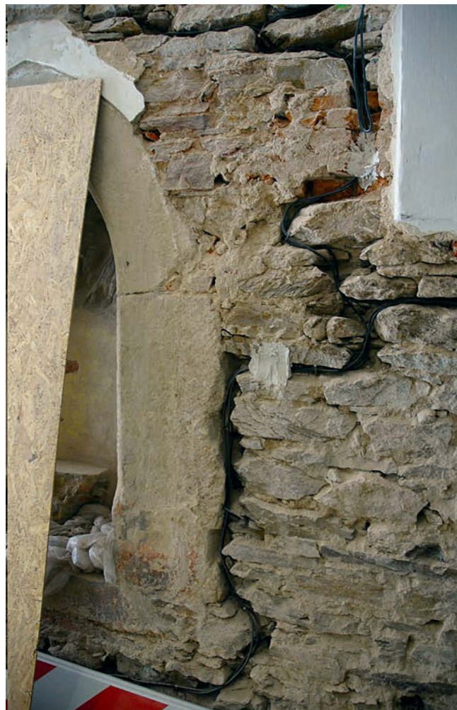
Obr. 14: Kolín, arciděkanství (Brandlova čp. 25), druhotně zazděný gotický portál na východní straně západní zdi vstupní chodby, detail provázání s okolním zdivem, stav 2015.
