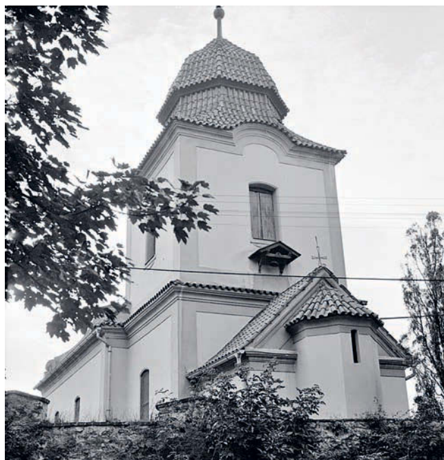
Obr. 3: Bylany, kostel sv. Bartoloměje, pohled od jihovýchodu. Stav po provedené opravě fasády, září 1987 (foto P. Vácha, fotoarchiv NPÚ ÚOP SČ v Praze).
