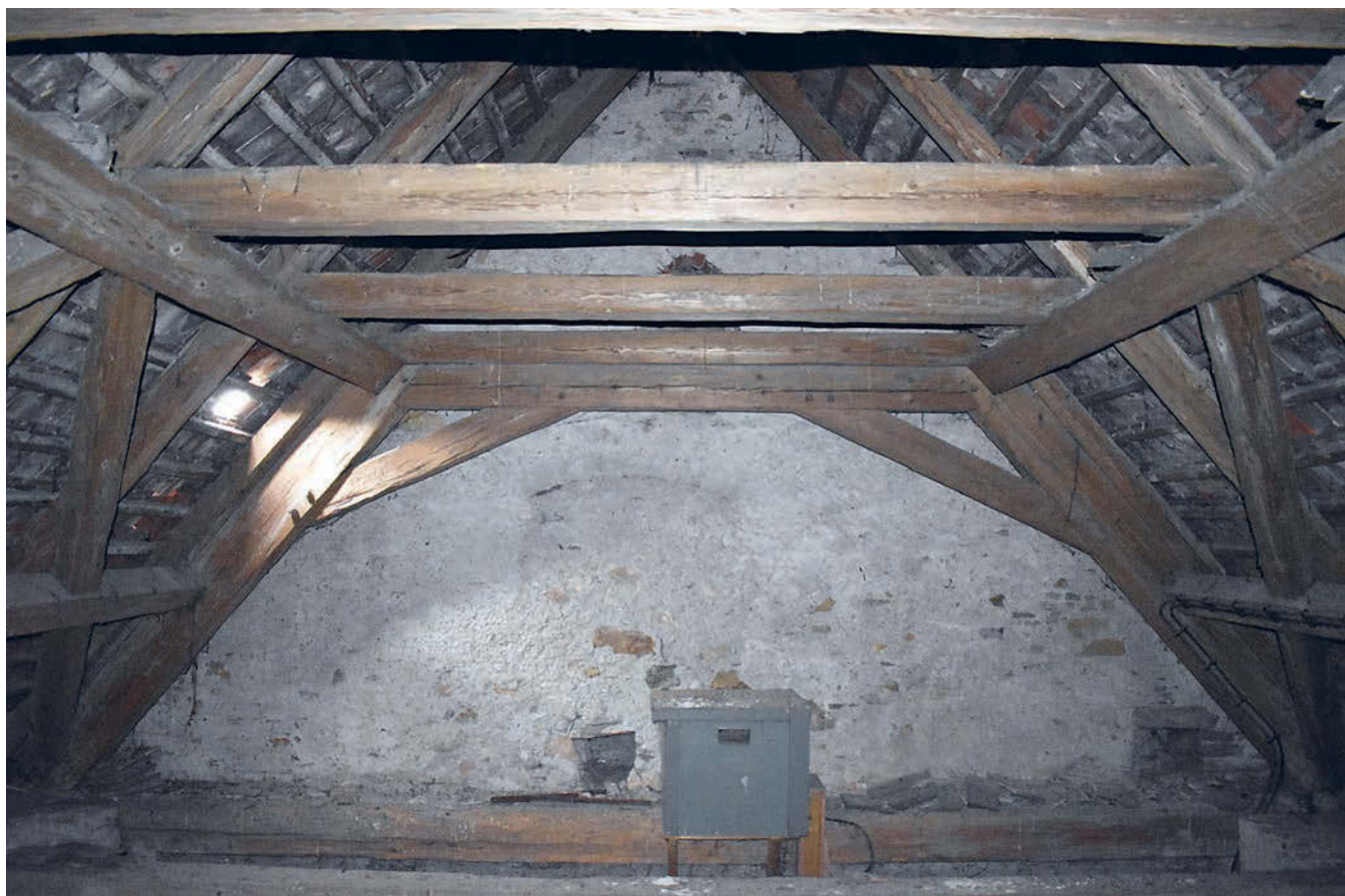
Obr. 11: Bylany, kostel sv. Bartoloměje, podkroví nad lodí, pohled k západnímu štítu (foto K. Kibic, 2022).
