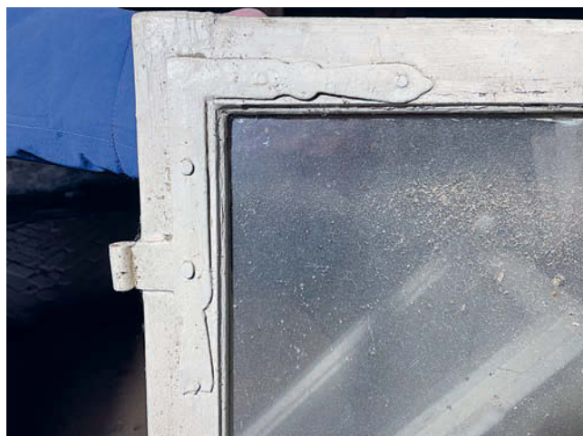
Obr. 23: Druhotně použitý barokní koutový závěs na okenním křídle, pravděpodobně z rekonstrukce v roce 1872, dnes deponováno na krovu chléva.
