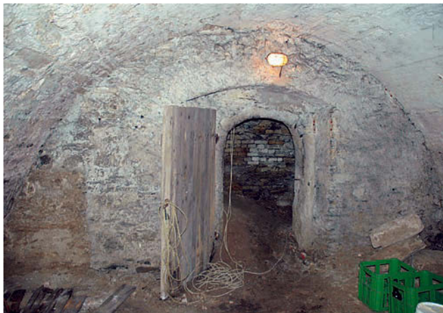
Obr. 8: Kolín, arciděkanství (Brandlova čp. 25), klenba v jižní části suterénu, pohled od severu na dělicí příčku mezi jižním a středním sklepem s gotickým portálem, stav 2015.
