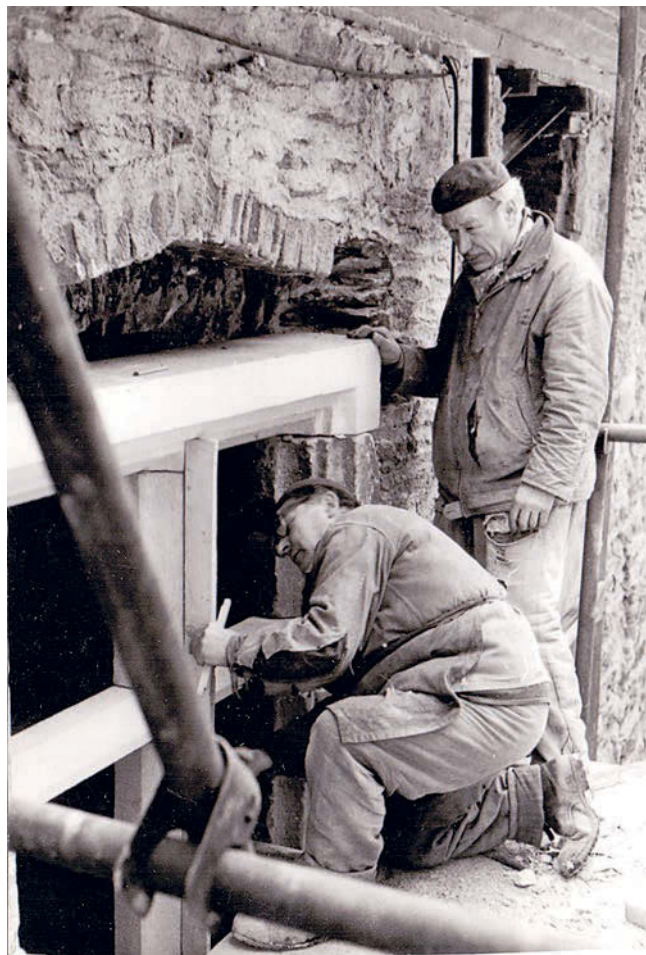
Obr. 17: Kolín, dům čp. 27 (Brandlova ul.), rekonstrukce jižního gotického okna přízemí kameníky Taschem a Hlavatým, stav 1983 (foto A. Váňa, Archiv Regionálního muzea v Kolíně).
