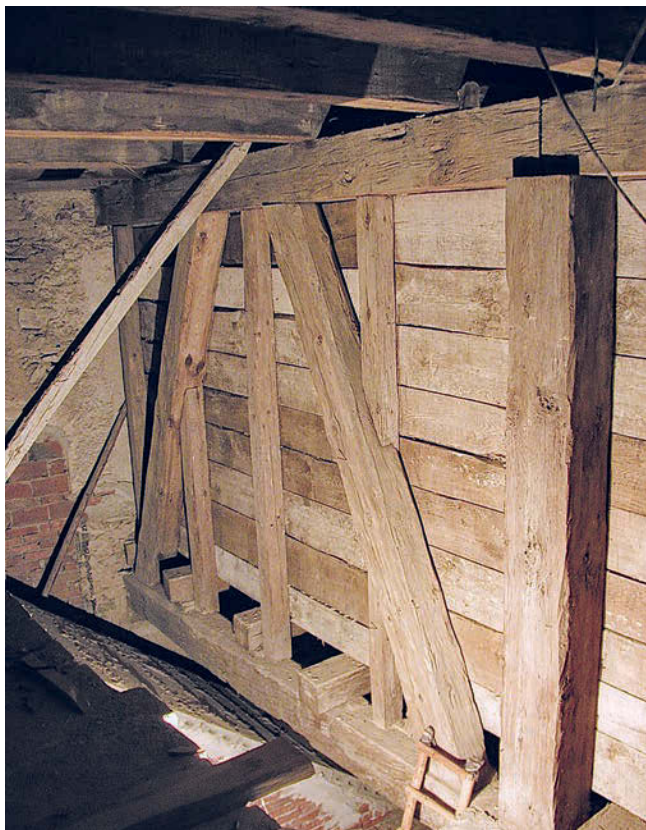
Obr. 18: Dalešice (okres Třebíč), zámek, konstrukce stěny spojující chodby (foto J. Bláha, 2010).
