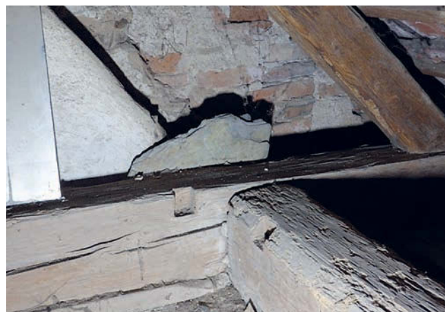
Obr. 17: Fara, podkroví, dlaby po zaniklé latové konstrukci, cihelná nadezdívka severního štítu, pohled z jihozápadu.
