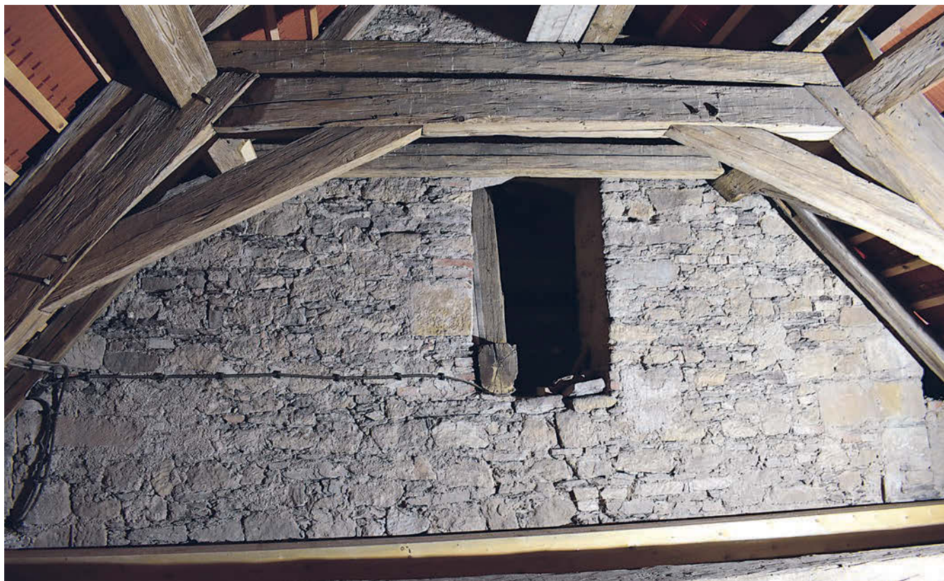
Obr. 13: Bylany, kostel sv. Bartoloměje, pohled na zdivo věže z podkroví lodi (foto K. Kibic, 2024).
