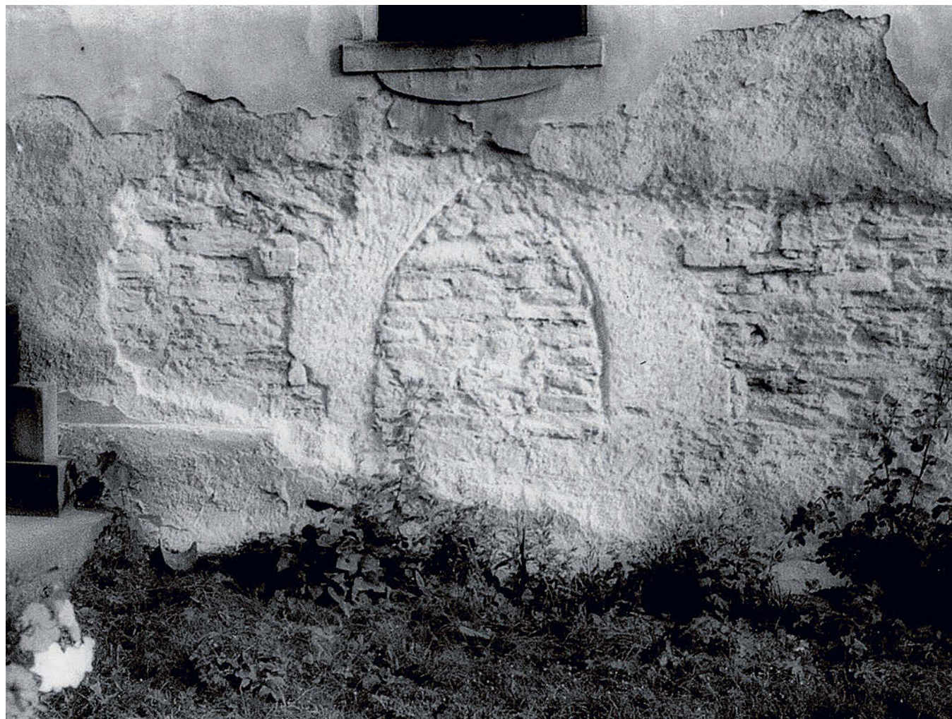
Obr. 4: Bylany, kostel sv. Bartoloměje, gotický portál odkrytý na severní straně lodi při opravě roku 1982. Portál se nacházel pod východnějším oknem, viz vyznačení v půdorysu (obr. 7). Podle snímku měl patrně jednoduchou profilaci, snad jen s okosenou hranou (Podlipanské muzeum v Českém Brodě, podsběrka fotografií).
