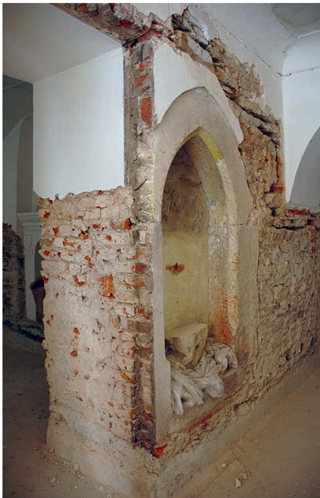
Obr. 13: Kolín, arciděkanství (Brandlova čp. 25), druhotně zazděný gotický portál na východní straně západní zdi vstupní chodby, stav 2015.
