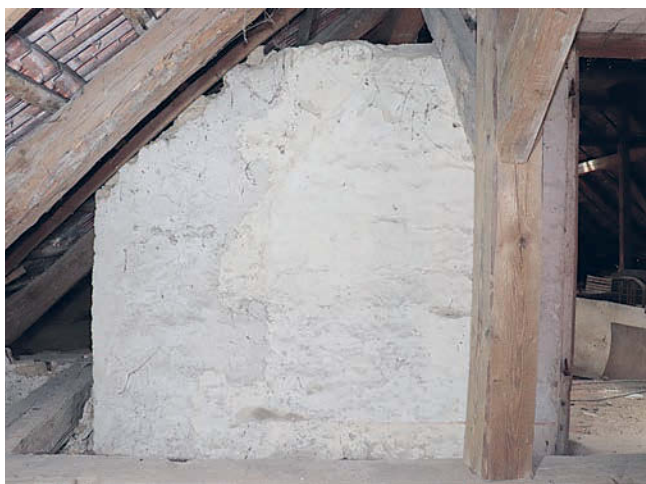
Obr. 13: Fara, podkroví, zděná přička severního dílu s otisky zaniklé dřevěné klenby a malovaným soklem, pohled od severu, stav 2023.
