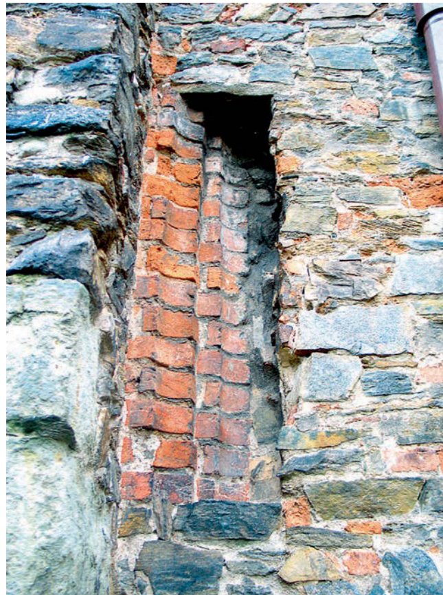
Obr. 21: Kolín, arciděkanství (Brandlova čp. 25), fragment levé stojky ostění druhotně zazděného gotického okna v západní zdi místnosti v přízemí severovýchodního křídla, stav 2014.
