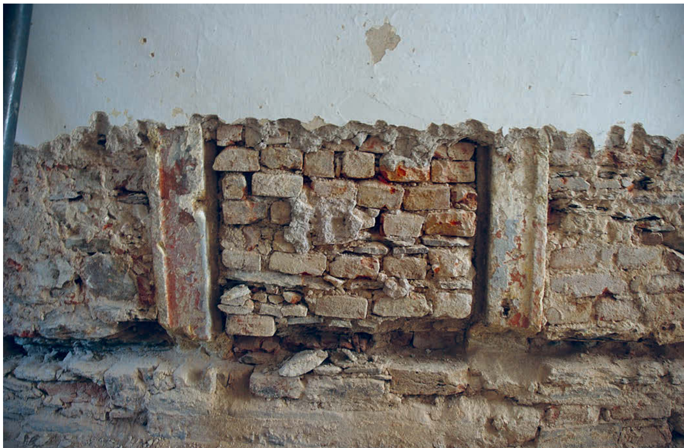
Obr. 24: Kolín, arciděkanství (Brandlova čp. 25), fragment barokního ostění příkladacího otvoru ve východní zdi vstupní chodby, stav 2015.
