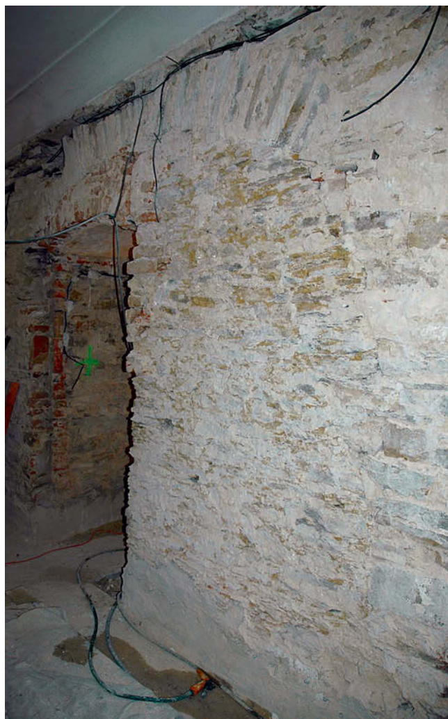
Obr. 10: Kolín, arciděkanství (Brandlová čp. 25), druhotně zazděná půlkruhová arkáda v zadní části západní zdi vstupní chodby, pohled z chodby, stav 2015.
