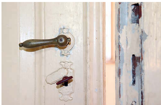
Obr. 22: Fara, přízemí, příklad většinově zastoupeného dveřního kování, pravděpodobně z rekonstrukce v roce 1872, stav 2023.
