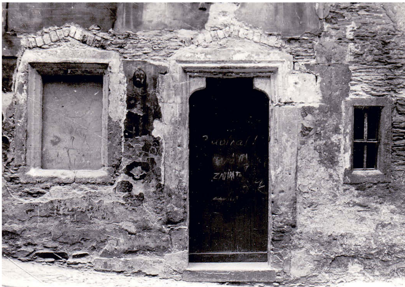
Obr. 18: Kolín, dům čp. 23 (Karlova ul.), gotický portál a gotická okna na východní fasádě, stav 1959 (foto L. Kamarýt, Archiv Regionálního muzea v Kolíně).
