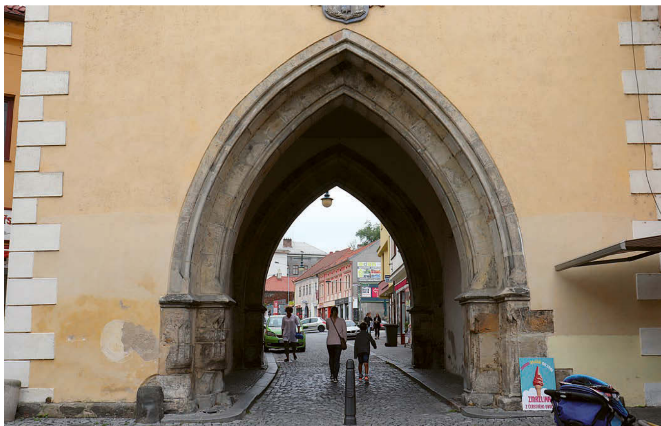
Obr. 1: Beroun, Horní (Plzeňská) brána, východní portál, pohled z východu (foto F. Facincani, 2023).
