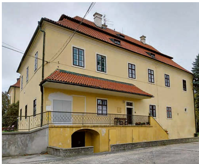
Obr. 6: Hořovice, Starý zámek, pohled od východu. Patrný je drobný zlom korunní římsy v pravé části fasády, kde dochované zdivo starší věže s malým oknem místnosti č. 1.05 pohledově splývá s barokním zdivem východního křídla. (foto M. Fliedrová, 2024).
