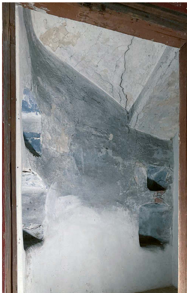
Obr. 33: Hořovice, Starý zámek, přízemí východního křídla. Komůrka se čtyřmi malými nikami v koutě místnosti (č. 1.04) pod schody do věže sloužila jako záchod, stav 2024.
