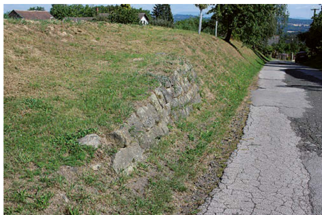
Obr. 6: Boháňka (okres Jičín), stará jednostranná úvozová cesta se změnila na silnici, výjezd na pole musel překonat výškový rozdíl, zde je výjezd již nefunkční, ale přesto se dodnes zachoval včetně podezděnění pískovcovými kvádry, stav 2024.
