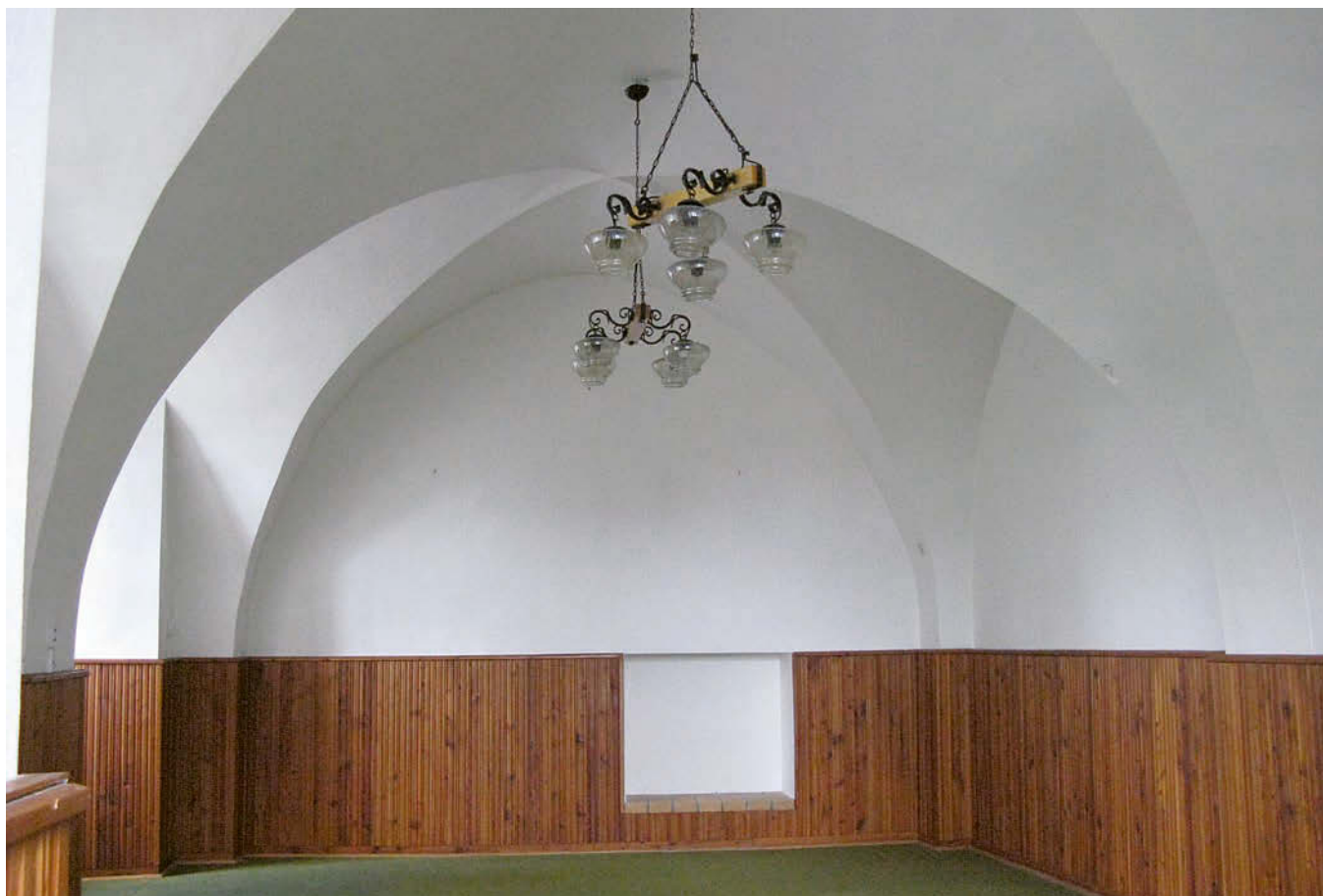
Obr. 22: Hořovice, Starý zámek, velká západní místnost (č. 1.27) v přízemí severního křídla, pohled k východu. Dřevěné obložení bylo před nedávnem odstraněno (foto A. Schubert, 2012).
