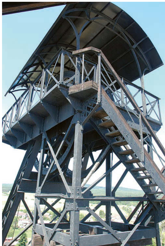
Obr. 10: Detailní pohled na vrchní ocelovou nýtovanou část těžní věže, stav 2005.
