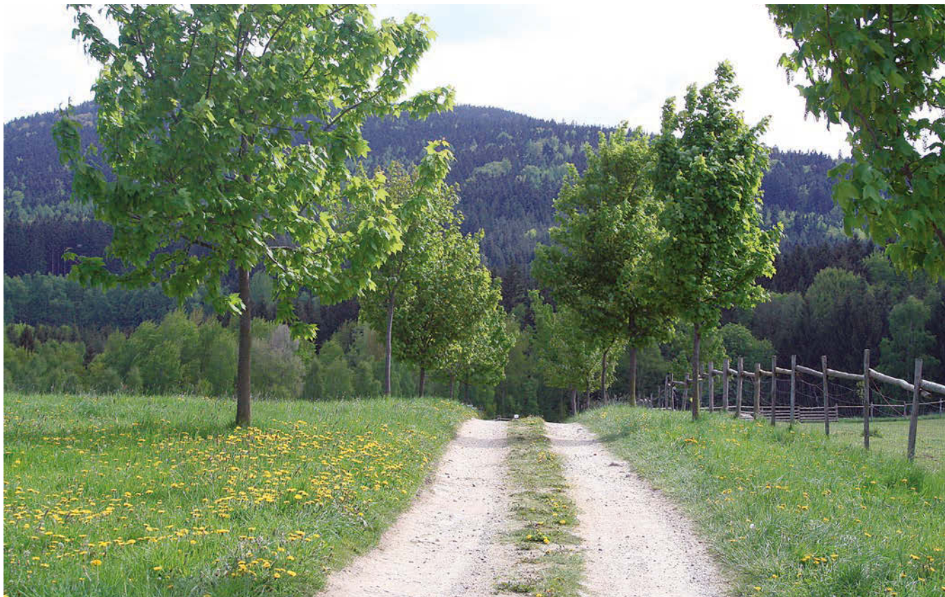
Obr. 21: Ukázka kvalitní nové polní cesty na katastru Pasek v Novohradských Horách. Pan Robert Blíženec tu v minulých desetiletích obnovil řadu starých cest a též zřídil polní cesty nové, vše na vysoké technické i estetické úrovni, stav 2011.
