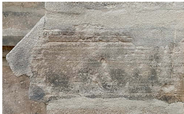
Obr. 3: Beroun, Horní (Plzeňská) brána, jemné horizontální vrstvení kosovského pískovce až křemence (foto J. Zavřel, 2024).
