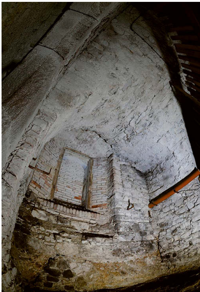
Obr. 15: Hořovice, Starý zámek, střední místnost (č. -1.03) v suterénu severního křídla. Pohled na jižní stěnu a pozdně gotickou křížovou klenbu. V levé části nika vstupního portálu, druhotně zúžená cihelnou vyzdívkou s dřevěnou zárubní. V pravé části je patrný zaslepený okenní otvor, kterému se přizpůsobuje kápe klenby. Dole základová spára v úrovni 90 cm nad stávající podlahou, stav 2024.
