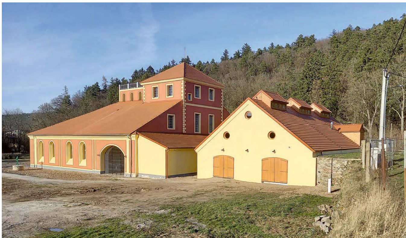
Obr. 8: Dřevouhelná vysoká pec Barbora, pohled od jihozápadu po obnově, stav březen 2024.
