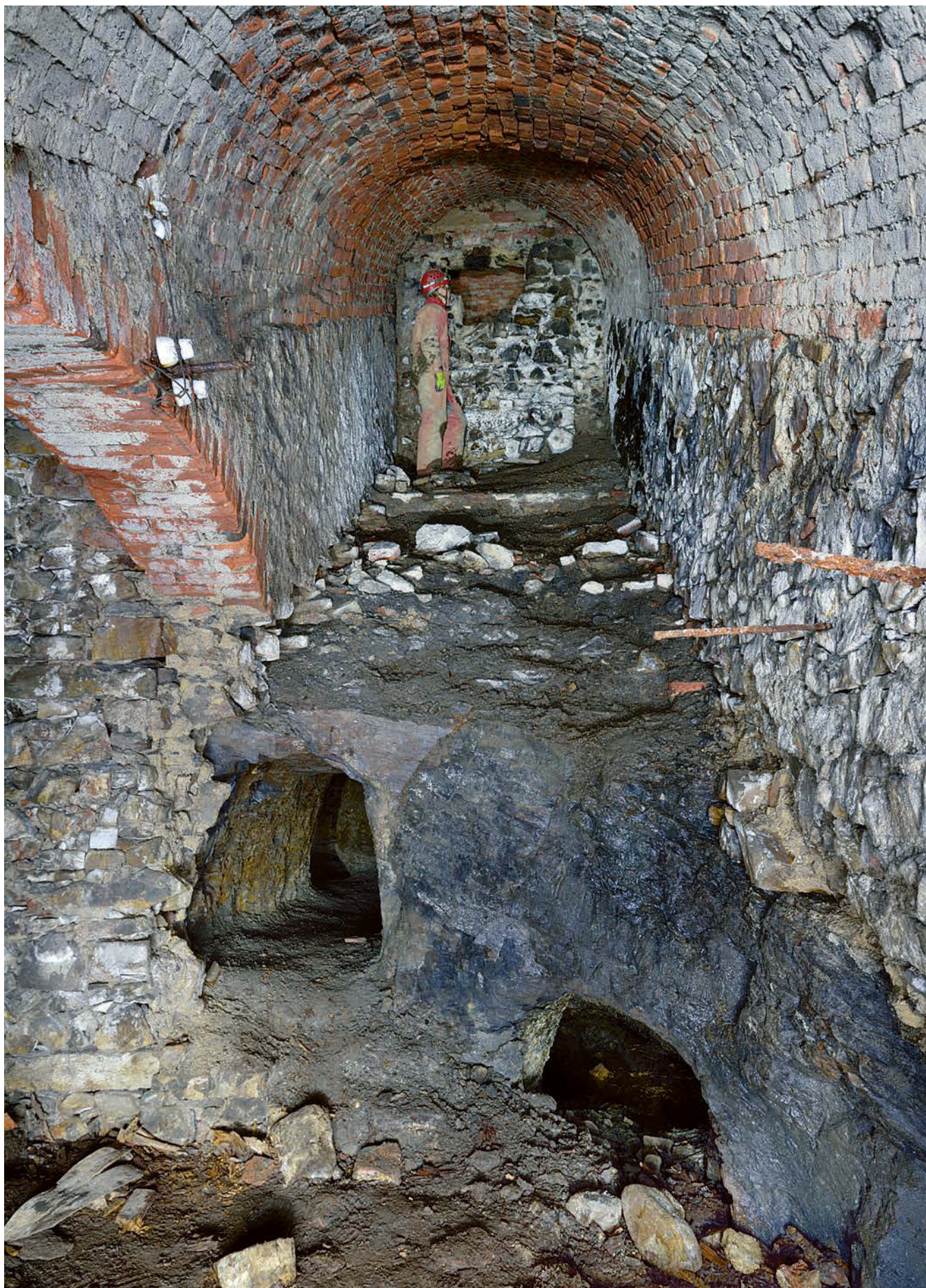
Obr. 35: Hořovice, Starý zámek, tzv. pivovarské sklepy. Šije zrušeného staršího schodiště ze suterénu východního křídla. Dole výchoz skalního masivu s ústím dvojice štol – pravá, níže položená je odvodňovací (foto M. Majer, 2024).
