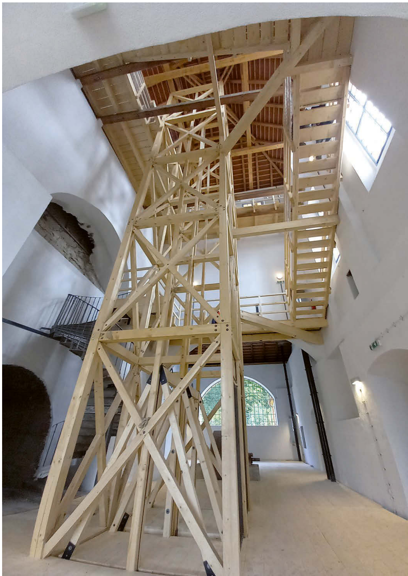
Obr. 11: Dřevouhelná vysoká pec Barbora, interiér zavázející věže po obnově, stav srpen 2023.
