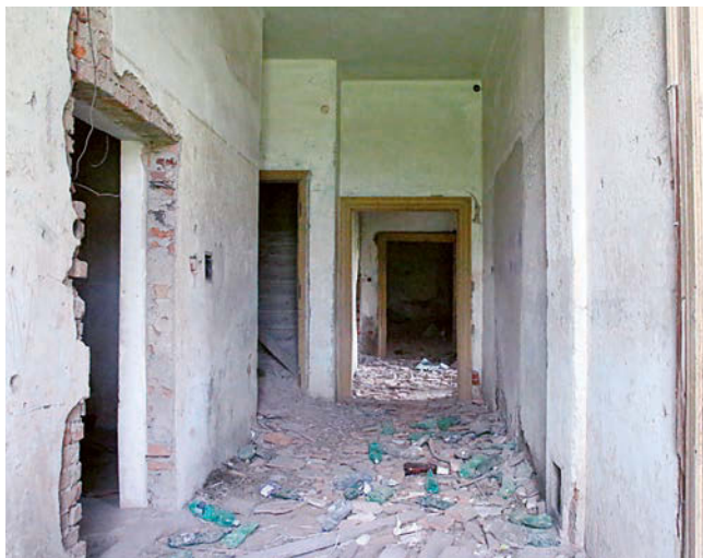
Obr. 7: Dřevouhelná vysoká pec Barbora, kanceláře, později byt před obnovou, stav duben 2016.
