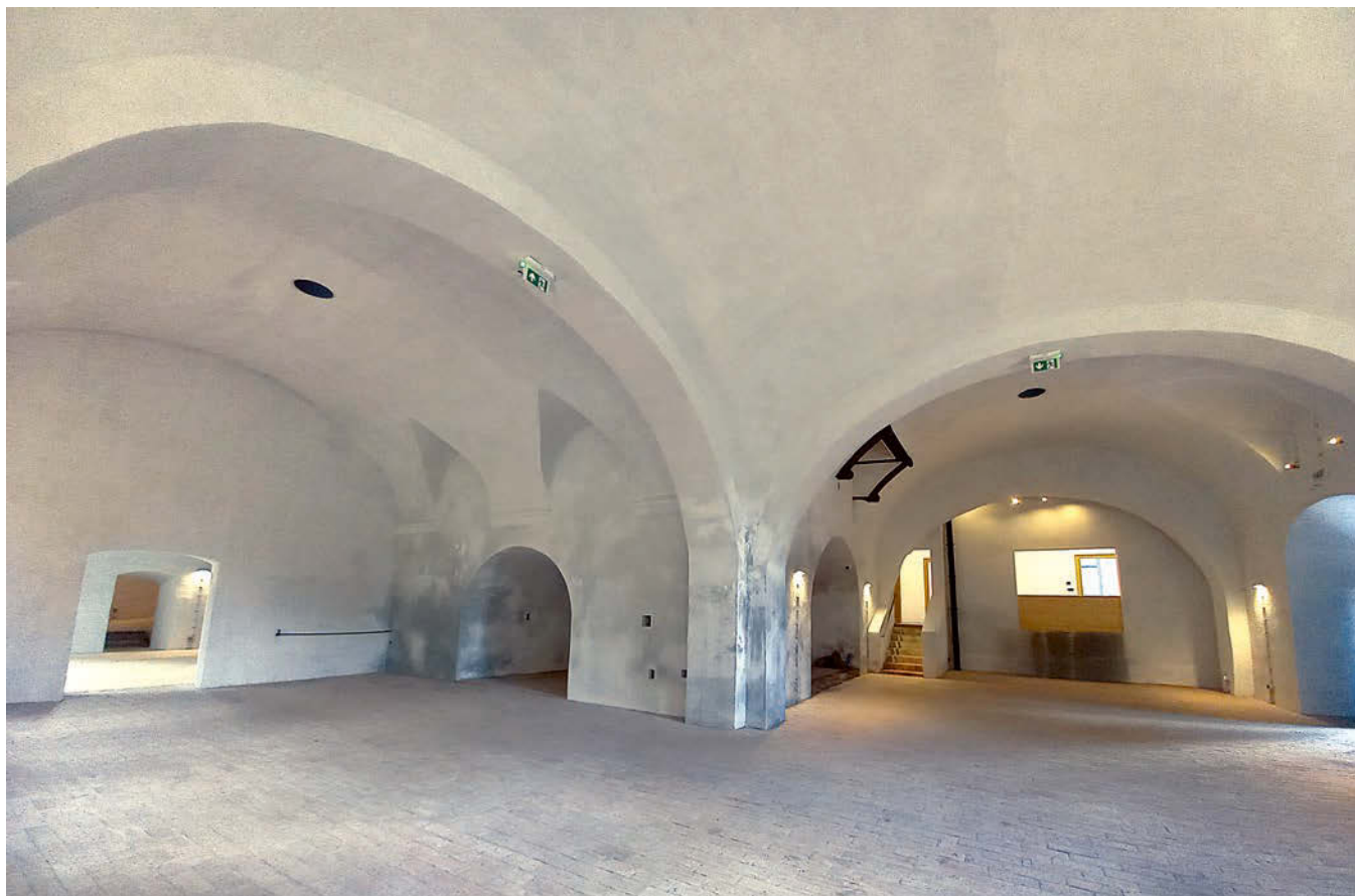
Obr. 10: Dřevouhelná vysoká pec Barbora, interiér huti po obnově, stav srpen 2023.
