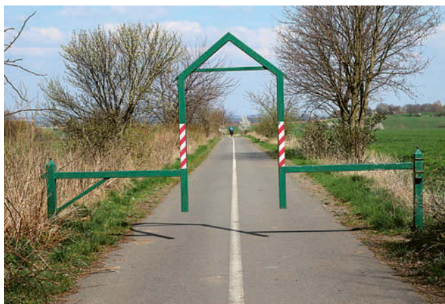
Obr. 16: K. ú. Stránka (okres Praha-východ), některé staré cesty se proměnily v asfaltové cyklostezky. Tato stará cesta u Stránky byla před rekonstrukcí mírně úvozová. Při proměně na cyklostezku se úroveň vozovky zvedla, takže efekt mírného úvozu byl téměř setřen. Okraj asfaltu je kamenitý, takže plynulá návaznost na travnatý okraj byla porušena a vlastně okraj ani nešel sekat, a ten tedy zarůstá plevellem. Pohodlná jízda je tu vykoupená ztrátou požitku z příznivého obrazu krajiny, stav 2019.
