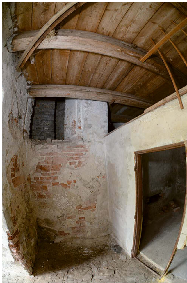
Obr. 20: Hořovice, Starý zámek, původně velká východní místnost v suterénu severního křídla je nyní rozdělena na tři menší stísněné prostory. Na snímku předsíně č. -1.04 je vlevo dole malá část špalety vjezdového otvoru a vpravo novodobá přička s dveřním otvorem místnosti č. -1.05. Nahoře trámový strop z roku 1869, přetínající vstup do zrušeného točitého schodiště z přízemí do patra s prahem v úrovni původní podlahy místnosti č. 1.21. V dolní části snímku je uprostřed patrné čelo zbytku pozdně gotické klenby, odstraněné z větší části v roce 1869, stav 2024.
