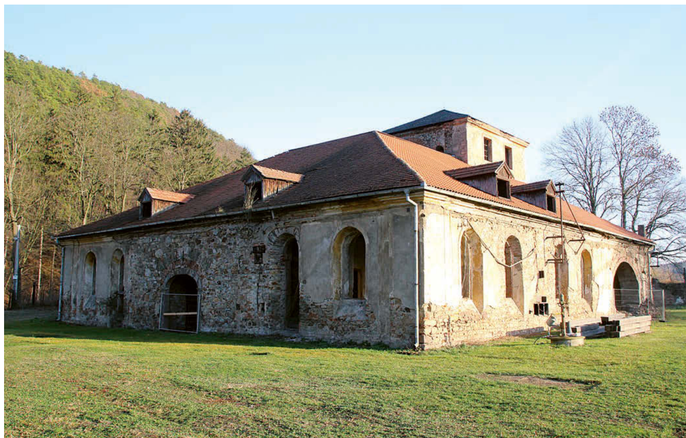
Obr. 4: Dřevouhelná vysoká pec Barbora, pohled od severozápadu před obnovou, stav 2020.
