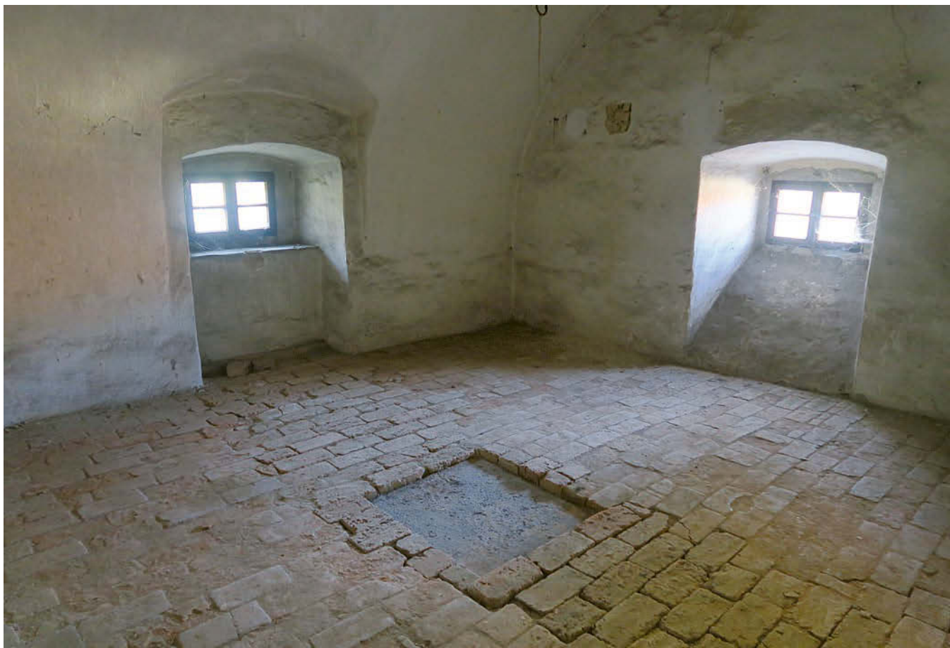
Obr. 27: Hořovice, Starý zámek, zvýšené přízemí věže (č. 1.05). V podlaze poklop otvoru do sklepení (foto A. Schubert, 2022).
