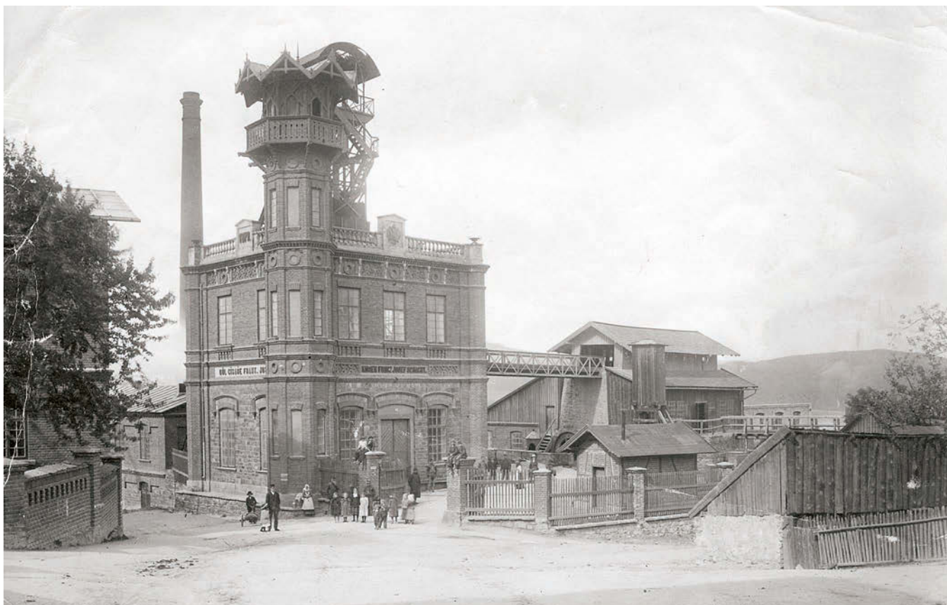
Obr. 9: Historická fotografie dolu Císaře Františka Josefa I. od jihovýchodu z roku 1915. Zcela vlevo budova cáčovny, uprostřed strojovna a jámová budova s těžní věží a komínem kotelny v pozadí (dnes zbořeným), vpravo je stará třídilna rudy (sypy) – dosud před úpravou na sokolovnu (© Hornické muzeum Příbram).
