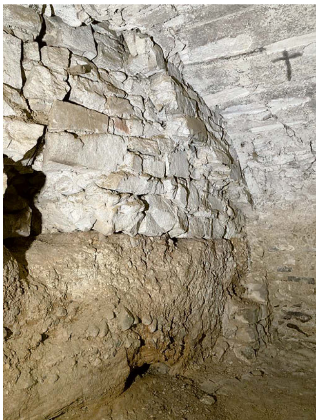
Obr. 19: Hořovice, Starý zámek, západní místnost v suterénu (č. -1.01) severního křídla, detail západní stěny se zbytky odbourané pozdně gotické přízdívky přiložené k vnitřnímu líci starší hradby při snižování úrovně podlahy a budování dochované valené klenby, stav 2024.
