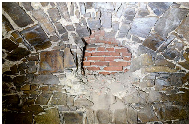
Obr. 13: Hořovice, Starý zámek, sklepení ve věži. Průraz západní stěnou z přízemí severního křídla uzavřený cihelnou příčkou (foto A. Schubert, 2023).
