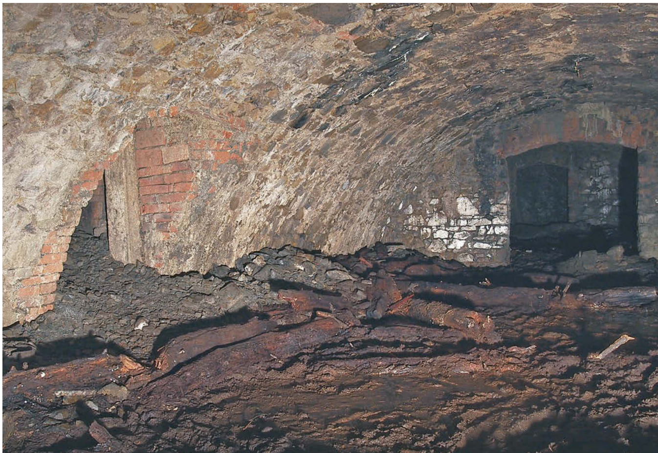
Obr. 36: Hořovice, Starý zámek, tzv. pivovarské sklepy. Jižní místnost, vpravo průchozí otvor v příčné dělicí stěně, vlevo komůrka v západní stěně (foto P. Ježek, 2017).
