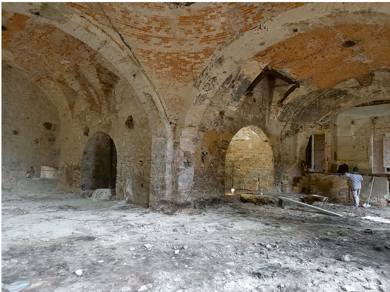
Obr. 5: Dřevouhelná vysoká pec Barbora, interiér huti před obnovou, stav říjen 2021.
