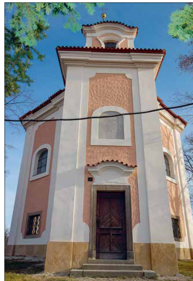
Malé Čičovice (správní obvod obce Černošice), osmiboká barokní kaple Nalezení svatého Kříže z let 1711–1714, celkový pohled na kapličku po velmi zdařilé opravě krovu, střešního pláště z prejzové krytiny a fasády (foto A. Musilová).
