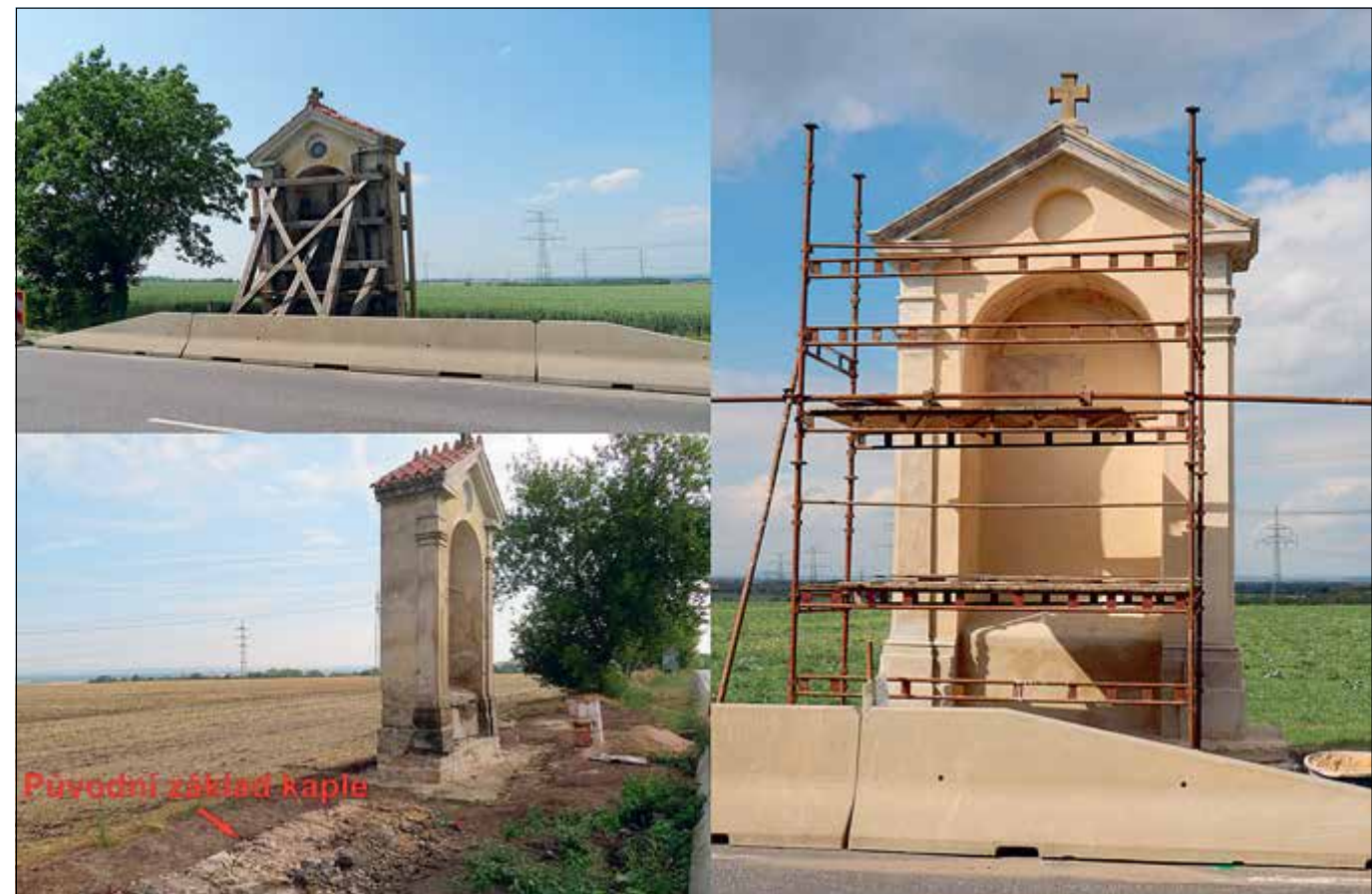
Dřevčice (správní obvod obce Brandýs nad Labem-Stará Boleslav), Strašenská kaple – kaple výrazně vykloněná do silnice byla po dobu deseti let provizorně zajištěná výdřevou (foto P. Kalinová). S ohledem na blízkost silnice a špatný základ kaple bylo rozhodnuto o přesunu kaple pomocí jeřábové techniky na nový základ (foto P. Kalinová). Při opravě kaple byly v ní nalezeny zbytky původní výmalby, které byly prezentovány. Při obnově fasád bohužel stále nedošlo ke korekci chybné opravy profilací a jednotnému nátěru fasád včetně architektonických článků (foto J. Černocho vá).
