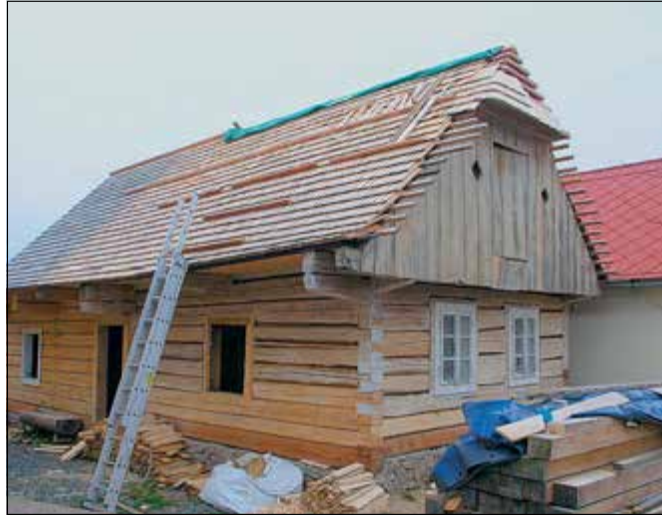
Starý Rožmitál (správní obvod obce Příbram), roubený dům čp. 59. Fotografie zachycuje dvorní a hlavní štítové průčelí stavby s probíhající obnovou střešního pláště ze štípaných dřevěných šindelů. Zajímavý je detail rozpracované pokládky kabřínce (foto M. Hanzlíková).
