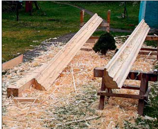
Žebrák (správní obvod obce Hořovice), dům Konráda z Vechty čp. 97, postupná obnova mansardového krovu. Mansardové římsy ručně opravoval tesař František Ungr (foto J. Procházka).
