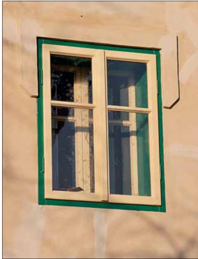
Mužský (správní obvod obce Mnichovo Hradiště), obytné stavení usedlosti čp. 5, osazená kopie vnějšího okna (foto A. Rákosníková).
