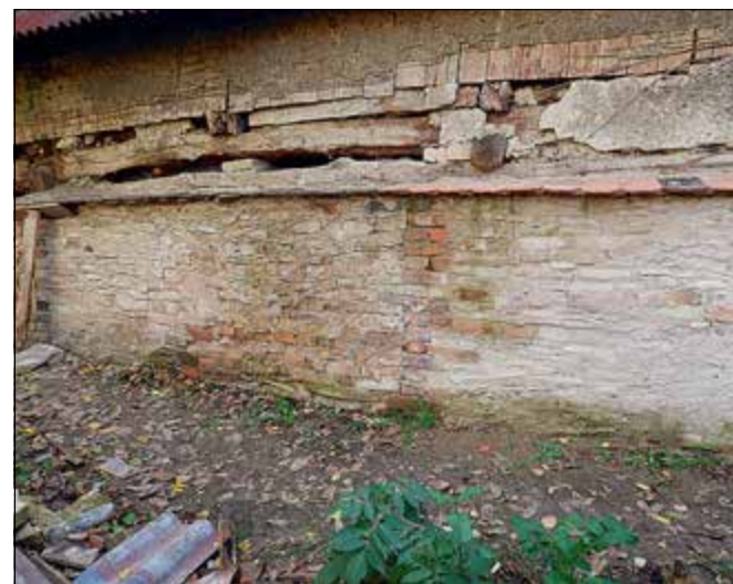
Vinice (správní obvod obce Poděbrady), roubený dům v usedlosti čp. 9 je dlouhodobě ve velmi špatném stavu. V rámci první etapy oprav byly sanovány zděné konstrukce související s blokem někdejšího topeniště včetně navazující stěny síně. V levé části obrázku je z větší části přezděná zeď síně. V rámci prací se podařilo zhotoviteli velmi věrně zachovat původní charakter zdiva (foto J. Berková).
