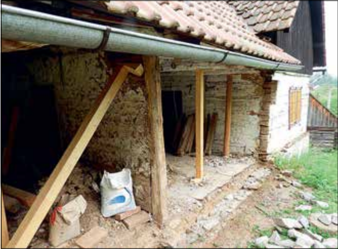
Losiny (správní obvod obce Kutná Hora), VPZ, dům usedlosti čp. 2. Výměnkářský přístavek byl v atypické pozici napojen na stěnu hlavní světnice pomocí sloupku s drážkou, do které byly vsazeny sténové trámy přístavku. V důsledku stárí a degradace zdiva došlo k vybočení sloupku a stěna se vyklonila ze své osy. V rámci obnovy musela být rozebrána včetně podezdívky a následně založena na nový základ. Prahové trámy byly tesány na místě z jedlového dřeva (foto J. Berková).
