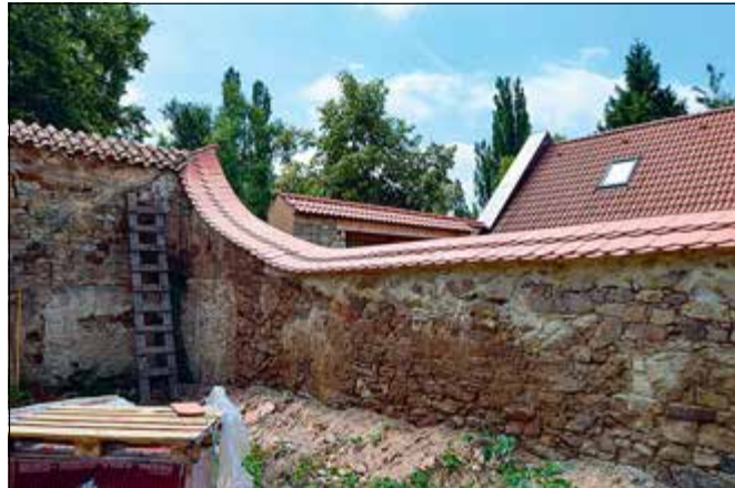
Kněžves (správní obvod obce Rakovník), areál fary. Oprava jihozápadního úseku ohradní zdi (foto E. Volfová).
