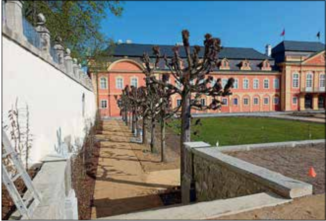
Dobříš, (správní obvod obce Dobříš), probíhající revitalizace francouzské zahrady v zámeckém parku, při které byla například vyměněna část habrových stěn lemujících opěrné zdi (foto A. Rudl).
