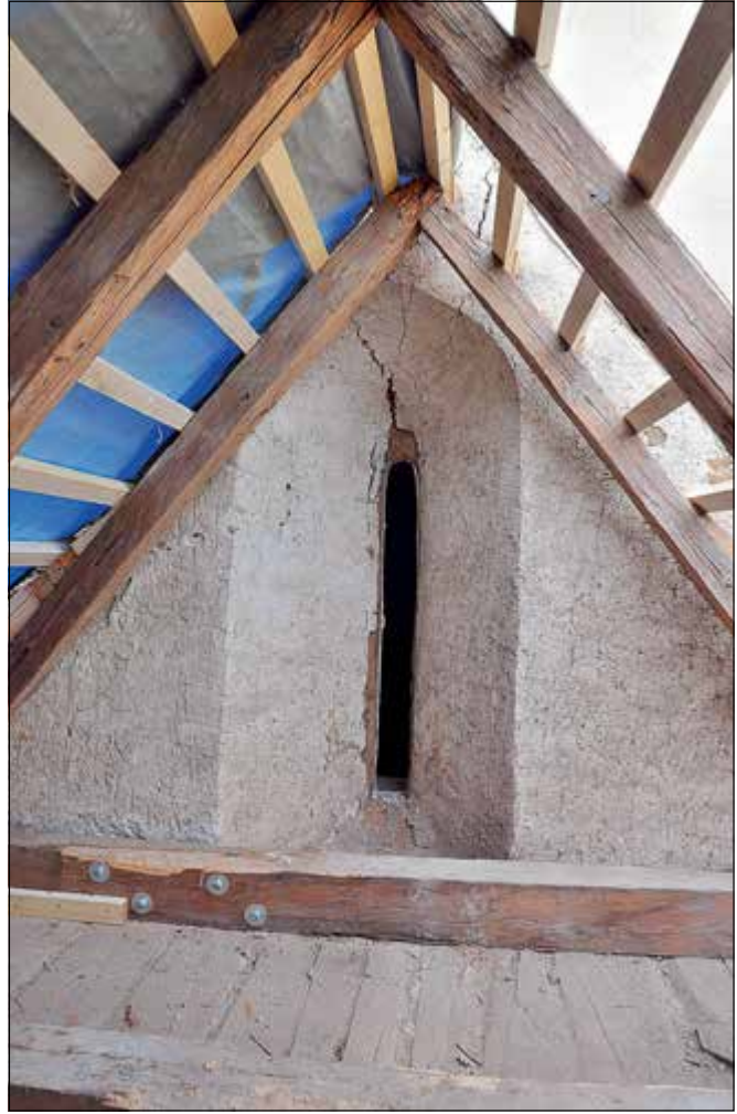
Zdebuzeves (okres Benešov), kostel sv. Anny, východní stěna presbytáře v pohledu z půdy sakristie. Při opravách střež kostelních přístavek se pravidelně stává, že je po omezenou dobu možné navštívit prostory, jinak bez rozebrání krytiny nepřístupné. Často se při takových příležitostech objeví opravdové skvosty zachované v neobvykle intaktním stavu. Na snímku je patrné dnes zaslepené raně gotické východní okno presbytáře s dochovaným dřevěným rámem vyrobeným z jednoho kmene (foto J. Veselý).
