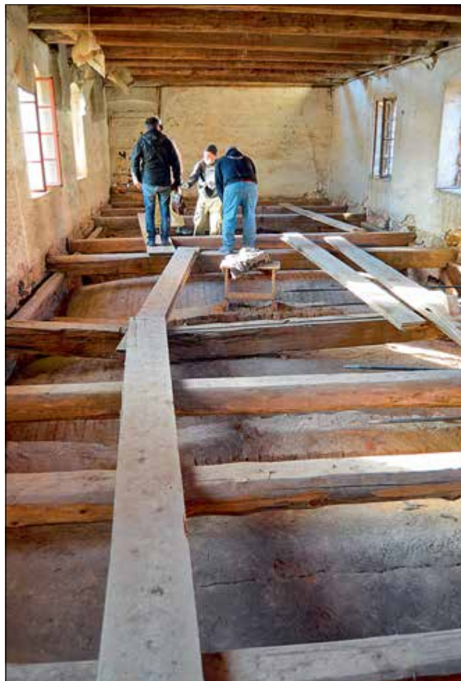
Kněžves (správní obvod obce Rakovník), areál zájezdniho hostince čp. 51, patro stavby. Zajištění statiky hospodářského objektu ve dvoře, oprava kleneb, příčné zajištění ocelovými tyčovými táhly (foto E. Volfová).
