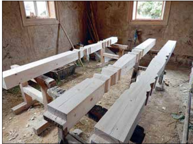
Jestřebice (správní obvod obce Mělník), VPZ, roubený dům usedlosti čp. 4. Výstavná budova má ve dvorním průčelí zachovanou původní bohatě zdobenou podstavku, zatímco v hlavním štítovém průčelí ji nahradila utilitární nezdobená trámová konstrukce novodobého původu. V rámci probíhající obnovy domu byla opět nahrazena zdobenou, vyrobenou jako replika dochované původní podstavky. Pohled na připravené nové sloupky (foto J. Berková)
