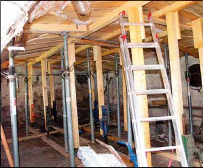
Lázovice (správní obvod obce Hořovice), KPZ Osovska, hospodářské stavení v usedlosti čp. 10. Při sanaci statických poruch zděných chlévů byla vyzvednuta pokleslá klenba v celé délce pomocí výdřevy a hydraulických zvedáků. Díky zdařilé akci nebylo nutné přistoupit k lokálnímu přezdění klenby (foto M. Hanzlíková).
