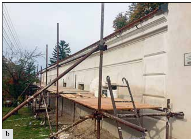
Činěves (správní obvod obce Poděbrady), chlév barokního areálu fary: a – stav před opravou; b – štukatéry byla zdařile prováděna obnova nárožní kvádřové bosáže, profilované římsy, subtilního architrávu a klenáků v nadpraží ležatě obdélníkových oken (foto D. Hofreiterová).
