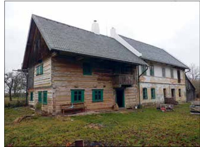
Víska (správní obvod obce Mladá Boleslav), VPR, dům čp. 6. Nová krytina z přírodní břidlice sjednotila střešní plášť domu, který až dosud kryly na roubeném jádru eternitové šablony a na zděné části drážkové pálené tašky (foto J. Berková).
