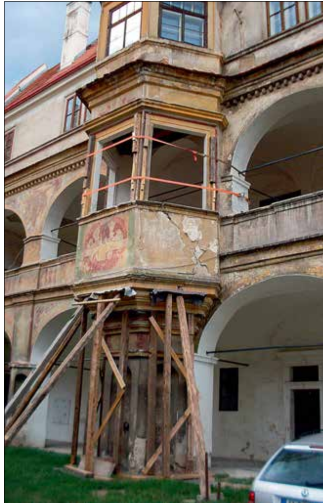
Bělá pod Bezdězem (správní obvod obce Mladá Boleslav), zámek. V návaznosti na zajištění kleneb arkád severního křídla pokračovaly práce statické zajištění arkýře, jehož konstrukce byla narušena výraznými trhlinami prostupujícími římsov včetně parapetů. V průběhu prací byla ve zdivu parapetů odhalena původní ztuzující konstrukce z trámů, která musela být vzhledem k poškození vyjmuta. Práce byly prováděny v součinnosti s restaurátorem, aby nedošlo k poškození dochovaných renesančních maleb (foto J. Müller).
