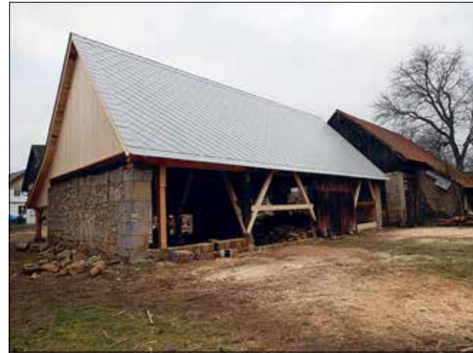
Kluky (správní obvod obce Mladá Boleslav), VPZ, původně hrázděná stodola byla v závěru 19. století doplněna o zděnou kolnu a zděné nárožní pilíře. V rámci její zachrany bylo nutno staticky stabilizovat jak zděné konstrukce, tak opravit s maximálním respektem k původní materii hrázděné konstrukce. Střešní plášť byl opět pokryt eternitovými šablonami (foto J. Berková).
