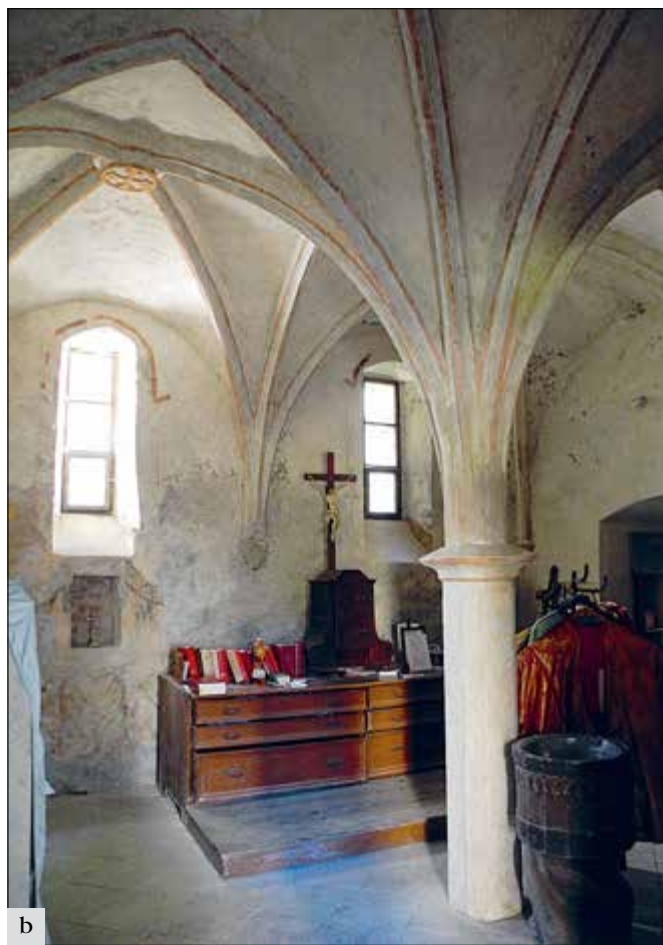
Bělá pod Bezdězem (správní obvod obce Mladá Boleslav), kostel Povýšení sv. Kříže. Gotická sakristie patří k vzácně dochovaným prostorům sklenutým na střední pilíř. Sakristie byla poškozena nejen v důsledku předchozího zatékání, ale i nevhodnými stavebními zásahy, zejména nešetrným provedením elektroinstalace i některými povrchovými úpravami: a – na základě restaurátorského průzkumu, který prokázal ve velkém rozsahu dochovanou pozdně gotickou omítku s fragmenty figurální malby, bylo rozhodnuto o odkryvu a restaurování této vrstvy; b – celkový pohled do prostoru sakristie po odstranění novodobého olejového nátěru pilíře a restaurování omítek s fragmenty maleb a červené polychromie žeber klenby (foto E. Vyletová).
