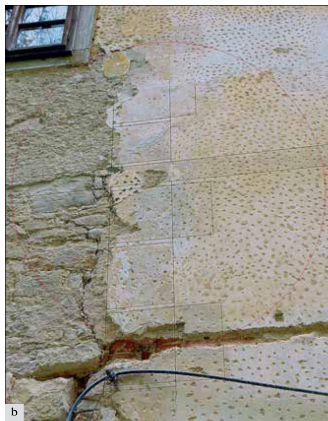
Hájek (správní obvod obce Černošice), františkánský klášter: a – schéma rozvržení kontur malovaného členění a principy vlastního rozbarvení severního průčelí východního křídla, vypracované NPÚ pro provádějící firmu; b – detail rozvržení malovaného členění promítnutý do fotografie; c – vlastní realizace po vnitřní konzervaci nálezové situace a pekovaných omítek a rekonstrukce malovaného členění, bez vybarvení kvádrování „zaniklého“ severovýchodního nároží studničního rizalitu (kresba schématu, detail ve fotografii a foto E. Zápalkové).
