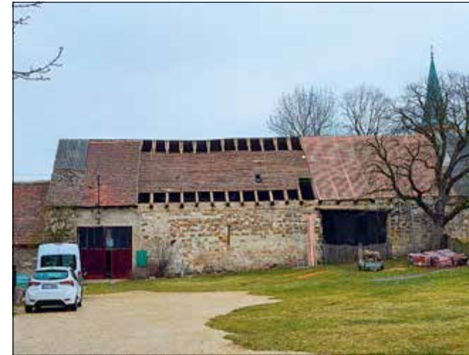
Srbeč (správní obvod obce Rakovník), areál zámku. Začala oprava střech stodol na východní straně, s příložkováním krokvi a částečným přeložením a položením nové krytiny (foto E. Volfová).
