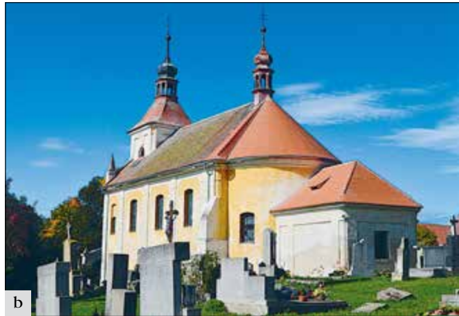
Panoší Újezd (správní obvod obce Rakovník), kostel Nanebevzetí P. Marie: a – tesařská vazba sakristie po snesení krytiny, vyklízení letitého nánosů holubích exkrementů ztlížilo práci při výměně střešní krytiny (foto E. Volfová); b – kostel s dokončenou opravou střechy sakristie z nových bobrovek pokládá nových na korunkovou vazbu, (foto E. Volfová).
