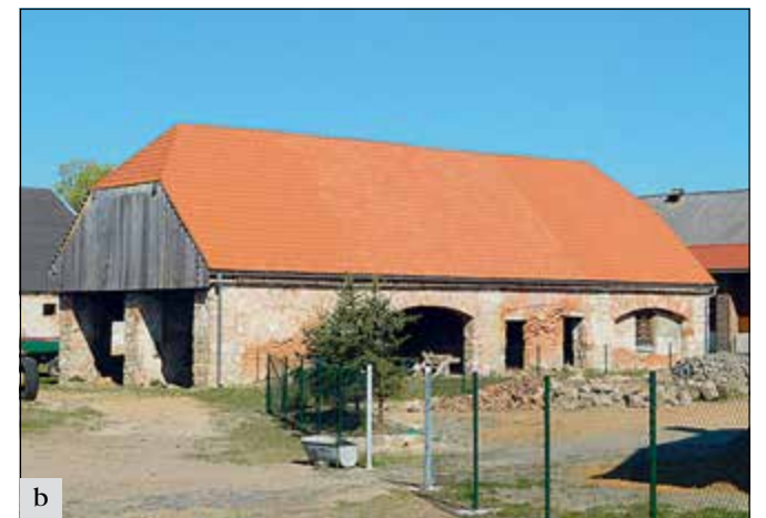
Mnichovo Hradiště, hospodářský dvůr Hněvousice (okres Mladá Boleslav): a – Bývalá kočárová kolna stojící uprostřed dvora, byla v důsledku zanedbané údržby v havarijním stavu (foto E. Vyletová); b – v letošním roce byla dokončena obnova krovu a krytiny, prováděná postupně po etapách v průběhu několika let (foto E. Zápalková).
