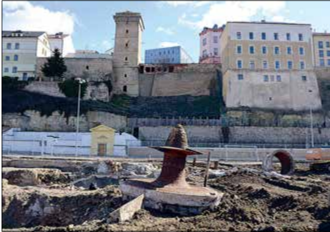
Mladá Boleslav, náhon a turbína bývalé elektrárny na místě bývalého Podstupenského mlýna, Ptácká čparc. 2804 a 1376/12. Nalezená Kaplanova turbína na místě bývalého Podstupenského mlýnu pod renesanční vodárenskou věží v Mladé Boleslavi je symbolickým mementem propojení techniky a výroby s celou historií města. Cílem památkářů je, aby se tyto hmotné doklady nelikvidovaly, ale integrovaly a rozvíjely. V okolí místa nálezu se to však v posledních letech daří minimálně (foto V. Jesenský).
