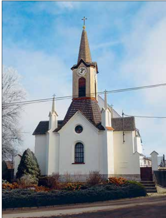
Psáře (správní obvod obce Vlašim), areál kostela Nejsvětější Trojice, zvonice s márnicí, celková obnova. Po opravě krovu a zvonové stolice, bednění věže a pokládce nového štípaného šindele byla v tomto roce dokončena oprava celého objektu obnovou kamenných bočních fiál a vnějších i vnitřních omítek (foto D. Primusová).
