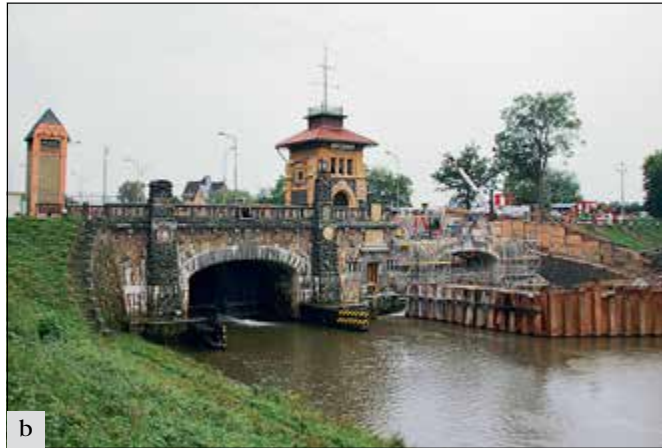
Hořín (správní obvod obce Mělník), zdymadlo vraňansko-hořinského plavebního kanálu: a – stav před započatím modernizace, prosinec 2017 (foto A. Rákosníková); b – stav v průběhu rozebírání přemostění dolního ohlavi velké plavební komory, srpen 2019 (foto A. Rákosníková).
