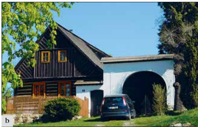
Mužský (správní obvod obce Mnichovo Hradiště), brána usedlosti čp. 11: a – stav před obnovou, prosinec 2016 (foto A. Rákosníková); b – stav po opravě, duben 2020 (foto E. Zápalková).
