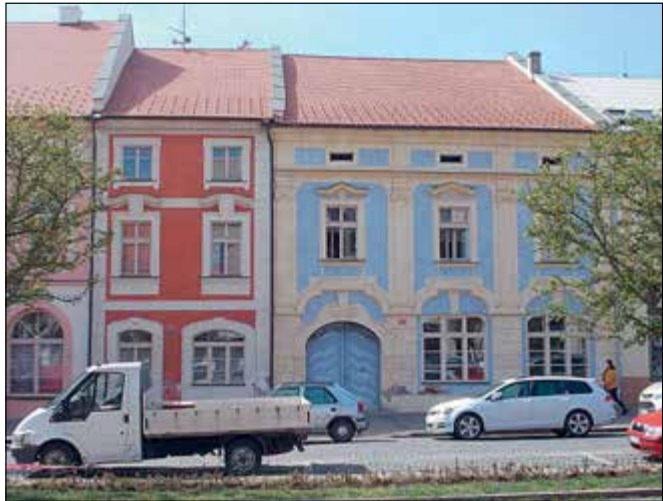
Rakovník (správní obvod obce Rakovník), radniční domy čp. 29 a 30. Po dokončení opravy krovu s výměnou střešní krytiny z hliníkových šablon Alukryt na pálenou z bobrovek (foto E. Volfová).
