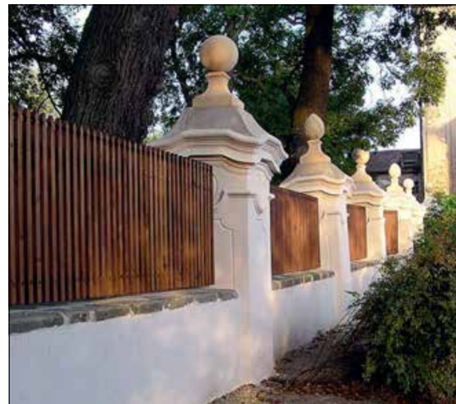
Břežno, zámek (správní obvod obce Mladá Boleslav). Obnova barokního oplocení pokračovala před jižním průčelím zámku směrem do návsi. Dokončena byla oprava omítek včetně náročné štukatérské práce hlavic i osazení chybějících kamenných koulí a šišek. Podkladem pro jejich obnovu byla archivní fotodokumentace i ojedinělý nález tohoto prvku v blízkosti stavby (foto M. Jonáš).
