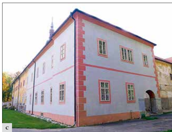
Hájek (správní obvod obce Černošice), františkánský klášter: a – schéma rozvržení kontur malovaného členění a principy vlastního rozbarvení severního průčelí východního křídla, vypracované NPÚ pro provádějící firmu; b – detail rozvržení malovaného členění promítnutý do fotografie; c – vlastní realizace po vnitřní konzervaci nálezové situace a pekovaných omítek a rekonstrukce malovaného členění, bez vybarvení kvádrování „zaniklého“ severovýchodního nároží studničního rizalitu (kresba schématu, detail ve fotografii a foto E. Zápalkové).
