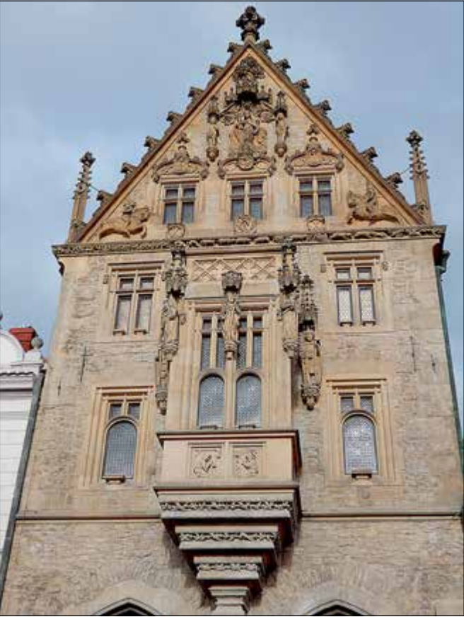
Kutná Hora (správní obvod obce Kutná Hora), Kamenný dům, horní partii fasády po restaurování. Povrch fasády byl značně znečištěn a lokálně docházelo k degradaci kamene. Vzhledem k stáří sochařské výzdoby však nebyla tato poškození závažná. Podstatné bylo restaurování mála původních prvků výzdoby, zde je třeba uvést zejména velmi kvalitně provedené práce na reliéfech konzole vynášející balkon, které na začátku prací byly z velké části pokryty krustami a nevhodnými cementovými překryty z předchozích oprav (foto L. Maděrová).
