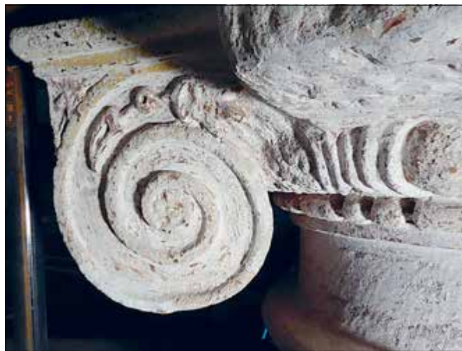
Stará Boleslav (správní obvod obce Brandýs nad Labem-Stará Boleslav), kostel Nanebevzetí Panny Marie, detail nejlépe provedené hlavice sloupů západní kruchty. Kamenné hlavice sloupů s vyzděnými a omítanými dřívky byly nepochybně osazeny v podobě polotovarů a dosekávány na místě. Kamenická práce je místy značně hrubá, na některých méně viditelných místech nebyly detaily vůbec vysekány (foto J. Žižka).
