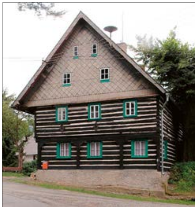
Dobřeň (správní obvod obce Mělník), roubený dům usedlosti čp. 1 dnes slouží jako prodejna a obecní dům. V minulosti byla okna v přízemí nahrazena nečleněnými výplněmi, které velmi rušily tradiční vzhled této ústřední stavby v jádru VPR. V rámci obnovy byla opravena původní okna v patře a doplněny jejich repliky do oken v přízemí (foto J. Berková).
