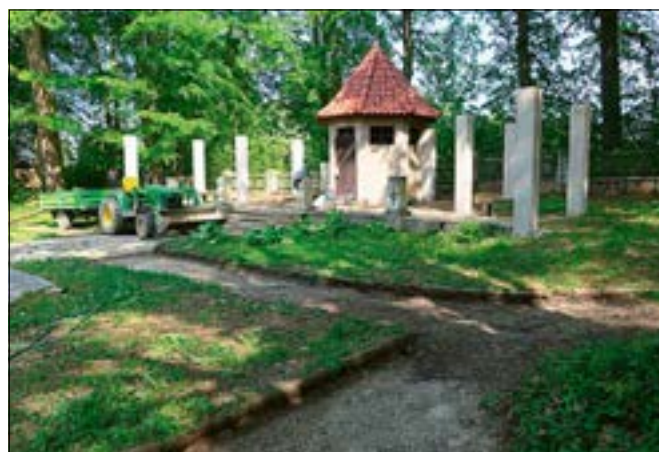
Líšno (správní obvod obce Benešov). V zámeckém parku byly obnovovány průhledy, započala práce na cestách, alpiniu a opraveny byly i drobné stavební prvky v parku. Fotografie zachycuje průběh realizace (foto A. Rudl).
