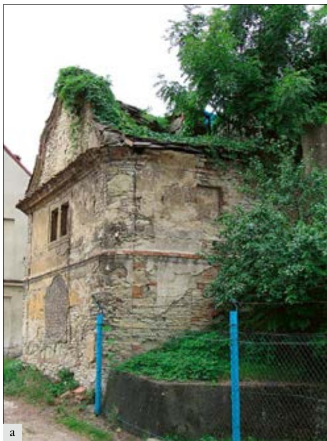
Liběchov (správní obvod obce Mělník), vinný sklep čp. 192: a – pohled na vinný sklep s propadlou střechou od východu, b – pohled na vinný sklep s obnovenou střechou od východu. Obnova střechy přišla opravdu na poslední chvíli, jelikož docházelo k masivnímu zatékání srážkové vody do interiéru stavby (foto V. Hlaváčková).
