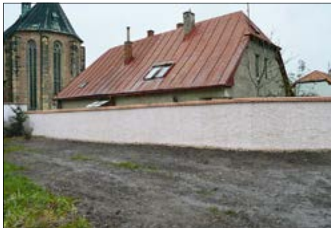
Nymburk (správní obvod obce Nymburk), ohradní zeď Starého děkanství čp. 29. Obnova zdi byla vynucena zřícením její velké části. Původní zdivo muselo být mimo kratší úseky zcela rozebráno a znovu vyzděno z původního materiálu doplněného novou kvalitní opukou. Obnova byla provedena za použití tradičních materiálů a technologií (foto B. Schmidová).
