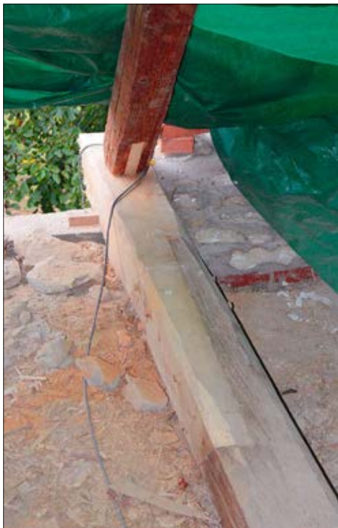
Hořátev (správní obvod obce Nymburk), toleranční modlitebna, detail doplnění dožilých prvků krovu za použití dřevěných kolíků jako tradičního spojovacího materiálu. Havarijní stav krovu byl způsoben zejména degradací pozednic, zazděných do půdní nadezdívky. Jelikož je ke krovu přímo kotven plochý strop kaple s výmalbou, nebylo možné provést kompletní výměnu pozednic a namísto toho byly zcela degradované úseky nahrazovány železobetonovým věncem, provázaným se zachovanými částmi. Tímto značně komplikovaným a pracným způsobem byla v roce 2017 opravena první polovina střechy (foto B. Schmidová).
