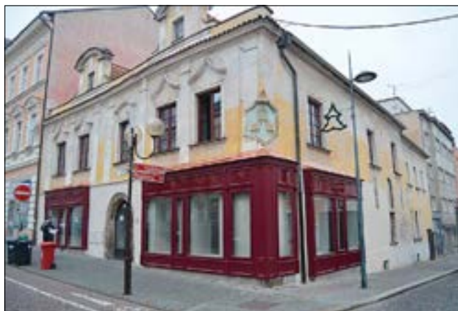
Kolín, (správní obvod obce Kolín), MPR, čp. 42, pohled na uliční fasády po rekonstrukci předsazených dřevěných výkladců podle archivní fotky z roku 1911z archivu NPÚ ÚOP SČ (foto D. Havlíková).
