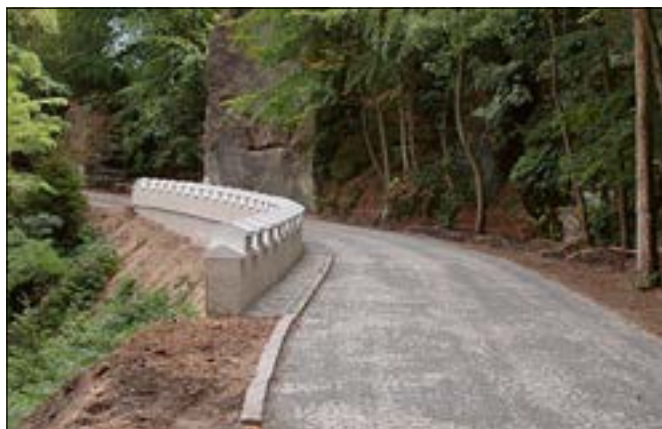
Kokořín (správní obvod obce Mělník), nová opěrná zeď pozemní komunikace v úbočí Kokořinského dolu, stav po dokončení v srpnu 2017 (foto J. Berková).
