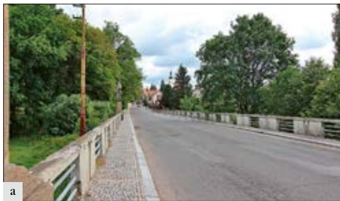
Sedlec-Prčice (správní obvod obce Sedlčany), silniční most přes Sedlecký potok: a – stav v červenci 2015. Železobetonové zábradlí vykazovalo značné poruchy a lokálně se zcela rozpadalo; b – stav v březnu 2018 po dokončení opravy svršku (foto A. Rákosníková).
