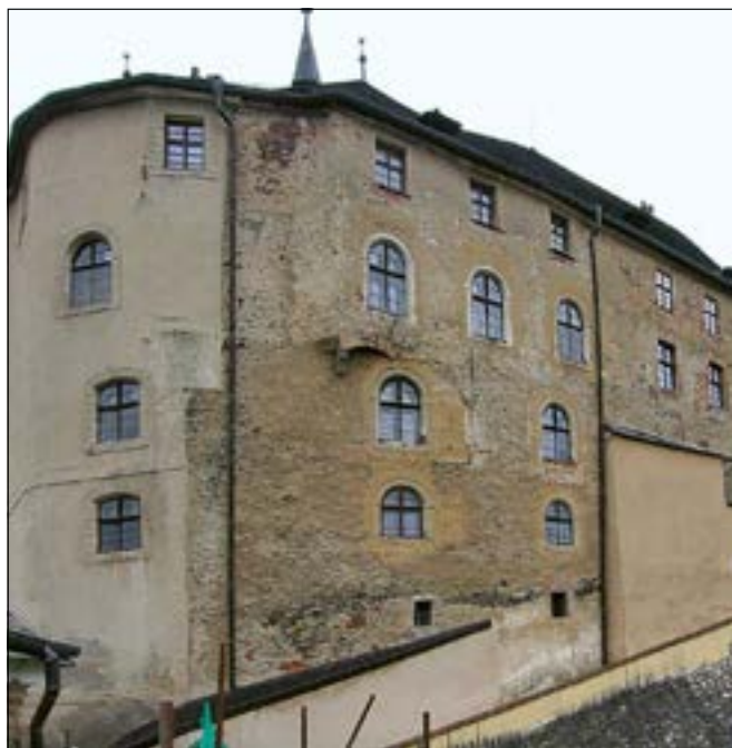
Český Šternberk (okres Benešov), hrad čp. 1. Severní dvě třetiny západní fasády tzv. horního hradu, zachycené na obrázku, nebyly od 20. let 20. století opravovány. Více než na jiných částech hradu tak zde vyniká bohatost a složitost vývoje jeho stavebního organismu. Bezprostřední přístup k fasádě z lešení postaveného pro obnovu omítek a výplní otvorů umožnil provedení stratigrafické analýzy omítkových vrstev a detailní dokumentace kamenných ostění všech fází otvorů. Množství nálezů a jejich vypovídací hodnoty byly nad očekávání bohaté (foto J. Kypta, 2015).
