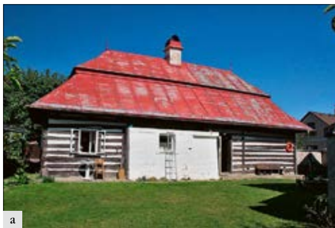
Kněžmost (správní obvod obce Mnichovo Hradiště), Branžežská ulice čp. 59: a – stav před obnovou střešního pláště v srpnu 2017. Pozoruhodné bylo časně užití krytiny z falcovaného plechu na venkovském domě (20. léta 20. století), spojené s dekorativními makovičkami. Plech se však neosvědčil esteticky ani funkčně; b – stav po obnově střešního pláště v prosinci 2017. Oprava střechy za pomoci tradičních materiálů a postupů vnějšímu výrazu střechy významně prospěla (foto A. Rákosníková).
