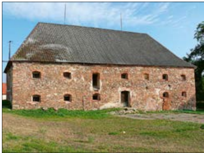
Plaňany (okres Kolín), sýpka, bývalá tvrz. Barokní sýpka postavená ve 40. let 18. století podle projektu Tomáše Vojtěcha Budila, obsahuje ve své jižní části zdivo tzv. Mírkovské tvrze z 16. století. Na snímku západního průčelí je starší etapa patrná svislou konstrukční spárou mezi druhou a třetí okenní osou vpravo. Jižní průčelí (mimo záběr) dosud nese zbytky sgrafitové výzdoby a v interiéru jsou patrné náběhy špalet zazděných oken tvrze. Dlouhodobě opuštěný objekt, představující poslední zbytek někdejšího rozsáhlého hospodářského dvora, se dochoval v mimořádně autentické podobě a v blízké době by měl být upraven na multifunkční společenský sál (foto I. Minář).
