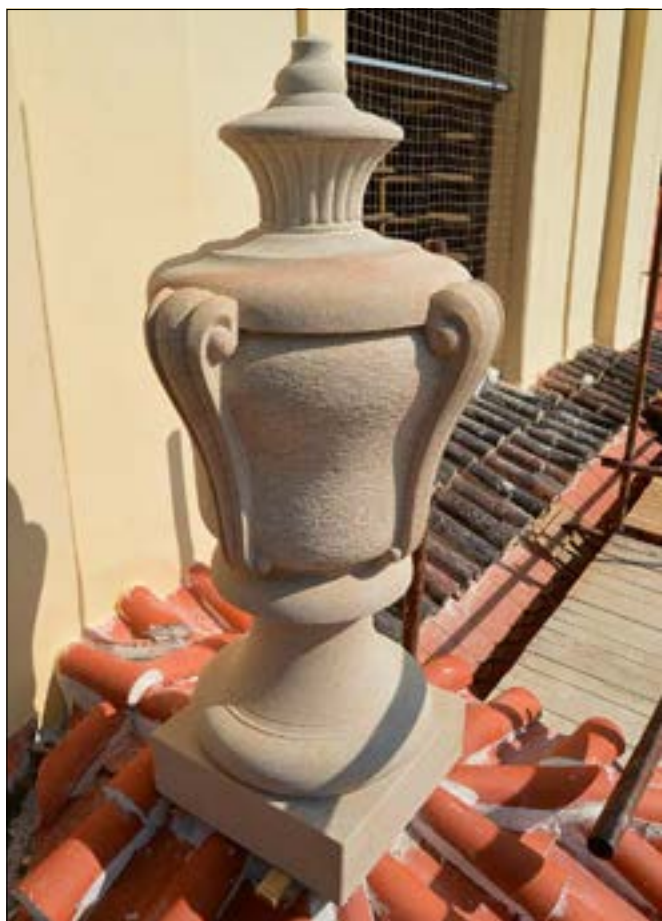
Zdice (správní obvod obce Beroun), kostel Narození Panny Marie, rekonstruována kamenná váza na jihozápadním vstupním průčelí podle archivní fotodokumentace (foto D. Havlíková).
