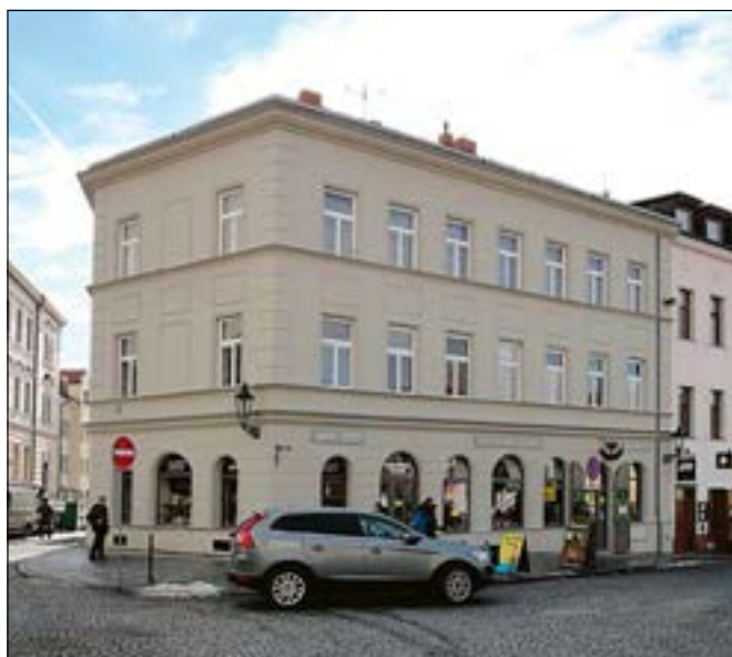
Příbram (správní obvod obce Příbram), dům čp. 142 po opravě fasády (foto E. Kosová).
