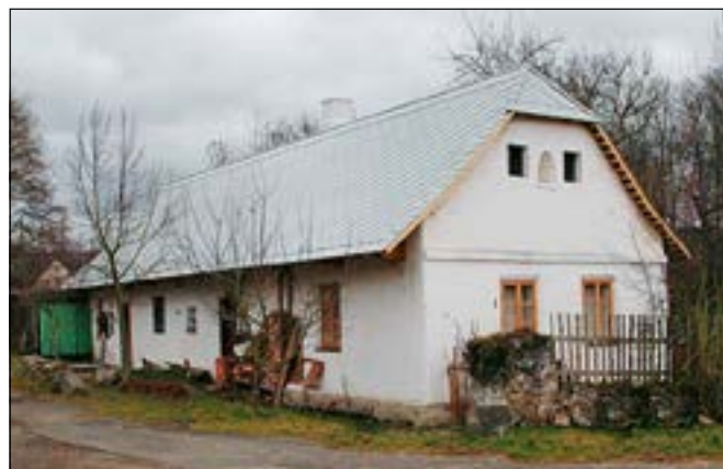
Žemličkova Lhota (správní obvod obce Sedlčany), dům č. e. 5, stav po obnově střešního pláště, kdy nově položené šablony nahradily předchozí velkoformátový vlnitý eternit z 2. poloviny 20. století. Původní krytinou zde byly slaměné došky (foto J. Berková).
