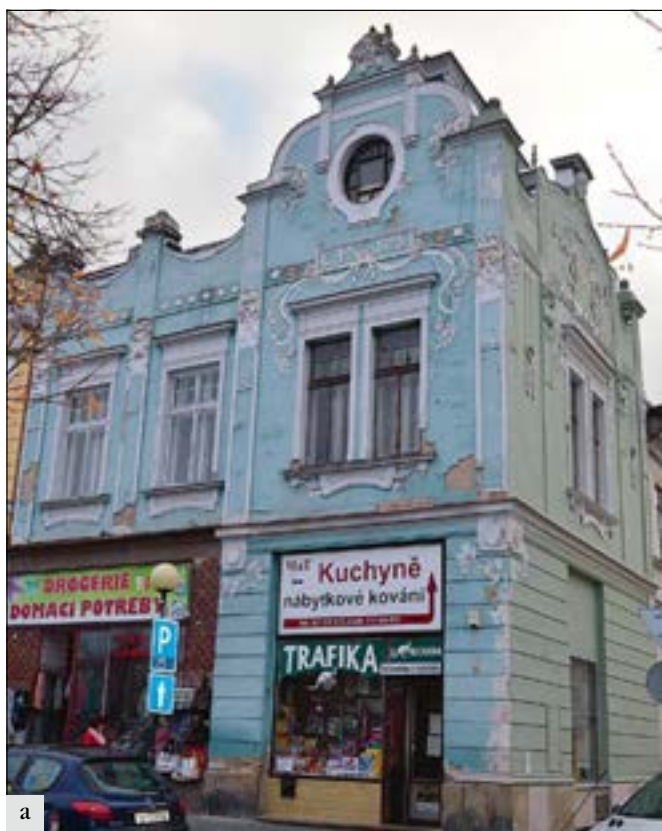
Čáslav (správní obvod obce Čáslav), dům čp. 154 před a po obnově hlavního průčelí. Dům čp. 154 je jedním z nejvýstavnějších objektů na náměstí Jana Žižky z Trocnova a v podstatě nejvýznamnějším secesním domem v Čáslavi; a – navzdory vizuálně lepšímu stavu čelní fasády oproti bočnímu průčelí před jeho obnovou v roce 2015 se při bližším ohledání i zde zjistila velká míra degradace štukových prvků a omítek; b – obnova čelního průčelí je opět kvalitním dílem zručných a zkušených štukatérů. Z důvodu klimatických podmínek byla oproti boční fasádě zvolena pro zlacení prvků zlatá fasádní barva. Vadou na kráse zůstává stejně jako u domu čp. 161 parter s nevhodně řešenými výkladci (foto B. Schmidová).
