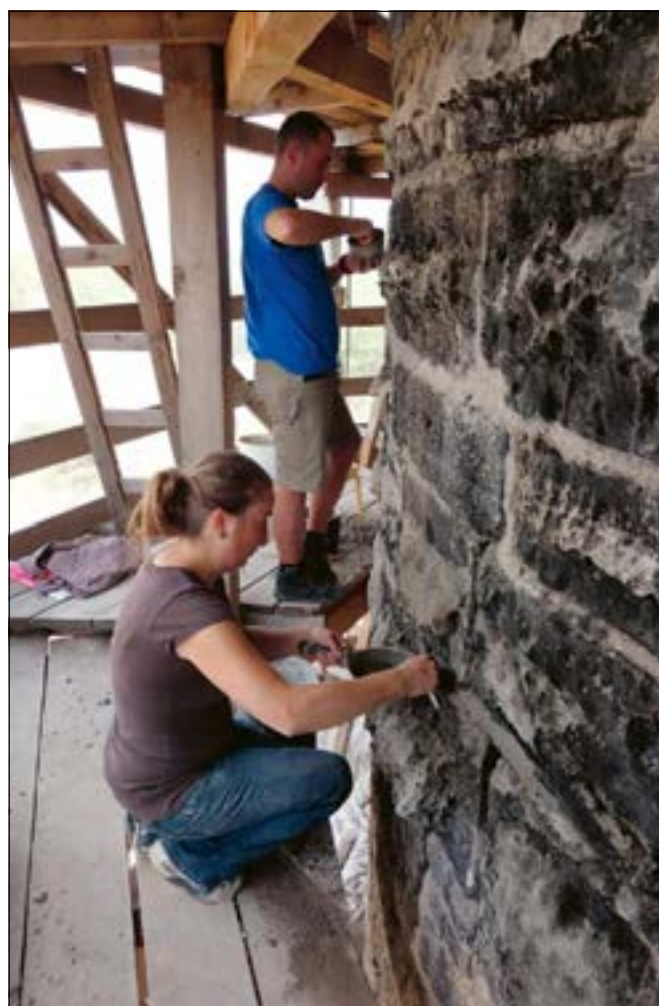
Jenštejn (správní obvod obce Brandýs nad Labem), práce na vyplňování spár kvádrového zdiva věže v roce 2017 (foto J. Žižka).
