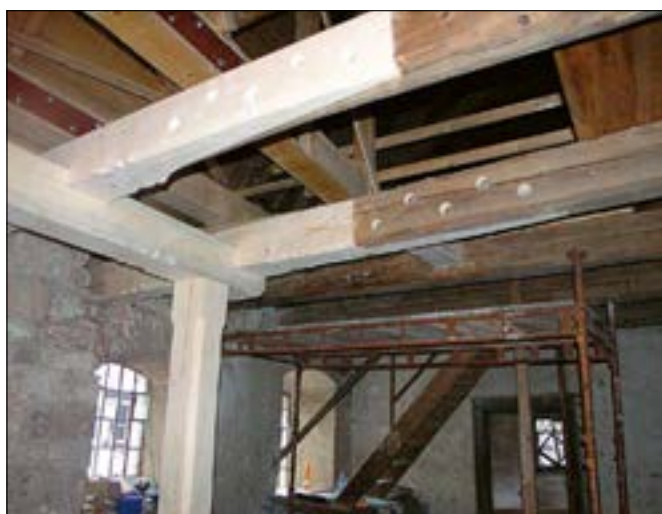
Vepřek (správní obvod obce Kralupy nad Vltavou), areál vodního mlýna čp. 19. Protézované stropní trámy patra mlýnice s šikmočelými pláty, fixované kovovými svorníky. Na fotografii je zřetelná obnova zdobné profilace. Zavičkování svorníků bude provedeno s časovým odstupem po dotažení svorníků. V levém horním rohu je na fotografii patrná vložena provizorní podpůrná konstrukce vynášející krov mansardové střechy (foto M. Hanzlíková).
