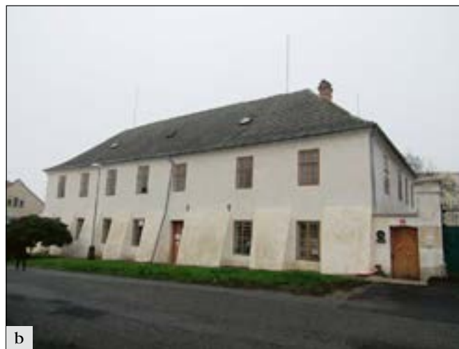
Odolena Voda (správní obvod obce Brandýs nad Labem), tvrz: a – pohled na západní fasádu tvrze před provedením obnovy fasády; b – západní fasáda tvrze po obnově. Cementové omítky byly nahrazeny vápennými omítkami (foto V. Hlaváčková).
