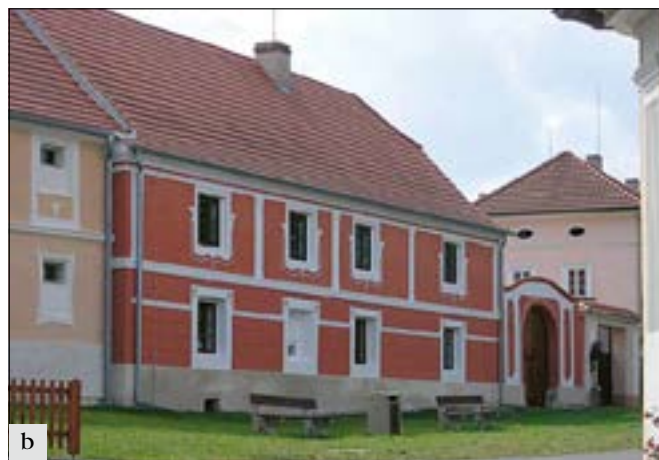
Dobrovíz (správní obvod obce Černošice), dům usedlosti čp. 4: a – stav objektu kolem roku 2000, následně byla na domě osazena okna, v roce 2004 vyměněna vrata v bráně (foto J. Berková); b – stav z roku 2017 po dokončení obnovy fasády brány a návesního průčelí domu (foto M. Hanzlíková).
