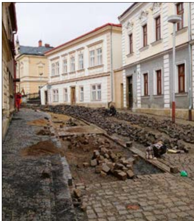
Kutná Hora (správní obvod obce Kutná Hora), Česká ulice. Po delší odmlce se do ulic Kutné Hory vrátili dlaždiči, a to v případě ulice Česká a Na Náměti. Podobně jako v předešlých etapách výměny povrchů ulic se i zde kladl důraz na uplatnění žulových dlažeb a řádkovanou vazbu. Součástí rekonstrukce byla také výměna osvětlení za litinové lucerny pražského typu. Škoda jen, že se nepodařilo eliminovat prvky, jako jsou normovaná opatření pro nevidomé a přemíra dopravního značení, které intravilán ulic našich historických měst značně devalvují (foto A. Pospíšil).
