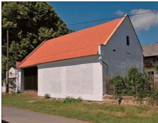
Šemanovice (správní obvod obce Mělník), stodola v usedlosti čp. 5, stav po dokončení obnovy vnějšího pláště (foto J. Berková).
