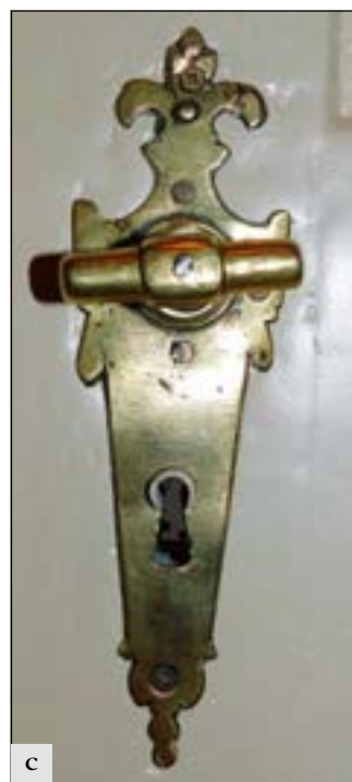
Lysá nad Labem (správní obvod obce Lysá nad Labem), evangelická fara: a, b, c – příklady repasovaných tvarově velmi zajímavých dobových klik a klíčových štítků od začátku 19. století po jeho konec. Nepříznivě v tomto kontextu však působí novodobé křížové šroubky, které nahradily původní nýty (foto E. Zápalková).
