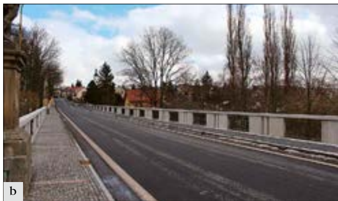
Sedlec-Prčice (správní obvod obce Sedlčany), silniční most přes Sedlecký potok: a – stav v červenci 2015. Železobetonové zábradlí vykazovalo značné poruchy a lokálně se zcela rozpadalo; b – stav v březnu 2018 po dokončení opravy svršku (foto A. Rákosníková).
