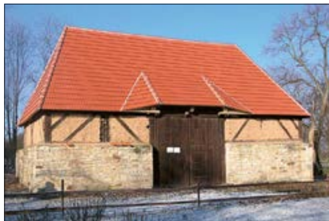
Třebíz (správní obvod obce Kladno), stodola v areálu usedlosti čp. 10. Dvorní průčelí po dokončení obnovy krovu a střešního pláště (foto M. Hanzlíková).
