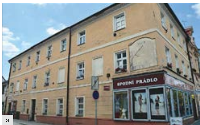
Čáslav (správní obvod obce Čáslav), dům čp. 161 před a po obnově fasády: a – před obnovou byla strádmá klasicistní fasáda domu nevhodně rozbarvena, detaily keramických tvarovek byly znejasněny vrstvami nátěrů, řada tvarovek byla poškozena nebo zcela chyběla; b – zachované tvarovky byly očištěny a doplněny kopiemi. Fasáda byla sjednocena monochromním nátěrem v neutrálním odstínu, zvoleném s ohledem na sousední objekty. Starší nátěry byly zdokumentovány v rámci stratigrafického průzkumu fasády před obnovou (foto B. Schmidová).
