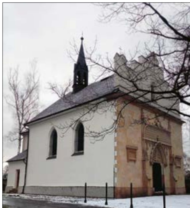
Poděbrady (správní obvod obce Poděbrady), oprava vnějšího pláště kostela Nanebevzetí Panny Marie, tzv. Havířského kostelíčku. Na západním průčelí byla provedena restaurátorem ak. soch. Jarmilem Plachým rekonstrukce Schnirchovy úpravy z roku 1896. Rovná omítková plocha je zdobena iluzivním kvádrováním s obraty přes nároží. Jedná se o příklad precizní, kvalitně odvedené práce (foto J. Kratochvilová).
