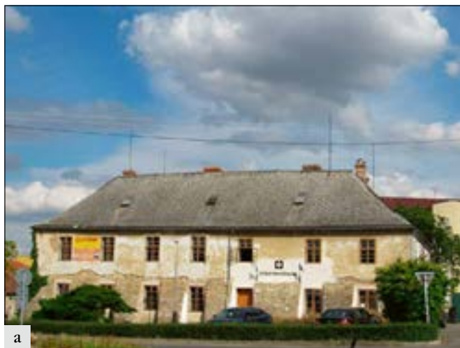
Odolena Voda (správní obvod obce Brandýs nad Labem), tvrz: a – pohled na západní fasádu tvrze před provedením obnovy fasády; b – západní fasáda tvrze po obnově. Cementové omítky byly nahrazeny vápennými omítkami (foto V. Hlaváčková).
