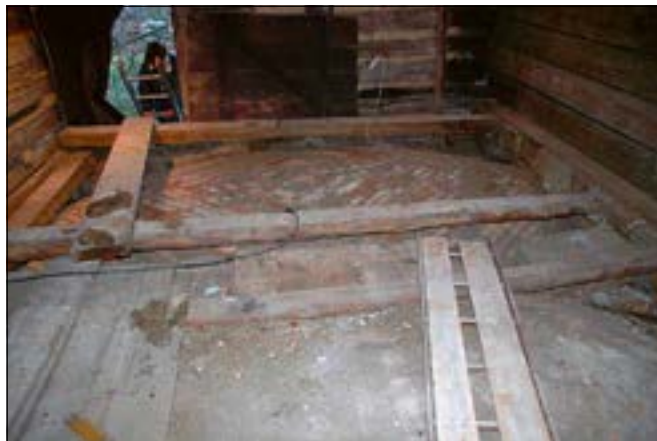
Nosálov (správní obvod obce Mělník), dům čp. 36. Statické zajištění hospodářské části s chlévem pod roubenými komorami vyžadovalo, mimo jiné, také obnovu tří polí plackových kleneb. Jedno z nich muselo být vzhledem ke stupni narušení nově vyžděno. Zhotovitel zde odvedl velmi dobrou práci, při které se podařilo dodržet původní tvar klenby a skladbu zdíva (foto J. Berková).
