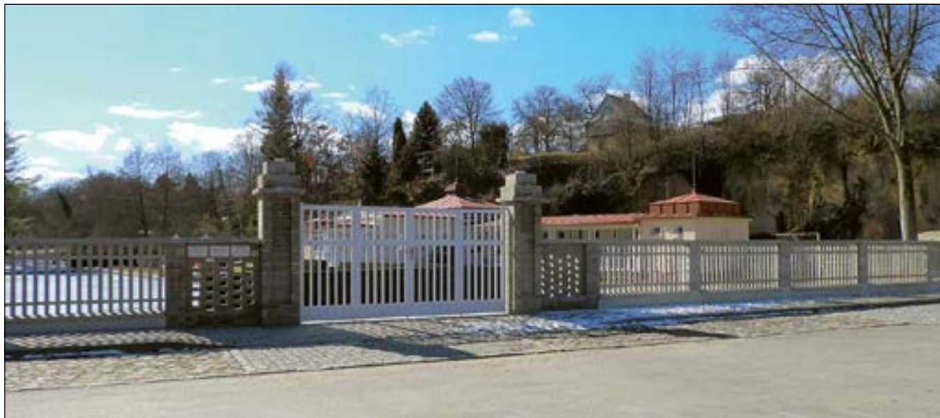
Mšeno (správní obvod obce Mělník), městské koupaliště postavené ve třicátých letech 20. století je chloubou města. Areál plovárny s prvky ve stylu art-deco je ve směru z Cinibulkovy ulice oddělen dobovým oplocením z prefabrikovaných betonových tvarovek. Obnovení plotu vyžadovalo zakázkovou výrobu kopií poškozených prvků. Nová brána, vystavěná podle soudobého návrhu, odkazuje na původní záměr dominantního vstupu a současně používá materiál odpovídající celkovému charakteru oplocení (foto J. Berková).
