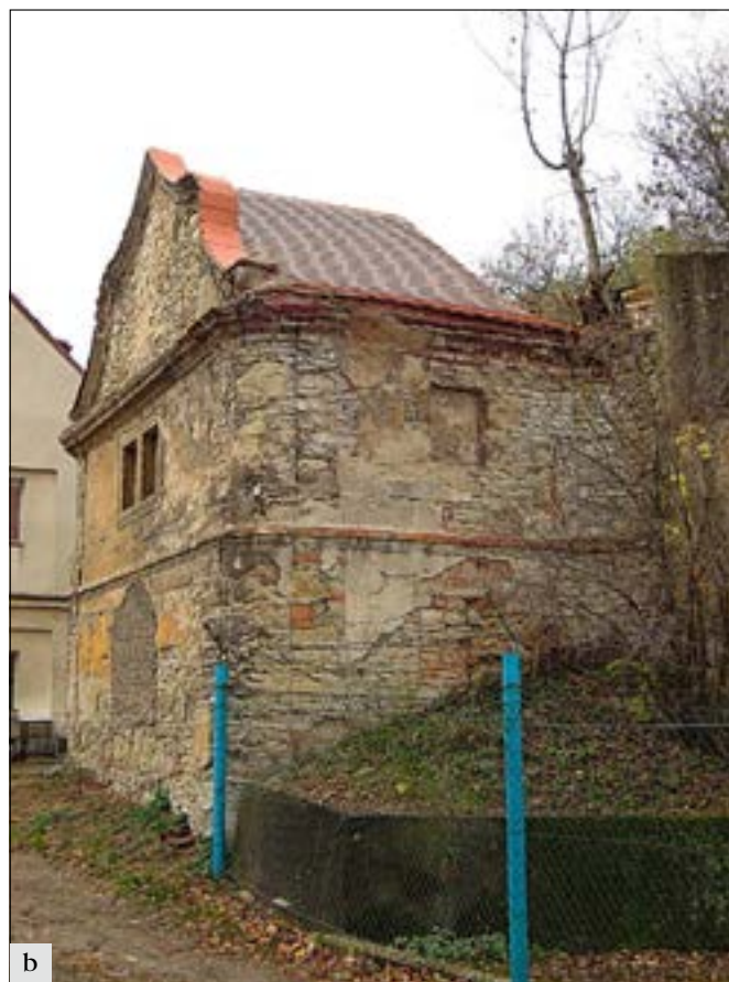
Liběchov (správní obvod obce Mělník), vinný sklep čp. 192: a – pohled na vinný sklep s propadlou střechou od východu, b – pohled na vinný sklep s obnovenou střechou od východu. Obnova střechy přišla opravdu na poslední chvíli, jelikož docházelo k masivnímu zatékání srážkové vody do interiéru stavby (foto V. Hlaváčková).
