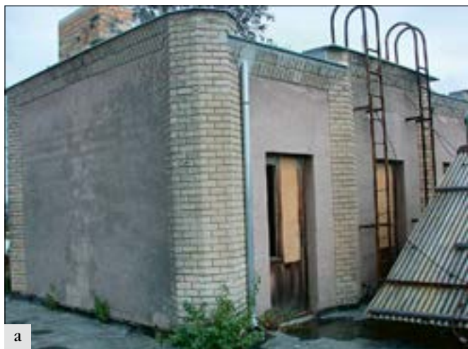
Litol (správní obvod obce Lysá nad Labem), Beniesova vila, střešní partie s převýšeným schodištěm: a – stav před celkovou rekonstrukcí; b – stav po celkové rekonstrukci rovných střech s pochozím kačírkem, po restaurátorském zásahu do původních probarvených strukturovaných omítek a do původních vápenopiskových cihel architektonického členění (čištění, konsolidace, doplnění a retuše), po repasování dveřních výplní s výrobou replik originálního kování (kliky, štitky), opravě a výměně klempířských prvků a po celkové obnově světlíku centrální dvoupodlažní haly (foto E. Zápalková).
