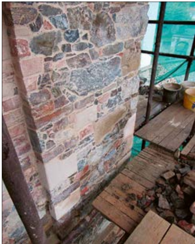
Chvatěruby (správní obvod obce Kralupy nad Vltavou), zámek. Detail konzervace a konsolidace zdiva hradního torza (foto V. Hlaváčková).
