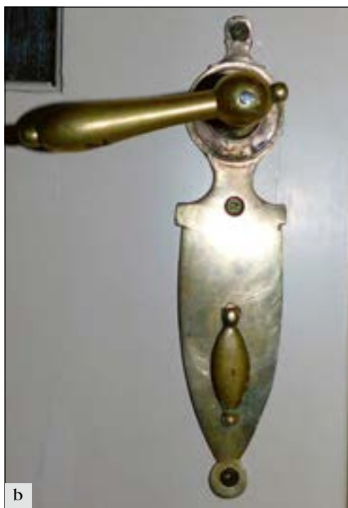
Lysá nad Labem (správní obvod obce Lysá nad Labem), evangelická fara: a, b, c – příklady repasovaných tvarově velmi zajímavých dobových klik a klíčových štítků od začátku 19. století po jeho konec. Nepříznivě v tomto kontextu však působí novodobé křížové šroubky, které nahradily původní nýty (foto E. Zápalková).
