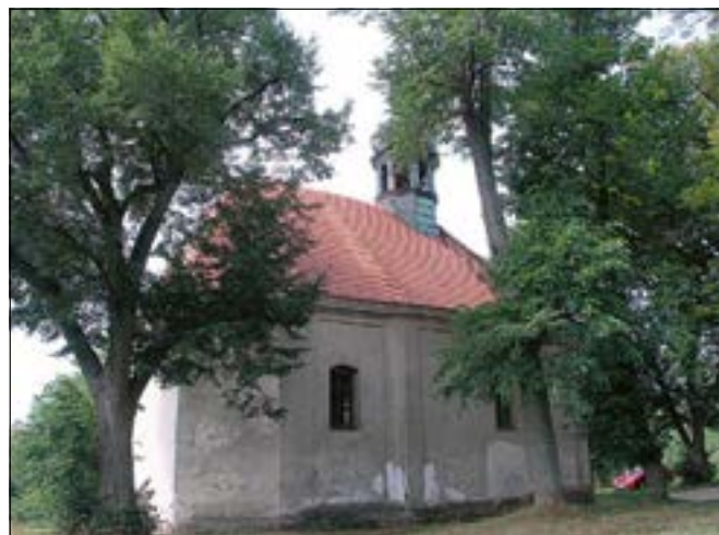
Čistá (správní obvod obce Rakovník), kaple sv. Anny, prováděla se oprava tesařské vazby krovu na jižní straně, nad lodí a presbytářem. Současně se pokládaly další plochy střešních rovin pálenými bobrovkami v korunkové vazbě (foto E. Volfová).
