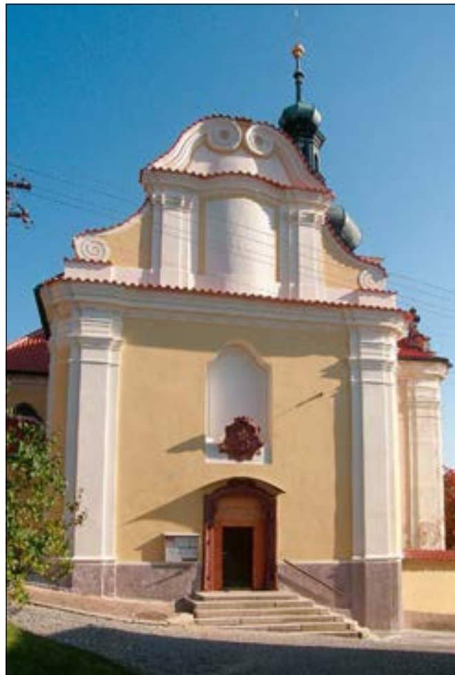
Mníchovice (správní obvod obce Říčany), kostel Narození Panny Marie – pohled na obnovené východní průčelí s restaurovaným vstupním portálem a erbem z červeného pískovce (foto B. Schmidová).
