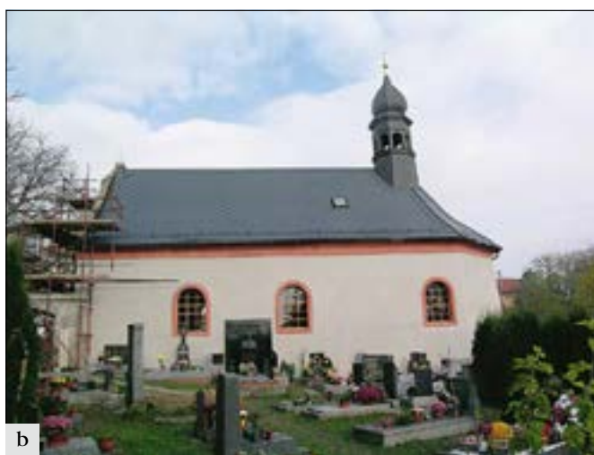
Paběnice (správní obvod obce Kutná Hora), kostel sv. Bartoloměje: a – jižní fasáda před opravou, b – jižní fasáda po opravě (foto M. Jedlička).
