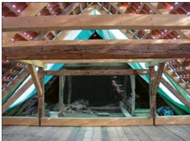
Slatina, (správní obvod obce Kladno), kostel sv. Vojtěcha, oprava tesařské vazby krovu kostela pokračovala další etapou nad východní částí lodi směrem do presbytáře, protězy se napojovaly tesařskými spoji jištěnými kolíky pod dohledem památkového statika (foto E. Volfová).
