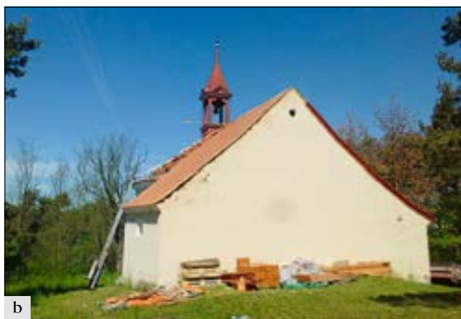
Libčice (správní obvod obce Dobříš), kostelík sv. Petra a Pavla, po loňské obnově krovu následovala pokládka krytiny: a – náročné pokrytí kuželové plochy si žádá zkušené řemeslníky; b – štít obdélné sakristie byl původně kryt plechem a jeho odstraněním drobný kostelík získal zpět jemné křivky s taškami tradičně zakončenými na štítu (foto H. Řepková).
