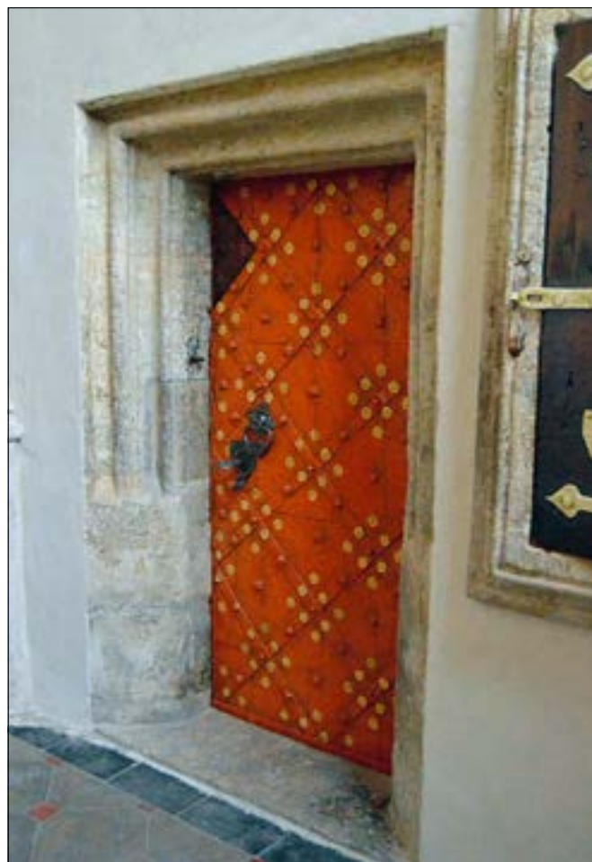
Kolín, (správní obvod obce Kolín), MPR, chrám sv. Bartoloměje, sakristie, dveře ze sakristie na schodiště do klenotnice, stav po restaurování. Byla obnovena formou rekonstrukce na nové vrstvě nálezoavá situace nejspodnější povrchové úpravy s kyticami malovanými podle šablony (foto D. Havlíková).
