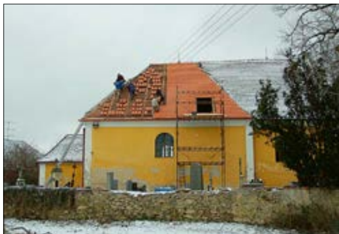
Všebořice (správní obvod obce Vlašim), kostel sv. Jiljí, oprava střechy. V roce 2017 byla nad lodí po lokální opravě a doplnění krovu položena nová krytina z pálených bobrovek. V příštím roce má být opravena i střecha nad presbytářem (foto D. Primusová).
