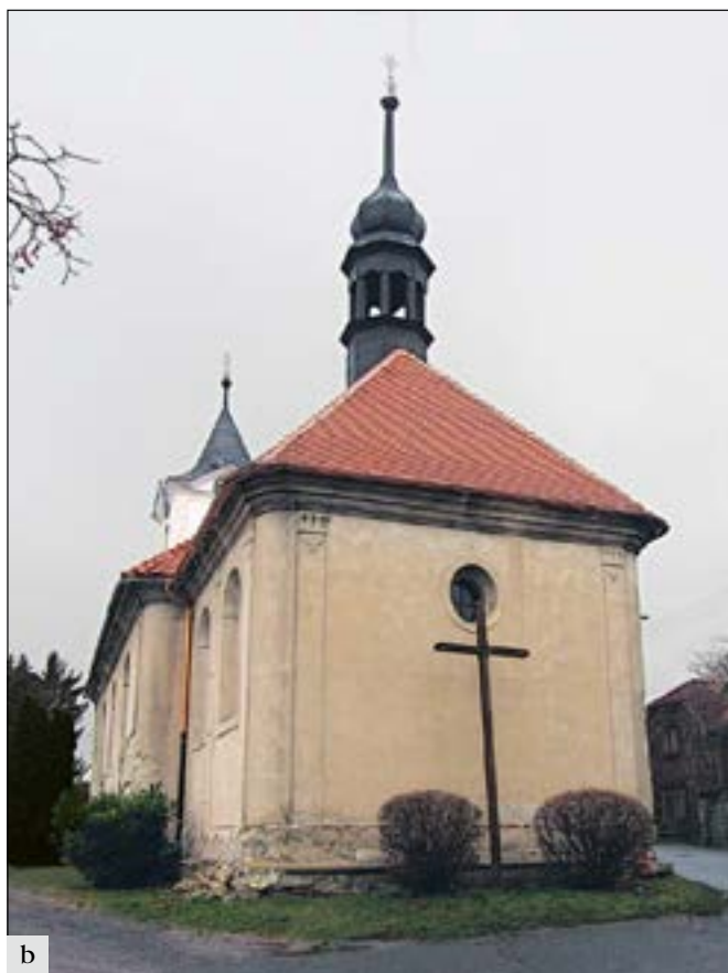
Kostelní Hlavno, (správní obvod obce Brandýs nad Labem – Stará Boleslav), kostel sv. Petra v okovech: a – pohled na presbytář kostela od jihovýchodu před zahájením prací na obnově střechy; b – pohled tamtéž po provedení obnovy střechy. Novodobá plechová krytina byla nahrazena bobrovkou a celkový vzhled nyní více odpovídá kulturní památce (foto V. Hlaváčková).
