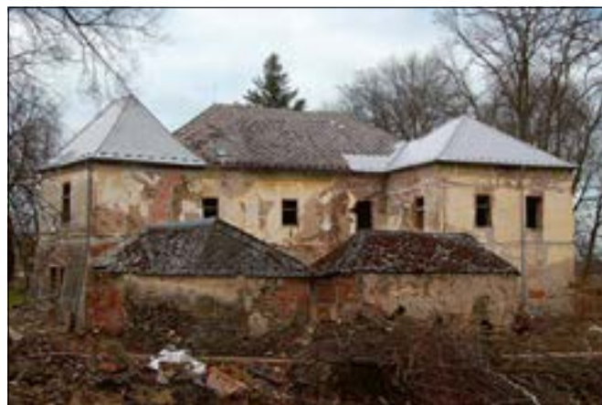
Vlčkovice (správní obvod obce Votice), zámek, oprava střechy. Na budově zámku, původně gotické vodní tvrzi, který je ohroženou památkou, pokračovala obnova střechy opravou jihozápadního křídla. Krov a bednění byly tesařsky opraveny a byla položena nová krytina ze šedých vláknocementových šablon (foto D. Primusová).
