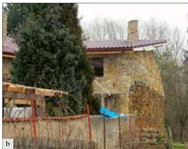
Zápy-Ostrov, (správní obvod obce Brandýs nad Labem), tvrz čp. 142: a – pohled na obytnou budovu se zbytky zdiva gotického paláce a na pozdně gotické torzo věže s obytnou vestavbou z počátku roku 2017 před započatím nepovolených stavebních prací; b – pohled na otřesně „zrekonstruované“ pozdně gotické torzo věže v závěru roku 2017. Z fotografie je jasně patrné původní zdivo věže a zdivo dostavěné v průběhu roku 2017. Markantní je i nepochopitelné zešíkmení zdiva (foto V. Hlaváčková).
