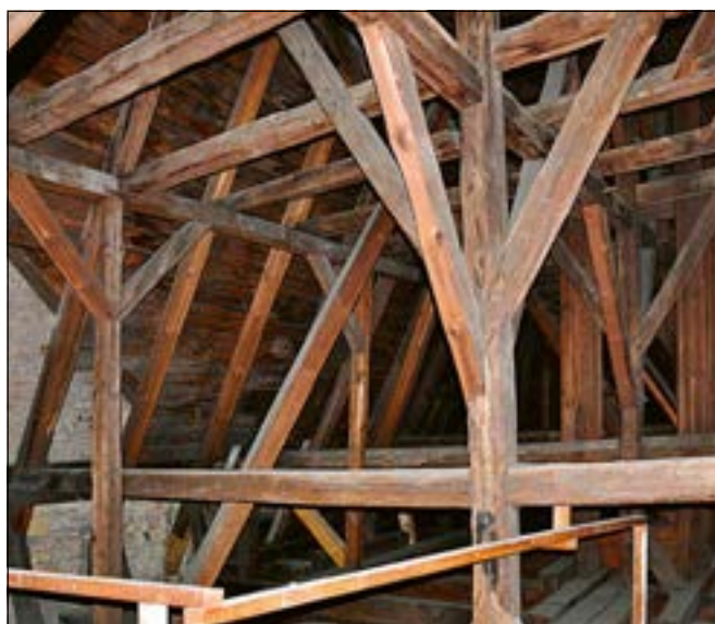
Rakovník, kostel sv. Bartoloměje. Rakovnický děkanský kostel se stal pro svou instruktivnost a metodické hodnoty předmětem systematického výzkumu v rámci projektu DKRVO – nemovité památky. Velmi cenné jsou pozdně gotické krovy nad hlavní lodí a kněžištěm. Krov nad presbytářem (na snímku pohled k severovýchodu) je pozoruhodný mimo jiné příčnými vodorovnými trámy v dolní úrovni (na snímku dole), které nejspíše vynášely ikonograficky doložený obranný ochoz (foto V. Razím, 2017).
