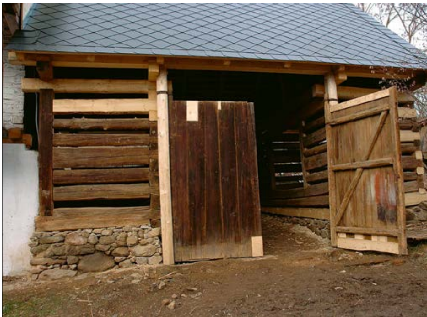
Rudoltice (správní obvod obce Votice), roubená stodola v areálu bývalé kovárny čp. 2 po dokončení celkové obnovy. Roubené stěny musely být vzhledem k rozsahu poškození rozebrány a následně na pečlivě vyzděnou podezdívku složeny v původní skladbě. Poškozené části stěn i vrat byly doplněny v nejnutnějším rozsahu (foto J. Berková).
