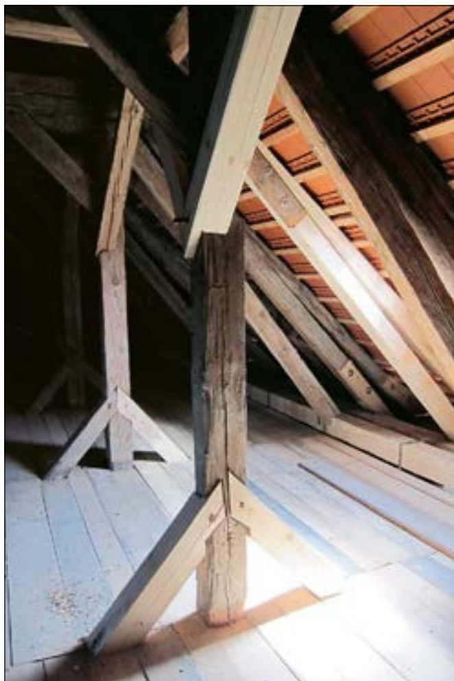
Luštěnice (správní obvod obce Mladá Boleslav), kostel sv. Martina, krov jižní strany kostela po opravě (foto D. Linhartová).
