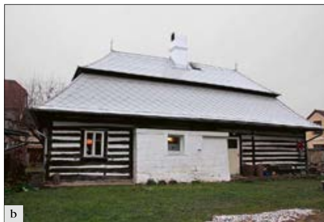
Kněžmost (správní obvod obce Mnichovo Hradiště), Branžežská ulice čp. 59: a – stav před obnovou střešního pláště v srpnu 2017. Pozoruhodné bylo časně užití krytiny z falcovaného plechu na venkovském domě (20. léta 20. století), spojené s dekorativními makovičkami. Plech se však neosvědčil esteticky ani funkčně; b – stav po obnově střešního pláště v prosinci 2017. Oprava střechy za pomoci tradičních materiálů a postupů vnějšímu výrazu střechy významně prospěla (foto A. Rákosníková).
