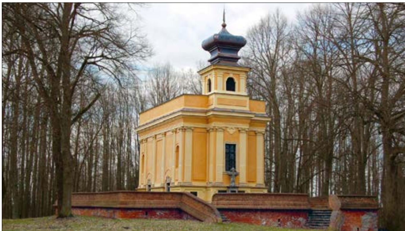
Bolinka (správní obvod obce Vlašim), Loreta, kaple Panny Marie, celková obnova. Doplněním omítek vnějšího soklu po jeho předchozím odsolení byla dokončena náročná a velmi zdařilá obnova pláště kaple, při které byly postupně opraveny střechy a fasády bohatě členěné kamennými a štukovými prvky. Na věž byla podle historické fotografie i nálezu torza na místě navrácena korouhev ve tvaru siluety Panny Marie Loretánské (foto D. Primusová).
