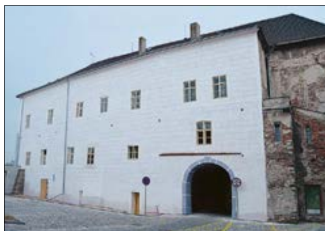
Kolín, (správní obvod obce Kolín), MPR, zámek, západní fasáda západního křídla, stav po restaurátorské rekonstrukci sgrafitové výzdoby (foto D. Havlíková).
