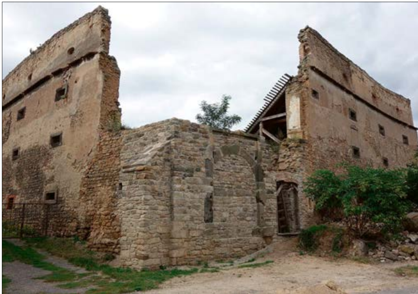
Vyšehořovice (správní obvod obce Brandýs nad Labem) pohled na jihovýchodní nároží tvrze s v roce 2017 realizovanou rekonstrukcí části brány s portálem a vpadlinou pro padací most, která zanikla při zřícení před čtvrt stoletím. Tohoto výsledku se podařilo dosáhnout díky velkému zájmu majitelů, dobré projekční přípravě a zodpovědnému přístupu zhotovitele za podpory z Programů MK. Po úplném dozvěnění nároží se předpokládá provedení určité omítkové úpravy, která rekonstruovanou část více začlení do celku (foto J. Žižka).
