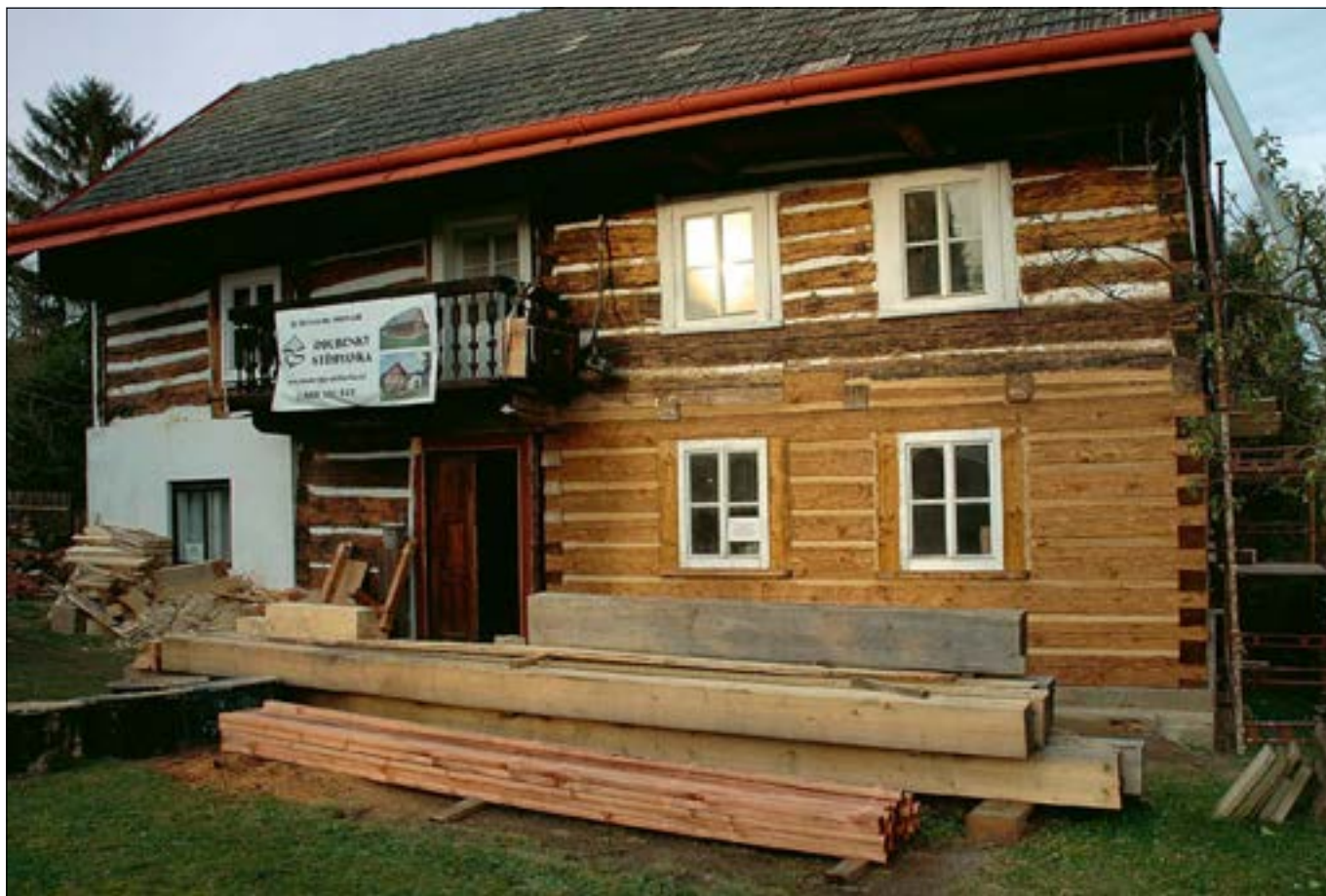
Nosálov (správní obvod obce Mělník), roubený dům čp. 25 je situován v chalupnické enklávě VPR. Stav po dokončení obnovy roubených stěn světnicového dílu. Nahrazením novodobých přízdivek kvalitním roubením byla rehabilitována původní konstrukce. Druhá část domu bude obnovena v následujícím roce (foto J. Berková).
