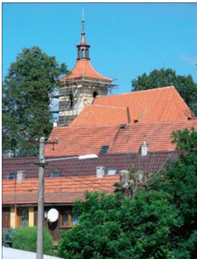
Svárov (správní obvod obce Kladno), kostel sv. Lukáše, pohled na dokončenou opravu věže od jihovýchodu, současně byla dokončena oprava hlavních střech kostela, zbývá opravit havarijní stav o patro nižší střechy nad sakristií s předsíní (foto E. Volfová).
