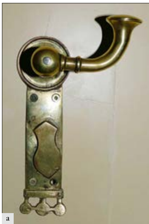
Lysá nad Labem (správní obvod obce Lysá nad Labem), evangelická fara: a, b, c – příklady repasovaných tvarově velmi zajímavých dobových klik a klíčových štítků od začátku 19. století po jeho konec. Nepříznivě v tomto kontextu však působí novodobé křížové šroubky, které nahradily původní nýty (foto E. Zápalková).
