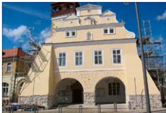
Dobruška (správní obvod obce Mladá Boleslav), radnice, oprava skarpovitých pilířů východního průčelí (foto D. Linhartová).
