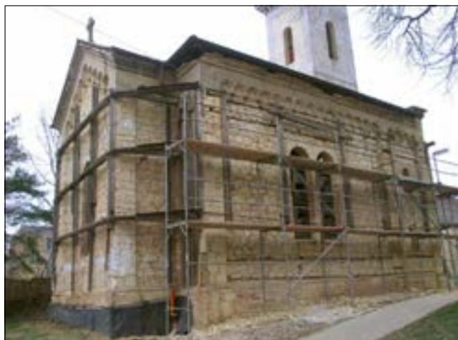
Mutějovice (správní obvod obce Rakovník), kaple sv. Prokopa od severovýchodu po dokončení další etapy statického zajištění stavby (foto E. Volfová).
