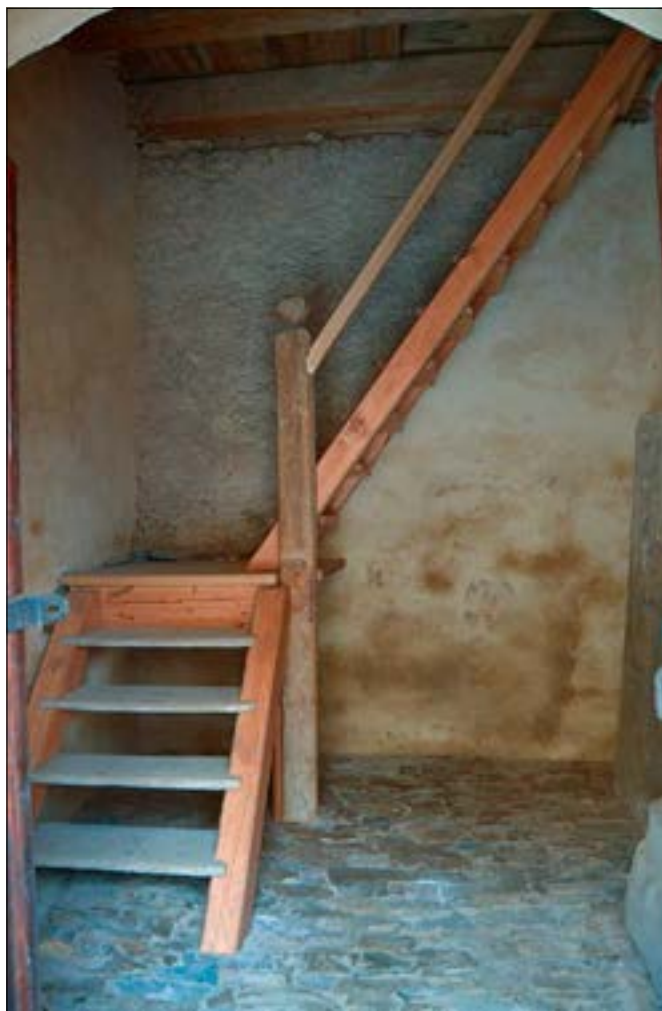
Třebovle (správní obvod obce Kolín), zvonice areálu kostela sv. Bartoloměje, pohled do interiéru přízemí s novou dlažbou, repasovaným schodištěm a obnovenými omítkami (foto D. Havlíková).
