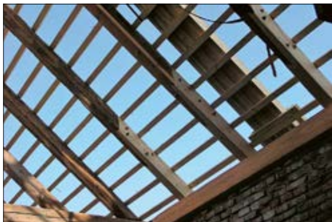
Třebíz (správní obvod obce Kladno), stodola v areálu usedlosti čp. 1. Tesařské protězy krokví severní střešní roviny. Pohled z interiéru zachycuje šikmočelé tesařské pláty fixované dřevěnými kolíky (foto M. Hanzlíková).
