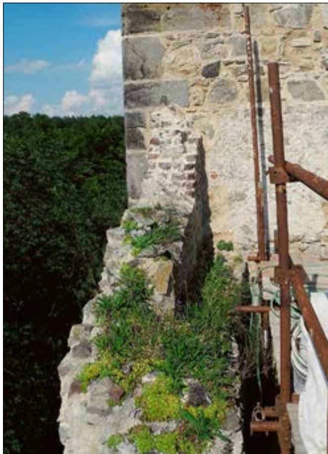
Boseň (správní obvod obce Mnichovo Hradiště), zřícenina hradu Valečov, pohled na korunu dochované části severní hradby při průčelí hlavního paláce po konzervaci. Konzervace byla provedena s respektem k původnímu zdivu a dochovanému detailu šikmé plochy na koruně zdi. Doplněno bylo spárování s pečlivým zatažením k povrchu zdiva proti zatékání. Zelený drn byl sejmут a po konzervaci navrácen zpět (foto E. Vyletová).
