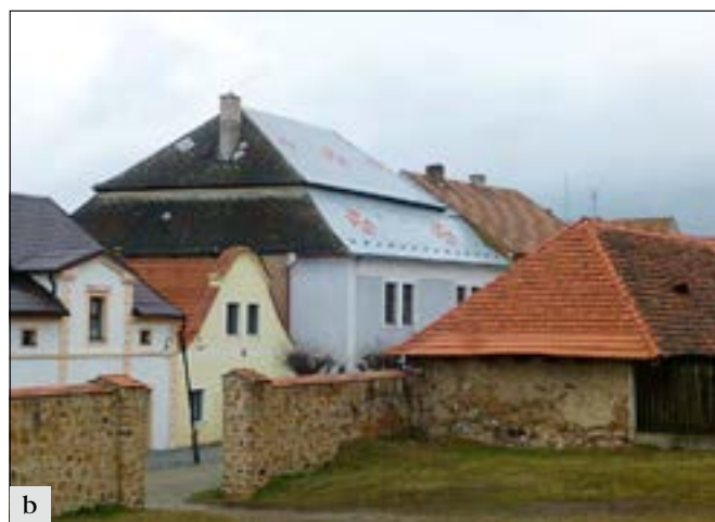
Žebrák (správní obvod obce Hořovice), na v jádru gotickém domě pražského arcibiskupa Konráda z Vechty proběhla druhá etapa obnovy vrchní části mansardového krovu. Západní část krovu navázala na dokončenou obnovu jižní části. Dokončen byl západní úsek střechy, na němž byla položena krytina ze světlešedých šablon a zopakován vzor z šablon červených. Zbývá ještě dvorní část střechy. Impozantní střecha tohoto historicky významného domu je z uliční strany dokončena s výjimkou zakončení krokví. K dokonalosti chybí jen omítnutí komínu a obnova komínové hlavice: a – stav v roce 2017; b – stav v roce 2016 (foto H. Řepková).
