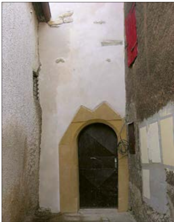
Buštěhrad, (správní obvod obce Kladno), lokalita Starý hrad, dům čp. 13, oprava ohradní zdi s gotickou brankou, povrch opukového zdiva po otlučení omítek byl velmi degradovaný a rozpadávající se, došlo k jeho zpevnění a opatření do hladka utahovanou jednovrstvou nastavovanou omítkou (foto E. Volfová).
