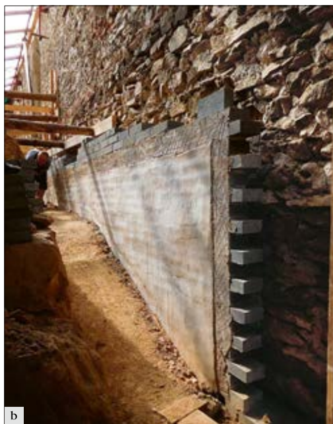
Kutná Hora-Sedlec (správní obvod obce Kutná Hora), kaple Věch Svatých s kostnicí. Generální oprava sedleckého karneru pokračovala další etapou, která po dokončení náročného archeologického výzkumu měla především za cíl eliminovat tvoření vlhkosti stěn spodního ossaria, a to výstavbou předstěny z nenasákavých cihel, opatřenou hydroizolačními omítkami. Tato situace je konstrukčně nezávislá na původním zdivu a bude skryta pod terénem: a – celkový pohled na rekonstruovaný karner od severovýchodu, b – detail konstrukce stěny ve výkopu (foto A. Pospíšil).
