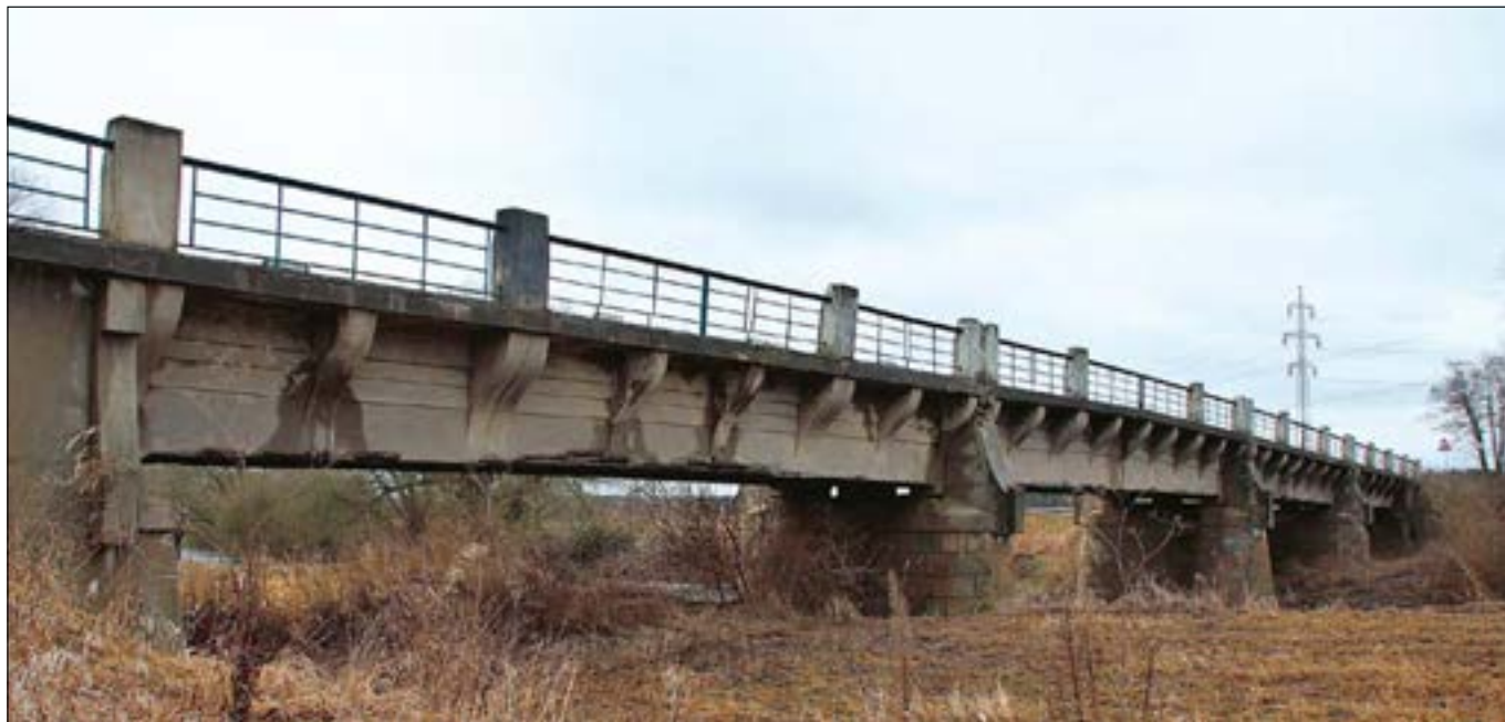
Sojovice (správní obvod obce Mladá Boleslav), silniční most přes Jizeru, pohled na návodní stranu v únoru 2017. Stávající most nevyhovuje především svojí malou šířkou. Po postavení kapacitnějšího nového mostu by mohl sloužit například pěším nebo cyklistům (foto A. Rákosníková).
