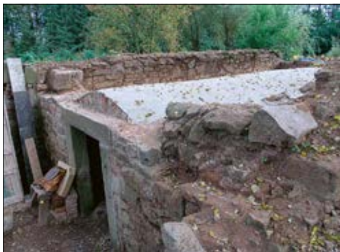
Pšovlky (správní obvod obce Rakovník), sklep na tvrzišti, statické zajištění obvodového zdiva s dozděním propadlé části valené klenby, stav po dokončení této etapy oprav (foto E. Volfová).
