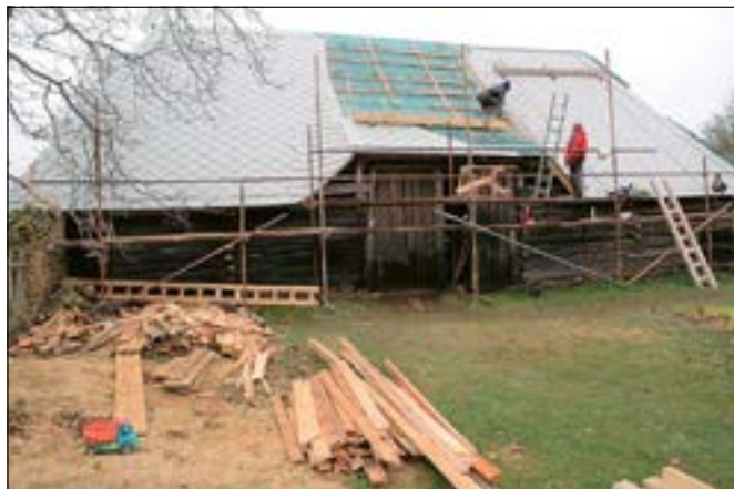
Bahno (správní obvod obce Kutná Hora), stodola v usedlosti čp. 16. Průběh obnovy střešního pláště. Původní krytinou na střeších těchto staveb byly slaměné došky, které umožňovaly měkké vykrytí náběhů střechy nad vraty. V tvrdé krytině vyžaduje tento úkol nemalou řemeslnou zdatnost (foto J. Berková).
