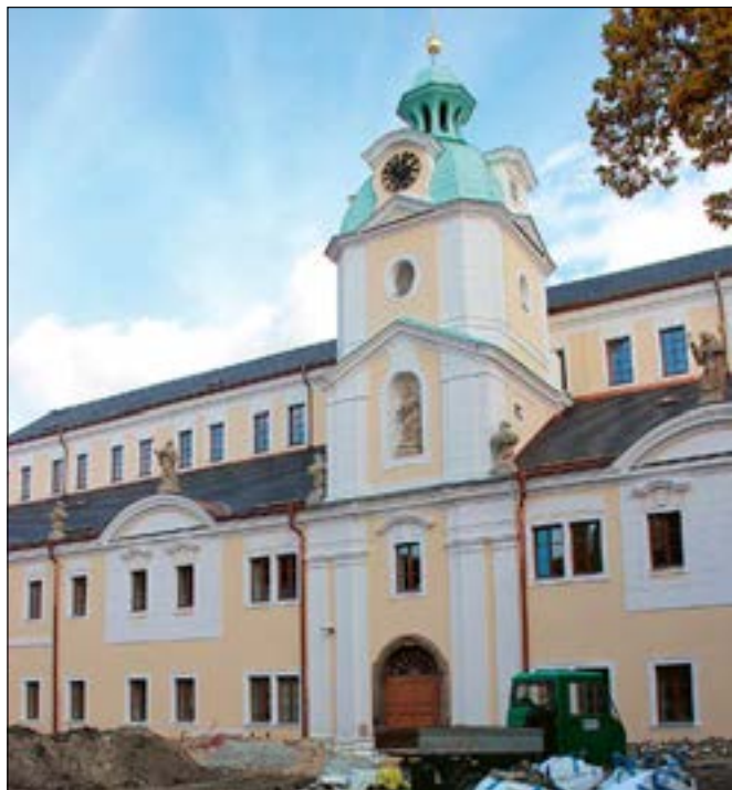
Kutná Hora-Sedlec (správní obvod obce Kutná Hora), čp. 1. Stěžejní akcí byla třetí etapa obnovy střešního pláště budovy mohutného trojlodního konventu v areálu společnosti Philip Morris ČR a.s. Na západní pultové střeše vystřídala plechovou krytinu přírodní břidlice. Zcela se proměnil prostor nádvoří novým řešením komunikačních tras a výsadbou zeleně, podporující atmosféru rajského dvora, která se však zazelená až v následujícím jaře (foto A. Pospíšil).
