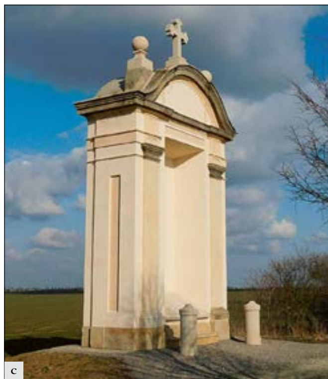
Litovice (správní obvod obce Černošice), kaple č. 18 poutní cesty do františkánského kláštera v Hájku. Příklad anastylózy stavby, zřícené v 80. letech 20. století, která byla znovu vystavěna s využitím zachovaného původního stavebního materiálu a kamenných článků. Znovu vztyčení kaple je významné z hlediska architektonického celku hájecké poutní cesty, která tak byla doplněna o nedílný chybějící prvek, i z hlediska krajinnotvorných souvislostí: a – stav zřícené kaple k roku 2013; b – pohled do restaurátorské dílny na zachráněné kamenné prvky, vyzvednuté z rumiště v roce 2015; c – kaple po celkové anastylóze, vysvěcená 9. 9. 2017 arcibiskupem Dominikem Dukou (foto E. Zápalková).
