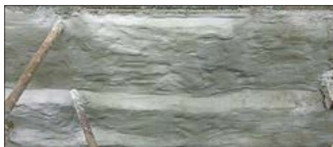
Sídlo NPÚ ÚOP SČ v Sabinově ulici, kde proběhlo odvlhčení stěn sklepa přední budovy (stav v létě 2017, foto L. Havlovic).
