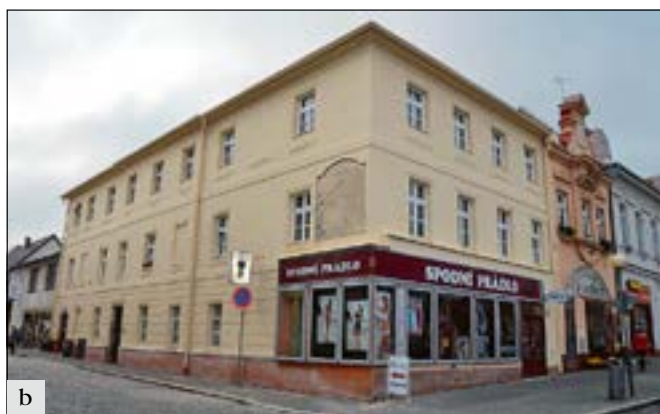
Čáslav (správní obvod obce Čáslav), dům čp. 161 před a po obnově fasády: a – před obnovou byla strádmá klasicistní fasáda domu nevhodně rozbarvena, detaily keramických tvarovek byly znejasněny vrstvami nátěrů, řada tvarovek byla poškozena nebo zcela chyběla; b – zachované tvarovky byly očištěny a doplněny kopiemi. Fasáda byla sjednocena monochromním nátěrem v neutrálním odstínu, zvoleném s ohledem na sousední objekty. Starší nátěry byly zdokumentovány v rámci stratigrafického průzkumu fasády před obnovou (foto B. Schmidová).
