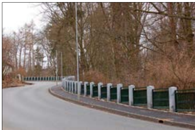
Vlašim (správní obvod obce Vlašim), úprava severní hranice zámeckého parku. Na místě zbytků ohradní zdi, starých plotů a zábradlí podél havarijního chodníku při silnici mezi Vlašimi a Domašínem byla vybudována nová tarasní zeď, která byla oplentovaná kamenem a na kterou bylo vystavěno hrazení ze žulových pilířů, mezi které byla vkládána pole kovového zábradlí. Toto masivní řešení bylo navrženo kvůli požadavkům vyplývajícím z provozu na komunikaci. Stejná zábradlí již byla realizována v historickém centru města. Podél hrazení byl vytvořen nový chodník pro pěší. Celá stavba v délce několika stovek metrů prostředí esteticky i provozně zkvalitnila a zajišťovala bezpečný pohyb místních občanů i návštěvníků zámeckého parku (foto D. Primusová).
