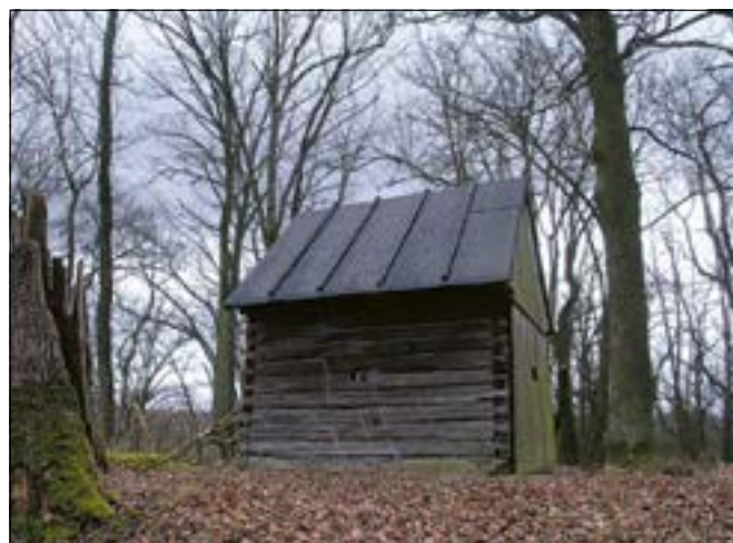
Hřebečnický (správní obvod obce Rakovník), roubený sroubek na Písařově vrchu po provedené výměně pásů lepenky na bednění sedlové střechy; oprava vypadající jednoduše byla náročná svojí přípravou s donesením potřebného nářadí a materiálu na vrchol zalesněného kopce (foto E. Volfová).
