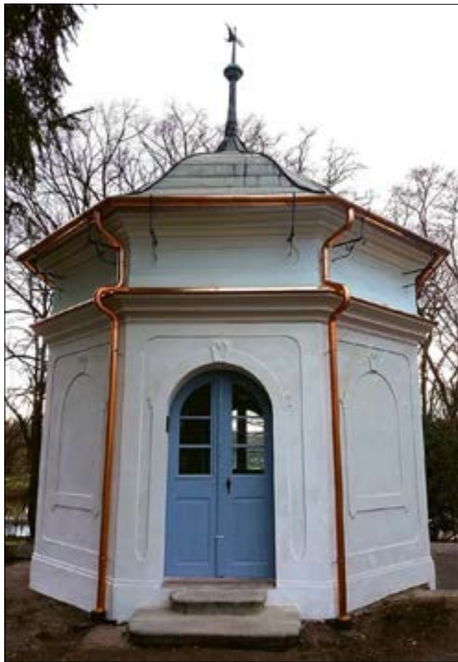
Poděbrady (správní obvod obce Poděbrady), altán Gloriet, v roce 2017 byla dokončena instalace nového okapového systému s napojením na dešťovou kanalizaci, přezděna poškozená klenba suterénu, položena nová podlaha na 1. NP, zrestaurováno původní zábradlí na balkóně, doplněny kamenné prvky, provedeny klempířské práce, repasovány původní okenní výplně i s okenicemi, opravena vnitřní a vnější fasáda (foto E. Markusová).
