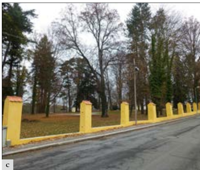
Sedlec-Prčice (okres Příbram), oplocení zámku Prčice: a – příklad zbytečné práce se zhotovením stříšek pílířů bez předchozí konzultace s velkými přesahy a ahistorickým kladením tašky bobrovky; b – upravené stříšky po konzultaci s minimálním přesahem a tradičním kladením tašky; c – opravené oplocení před osazením dřevěných výplní (foto H. Řepková).
