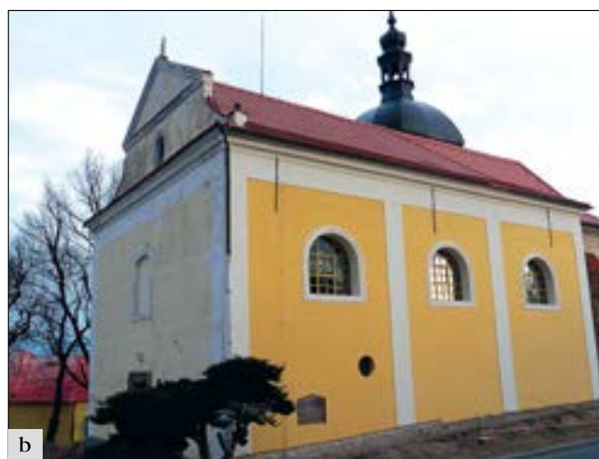
Hořovice (okres Beroun), kostel sv. Jiljí: a – jižní průčelí kostela na začátku roku 2016; b – jižní průčelí po zakrytí nálezů, obnově plastických článků a repasi oken (foto H. Řepková).
