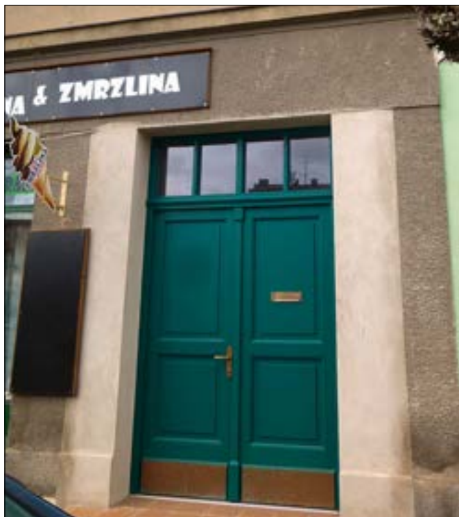
Sedlec-Prčice (okres Příbram), dům čp. 63 v Sedlci. Nové dřevěné vchodové dveře v tradičním dělení nahradily stávající nevhodné hliníkové dveře. Lépe tak zapadají do MPZ (foto H. Řepková).
