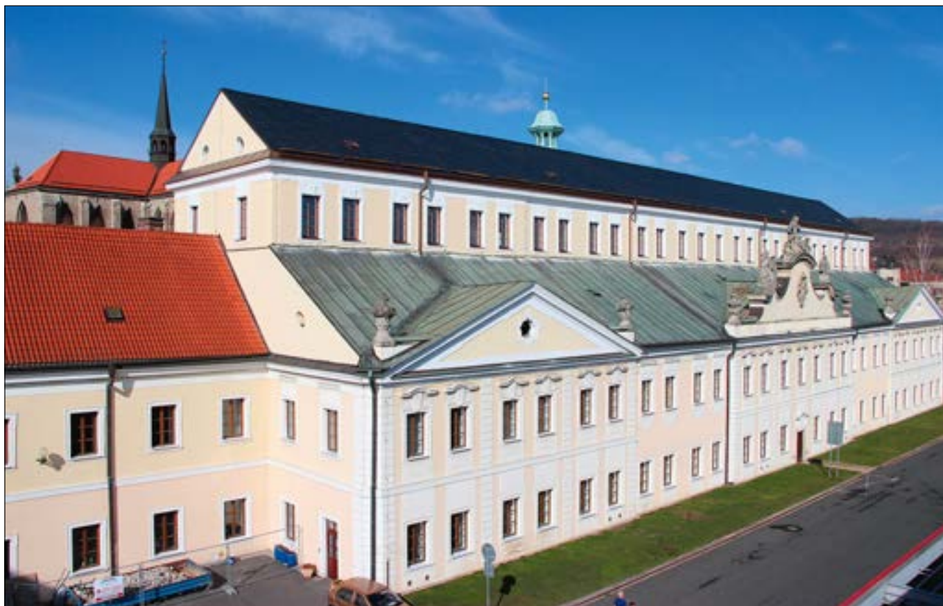
Kutná Hora – Sedlec (Kutná Hora), čp. 1. Mimořádnou akcí byla druhá etapa obnovy střešního pláště budovy mohutného trojlodního konventu v areálu firmy Philip Morris ČR a.s. Krovová konstrukce, datovaná do let 1864–65, patří mezi nejprogresivnější dobové konstrukce tohoto typu v Čechách. Po citlivé tesařské opravě nahradila krytinu z plechových šablon přírodní břidlice o celkové výměře úctyhodných 1130 m 2 . Obnoveny byly rovněž fasády s rekonstrukcí klenáků podle historické fotodokumentace (foto A. Pospíšil).
