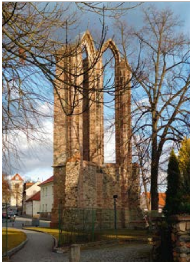
Benešov (okres Benešov), areál minoritského kláštera, zřícenina kostela. V roce 2016 byla dokončena celková obnova torza, které je symbolem města. Zdivo bylo restaurováno – cementové a drolící se výplně spár byly odstraněny, kaverny vyplněny menšími kameny, degradované kvádry z červeného pískovce zpevněny a bylo provedeno nové spárování. Horní vodorovné plochy byly zakryty olověným plechem, který se pohledově nijak neuplatňuje (foto D. Primusová).
