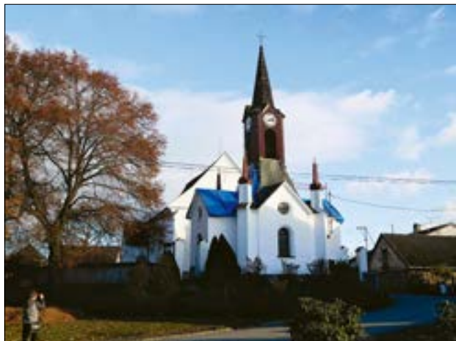
Psáře (okres Benešov), areál kostela Nejsvětější Trojice, zvonice, oprava střechy. Oprava šindelové střechy, do které již zatékalo, byla započata opravou spodní části krovu, včetně zvonové stolice. V dalším roce bude provedena oprava krovu jehlanové střechy věže a dokončena pokládka štípaného šindele (foto D. Primusová).
