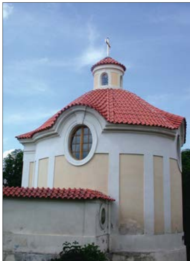
Středokluky (okres Praha-západ). Pohled na oválnou kapli sv. Kříže z roku 1725 s novou prejzovou krytinou kladenou přímo na rub klenby. Provedena i lokální štukatérská oprava fasády lucerny a oprava okenních výplní z šestihranů z čírého skla, spojovanými olověnými pásky. Kovaný latinský kříž byl pozlacen (foto E. Zápalková).
