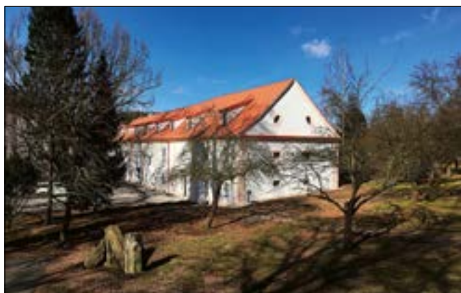
Pyšely (okres Benešov), areál zámku, sýpka, celková obnova. Barokní sýpka v areálu zámku byla upravována pro účely zařízení pro nemocné Alzheimerovou chorobou. Jednalo se o náročnou akci, při které byly kvůli budoucímu využití provedeny velké zásahy do stropních konstrukcí. Vzhledem k tomu, že se jednalo o dlouhodobě nevyužívaný objekt, jehož všechny konstrukce byly v havarijním stavu, lze opravu ohodnotit jako zdařilou (foto D. Primusová).
