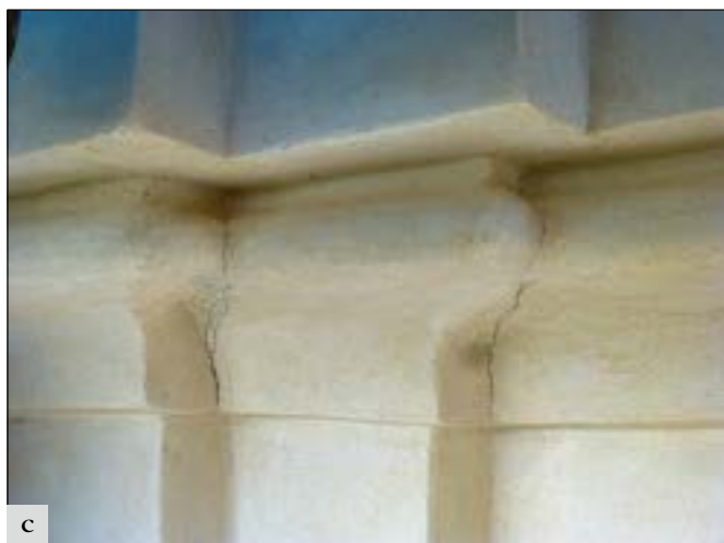
Osov (okres Beroun), kostel sv. Jana Křtitele: a – dokončení severozápadního nároží; b – stav atiky před obnovou; c – zpřesňování profilace atiky (foto H. Řepková).
