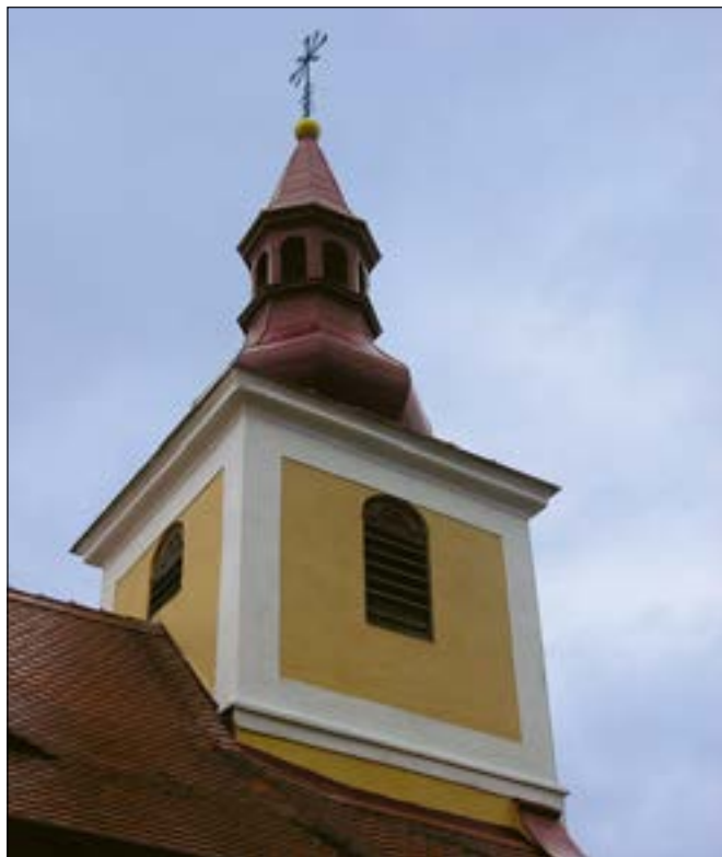
Pochvalov (okres Rakovník), kaple sv. Prokopa. V rámci celkové opravy stavby se podařilo uskutečnit další etapu opravy, a to celku průčelní věže s opravou krovu, novým oplechováním, výměnou hrotnice s novým kovaným křížem a obnovou fasádních omítek (foto E. Volfová).
