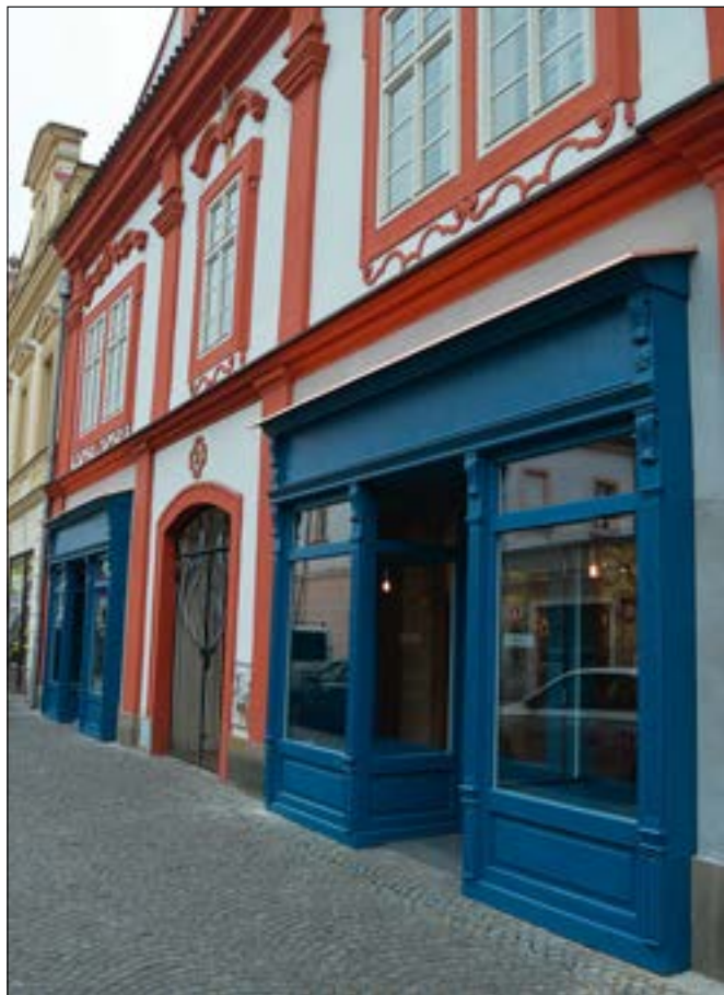
Kolín (okres Kolín), MPR, dům čp. 3 v Pražské ulici, pohled na uliční fasádu s novými přesazenými výkladci (foto D. Havlíková).
