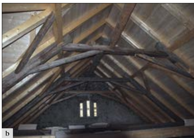
Bratřejov (okres Příbram), usedlost čp. 8: a – krov objektu s chlévy a stájemi byl v havarijním stavu, který vyžadoval citlivé rozebrání krovu a opravu koruny zdí; b – následně byla část původní krovové konstrukce opětovně sestavena, tesařsky opravena a doplněna. Střešní plášť byl opět proveden z pálených bobrovek (foto J. Berková).
