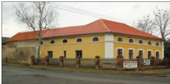
Chotouň (okres Kolín), obytné stavení usedlosti čp. 3, stav v únoru 2017. Krov se podařilo zachovat a lokálně opravit. Položená krytina je však vzhledem k jeho charakteru nevhodná (foto A. Rákosníková).
