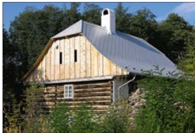
Starosedlský Hrádek (okres Příbram), roubený, tzv. Panský, mlýn čp. 4 po obnově střešního pláště a komínové hlavičky (foto M. Hanzlíková).
