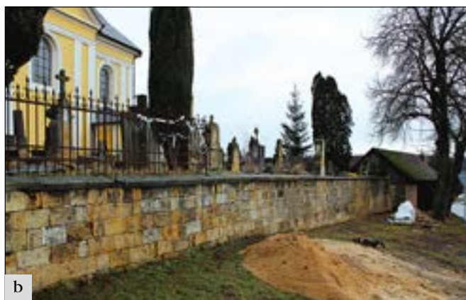
Chroustov (okres Nymburk), obnova ohrazení hřbitova kolem kostela Nanebevzetí Panny Marie: a – střední část ohrazení a zároveň opěrné zdi hřbitova byla vykloněna ze svislé osy a hrozilo její vyvalení; b – po rozebrání narušené části zdí byla provedena nová železobetonová opěrná zeď (2015), která byla v tomto roce zakryta obnovenou zdí z pískovcových kvádrů. V průběhu stavby bylo rozhodnuto o přezdění lícové zdi v širším úseku, aby došlo k plynulejšímu napojení na zachovávané zdivo (foto A. Jankulíková).
