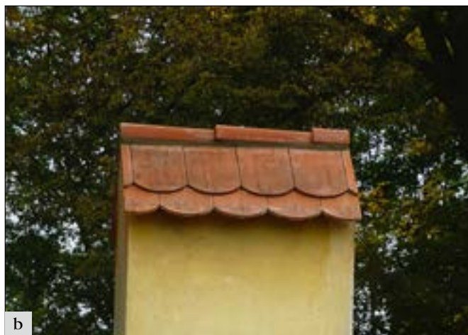
Sedlec-Prčice (okres Příbram), oplocení zámku Prčice: a – příklad zbytečné práce se zhotovením stříšek pílířů bez předchozí konzultace s velkými přesahy a ahistorickým kladením tašky bobrovky; b – upravené stříšky po konzultaci s minimálním přesahem a tradičním kladením tašky; c – opravené oplocení před osazením dřevěných výplní (foto H. Řepková).
