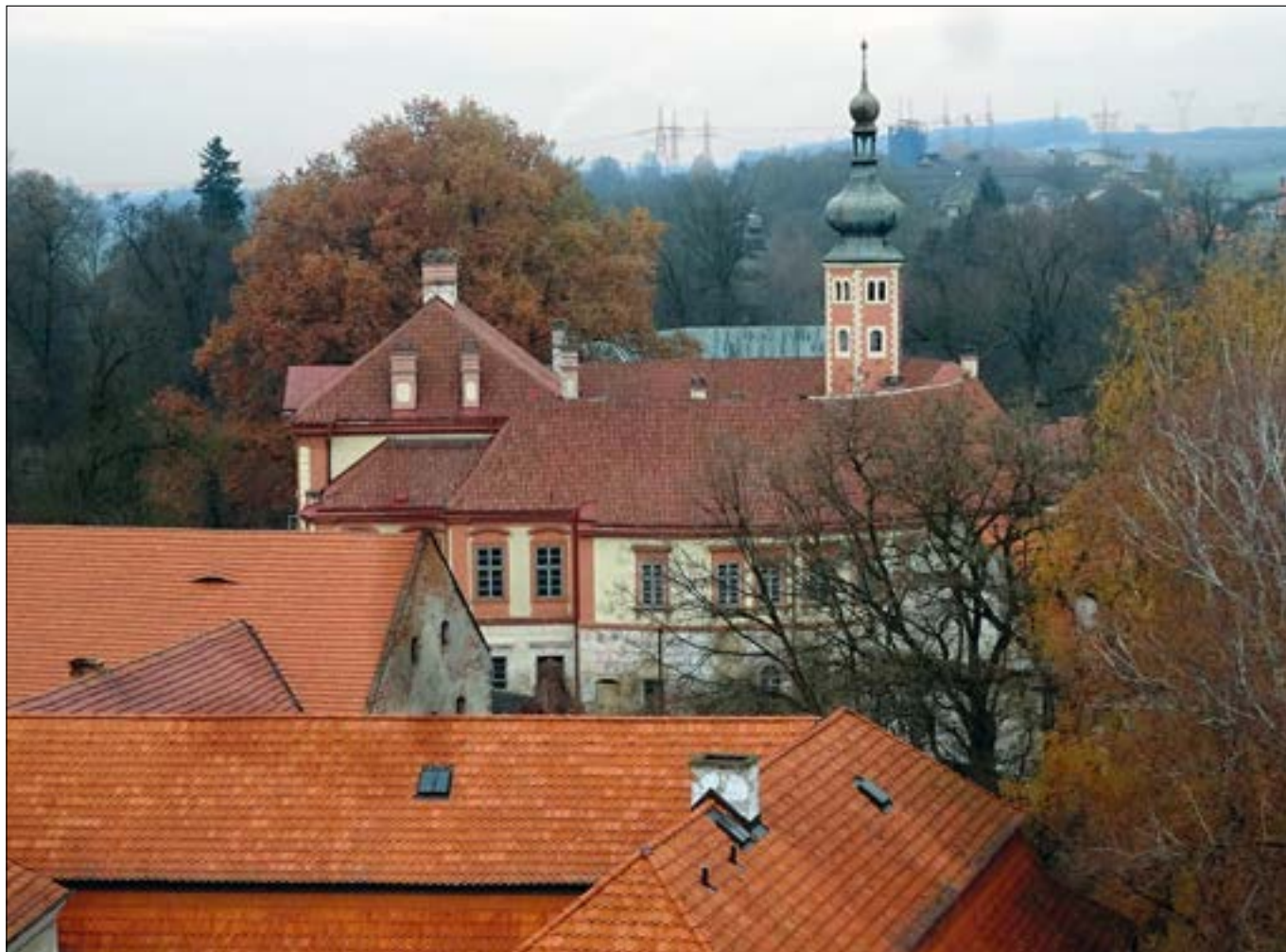
Liběchov (okres Mělník), pohled na zámek z lešení u vrcholu štítu kostela sv. Havla. Lešení zhotovené pro opravy památek vždy umožní zajímavé pohledy do okolí. Při opravě štítu kostela se nabízel pozoruhodný pohled na zámek, kde se po dlouhých letech podařilo zahájit a realizovat první etapu obnovy prejzové krytiny. V popředí se výrazně uplatňují střechy budov pivovaru (foto J. Žižka).
