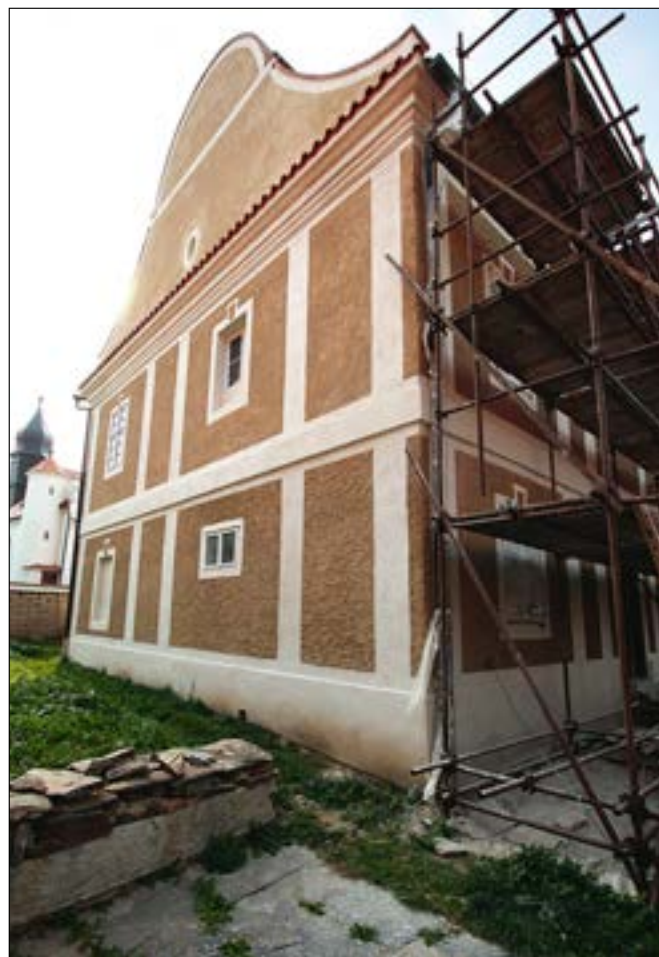
Krchleby (okres Kutná Hora), klasicistní budova fary čp. 56 z konce 18. století – pokračování obnovy strukturovaných omítek fary kombinujících hrubší plochy s hladkými články. Obnova fasády proběhla s využitím tradičních technik a materiálů (foto M. Gottwaldová).
