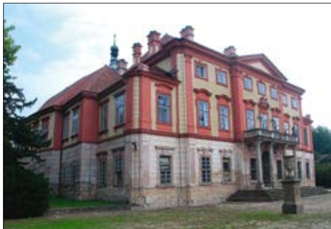
Liběchov (okres Mělník), zámek, významná památka, původně využívaná jako jedna z budov s atraktivními expozicemi Národního muzea. Dlouhodobě je tato budova ponechána bez využití a k jejímu zachránění přispělo i zcela zbytečné osekání spodního pásu omítek fasády i většiny omítek v přízemních místnostech. Tato reakce na několikadenní zaplavení místa vodou z řeky Labe v roce 2002 neměla žádný význam, jak svědčí dobře dochované omítky v několika místnostech, které před tímto zničením zachránila cenná malířská výzdoba (foto J. Mrázek)
