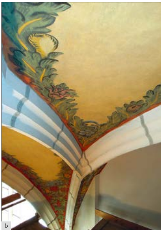
Mělník (okres Mělník), kostel sv. Petra a Pavla. V roce 2016 byla provedena další etapa statického zajištění a restaurování kleneb lodi kostela: a – podchycená žebra kleneb a opadaná výmalba v lodi kostela před zahájením obnovných prací a restaurování; b – žebra a výmalba kleneb po provedení obnovných prací a restaurování (foto V. Bártová)
