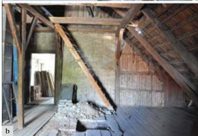
Kosmonosy (okres Mladá Boleslav), bývalý špitál čp. 142. Hrzděné dělicí stěny, zejména v prostorech půd a krovů, patří mezi konstrukce, které zpravidla při rekonstrukcích zanikají: a – obrázek zachycuje podobu líce, b – rub hrzděné podkrovní příčky se zřetelnou skladbou výplně z tyčoviny s hliněnou omazávkou. Konstrukce vyniká vysokou mírou autenticity (foto J. Veselý, 2016).
