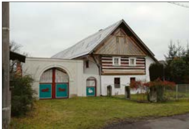
Březinka (okres Mladá Boleslav), čp. 19. Obnova hlavního průčelí usedlosti vycházela z dobové kolorované fotografie z období přelomu 19. a 20. století, podle které bylo obnoveny zaniklé členění brány i originální podoba vjezdových vrat včetně barevnosti (foto J. Berková).
