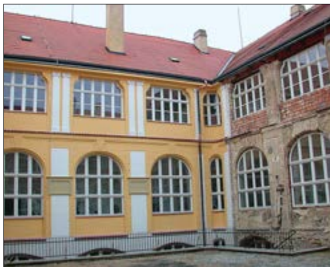
Tuchoměřice (okres Praha-západ). Pohled na dokončené jižní průčelí a dosud neopravené západní průčelí vnitřního dvora barokní čtyřkřídlé jezuitské rezidence. V případě východního a jižního průčelí jde o kvalitně provedenou odbornou štukatérskou práci s náročnou rekonstrukcí mnohde již chybějících předloh. Do tvarových replik dvou nápisových desek z konce 19. století byly nově vyryty nápisy FVN DATVM MDCLXVII a RENOVATVM MMXVI (foto E. Zápalková).
