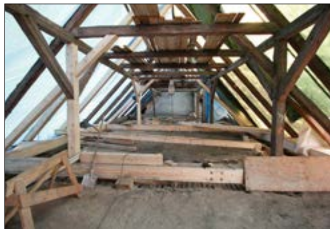
Žehušice (okres Kutná Hora), hospodářská budova (obytné stavení s chlévy) v předzámčí zámeckého areálu – detail opravy krovu s výměnou a doplněním dožilých prvků (foto M. Gottwaldová).
