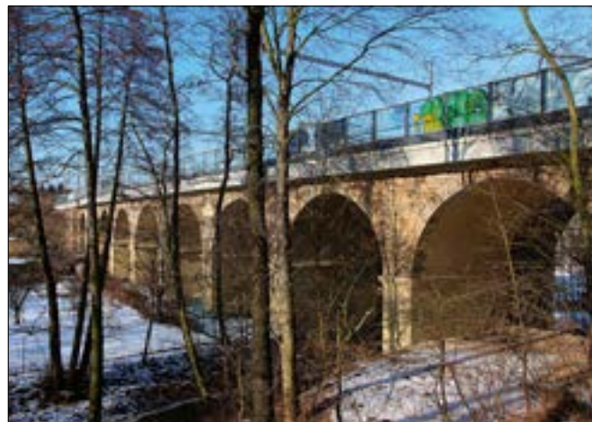
Úvaly (okres Praha-východ), devítiobloukový železniční most přes Výmolu v km 387,144, stav v lednu 2017 po dokončení pískového nátěru. Komplikace nastaly v případě původně plánovaného odstranění novodobé cementové omítky pilířů a kleneb. V důsledku negativně vyhodnocených vzorků byly omítky z větší části ponechány a konstrukce byla opatřena pouze prodyšným sjednocujícím nátěrem (foto A. Rákosníková).
