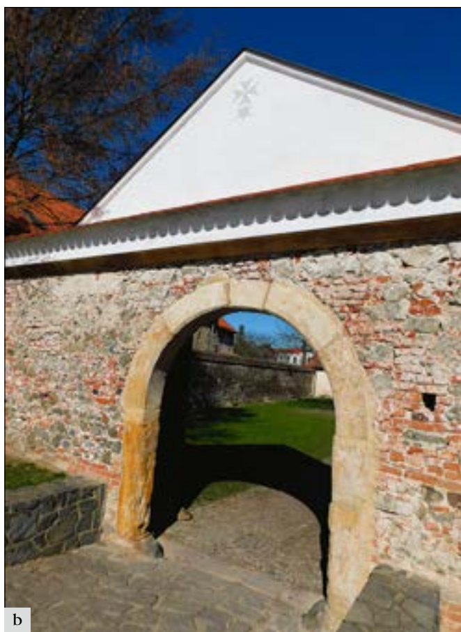
Dobřichovice (okres Praha-západ): a – pohled na renesanční kamenný portál západního vjezdu do dvora zámku před zásahem; b – kamenný portál po odborné kamenické opravě, po sejmutí druhotných nehodnotných omítkových vrstev byly na jižní stojce odhaleny hodnotné historické stopy po broušení šavlí a nožů (foto E. Zápalková).
