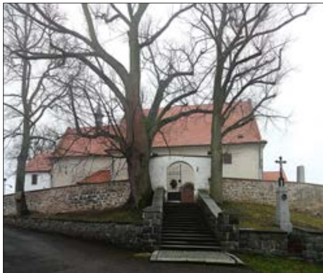
Hvoždany (okres Příbram), kostel sv. Prokopa a Navštívení Panny Marie s opravenou ohradní zdí (foto E. Kosová).
