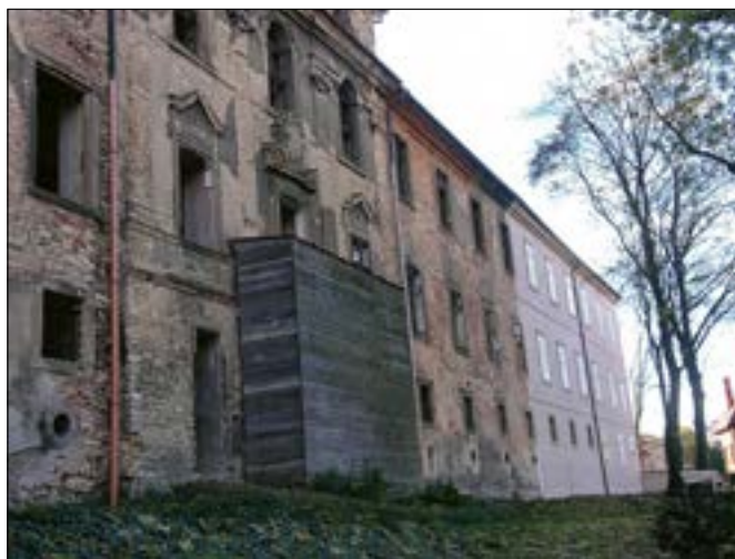
Buštěhrad (okres Kladno), severní zámecké průčelí obrácené do parku, z něhož se obnovovala pouze nejvzdálenější, západní část na délku 6 okenních os. Obnovovaly se zde fasádní vápenné omítky spolu s jednobarevným okrovým vápenným nátěrem. Zbývající část se zabedněným místem po kamenném portálu s balkonem vynášeným atlanty je v majetku kraje (foto E. Volfová).
