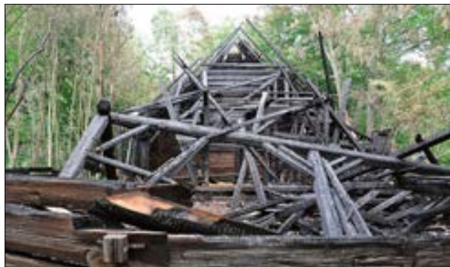
Ohrobec (okres Praha-západ), usedlost čp. 12. Požárem těžce poškozená unikátní polygonální roubená stodola. Dokumentace byla prováděna těsně po požáru, ještě s nadějí na záchranu stavby. Dendrochronologická analýza určila datum smýcení kmenů na trámy hlavní stolice do let 1756/57 a na trámy roubení stěn do let 1832–1835. O půl roku později již díky „nezájmu“ a obstrukcím ze strany majitele žádná naděje na záchranu výjimečné stavby nezbyvá (foto J. Veselý, červen 2016, srov. s. 87).
