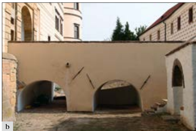
Kostelec nad Černými lesy (okres Praha-východ), areál zámku čp. 1, most přes suchý zámecký příkop mezi hlavní budovou zámku a objektem předzámčí. Jde o tříobloukový most postavený v období vrcholného baroka s relikty starších stavebních konstrukcí: a – původní stav mostu před opravou pocházející z 90. let 20. století; b – most po opravě s přiznanými oblouky konstrukce a obnovenou omítkou (foto M. Gottwaldová).
