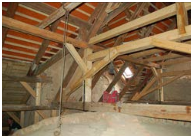
Neveklův (okres Benešov), kostel sv. Havla, oprava střechy. V roce 2016 pokračovala tato akce obnovou sedlové střechy nad presbytářem, jejíž krov byl posílen věšadlem, protože byl přetížený a vazným trámem náléhal na klenbu. V příštím roce by měla být provedena oprava stropu nad lodí, který má napadená zhlaví trámů (foto D. Primusová).
