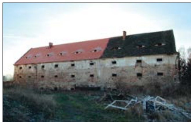
Drachkov (okres Benešov), sýpka, oprava střechy. Přestože není tento objekt kulturní památkou, obnova jeho střechy probíhala příkladně. Byl zde tesařsky opraven lokálně poškozený krov a položena nová krytina z pálených bobrovek. Na střeše je velké množství vikýřů – volských ok se zděným čelem, které byly obnoveny. Oprava by měla být dokončena v příštím roce (foto D. Primusová).
