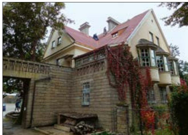
Dub (okres Benešov), vila Vítova mlýna, oprava střechy. Na členité střeše obytné budovy mlýna, která byla postavena ve stylu klasicizující moderny, byla obnovena krytina z pálených bobrovek, přičemž se podařilo zachovat všechny detaily včetně zdobných komínů z rezných cihel (foto D. Primusová).
