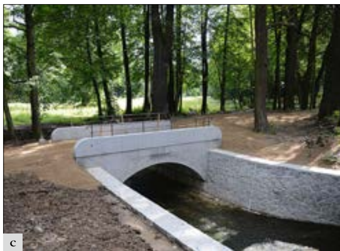
Dobříš (okres Příbram), areál zámku, mostek v anglickém parku: a – původní mostek z 1. poloviny 20. století poškozený povodní; b – průběh stavby nového mostku z železobetonu, čela vyzděna klasicky; c – po dokončení, vyzděná parapetní zídka s jednoduchým kovaným zábradlím (foto H. Řepková).
