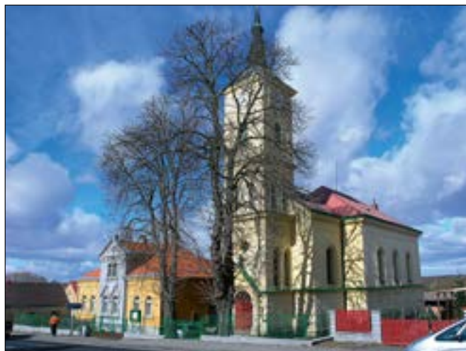
Hořovičky (okres Rakovník), kostel sv. Cyrila a Metoděje s farou. Proběhla výměna střešní krytiny na farní budově s odvodněním obvodového zdiva a oprava krovu nad kostelní lodí s výměnou poškozených střešních šablon. Chvályhodné zejména je, že pravoslavná církev projevila o své objekty opět po čase zájem, což potvrdila uskutečněnými opravami (foto E. Volfová).
