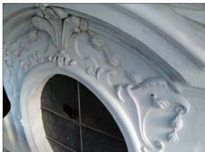
Liběchov (okres Mělník), kostel sv. Havla, detail opravené štukové výzdoby před finálním nátěrem. Fasáda kostela dostala při předcházející opravě červenobílou barevnost, provedenou v akrylátové technologii. Průzkum ukázal, že vrcholně barokní štuková výzdoba byla provedena z kvalitní malty s plnivem z místních čistých křemičitých písků. Výzdoba je tedy stále pevná a soudržná, povětrnost jen do určité míry místy narušila tvarovou preciznost původního provedení. Zásahy tedy neměly velký rozsah, bylo nutné zejména opravit a doplnit místa, kde byla při předchozí opravě použita nastavená malta. Díky charakteru materiálu bylo relativně snadné i očištění od akrylátového nátěru (foto J. Žižka).
