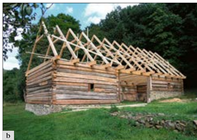
Bratřejov (okres Příbram), usedlost čp. 8: a – krov objektu s chlévy a stájemi byl v havarijním stavu, který vyžadoval citlivé rozebrání krovu a opravu koruny zdí; b – následně byla část původní krovové konstrukce opětovně sestavena, tesařsky opravena a doplněna. Střešní plášť byl opět proveden z pálených bobrovek (foto J. Berková).
