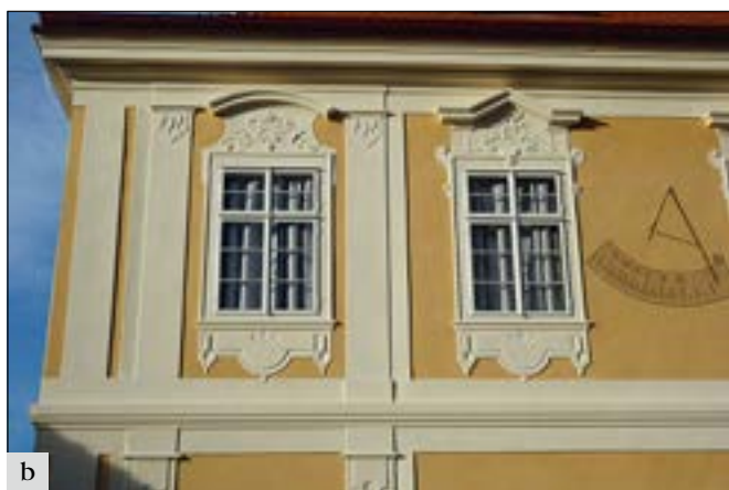
Panenské Břežany (okres Praha-východ), zámek: a – průčelí zámecké budovy s novobaročně upraveným architektonickým členěním tvarově precizně obnovené zkušeným štukatéry, b – detail obnoveného průčelí s novobaročně upraveným architektonickým členěním, tvarově precizně obnoveným zkušeným štukatéry (foto J. Žižka).
