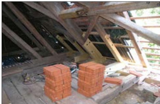
Čistá (okres Rakovník), kaple sv. Anny, kde se prováděla oprava tesařské vazby krovu na severní straně, nad lodí. Protězovat bylo nutné všechny stropní trámy, včetně napojení krokví a sloupků ležaté vazby (foto E. Volfová).
