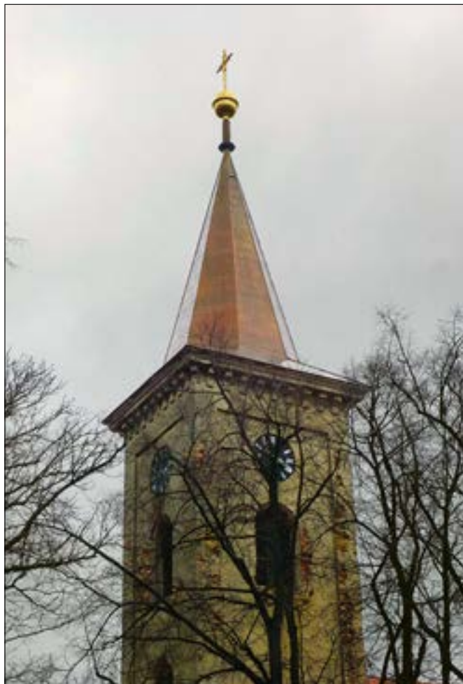
Hostomice (okres Beroun), kostel Nastolení sv. Petra v Antiochii. Věž po kompletní náhradě krovu a krytiny, zbývají ještě fasády (foto H. Řepková).
