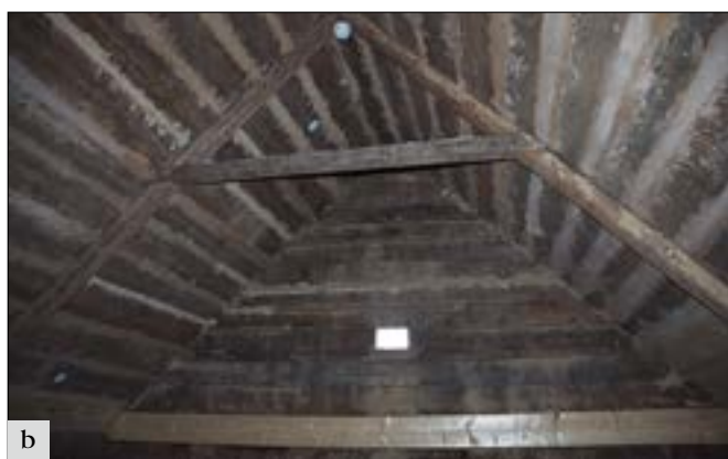
Kouřim (okres Kolín), Muzeum lidových staveb – roubený špýchar s roubenou klenbou z Kornatic u Rokycan byl na původním místě chráněnou památkou. V roce 1979 byl rozebrán a převezen do depozitáře Muzea lidových staveb. V roce 2016 byl znovu sestaven při zachování maxima původních prvků a opatřen vnějším hliněným omazem, tzv. kožichem (foto J. Berková).
