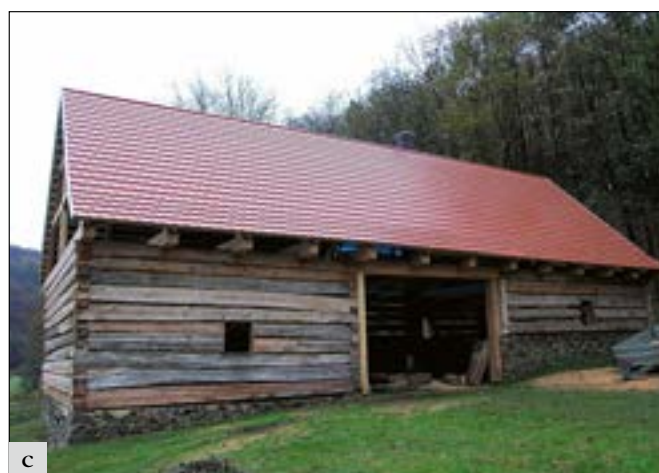
Branov (okres Rakovník), areál Kouřimecké rybárny čp. 55. Celková obnova stodoly: a – stav torza stodoly v lednu 2012 před zahájením prací; b – roubená stodola po obnově obou peren a provedení kopie krovu; c – stav po položení střešního pláště z pálených drážkových bobrovek. (foto M. Hanzlíková).
