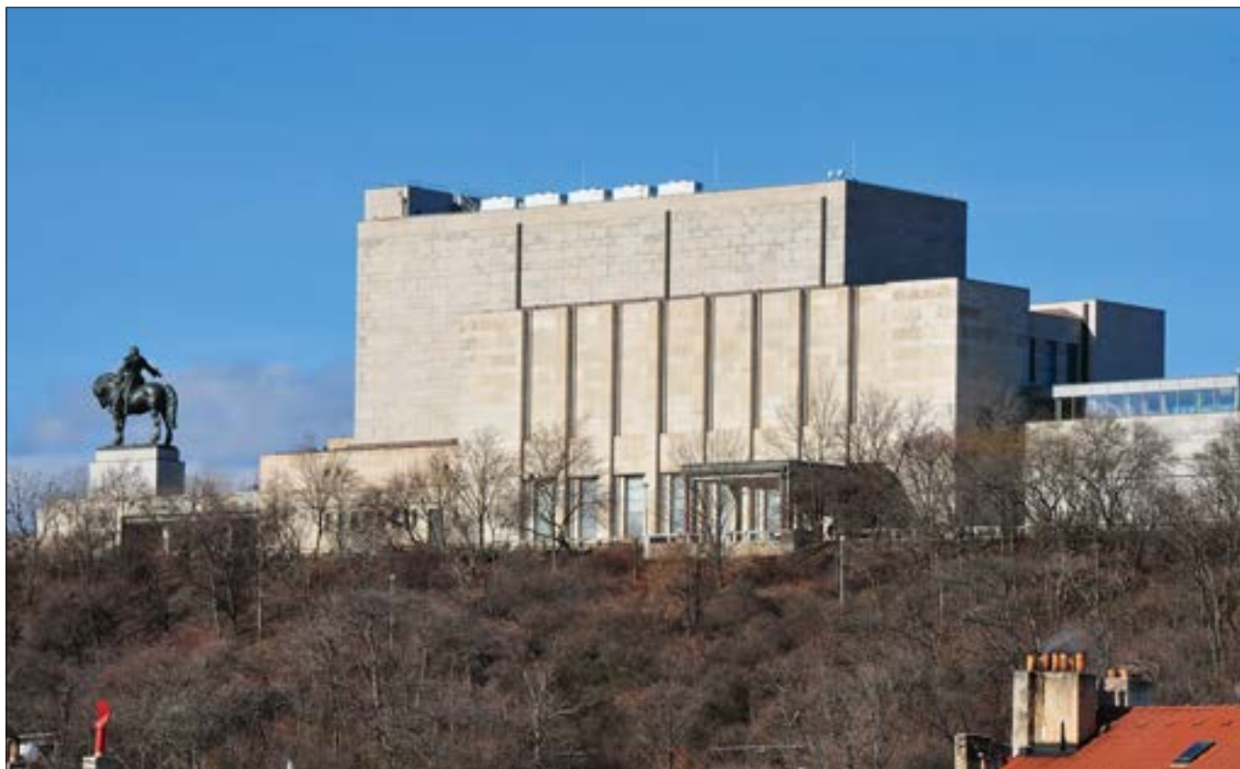
Pohled ze zadní budovy sídla NPÚ ÚOP SČ v Sabinově ulici čp. 5 na Národní památník na Vítkově (foto V. Razím).
