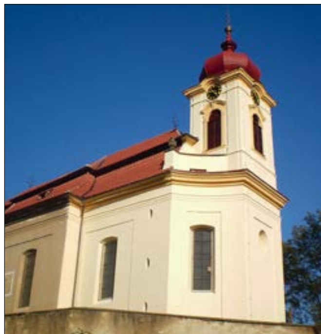
Jinče (okres Příbram), kostel sv. Michala, oprava fasády (foto E. Kosová).
