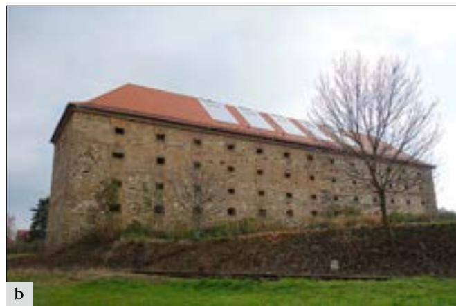
Břeštiny (okres Kladno), barokní sýpka: a – stav v roce 2012; b – nová střecha sýpky s prosvětlením střední části. Z hlediska památkové péče bylo toto řešení ústupkem, střecha se výrazně pohledově uplatňuje v blízkém prostoru; bylo zde však přihlédnuto k rozsahu prací a k celkové opravě objektu, který byl natolik poškozen, že mu postupující destrukcí hrozil zánik. Hlavním cílem zde byla jeho záchrana, oživení a využití; navíc prosvětlená partie je upravitelná, lze zde doplnit celkové zakrytí (foto E. Mikešová).
