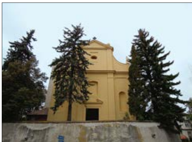
Čečelice (okres Mělník), kostel sv. Havla. V roce 2015 byla obnovena fasáda průčelí kostela. V roce 2016 byla provedena re-vize fasády a nátěr. Barevnost byla zvolena na základě dochovaných historických fotografií, které dokládají monochromní barevnost (foto V. Bártová).
