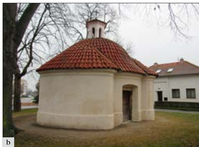
Lužec nad Vltavou (okres Mělník), márnice u kostela sv. Jiljí: a – pohled na márnici před obnovou fasády. Z původních omítek a architektonického členění zůstaly pouhé fragmenty; b – fasáda márnice po provedení nových omítek (foto V. Bártová).
