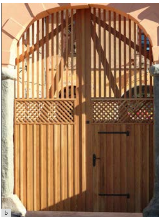
Králův Dvůr (okres Beroun), zámek: a – jižní brána v pohledu z nádvoří, zjednodušená profilace z vnitřní strany, b – dřevěná vrata brány jsou replikou dle archivní fotografie (foto E. Kosová).
