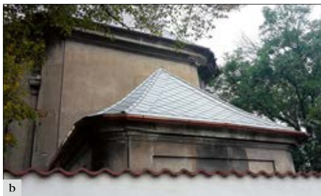
Kostomlaty nad Labem (okres Nymburk), barokní kostel sv. Bartoloměje: a – původní stav střešního pláště sakristie kostela; b – střecha sakristie po provedení obnovy (foto M. Gottwaldová).
