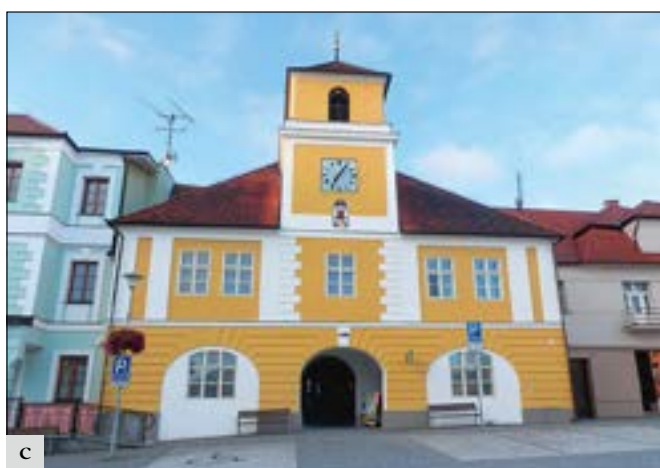
Votice (okres Benešov), stará radnice: a – historická fotografie z roku 1887, boční okno v patře bylo znovu otevřeno; b – radnice před plánovanou výměnou oken s netektonickým řešením otvorů v přízemí a zkomoleným členěním patra; c – radnice po obnově průčelí, zazděné podloubí bylo upraveno do podoby z konce 19. století (foto H. Řepková).
