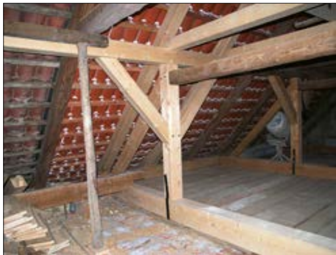
Slatina (okres Kladno). V kostele sv. Vojtěcha pokračovala 2. etapou oprava tesařské vazby krovu na části uprostřed, blíže štítu. Krov byl zejména v této partii ve špatném stavebně technickém stavu a bylo nutné celou řadu prvků protézovat nebo i vyměnit. Oprava byla provedena perfektním způsobem (foto E. Volfová).
