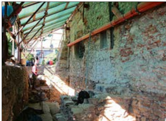
Kutná Hora – Sedlec (Kutná Hora), kaple Věch Svatých s kostnicí. Náročná akce generální obnovy sedleckého karneru pokračovala další etapou, a to rekonstrukcí terasy po severní straně horní kaple. Po obvodu jižní a západní strany spodního podlaží – ossaria – byl proveden plošný archeologický výzkum, který pronikl skrze několikapatrové etážové pohřebiště až k základové spáře kaple. Podobně jako v předchozích etapách přinesl zásadní poznatky ke středověkým dějinám této mimořádné památky (foto A. Pospíšil).
