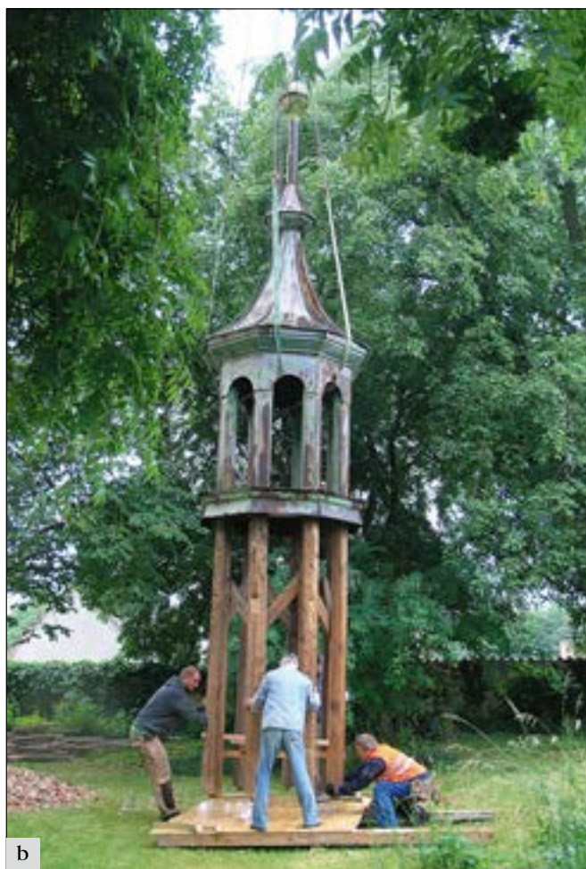
Svárov (okres Kladno): a – při podrobném průzkumu střechy věže kostela sv. Lukáše byla zjištěna rozsáhlá poškození, zde souběh podkladových vazných trámů napadený v plném rozsahu hnilobou. Nebyla dohledána část, kterou by bylo možné zachovat a opětovně použít do nové vazby; b – kvůli rozsáhlému poškození řezané vazby krovu věže kostela sv. Lukáše ji bylo nutné na místě odstrojít a snést jeřábem, aby mohla být dílensky vyrobena její kopie (foto E. Volfová).
