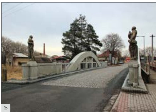
Křinec (okres Nymburk), silniční most přes Mrlinu: a – most s pozoruhodnou konstrukcí a druhotně osazenými sochami představuje ojedinělou technickou památku na území středních Čech, stav v červnu 2014; b – oprava betonových povrchů se dotkla celého mostu, železobetonové rámy zábradlí bylo nutné vyměnit. Úpravou plošného uspořádání prošla i dlážděná vozovka, stav v únoru 2017 (foto A. Rákosníková).
