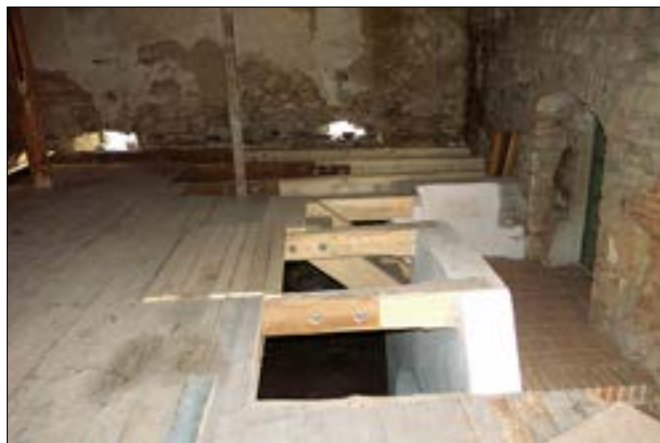
Vepřek (okres Mělník), areál vodního mlýna čp. 19, protézování stropních trámů mlýnice (foto M. Hanzlíková).
