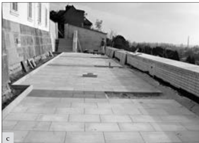
Lysá nad Labem (okres Nymburk), bývalý klášter bosých augustiniánů: a – pohled na jižní klášterní terasy z Žižkovy ulice, stav po obnově pěti úseků tarasních zdí, vyjma západního úseku střední terasy. Podle objemu dochovaných konstrukcí byla spodní terasa opravena z původního, drubotně použitého materiálu, opěrné zdi střední a horní terasy včetně všech nových obradních zdí nad terémem jsou z materiálu nového, nicméně opět z vápenopískových cihel; b – pohled na způsob sanace úseku opěrné zdi. Degradovaný původní líc byl odstraněn a před něj založen líc nový, přičemž mezera byla vyplněna litým betonem s armaturou; c – východní část horní terasy ve fázi nově vyzděného schodiště východní branky a položení nové pískovcové dlažby. Plocha bude v budoucnu sloužit jako otevřená kavárna, a bude proto členěna na jednotlivé kóje s úseky květinových záhonů (foto E. Zápalková).
