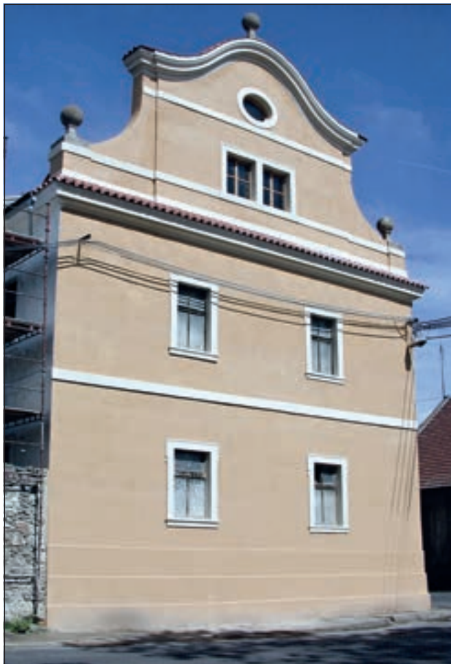
Tursko (okres Praha-západ), Nová hospoda čp. 9, pohled na jihovýchodní průčelí těsně po dokončení prací na celkové obnově. Po tvarové korekci byly všechny architektonické články fasády, včetně modelace kamenných okenních ostění s uchy a kapkami, kvalitně štukátérsky opraveny a dle protilehlého průčelí opatřeny vápenným nátěrem ve dvojí barevnosti, jež vzešla z průzkumu (foto E. Zápalková).
