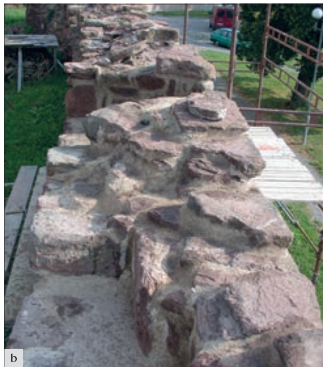
Český Brod (okres Kolín), jihovýchodní úsek pobusitského městského opevnění: a – pohled na korunu zdiva po odstranění náletové vegetace a degradovaného maltového potěru s fragmenty dvou typů střelen, jejichž otvory nejsou v jedné výškové úrovni; b – stav koruny po restaurátorském přezdění a doplnění novými kameny z červeného pískovce tak, aby byla dodržena formální logika obranného systému i charakter koruny zdiva (foto E. Zápalková).
