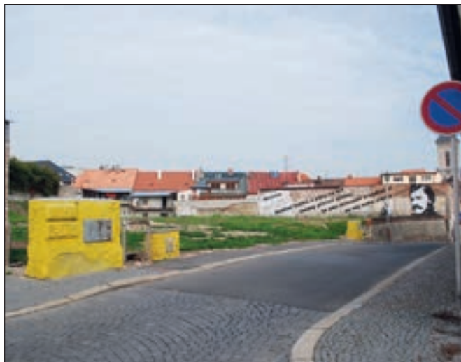
Kutná Hora, volný prostor parcely, na které stál již demolovaný dům čp. 566 s velkou zabradou v Robáčově ulici je připravován svým vlastníkem pro nový investorský záměr; zatím byla plocha pobledově odhalené stěny směrem k nedalekému kostelu Panny Marie na Náměstí využita pro připomenutí osoby a myšlenky jednoho z našich významných historických velikanů, osudem spjatého s Kutnou Horou (foto J. Mrázek).
