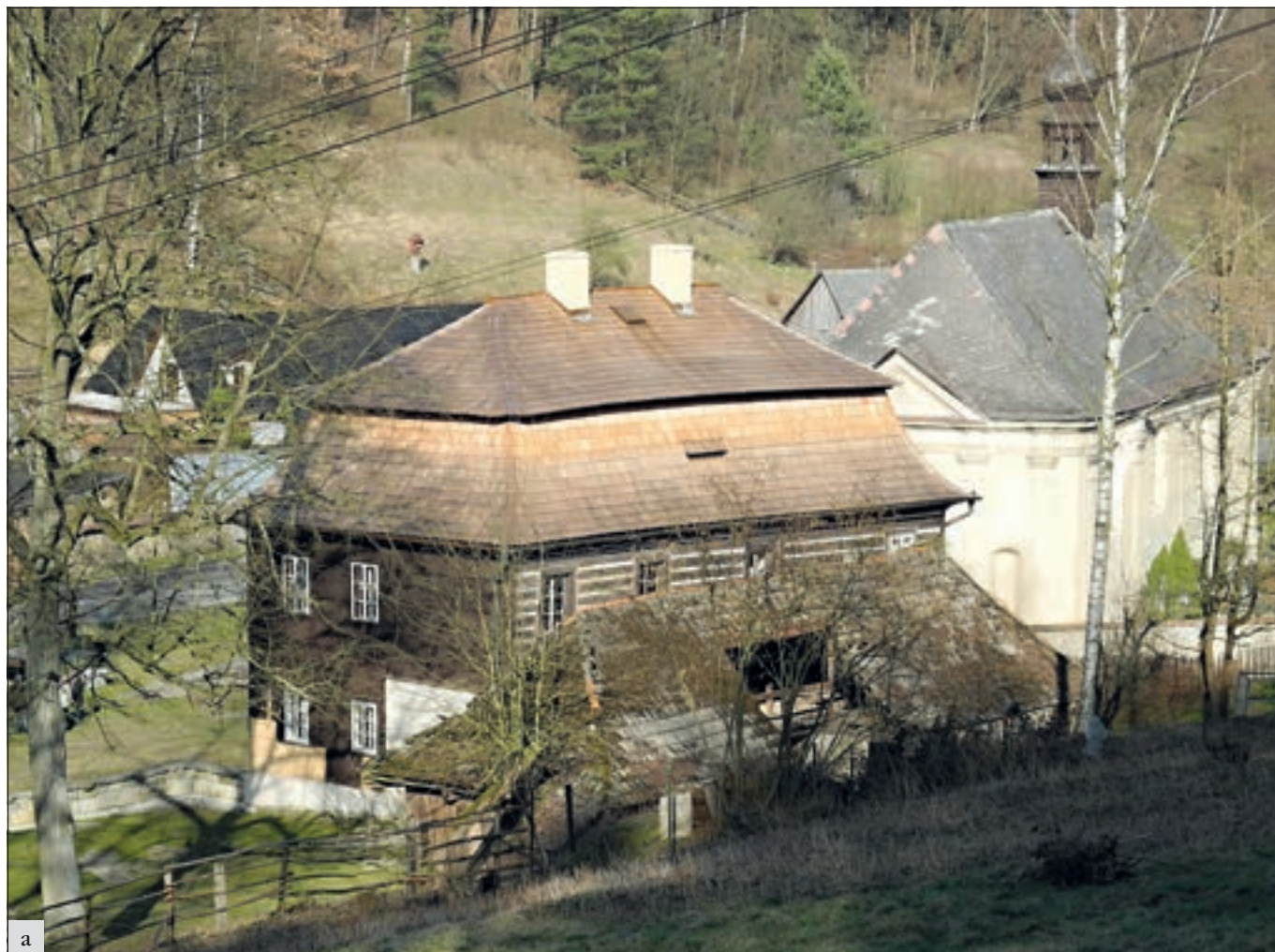
Dolní Krupá fara (okres Mladá Boleslav), a – celkový pohled na faru po obnově krytiny z dřevěného šindele; b – pohled do krovu po opravě. Prvky krovu byly opraveny tradičním způsobem s vysazením poškozených částí s plátovanými kolíkovými spoji. Zachována zůstala i blíněná mazanina podlahy (foto E. Vyletová).
