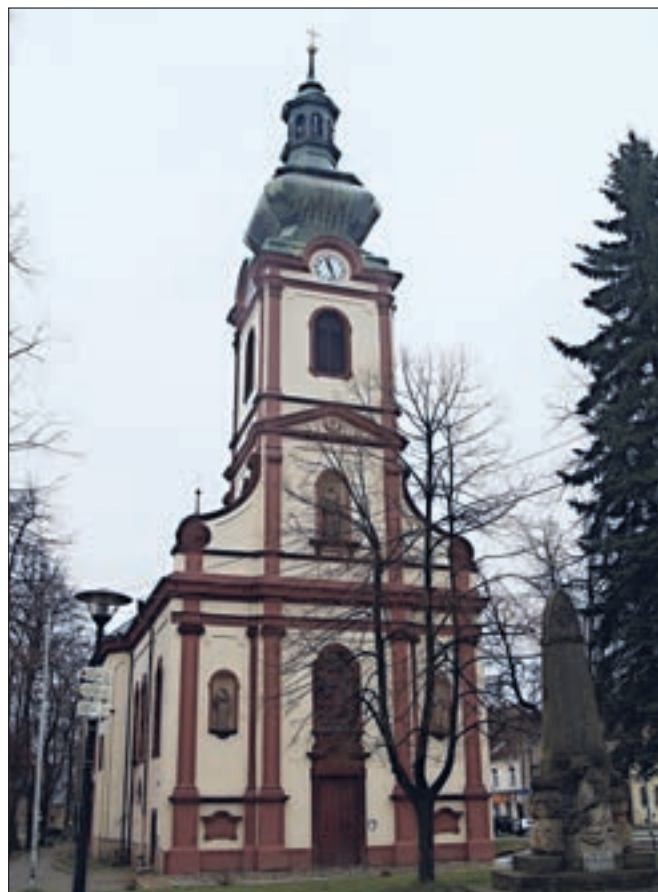
Kostelec nad Černými lesy (okres Praha-východ), kostel sv. Andělů Strážných. V roce 2014 bylo započato s celkovou obnovou v jádře barokního kostela. Byla provedena úspěšná celková obnova vnějšího pláště západního průčelí včetně hranolové věže. Součástí obnovy bylo restaurování kamenných článků, oprava klempířských prvků, omítek apod. Konečná barevnost vnějšího pláště kostela respektovala stávající barevné řešení, vycházející z novobaročnických úprav s tím, že byla korigována sytost červeného odstínu (foto P. Kroupa).
