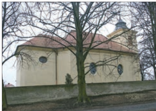
Břežany (okres Rakovník), kostel sv. Markéty, dokončením fasád kostela skončil téměř 10 let trvající proces oprav obvodové pláště stavby. Omítky jsou provedeny pečlivě, došlo i na zachování skromných vzorků původních omítkových vrstev (foto E. Volfová).
