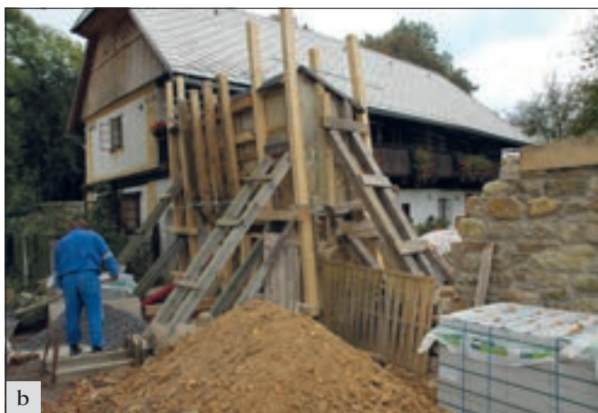
Skalsko (okres Mladá Boleslav), brána usedlosti čp. 6. Tradiční vjezdová brána z roku 1833 se na jaře roku 2013 výrazně vychýlila od svislé osy a brozila zřícením – a. Provizorně zajištěná stavba – b, byla v roce 2014 náročným způsobem staticky zajištěna. Její zdivo bylo postupně podezděno novými základy – c, a následně byla brána vyrovnána do svislé polohy – d. Obnova fasády, kterou se přes nemalou náročnost prací podařilo z velké části zachovat, bude obnovena v příštím roce (foto J. Berková).
