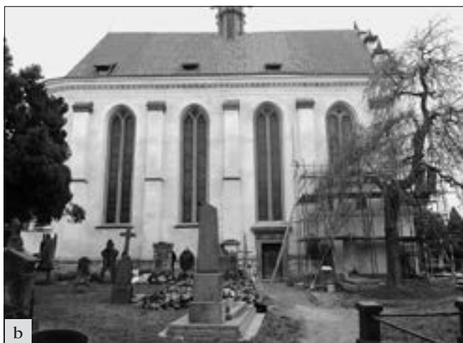
Velvary (okres Kladno), hřbitovní kostel sv. Jiří, obnova severní fasády. V roce 2014 byla zahájena postupná obnova fasád renesančního kostela sv. Jiří. Bylo třeba obnovit nejen omítky na plochách, ale provést téměř restaurování a doplnění zřejmě vytlačovaného štukového rostlinného ornamentu vlysového pásu v různém stupni narušení – a; náročná byla i oprava kamenných kružeb nebo oprava pozoruhodných kamenných stříšek opěrných pilířů. Záměrem stavební sezóny byla fasáda připravena pro finální nátěr – b (foto J. Žížka a M. Jedlička).
