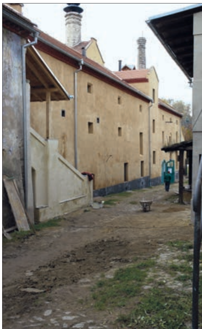
Lobeč (okres Mělník), areál pivovaru čp. 34. Dvorní průčelí hlavní budovy pivovaru, která obsahuje sladovnu se sýpkami v patře, bvozd a varnu oddělenou průjezdem, bylo obnoveno podle posledního dochovaného stavu, tedy do podoby, kterou získalo po velké přestavbě pivovaru v závěru 19. století. Hladkou okrovou fasádu s šedým hladkým soklem zdobí pouze režná ciblově červená hlavní římsa, skládaná z cibí kladených nakoso (foto. J. Berková).
