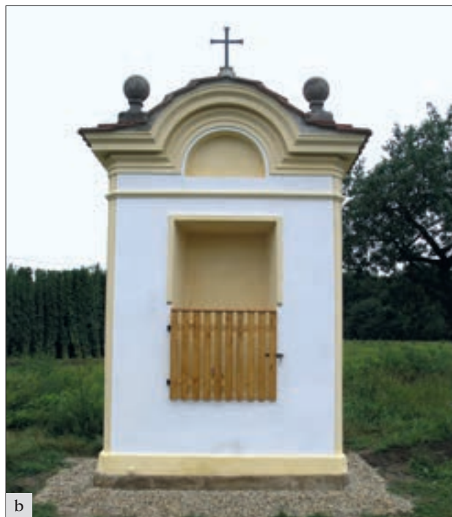
Mšec (okres Rakovník), kaple v polích k Srbči: a – stav před opravou. Počátkem 90. let došlo k otlučení zbytků opadaných štukových říms a článků a následné neodborné zjednodušující opravě; b – rekonstruovat původní vzhled kaple se podařilo zejména díky tomu, že se našla, byť špatně čitelná, malá fotografie. Bylo radostí a zadostiučiněním nakreslit návrh nových profilů, odpovídajících proporcím drobné stavby, a sledovat proměnu kaple při opravě v rukou zkušeného štukatéra (foto E. Volfová).
