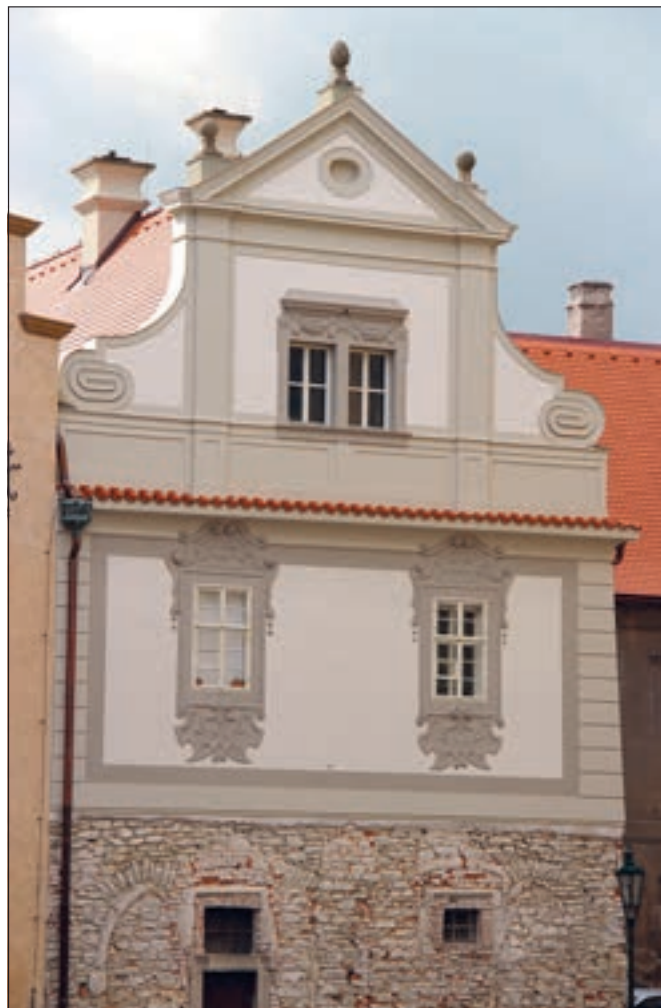
Kutná Hora, dům čp. 1. V oblasti fasád stojí na prvním místě arciděkanství, kde kromě kvalitní obnovy štukové výzdoby oken severního křídla došlo ke stanovení finální barevnosti objektu. Na základě restaurátorského průzkumu i provedených čtených vzorků a po zvažování pohledových souvislostí objektu v celkovém městském panoramatu byla zvolena tlumeně teple šedá barevnost ve třech stupních intenzity a rozložení barevnosti, vycházející z historické fotografie z osmdesátých let 19. století (foto A. Pospíšil).
