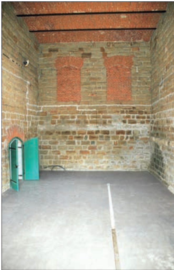
Lobeč (okres Mělník), areál pivovaru čp. 34. Interiér jedné z prostor tzv. malých sklepů, navazujících na objekt stáčírny, byl zednický opraven při zachování jeho celkového charakteru s neomítaným pískovcovým zdivem, režnými klenbami a zazdívkami obslužných otvorů. Byla provedena nová podlaha, nutná pro osazení současné technologické výbavy ležáckých sklepů (foto. J. Berková).
