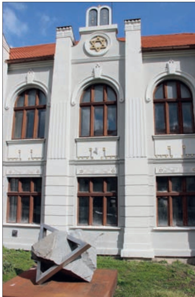
Kutná Hora, dům čp. 619. Dokončení rehabilitace vnějšího pláště se dočkal objekt bývalé synagogy, situované naproti severnímu křídlu jezuitské koleje. Původní architektonické členění ve stylu moderny bylo v roce 1951 téměř kompletně odstraněno a od roku 2013 postupně došlo k jeho návratu s přihlédnutím k původním plánům stavitele B. Moravce. Synagoga tím bezesporu získala na atraktivitě, a ačkoliv nejde o kulturní památku, doplnila pestrou mozaiku kutnoborské architektury (foto A. Pospíšil).
