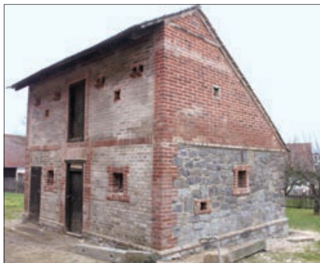
Drabenice-Račany (okres Příbram), čp. 31. Drobný objekt chlévků s charakteristickou asymetrickou střechou po provedeném statickém zajištění. Stažení systémem Helifix je zcela skryté ve spárách. Praskliny zdíva ze struskových cihel byly opraveny pomocí vysazení jednotlivých cihel (foto M. Hanzlíková).
