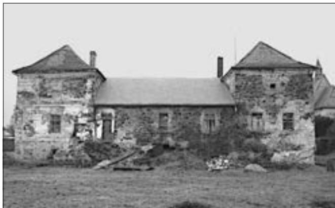
Pakoměřice (okres Praha-východ), zámek. Dlouho utilitárně využívané a obrožené drobné zámecké stavby se ujal nový zodpovědný vlastník se zkušenostmi s obnovou památek. Hned v roce 2014 byla zahájena postupná oprava krovů a obnova pálené krytiny (foto P. Kroupa).
