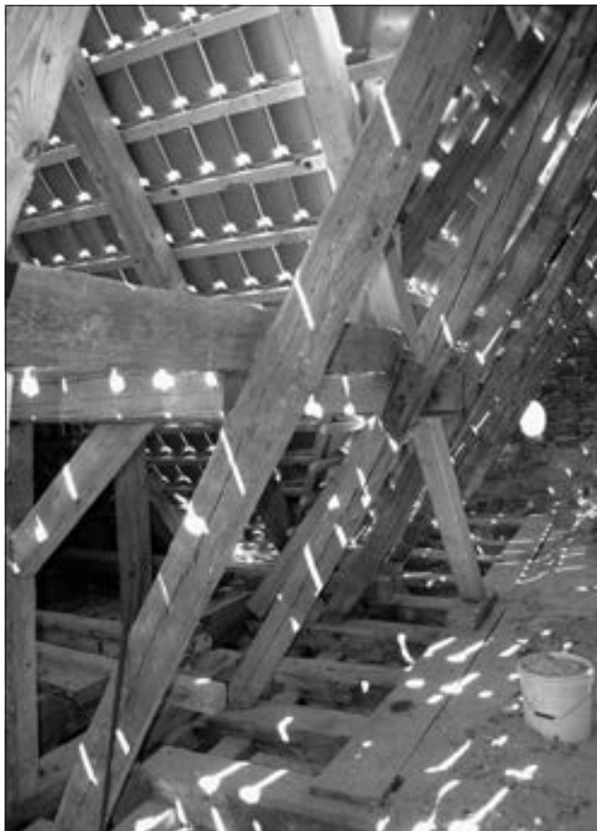
Svárov (okres Kladno), kostel sv. Lukáše. Na kostele úspěšně pokračovala oprava tesařské vazby cenného, raně barokního krovu nad jižní částí lodi, s položením nové prejzové krytiny až po těleso západní věže (foto E. Volfová).
