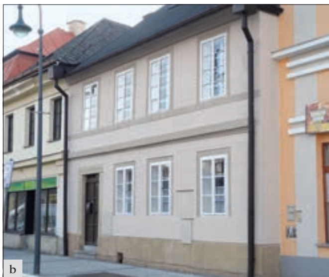
Bělá pod Bezdězem (okres Mladá Boleslav), průčelí domu čp. 83 si kromě architektonického členění zachovalo i charakteristická okna v líci fasády: a – stav před opravou, kdy je viditelné značné narušení omítek a zdíva i poškození estetické hodnoty fasády nevhodným hrubým nástříkem; b – fasáda po obnově (foto E. Vyletová).
