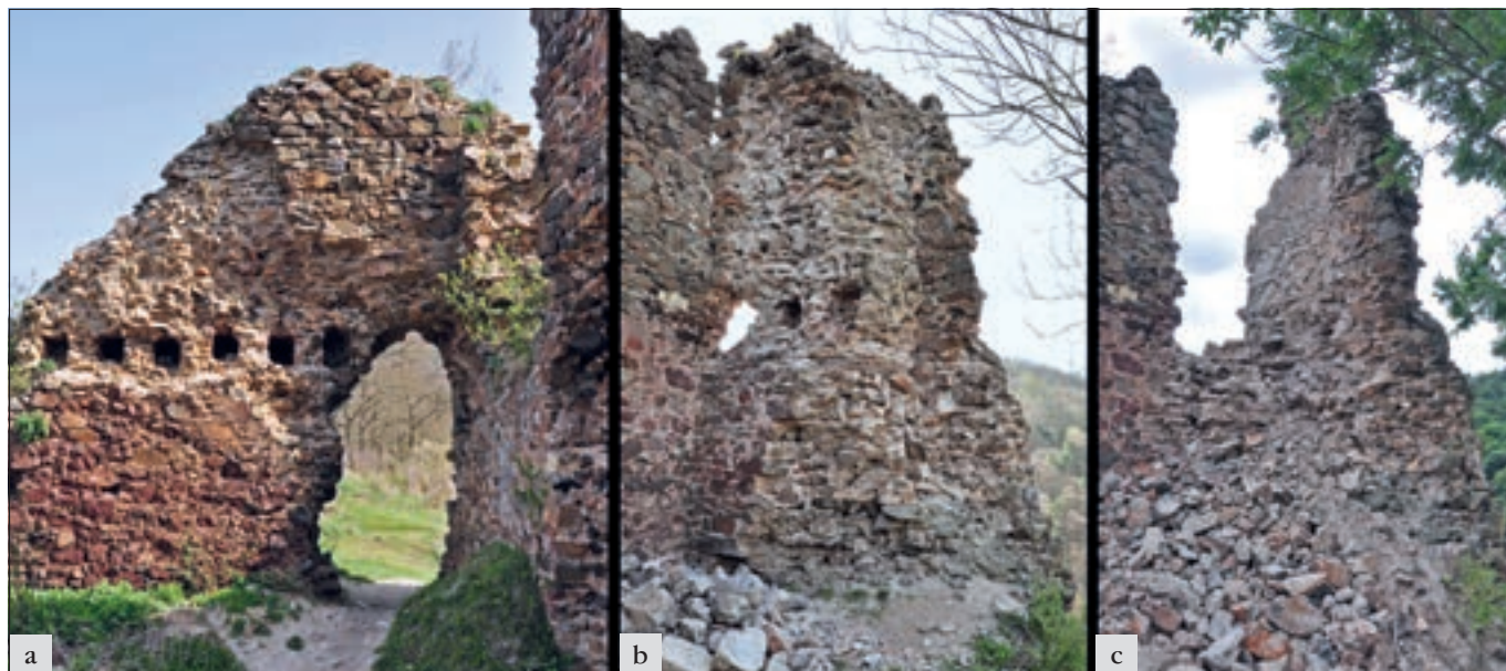
Týřov, k.ú. Karlova Ves (okres Rakovník), brad. Zřícenina bradu Týřova patří mezi torzálně dochované stavby, které už léta volají po konzervaci svého silně obroženého zdiva. Do konce roku 2014 snahy vyznívaly naprázdno nejen kvůli velmi obtížné dostupnosti a dalším technickým problémům. Jen v interiéru věžového paláce ze 13. století došlo v posledních letech ke dvěma výrazným destrukcím líců nad stropními trámy, a tím k dalšímu zboršení statiky celé stavby (a, b). Průzkum a dokumentace těchto situací je zásadním úkolem, samotnou záchranu stavby však neřeší (foto V. Razím, 2014). Poslední, tentokrát již fatální destrukce nastala v červenci 2015 (c, srov. s b; foto V. Razím, 2015).
