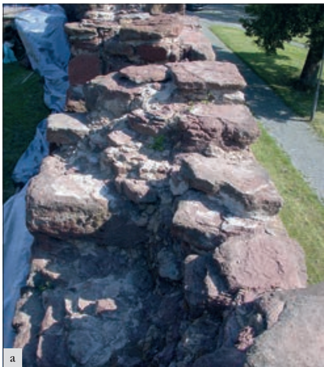
Český Brod (okres Kolín), jihovýchodní úsek pobusitského městského opevnění: a – pohled na korunu zdiva po odstranění náletové vegetace a degradovaného maltového potěru s fragmenty dvou typů střelen, jejichž otvory nejsou v jedné výškové úrovni; b – stav koruny po restaurátorském přezdění a doplnění novými kameny z červeného pískovce tak, aby byla dodržena formální logika obranného systému i charakter koruny zdiva (foto E. Zápalková).
