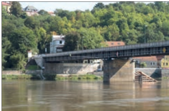
Mělník (okres Mělník), ocelový silniční most Josefa Straky přes Labe, oprava spodní stavby, stav v březnu 2014. Příprava obnovy spodní stavby byla započata v červenci 2013, vlastní realizace probíhala od května do září 2014. Stav po dokončení prací (foto A. Rákosníková).
