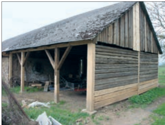
Olešná (okres Beroun), stodola s navazující kolnou v areálu usedlosti čp. 12. Jižní a východní průčelí rámové konstrukce kolny po obnově tradičními tesařskými postupy (foto M. Hanzlíková).
