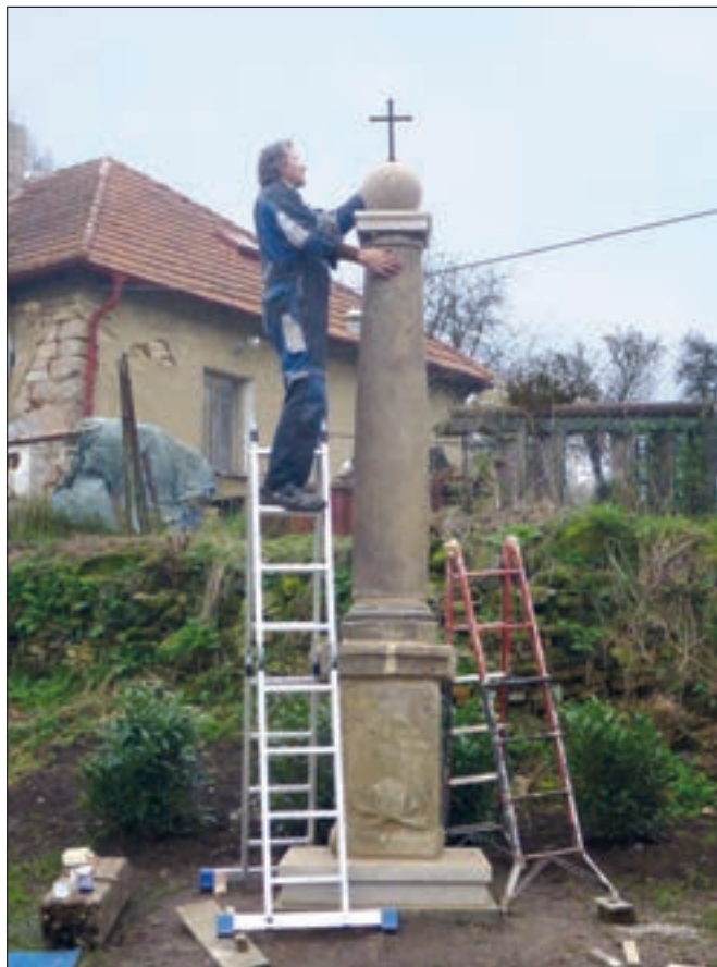
Saky (správní obvod Kladno), boží muka, stav v průběhu prací. Sloupová boží muka byla od roku 1999 uložena v rozebraném stavu. Uložení předcházely vandalské zásahy, který způsobil značné ztráty originálu. Navrácení na původní místo za Třebčovicemi, poblíž staré usedlosti v lokalitě Paninský Mlýn, nemohlo být realizováno kvůli riziku dalšího poškození. Součástí sestavení na návsi v Sakách bylo restaurování kamene a došlo také k rekonstrukci některých chybějících prvků (foto Jan Turský).
