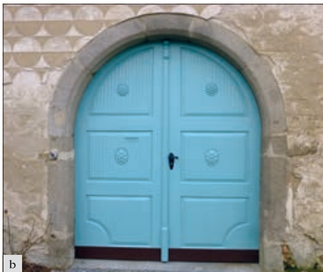
Kosova Hora (okres Příbram), zámek: a – vrata, stav před obnovou. Na zámku probíhají dílčí opravy a údržba výplní otvorů; b – zdařilým příkladem je repase klasicistních vrat brány s obnovou krycího nátěru v odstínu podle nálezu původní barevnosti (foto H. Řepková).
