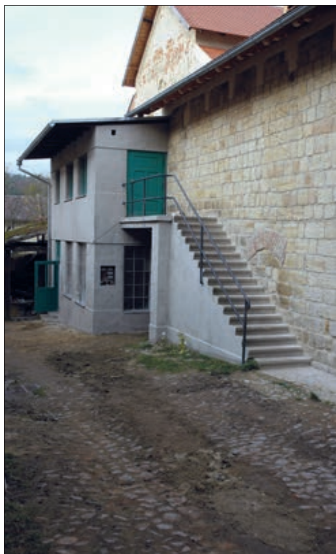
Lobeč (okres Mělník), areál pivovaru čp. 34. Budova stáčírny, představená před rozlehlý komplex sklepů, pochází z 30. let 20. století. Vnější plášť této menší stavby byl důsledně obnoven podle původní podoby. Původní hrubá omítka byla zachována a po opravě scelena jednotným nátěrem v šedé barvě – podle původního stavu (foto. J. Berková).
