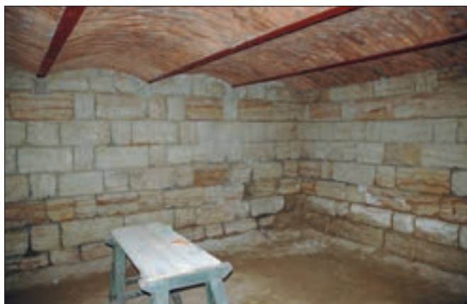
Ráj (okres Mělník), č. e. 10. Prostor chléva byl zaklenutý stájovými klenbami na drubotně použitých železných kolejnicích, které praskly. Jejich výměna si proto vyžádala odstranění všech klenb a jejich následnou rekonstrukci podle původní podoby. Stav po dokončení rekonstrukce (foto J. Berková).
