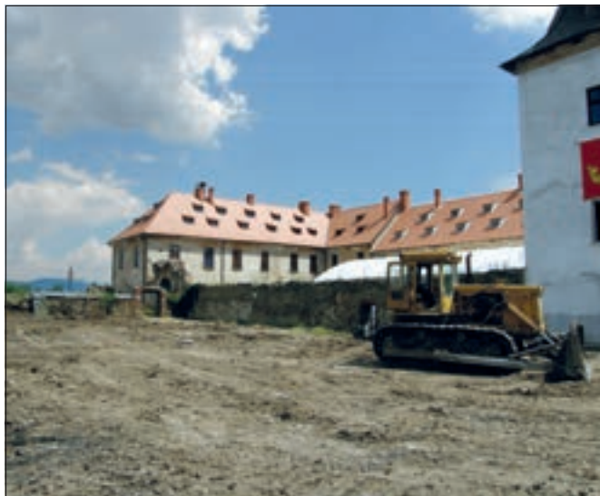
Králův Dvůr (okres Beroun), hrubé terénní úpravy po částečném snížení nepůvodního terénu – skládky (foto Z. Mladá).
