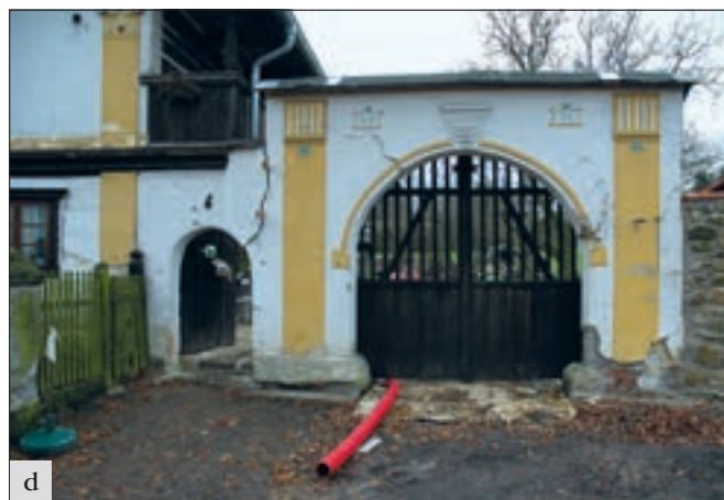
Skalsko (okres Mladá Boleslav), brána usedlosti čp. 6. Tradiční vjezdová brána z roku 1833 se na jaře roku 2013 výrazně vychýlila od svislé osy a brozila zřícením – a. Provizorně zajištěná stavba – b, byla v roce 2014 náročným způsobem staticky zajištěna. Její zdivo bylo postupně podezděno novými základy – c, a následně byla brána vyrovnána do svislé polohy – d. Obnova fasády, kterou se přes nemalou náročnost prací podařilo z velké části zachovat, bude obnovena v příštím roce (foto J. Berková).
