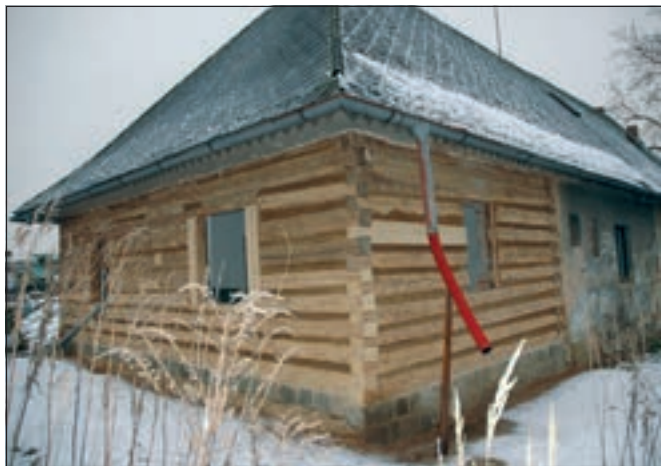
Bělá pod Bezdězem (okres Mladá Boleslav), Panin dvůr. Unikátně dochovaný roubený panský dvůr s domem a špýcharem ze závěru 17. století prochází postupnou obnovou. V roce 2014 byla provedena oprava roubených obvodových stěn obytného stavení – stav po dokončení této etapy (foto J. Berková).
