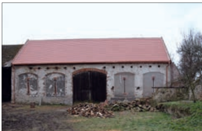
Bylany (okres Kutná Hora), čp. 25. Obnova krovu a výměna krytiny na stodole byla prvním krokem k postupné celkové obnově tohoto zanedbaného areálu. Stav po dokončení prací (foto J. Berková).
