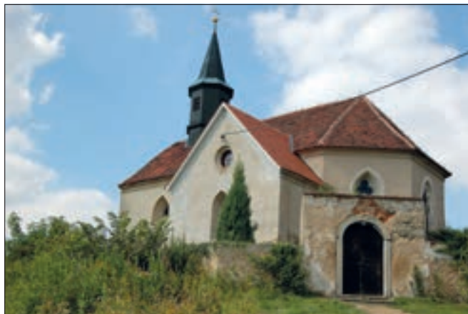
Chvojíně (okres Benešov), kostel sv. Václava, oprava střechy nad sakristií a vstupní předsíní. Kostel je významnou dominantou krajiny, výrazu prospěla výměna poškozené plechové krytiny za pálené bobrovky na vedlejších plochách střechy (foto D. Primusová).
