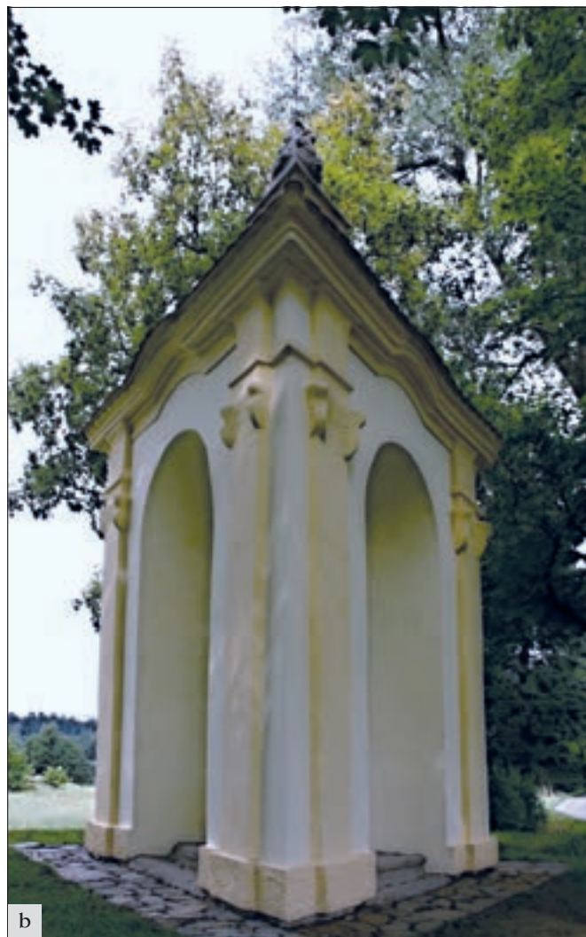
Zbenice (okres Příbram): a – pohled na trojbokou barokní kapličku před opravou v březnu 2014; b – při obnově omítek se podařilo obnovit alespoň částečně úpravu zjednodušených volut a hlavic pilastrů (foto. D. Havlíková).
