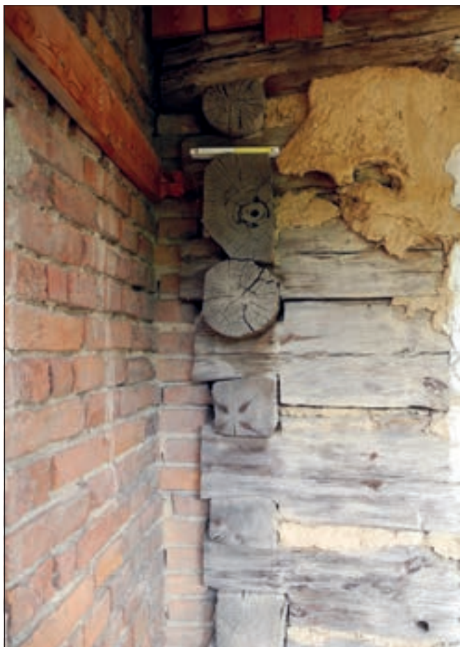
Bělá pod Bezdězem (okres Mladá Boleslav), detail nároží roubené stěny v patře domu čp. 83, drubotně sestavené z původních prvků konstrukce domu. Dendrochronologický průzkum určil shodnou dataci kácení těchto prvků i částí roubených stěn zachovaných in situ na přelom let 1656/57. Tento příklad současně ukazuje na potřebu dokumentace dochovaných roubených konstrukcí městských domů skrytých za omítanou nebo zděnou fasádou, která může přinést zajímavé poznatky k původu a vývoji zástavby (foto E. Vyletová, 2014).
