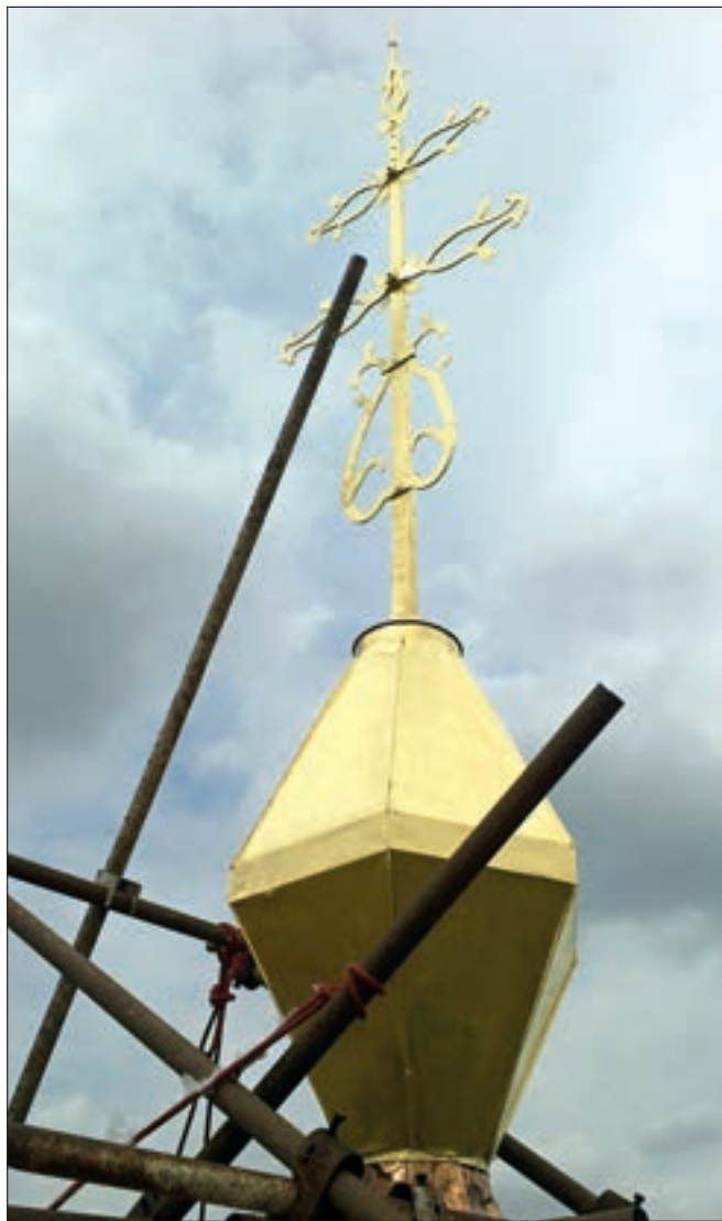
Počaply (okres Beroun), restaurovaná hrotnice střechy věže. Kostel Nanebevzetí Panny Marie je cennou barokní stavbou od významného architekta K. I. Dienzenhofera z 30. let 18. století. S restaurováním samotné hrotnice souvisela oprava borní části krovu věže a výměna nefunkční měděné krytiny (foto A. Musilová).
