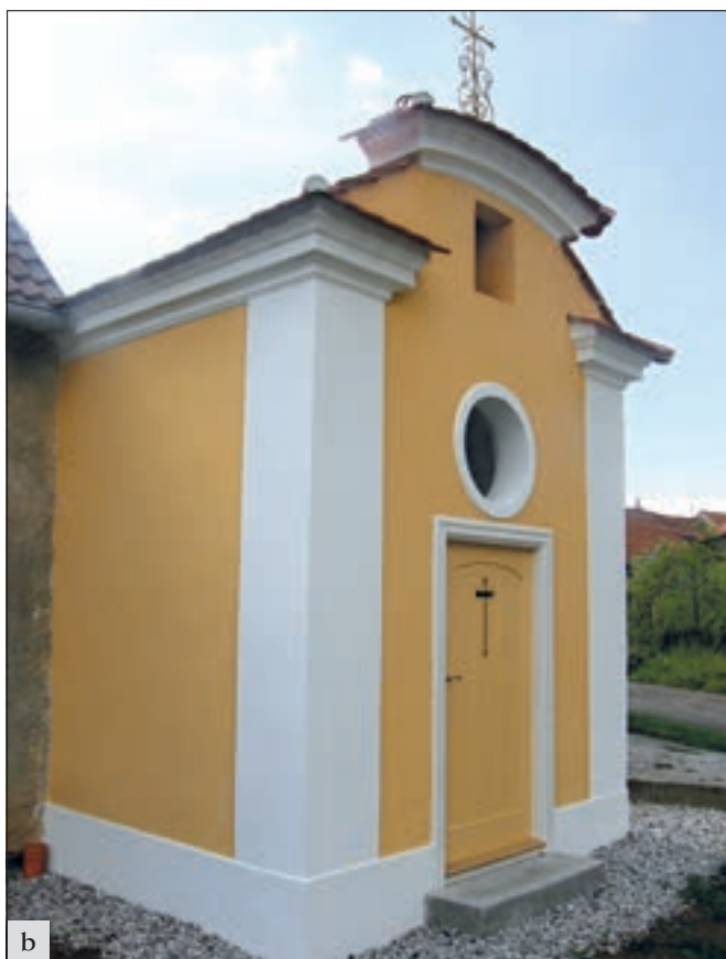
Měňany – a; Tobolka – b (okres Beroun), kapličky po celkové obnově. Při celkové rekonstrukci byly obnoveny štukové prvky (římsy, pilastry, šambrány), dle průzkumu barevnosti bylo navrženo dobové barevné řešení interiéru i exteriéru kapliček, kvalitně řemeslně byly vyspraveny krovy a střešní krytina. Snížení zemní vlhkosti přispělo zřízení vnějšího provětrávacího systému a obsypání základů kamenivem různé frakce (foto A. Musilová).
