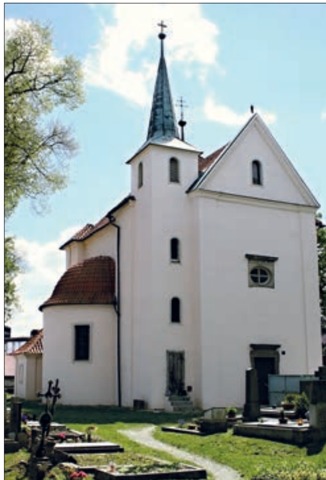
Březnice (okres Příbram), kostel sv. Rocha po opravě fasády. Oprava omítek, realizovaná poměrně po krátké době po předchozí opravě, nikterak nezměnila jednoduchost fasád kostela. Nicméně, relativně tmavší nátěr fasády příznivě ovlivnil optický výraz celku a potlačil výrazný kontrast mezi šambránami a do nedávna bílými plochami omítek (foto D. Havlíková).
