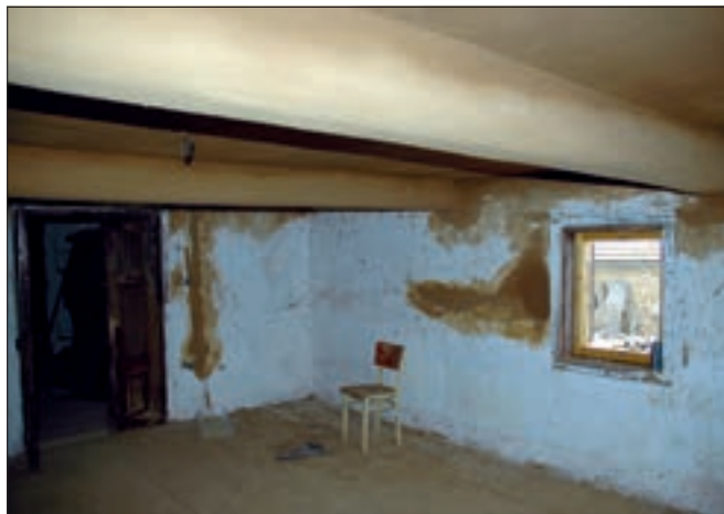
Zamachy-Syslov (okres Mladá Boleslav), čp. 19. Obytné patrové roubené a brázděné stavení prochází postupnou obnovou. V rámci této etapy byly provedeny na opravených konstrukcích stěn a stropů nové hliněné omítky podle původního stavu (foto J. Berková).
