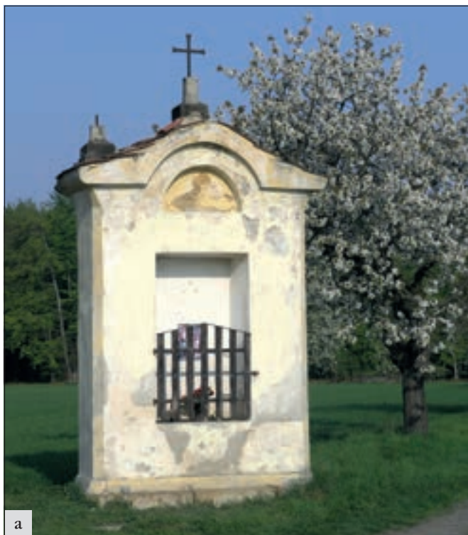
Mšec (okres Rakovník), kaple v polích k Srbči: a – stav před opravou. Počátkem 90. let došlo k otlučení zbytků opadaných štukových říms a článků a následné neodborné zjednodušující opravě; b – rekonstruovat původní vzhled kaple se podařilo zejména díky tomu, že se našla, byť špatně čitelná, malá fotografie. Bylo radostí a zadostiučiněním nakreslit návrh nových profilů, odpovídajících proporcím drobné stavby, a sledovat proměnu kaple při opravě v rukou zkušeného štukatéra (foto E. Volfová).
