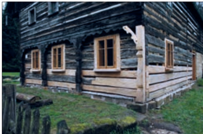
Vidím (okres Mělník), čp. 67. Vnější plášť roubeného stavení po dokončení opravy. Poškozené prvky byly doplněny a nabazeny ručně tesanými trámy. Okenní ostění včetně parapetních říms byla provedena jako repliky posledních prvků tohoto druhu v obci, dochovaných na čp. 76. Doplnění bliněných vymazávek bude následovat po vyschnutí nových prvků v příštím roce (foto J. Berková).
