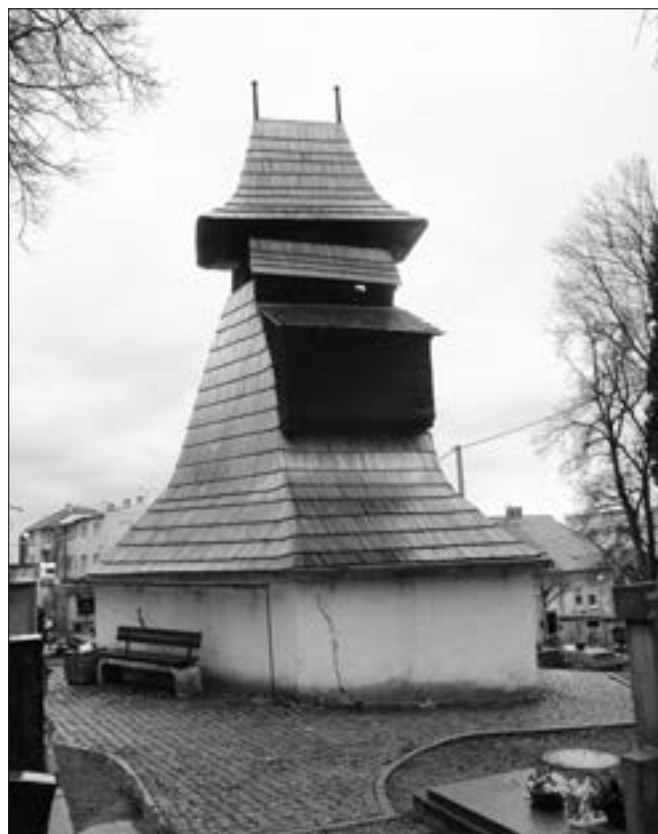
Rakovník, brbitovní zvonice při kostele Nejsvětější Trojice, stav dožilého štípaného šindele na zvonici před opravou byl špatný až bavitelný. Stavbu před výměnou krytiny důkladně prohlédl statik, ing. Miroslav Fuchs, a konstatoval, že tesařská vazba je vcelku v pořádku. Na rozdíl od ní zůstává řadou šikmých vertikálních trblin poškozený zděný sokl. Ten se začne opravovat v nejbližší době. Důležité je zjištění, že jeho stav nijak neohrožuje tesařskou vazbu zvonice uvnitř, ale ani své okolí, (foto E. Volfová).
