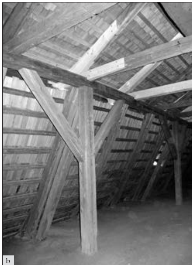
Dolní Krupá fara (okres Mladá Boleslav), a – celkový pohled na faru po obnově krytiny z dřevěného šindele; b – pohled do krovu po opravě. Prvky krovu byly opraveny tradičním způsobem s vysazením poškozených částí s plátovanými kolíkovými spoji. Zachována zůstala i blíněná mazanina podlahy (foto E. Vyletová).
