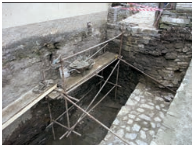
Poteplí – Malé Kyšice (okres Kladno), vodní mlýn čp. 13 – probíhající lokální obnova východní stěny mlýnice po vytěžení druhotně zasypané lednice (foto M. Hanzlíková).
