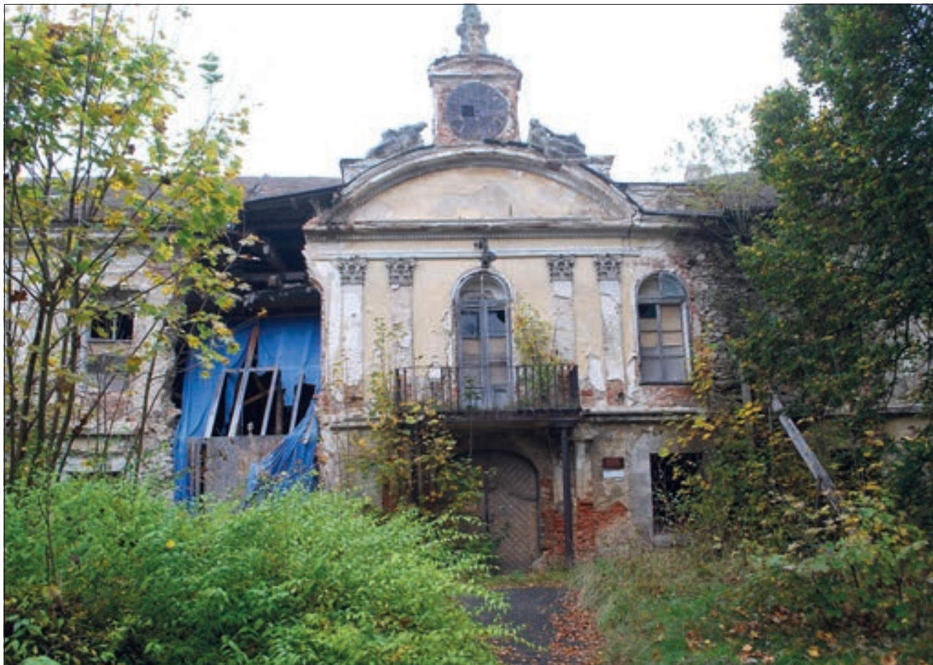
Pravonín (okres Benešov), zámek, stav soukromého zámku v roce 2014; ani plnébo čtvrt století po pádu našeho předcházejícího politického režimu na podzim 1989 se bohužel stále nepotvrzuje zřejmě naivní obecný předpoklad, že každá památka bude mít v nových podmínkách svého odpovědného vlastníka a již nikdy nebude docházet k devastaci kulturního dědictví, které bylo v nefungujícím socialistickém státě dříve zcela běžné (foto J. Mrázek).
