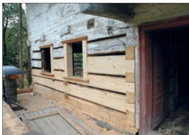
Víska (okres Mladá Boleslav), čp. 6. Dům menší usedlosti má roubenou část z konce 18. století, na kterou navázala mladší patrová hospodářská přístavba ze závěru 19. století. Roubené konstrukce v přízemí obytné části byly v rámci obnovy nabazeny v nezbytném rozsahu novým dřevem. Okenní ostění s profilovanými římsami jsou kopií jediného dochovaného původního okna, které se zachovalo ve výměnkářské světničce (foto J. Berková).
