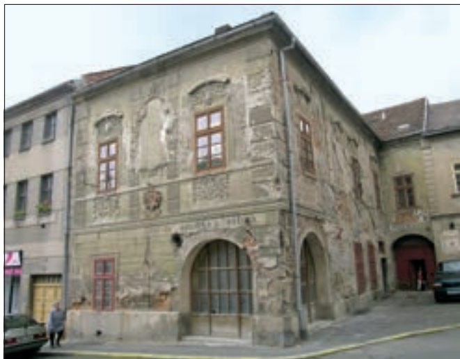
Kutná Hora, rodný dům Mikuláše Dačického z Heslova, čp. 41 na Komenského náměstí. Jedna z mimořádně hodnotných památek města, která čekala dlouhá léta na své znovuoživení. Vzhledem k tomu, že se nyní podařilo prosadit vzorovou opravu a adaptaci tohoto cenného středověkého domu na budoucí Vzdělávací a prezentační centrum kulturního dědictví UNESCO, nebylo dlouhé čekání vůbec marné, naopak je zde jedinečná možnost využít předcházející bohaté zkušenosti z obnovy kutnohorských památek a náročný projekt, který startuje na počátku roku 2015, by se sám mohl stát nejlepším prezentací péče města o své památky (foto J. Mrázek).
