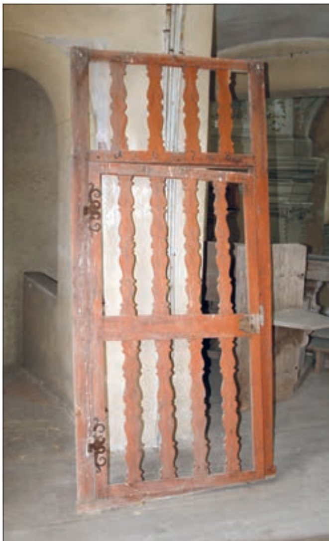
Šonov u Broumova (okres Náchod), kostel sv. Markéty. Barokní dřevěné jednokřídlé dveřní mříže jednoduché konstrukce, drhotně osazené na vyústění schodiště z presbytáře do oratoře kostela, jsou pravděpodobně pozůstatkem původního dřevěného kostela sv. Jana Evangelisty, vyhotoveným při jedné z jeho oprav (v roce 1678). Dveře jsou zchátralé, provizorně umístěné v interiéru oratoří (foto D. Havlíková, 2014).
