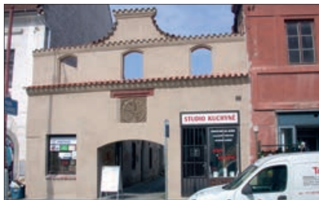
Český Brod (okres Kolín), jižní průčelí Masných krámů po opravě. Tento objekt v jádru pochází z 16. století a je jediný z celkem 28 krámů, které se v té době v Českém Brodě zabývaly prodejem masa. Průčelí krámů bylo v minulosti několikrát formálně upravováno, renesanční kamenný reliéf se znakem řeznického cechu a úsek profilovaného okenního překladu původně nepochází z tohoto objektu, nýbrž na něj byl ve 20. století přenesen. V rámci opravy se nepodařilo korigovat výplně otvorů (foto E. Zápalková).
