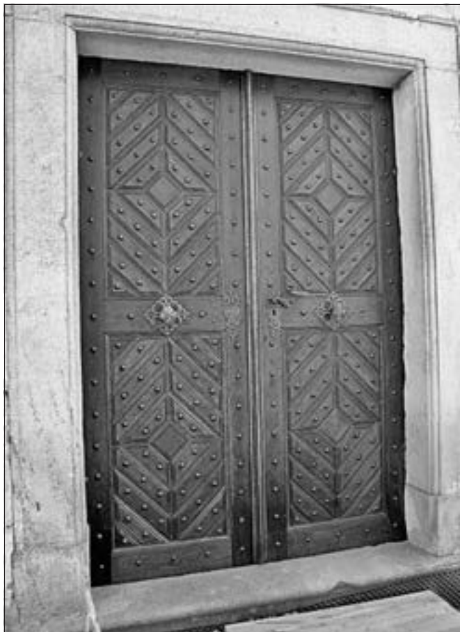
Ruda (okres Rakovník), kaple sv. Anděla Strážce, vstupní dveře po restaurování. Velmi bezká barokní kaple byla postavena roku 1749 při silnici do Prahy. Zadání opravy vstupních dveří s rámovou kazetovou konstrukcí, opatřenou kovnými a kovársky provedenými ozdobnými úchyty, dopadlo velmi zdařile (foto E. Volfová).
