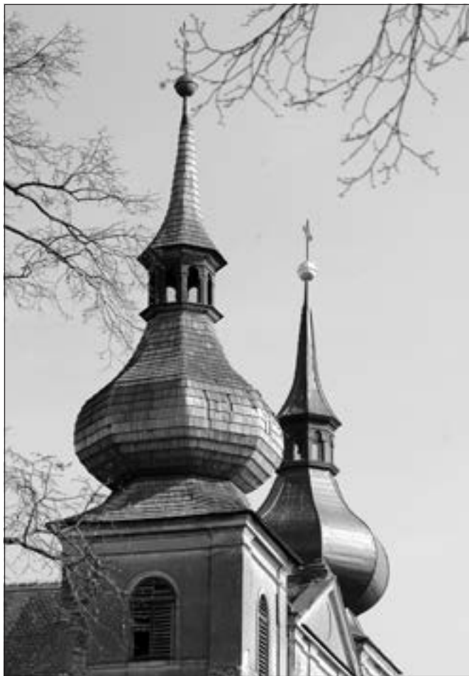
Zbyslav (okres Kutná Hora), střecha západních věží kostela Nejsvětější Trojice. Střechám zdaleka viditelných věží se po náročných opravách krovu vrací plechová krytina doložená již v barokním období. Pochopitelně je třeba předpokládat červený nátěr. Skutečně to není naopak, šindelová krytina je zde až novodobou záležitostí. Stav cibule levé věže ukazuje, jak šindel obnovený v 90. letech 20. století v této exponované poloze trpí povětrností (foto J. Žižka).
