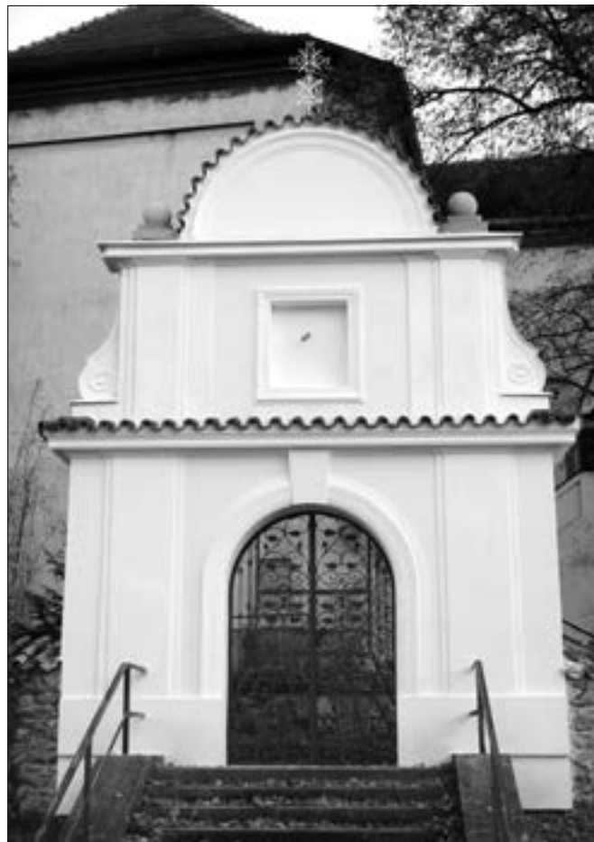
Neveklov (okres Benešov), areál kostela sv. Havla, vstupní brána, celková obnova. Barokní vstupní brána areálu kostela je bohatě členěná štukovými články, jejichž stav byl havarijný. V minulém roce byly odborně obnoveny vnější omítky v jejich původních tvarech a profilacích a zakrytí brány prejzy (foto D. Primusová).
