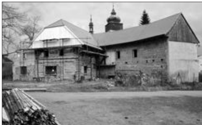
Skalsko (okres Mladá Boleslav), usedlost čp. 26. Obnova střechy a krovu tohoto zánikem obroženého roubeného stavení, které je pozůstatkem jedné z největších usedlostí ve vsi, má zásadní význam pro vzhled centrální části vesnice. Stojí v těsném sousedství areálu kostela, který odděluje od nové bytové zástavby, postavené na parcele zbouraných hospodářských staveb v 80. letech 20. století. S ohledem na stav roubených konstrukcí byl nový krov prozatímně podložen ocelovou podpůrnou konstrukcí, která přenáší zatížení do doby řádné tesařské obnovy roubených stěn domu (foto J. Berková).
