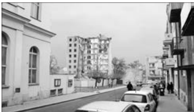
Kutná Hora, dům čp. 555. Závěr roku byl poznamenán dvěma demoličními akcemi, z nichž tato představovala nesporně významný počín. Sedmipatrový dům totiž v roce 1968 necitlivě vstoupil do urbanistické struktury spodní části města a ovlivňoval téměř půlstoletí dálkové pohledy na městské panorama z východní strany (foto A. Pospíšil).
