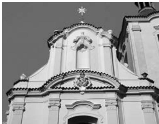
Sluštice (okres Praha-východ), kostel sv. Jakuba, detail západního průčelí. Jednou z nejvýznamnějších akcí okresu Praha-východ v roce 2013 byla záchrana a obnova západního průčelí kostela ve Slušticích. Tento barokní kostel je v rámci obce ve výrazné poloze a je nedílnou součástí historické identity obce. Západní průčelí barokního kostela je mimořádně tvarově bohaté, složené z architektonických článků a jemné dekorativní výzdoby. Po zjištění havarijního technického stavu západního průčelí z lešení bylo konstatováno, že další rok bez opravy by průčelí bez nevratných škod nevydrželo a jeho oprava by v některých místech již byla prakticky nemožná. V rámci obnovy byly rekonstruovány veškeré složitě profilované architektonické články, byla obnovena a doplněna původní dekorativní výzdoba a provedena konečná barevnost fasády (foto J. Žížka).
