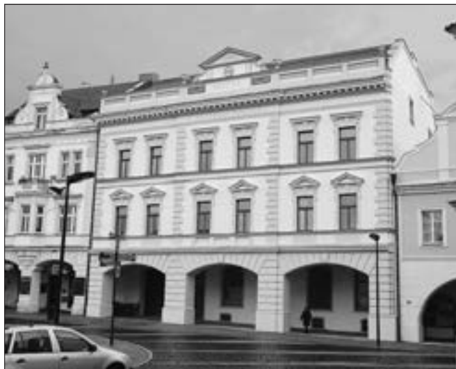
Mělník, průčelí domu čp. 10 – hotelu Bílý beránek po obnově. Obnova fasád domu, navazující na obnovu a úpravy střech, byla pracná pro všechny zúčastněné strany. Byly vytipovány poškozené prefabrikované štukové detaily blavní římsy a doplněny novými, obnoveny byly některé v minulosti odstraněné prvky rízlity. Mnohokrát, již na úrovni zpracování projektu, byla konzultována úprava atiky s přidáním kamenným atikovým trojúhelníkem štítem. Výsledek je výrazným kompromisem s tím, že se po tvarové stránce podařilo dosáhnout relativně věrohodné úpravy. Celá rekonstrukce vnějšího pláště domu čp. 10 byla důkladně konzultována a probíhala zde pravidelná setkání s vlastníkem, firmou a zástupci památkové péče (foto J. Stojanová).
