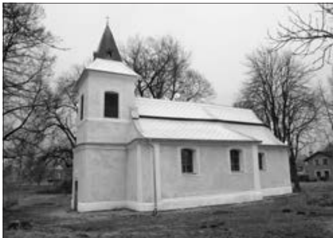
Otěvěky (okres Rakovník), kaple Nejsvětější Trojice, pokládka nové střešní krytiny z cementovláknitých šablon šedé barvy byla dokončena v roce 2011. Oprava fasád probíhala na podzim roku 2013. K dokončení celkové opravy kaple zbývá rehabilitace zanedbaných vnitřních prostor, které byly dlouhodobě vystaveny působení vandalů (foto E. Volfová).
