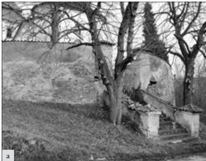
Mrtník (okres Beroun), kostel Narození P. Marie, kamenné schodiště, které stoupá od silnice strmě ke kostelu. Schodiště bylo přeloženo a zpevněno, parapetní zídky přezděny, dostaly novou krytinu z pálených tašek. Dva jírovce u paty schodiště, které svými kořeny vyvracely, byly pokáceny, částečně se tak otevřel výhled na kostel, stíněný několika vzrostlými stromy rostoucími v jeho blízkosti. Na pilířích brány byla obnovena zrcadla z hrubé omítky, kolem kostela bylo obnoveno odvodnění a doplněn chodník z kamenných desek. V další etapě proběhne restaurátorské doplnění chybějících částí stupňů (foto H. Řepková).
