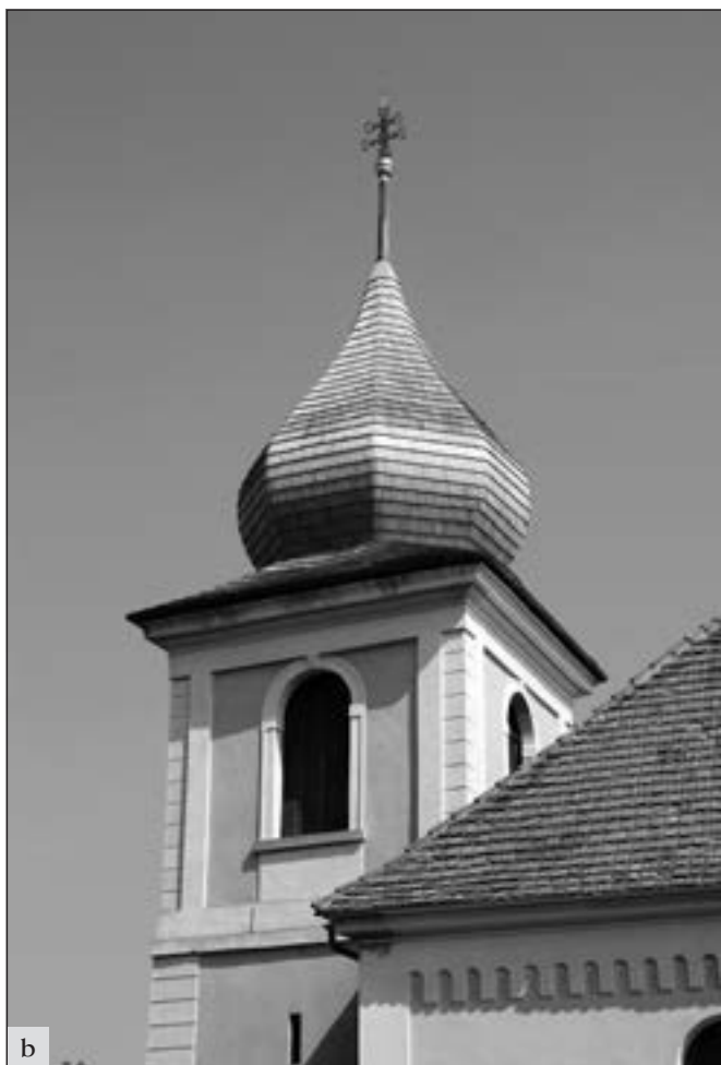
Ždánice (okres Kolín), kostel sv. Havla. Pobled na kostel při probíhající obnově šindelové krytiny věže. Ve vikariátu Kolín se do dnes dochovala řada střech kostelů, částečně nebo zcela pokrytých šindelovou krytinou. Díky zodpovědnému přístupu a pochopení techniků vikariátu se obnova šindelových střech přes nesporně náročnou a nákladnou údržbu stále daří: a – průběh oprav (foto D. Havlíková); b – obnovená šindelová krytina věže (foto V. Láška).
