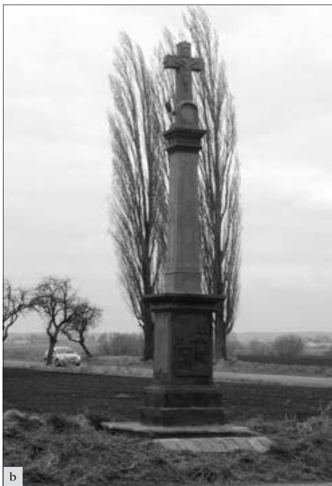
Čáslav (správní obvod Čáslav), kamenný kříž: a – stav po sejmutí. Kříž byl v havarijním stavu a brozil zřícením; b – stav po celkovém restaurování. Vlastní kříž a pilíř byly nabazeny kopiemi z kamene z lokality Nowa Ruda (Polsko), který se blíží barevnosti a strukturou původnímu. Originály byly uloženy v Městském muzeu v Čáslavi (foto L. Maděrová).
