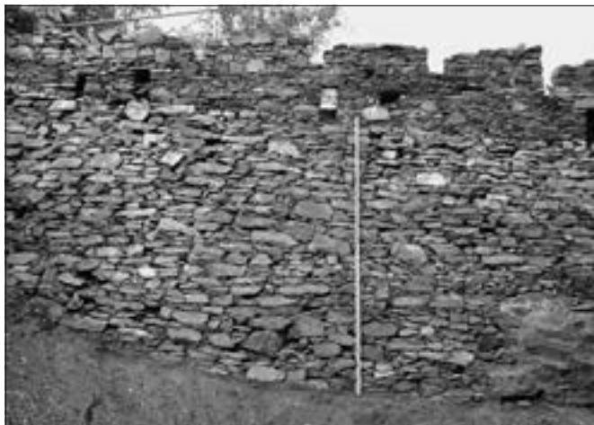
Kouřim (okres Kolín), úsek parkánové brady městského opevnění v parku. Odstranění vegetace, která dosud zcela zakrývala vnější líc parkánové bradby, umožnilo realizovat OPD. Jeho součástí byla tzv. jednosnímková fotogrammetrie. Nad spodní šikmou částí, plynule přecházející v eskarpu příkopu, lze sledovat dva druhy střeleckých otvorů. Horní části „zubů“ zcela nahoře jsou dílem novodobé úpravy věže (foto V. Razím, 2013).
