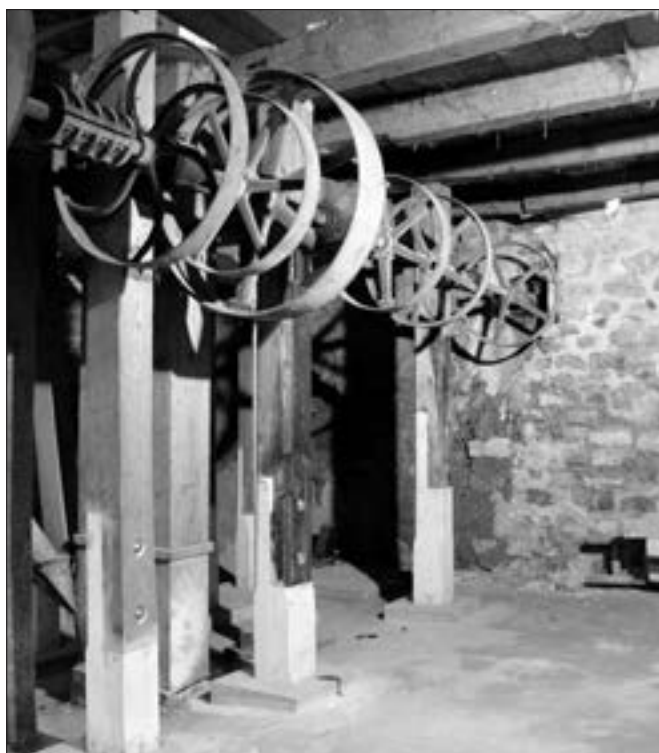
Vepřek (okres Mělník), areál vodního mlýna čp. 19. Na celkovou obnovu domu navázala v letošním roce první etapa celkové obnovy barokní mlýnice. Fotografie dokumentuje protézované sloupky v polosuterénu mlýnice (foto M. Hanzlíková).
