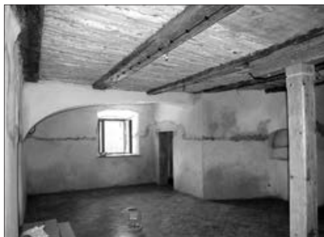
Rakovník, ulice Dukelských brdů, dům čp. 59. V loňském roce prošla stavba cenného pozdně barokního domu důkladnou opravou vnitřních prostor. Součástí byla zejména oprava podlah, kdy se v patře repasovaly ty původní prkenné a místo novodobých podlahovin na betonu se pokládala kvalitní cihelná dlažba. Snímek zachycuje interiér velké místnosti v západní části přízemí s unikátním trámovým stropem s polozapuštěným záklopem tvořeným tyčovinou omotanou povřískem s blíněnou omazávkou (foto E. Volfová).
