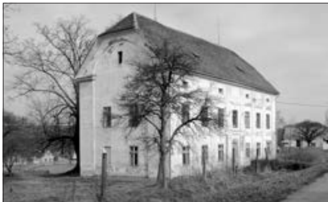
Rousínov (okres Rakovník), bývalá škola. Dominantní budova situovaná v prostoru návsi sloužila původně jako kontribuční sýpka. Z doby její úpravy na školní budovu pocházela také okna v hlavním průčelí. V rámci jejich repase a obnovy byla v této etapě opravena okna celého přízemí (foto J. Berková).
