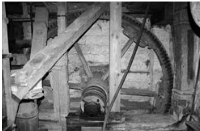
Střebom (okres Mladá Boleslav), vodní mlýn čp. 12. Pohled do prostoru mlýnice dokládá obtížnost prací při výměně břídele, kdy bylo třeba staré paleční kolo bez poškození demontovat a zpětně osadit na novou hřídel, stejně jako kolo vodní na vnější návodní straně mlýnice. Akci provedl sekerník F. Mikyška z Petrovic u Sedlčan (foto J. Berková).
