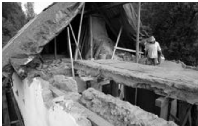
Žemličkova Lhota (okres Příbram), venkovský dům č. e. 5 z počátku 19. století. V srpnu roku 2013 proběhla druhá fáze opravy střechy a stropů tohoto mimořádně hodnotného domu. Zejména stropní konstrukce byla v tak špatném stavu, že musely být vyměněny všechny stropní – vazné trámy a větší část povalu. Obrázek zachycuje pohled na korunu zdiva světnice a část povalového stropu určenou k zachování, po rozebrání krovu a vyjmutí ztrouchnivělých částí stropní konstrukce (foto J. Veselý, červenec 2013).
