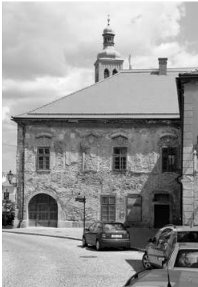
Kutná Hora, dům čp. 41. Kompletní rekonstrukce střechy se po letech dočkal dům známý jako rodný dům Mikuláše Dačického z Heslova. Dlouhodobě zcela neudržovaný a chátrající objekt má šanci na nové využití a obnovu. V této první etapě byl zajištěn bavarijní stav statiky vodorovným ztužením a vložením nového stropu a kompletní výměna krovové konstrukce včetně krytiny z bobrovek. Akce byla realizována podle projektu, který počítá s využitím domu jako sídla restaurátorské školy univerzitního typu (foto A. Pospíšil).
