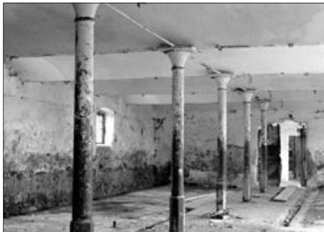
Točnick (okres Beroun), hospodářský dvůr, pobled do interiéru chléva. Chlív dostal svoji dodnes dochovanou podobu v 70. letech 19. století, kdy nabídl barokní stavbu. Při průzkumu bylo možno sledovat návaznost na barokní stavbu, využití některých starších konstrukcí, provedení litinové a železné konstrukce se stažením, a to i z hlediska barevné, v tomto případě zelené úpravy povrchů sloupů (foto J. Žizka).
