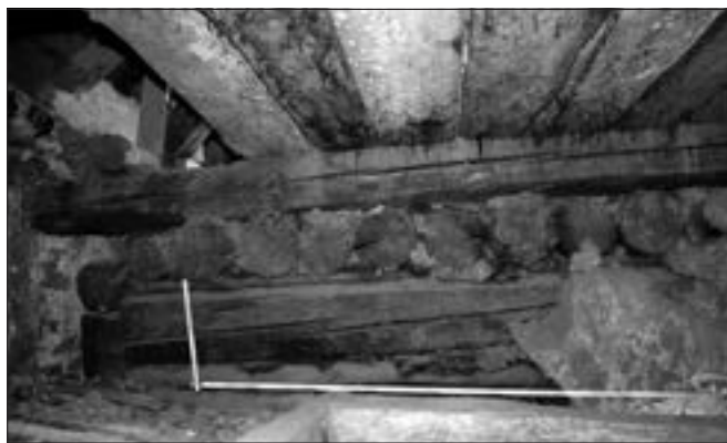
Kutná Hora, Husova ul. čp. 135. Vnější stěna srubu a čela jeho povalového stropu, datované do roku 1539–1540, které vystupují na půdě v mezistropí – mezi stropem patra a podlahou půdy (foto V. Jesenský).
