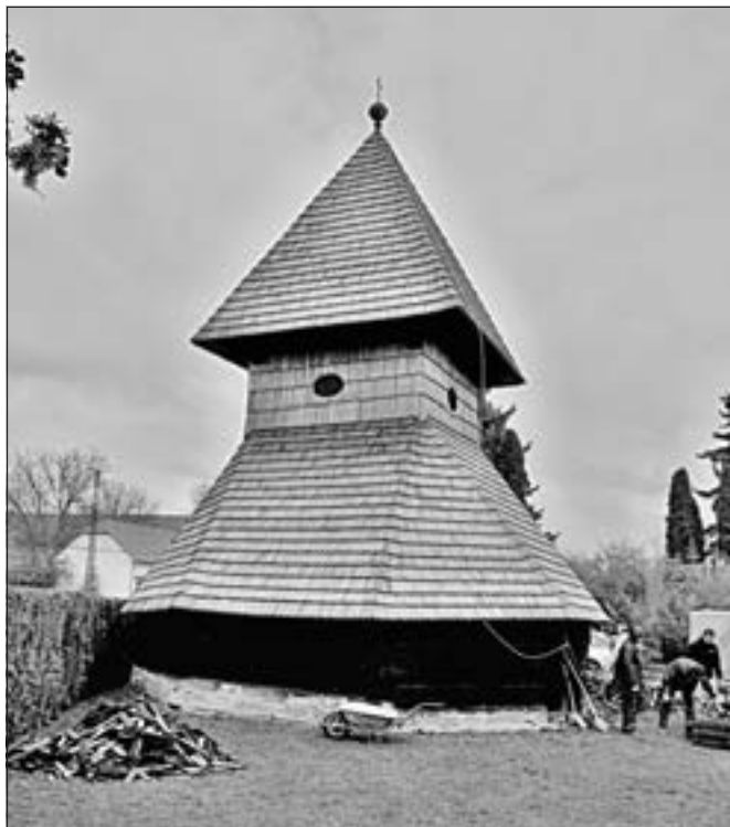
Kosmonosy, část Horní Stakory (okres Mladá Boleslav), zvonice u kostela sv. Havla po obnově šindelové krytiny. Kvalitní obnova krytiny má u zvonice s výrazně přesahující střechou zvonového patra zásadní význam (foto D. Linhartová).
