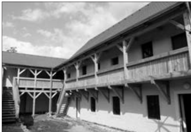
Ledčice (okres Mělník), areál usedlosti čp. 15. V letošním roce byla dokončena hmotová dostavba zaniklých chlívů a navazují podjezdni kolny, které budou sloužit Obci Ledčice jako veřejně přístupné víceúčelové objekty. Pohled na dvorní průčelí dostavby chlívů a kolny (foto M. Hanzlíková).
