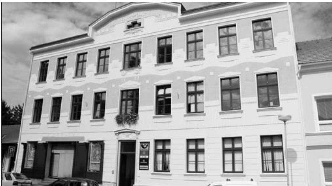
Kutná Hora–Sedlec, dům čp. 167. Mimořádnou akcí svého druhu byl návrat původního architektonického členění fasády bývalé školy v Zámecké ulici. Výrazná dvoupatrová budova převyšující okolní zástavbu byla zbavena členění i truhlářských výrobků během druhé poloviny 20. století. Na základě historické fotografie se podařilo členění obnovit včetně oken a dveří či výkladce. Je nutné podotknout, že nejde o kulturní památku (foto A. Pospíšil).
