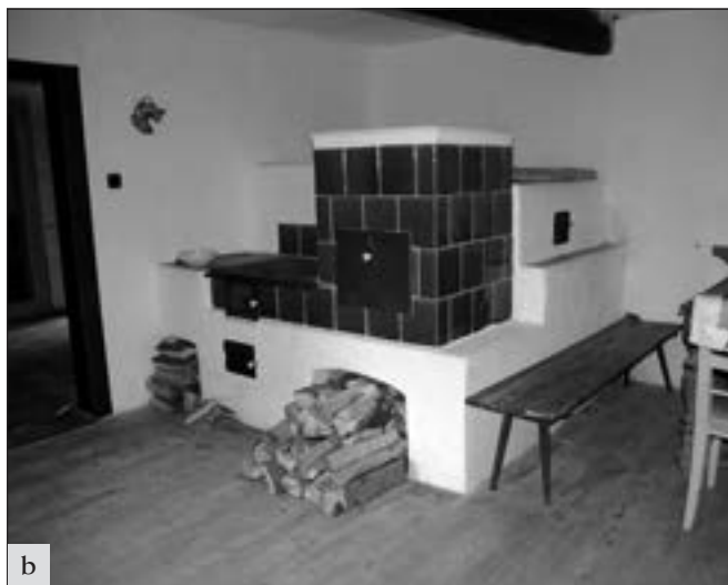
Vidím (okres Mělník), chalupa čp. 78: a – většina roubených chalup na Kokořínsku přišla v důsledku změny využití pro rekreační účely o původní otopná zařízení, která byla často nabírávána otevřenými krby; b – v rámci celkové obnovy domu čp. 78 byla rehabilitována tradiční podoba topeniště s kachlovým tabovým sporákem a chlebovou pecí. Tyto prvky velmi pozitivně změnily celkový charakter světnice (foto J. Berková).
