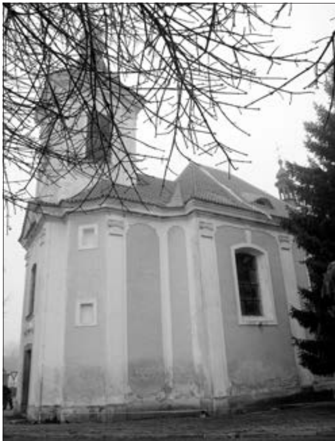
Bratronice (okres Kladno), barokní novostavba kostela Všech svatých je dominantní stavbou v návesním prostoru a jedinečným způsobem se uplatňuje v panoramatu vesnice. Předchozí prejzová krytina byla dožila, kůrky samovolně sjížděly se střešních rovin. Také barokní krov byl místy vážně napaden bnilobou. Krov datovaný do roku 1774 představuje vedle vysoké řemeslné úrovně zpracování velmi vysoké estetické kvality (foto E. Volfová).
