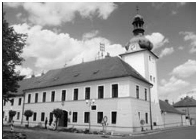
Kostelec nad Labem (okres Mělník), budova radnice po obnově fasády. Radnice patří pochopitelně v rámci města k nejbodnotnější a architektonicky nejvýraznější stavbám. Členění fasády zde vyniká i v kontextu s jinak ve druhé polovině 20. století výrazně ocbuzenými fasádami většiny okolních městských domů. Při opravě se podařilo vylepšit některé tvary a detaily i korigovat barevný rozvrh (foto J. Stojanová).
