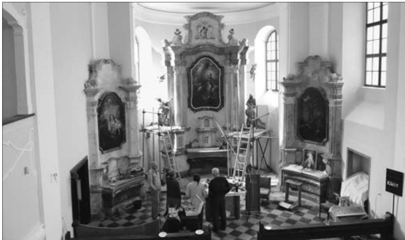
Ostředek (okres a správní obvod Benešov), zámecká kaple sv. Jana Nepomuckého, celkové restaurování interiéru – hlavního oltáře, bočních oltářů, obrazů, nástěnných obrazů a umělých mramorů. Na snímku interiér kaple ve stavu rozpracovanosti restaurování umělých mramorů se snesenými dřevorezbami již po osazení zrestaurovaných obrazů. Obrazy restauroval ak. mal. Petr Šafus (foto M. Kuldová).
