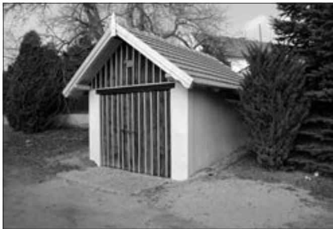
Sitné (okres Mělník). Drobné stavby hasičských zbrojnic byly dříve tradiční součástí vybavenosti vesnice. S postupnou proměnou hasičské techniky však většina z nich zanikla nebo byla přestavěna. Hasičská zbrojnice z počátku 20. století v Sitném je jedním z mála dochovaných reprezentantů tohoto typu staveb na Kokořínsku. Jedinou změnou, kterou bylo v rámci obnovy třeba akceptovat, bylo nabrání původních šedých betonových drážkových tašek malého formátu, které se dnes nevyrábějí, pálenou krytinou (foto J. Berková).
