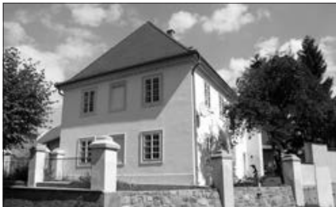
Drabenice (okres Příbram), stará škola čp. 56. Dokončení celkové obnovy fasády pohledově exponované stavby situované na východní straně návsi (foto M. Hanzlíková).
