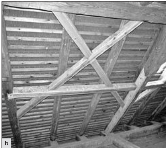
Skryje (okres Rakovník), kostel sv. Archanděla Michaela: barokní kostel disponuje velmi pěknou vazbou barokního tesařského krovu. Jelikož je krytina překládána z více jak 100 let starých bobrovek již dožilá a dochází k haváriím, přikročilo se k položení nové krytiny opět z bobrovek na opravený a překontrolovaný krov: a – stav před opravou, b – po dobře provedené opravě (foto E. Volfová).
