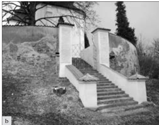
Mrtník (okres Beroun), kostel Narození P. Marie, kamenné schodiště, které stoupá od silnice strmě ke kostelu. Schodiště bylo přeloženo a zpevněno, parapetní zídky přezděny, dostaly novou krytinu z pálených tašek. Dva jírovce u paty schodiště, které svými kořeny vyvracely, byly pokáceny, částečně se tak otevřel výhled na kostel, stíněný několika vzrostlými stromy rostoucími v jeho blízkosti. Na pilířích brány byla obnovena zrcadla z hrubé omítky, kolem kostela bylo obnoveno odvodnění a doplněn chodník z kamenných desek. V další etapě proběhne restaurátorské doplnění chybějících částí stupňů (foto H. Řepková).
