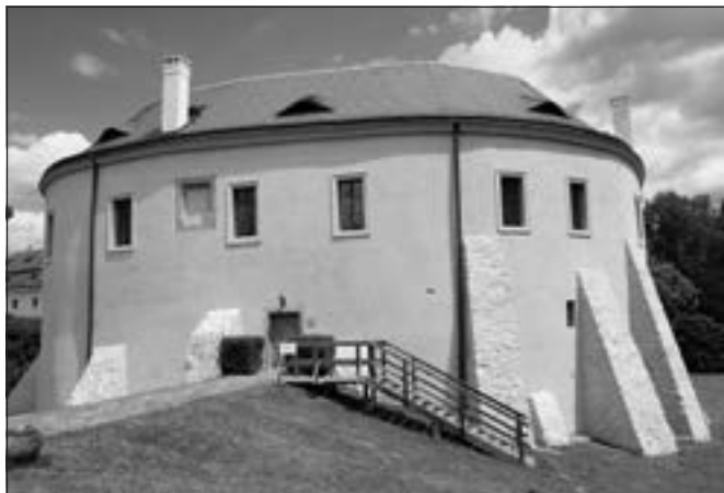
Roztoky (okres Praha-západ), zámek. Stavební obnova exteriéru a interiéru zámku po povodni v roce 2002 byla dokončena v říjnu 2012 a v průběhu roku 2013 na ni navázala příprava muzeální expozice Středočeského muzea v Roztokách, tematicky zaměřená na vrchnostenskou správu velkostatku a život v Roztokách, oblíbeného letoviska Pražanů. Expozice s množstvím hodnotných sochařských a malířských děl, s mobiliářem, tapisériemi i historickými předměty každodenního života byla realizována v přízemí a v prvním patře zámku a slavnostně byla otevřena v červnu 2014 (foto V. Láška).
