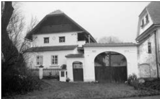
Skalsko (okres Mladá Boleslav), usedlost čp. 20. Obnova fasády štitového průčelí domu a návesní brány je první etapou obnovy fasády návesního průčelí usedlosti. Při obnově bylo třeba zachovat veškerou štukovou výzdobu, která je na obytném stavení provedena na spodní vrstvě tradiční bliněné omítky. Barevnost kombinující základní plochu v lomené bílé a červené prvky výzdoby a okenních ostění vycházejí z dochovaného stavu Skalsko (foto J. Berková).
