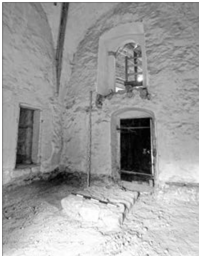
Strenice (okres Mladá Boleslav) – tvrz Velké Horky, čp. 84. I zdánlivě banální stavební zásah, jakým je výměna dřevěné podlahy, vyžaduje archeologický dozor. Cenné architektonické prvky se mohou skrývat poměrně mělce pod současným povrchem. Na fotografii je zděný kamenný sokl, který se objevil po odstranění klenebního zášypu v prostoru, který mohl sloužit jako kaple. Podle jedné z interpretací se jedná o základ oltářní menzy (foto Z. Neustupný).
