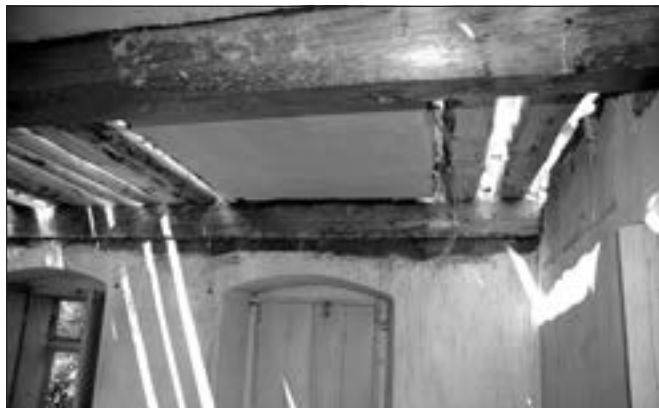
Žemličková Lhota (okres Příbram), dům č. e. 5. Při výměně stropních trámů ve světnici bylo třeba nejen ochránit unikátně dochované otopné zařízení, ale zachovat maximum z původního povalového stropu. Foto zachycuje jeden z menších bloků původního záklopu v prvním poli stropu, po zpětném osazení na nové trámy (foto J. Berková).
