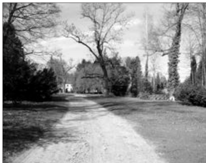
Žebušice (okres Kutná Hora), v zámeckém parku byly obnoveny také komunikace. Mlatová úprava patří k nejstarším metodám zpevnění cestních povrchů. Pokud vlastníky kulturní památky je milovníkem zámeckého parku i koní, je estetická hodnota mlatové cesty snižována (foto R. Bočková).
