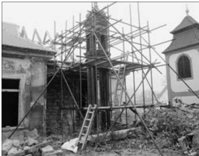
Koleč (okres Kladno), část zámku s kostelem Nejsvětější Trojice. V Kolči úspěšně pokračovala postupná obnova zámku donedávna patřícího mezi nejbožejší památky v kraji. Při opravě krovu zámeckého kostela byla nejprve s pomocí jeřábu snesena sanktusová věž a následně provedena oprava krovu presbytáře kostela. V dané situaci jistě potěší skutečnost, že se podařilo vrátit zpět přibližně polovinu trámů původní tesařské vazby krovu (foto E. Volfová).
