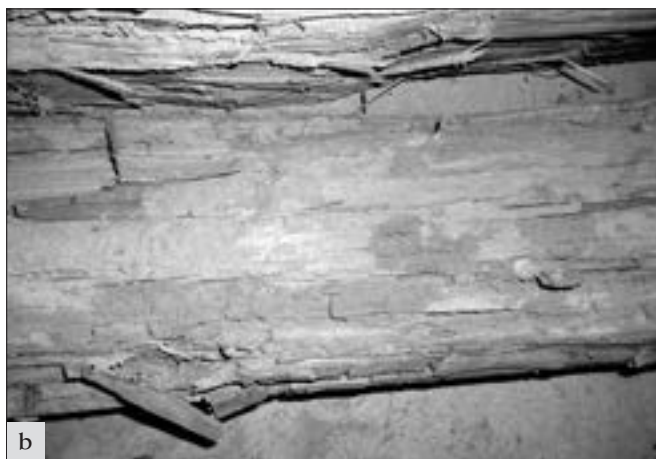
Veltrusy, zámek: a, b – detail narušení trámy (foto V. Komárek).
