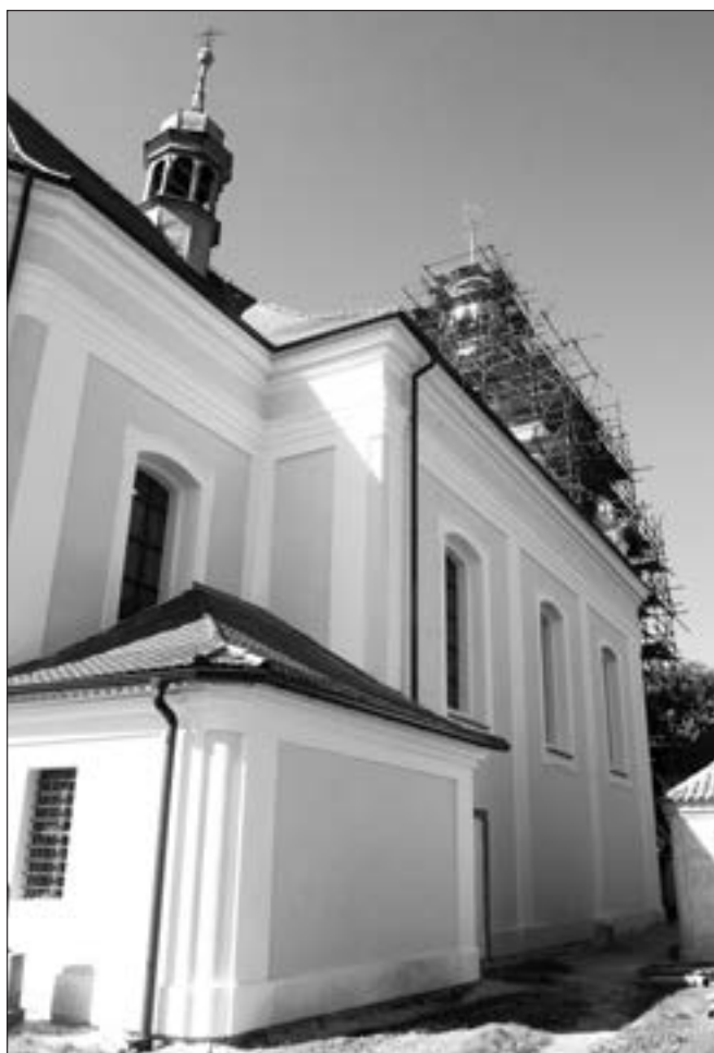
Chorušice (okres Mělník), kostel Nanebevzetí Panny Marie od severovýchodu během obnovy. Významnou akcí byla celková obnova kostela Nanebevzetí Panny Marie. Práce probíhaly ve výborné spolupráci s prováděcí firmou, investorem i dozorem projektanta a podařilo se v jedné stavební sezóně provést celkovou opravu kostela. Ta zahrnovala provedení nové konstrukce krovu věže kostela včetně oplechování, restaurování všech okenních a dveřních otvorů, restaurování soch a opravu omítek kostela. Dále byla opravena i márnice u kostela (foto A. Burešová).
