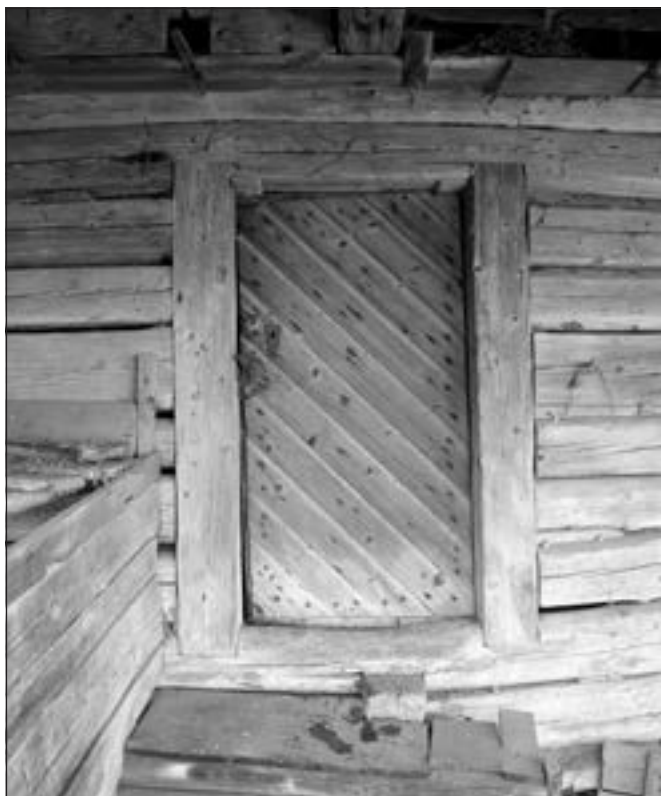
Třetužel usedlost č. 11. Archaický vstup do jednokomorového roubeného špýcharu demolované usedlosti, s konstrukční trámovou zárubní se sedly a se zdobnými dvouplášťovými svlakovými dveřmi (foto J. Veselý, březen 2012).
