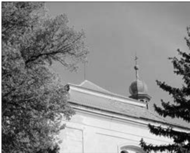
Týnec (okres Mladá Boleslav), kostel sv. Anny, pobled na částečně opravenou střechu. V roce 2012 zde byla úspěšně dokončena další etapa tesařských oprav krovu na jižní straně střechy včetně zhotovení kopie dřevěné mansardové římsy a položení bobrovek na latě. Obrázek ilustruje velmi častý stav při opravě památky, která musí být vzhledem k nedostatku finančních prostředků rozvržena na několik dílčích etap (foto D. Linhartová).
