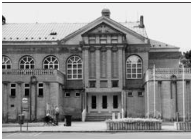
Rakovník, objekt Sokolovny, čp. 733. Havarijní stav velkých oken sálu sokolovny vyústil roce 2012 v jejich opravu. Vnitřní okna zůstala po nezbytné opravě zachována, kdežto vnější výplně bylo nutné nabravit novými. Výroba nových kovových oken velkých rozměrů se nakonec ukázala jako obtížně proveditelná. Za cenu rozšíření profilů rámců i křídel se úkol nakonec podařilo splnit. Kromě oken se pořizovala také sestava trojice dřevěných vchodových dveří jako repliky podle archivních fotografií (foto E. Volfová).
