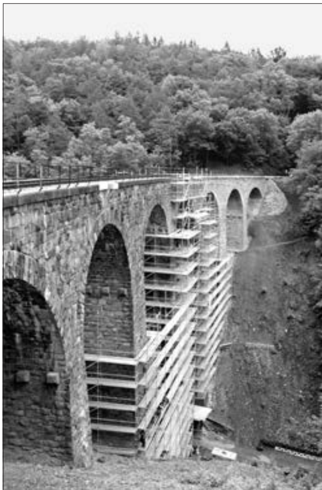
Jilové u Prahy (okres Praha-západ). Esteticky velice působivý, největší a nejvyšší kamenný železniční most v Čechách, překlenující údolí Žampachu, byl do provozu uveden roku 1900. Jeho obnova započala v roce 2011 úpravou horní části. V první polovině roku 2012 byla provedena obnova vlastního zdiva mostu – injektování, spárování a čištění. I díky zodpovědnému přístupu dodavatele prací dopadla celá akce velmi dobře (foto J. Svobodová).
