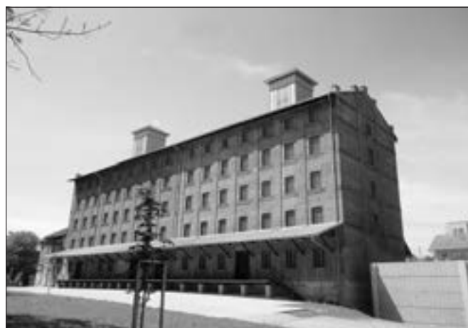
Kutná Hora–Hlouška, pohled na zrekonstruovanou budovu centrálního depozitáře (foto V. Komárek).
