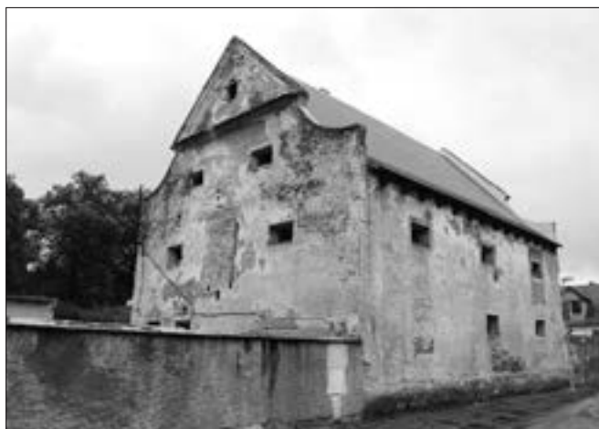
Zlenice (okres Benešov), sýpka, oprava střechy. Při citlivé obnově střechy byl opraven krov a položena nová krytina z pálených bobrovek. Bylo obnovené také zakrytí štítů, při kterém byly použity původní tašky. Na příští léta je projednána obnova barokní fasády sýpky, jejíž realizací by byla podoba jediného zachovalého objektu bývalého hospodářského dvora vhodným způsobem rehabilitována (foto D. Primusová).
