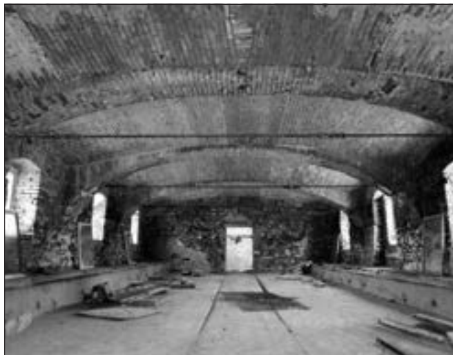
Třebešice (okres Benešov), areál zámku, budova chlévů, celková obnova. Budova chlévů byla před započetím obnovy v havarijním stavu. Nad částí půdorysu úplně chyběla střecha a strop, tvořený cibelnými klenbami (plackami do pasů), který byl v rozsahu tří polí zřícený. V minulém roce byla provedena celková obnova střechy – opraven krov a položena nová krytina z pálených bobrovek. Obnova chléva je vzorovým příkladem přístupu k velké hospodářské budově z 19. století. Na snímku je obnovená klenba stropu chléva, která byla opětovně vyklenuta z ciblí v původním tvaru (foto D. Primusová).
