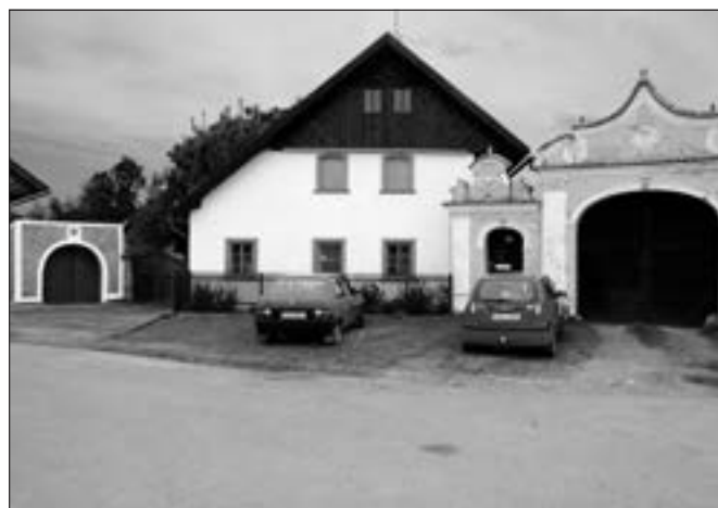
Víška (Mladá Boleslav), čp. 5. Hlavní průčelí usedlosti získalo po předchozí obnově oken novou omítku, která navrátila jeho vzhled do doby z počátku 20. století – srov. ročenka 2011, s. 51 (foto J. Berková).
