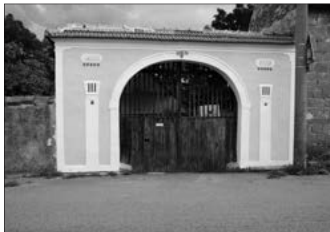
Skalsko (okres Mladá Boleslav), čp. 20. Zadní brána usedlosti po dokončení celkové obnovy fasády (foto J. Berková).
