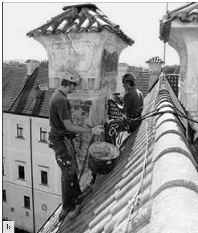
Konopiště (okres Benešov), zámek, v rámci údržby byly provedeny: a – nutné opravy a údržba střešní krytiny východního křídla; b – opravy omítek komínů.
