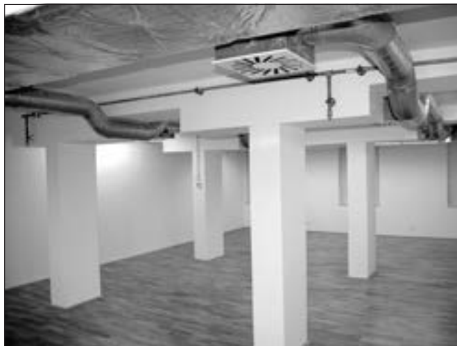
Kutná Hora – Hlouška, centrální depozitář, interiér (foto archiv NPÚ).
