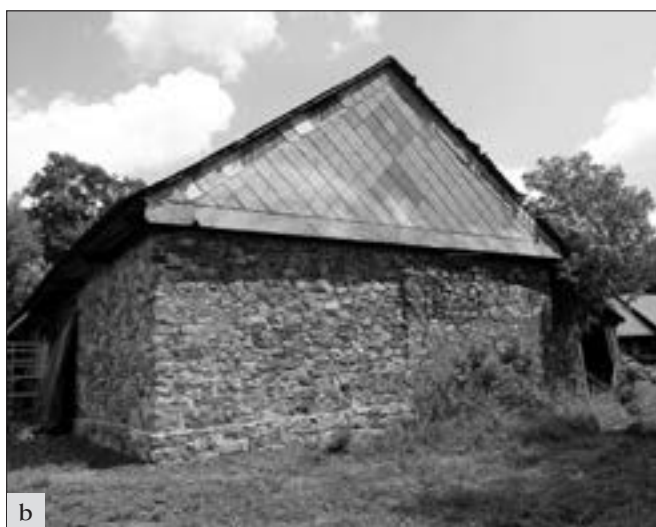
Olešná (okres Beroun), usedlost čp. 12. Zahájení dlouho připravovaného statického zajištění stodoly dává naději na zachování její další existence. První etapa řešila odstranění havarijního stavu severozápadního nároží: a – zachycuje stav před zahájením prací; b – dokumentuje výsledek obnovy s poměrně pečlivě přezděnou stěnou (foto M. Hanzlíková).
