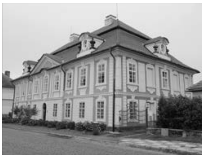
Zlonice (okres Kladno), celkový pohled na barokní faru. V průběhu posledních let byla postupně kvalitně realizována oprava fasád fary. V roce 2012 obnova pokračovala opravou oken, která byla ve značně narušeném stavu. Především spodní partie, včetně špalet a parapetů, byly vlivem povětrnosti a slunečního záření poškozené. Došlo k repasi oken; nejvíce narušené partie (některé okapníčky a spodní rámy okenních křídel) byly vyměněny. Kování bylo očištěno, odstíny nátěrů oken vycházely z původních, dle průzkumu barevnosti (hnědá vnitřní křídla, bílá lícová křídla). Celkový výsledek obnovy je třeba pokládat za velmi zdařilý (foto E. Mikešová).
