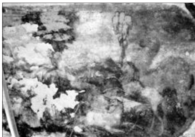
Králův Dvůr (okres Beroun), přízemí jižního křídla zámku, klenba, Orfeus hrající zvířatům, kolem 1586. Část malby během průzkumu. Na záběru vlevo je patrné poškození omítek a čidlo monitorující teplotu a vlhkost ve vrcholu klenby (foto M. Pařízek).
