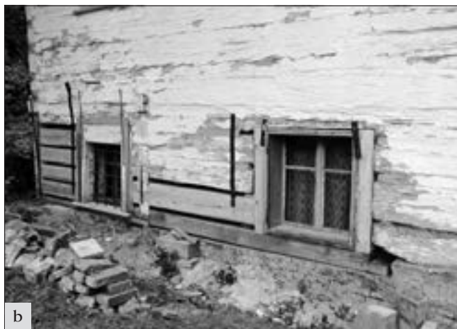
Vicmanov (okres Mladá Boleslav), Blazkův mlýn. Unikátně dochovaný celoroubený mlýn prochází postupnou obnovou. Po dokončení vnějších bliněných omítek na tzv. šalandě – a (srov. ročenka 2011, s. 51), pokračovaly práce na obnově roubených stěn hlavní budovy – b (foto J. Berková).
