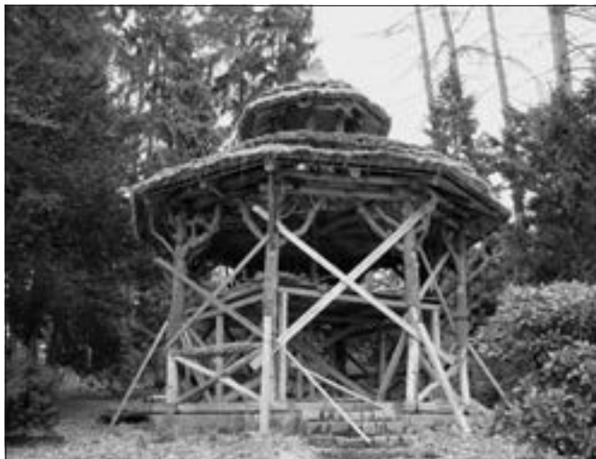
Konopiště, zámek, další dílčí části pokračovala oprava korkového pavilonu v Růžové zahradě, byla položena došková krytina.
