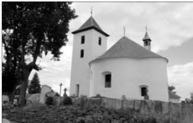
Libouň (okres Benešov), kostel sv. Václava. V minulém roce byla obnovou fasád a střechy dokončena 20 let probíhající celková obnova románského, barokně přestavěného kostela sv. Václava. Součástí akce byla i obnova márnice a ohradní zdi bříbitova. Interiéry kostela a márnice byly obnoveny restaurátorský. Oprava zahrnovala nástěnné malby kostela a márnice i veškerý inventář kostela – opraveny byly cenné barokní oltáře, kazatelna a mřížka (foto D. Primusová).
