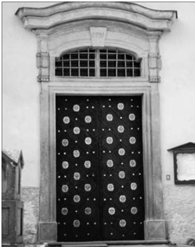
Obořiště (okres Příbram), dveře do kostela sv. Josefa. Cenné barokní dveře kostela sv. Josefa v Obořišti prošly velmi kvalitní péčí uměleckého kováře a truhláře. Dřevěné prvky byly repasovány, podařilo se do nich ukrýt i zabezpečovací zařízení. Kované růžice byly repasovány a doplněny, byla vytvořena replika chybějícího barokního krabicového zámku a opraveny poškozené kované zástrčky. Z průzkumu barevnosti vyplynulo, že ozdobným prvkem vrat nebyly jen růžice, ale i hlavy břebů, na zrestaurovaných vratech se proto oba prvky vzájemně doplňují (foto H. Řepková).
