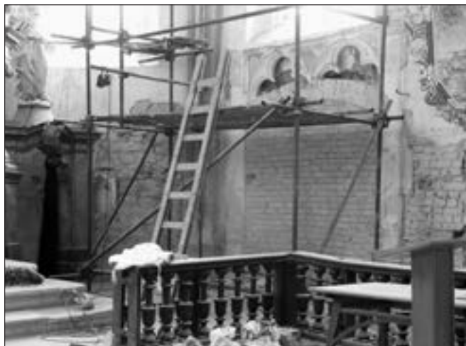
Benátky nad Jizerou (okres Mladá Boleslav), kostel Narození P. Marie v areálu zámku. V rámci průzkumných a restaurátorských prací byl na jižní stěně závěru odkryt výklenek (pravděpodobně sedile) s dvojicí kružeb. Souběžně prováděným operativním průzkumem bylo zjištěno, že kružby nejsou v původní poloze. Na základě vyhodnocení celkové situace bylo možné hypoteticky odvodit původní výšku sedile a jeho umístění ve vztahu ke gotickým příporám. O existenci gotické přípory vpravo od sedile vypovídá cibelná vyzdívka, která je shodná s šířkou dochovaných gotických přípor v nárožích závěru (foto E. Vyletová).
