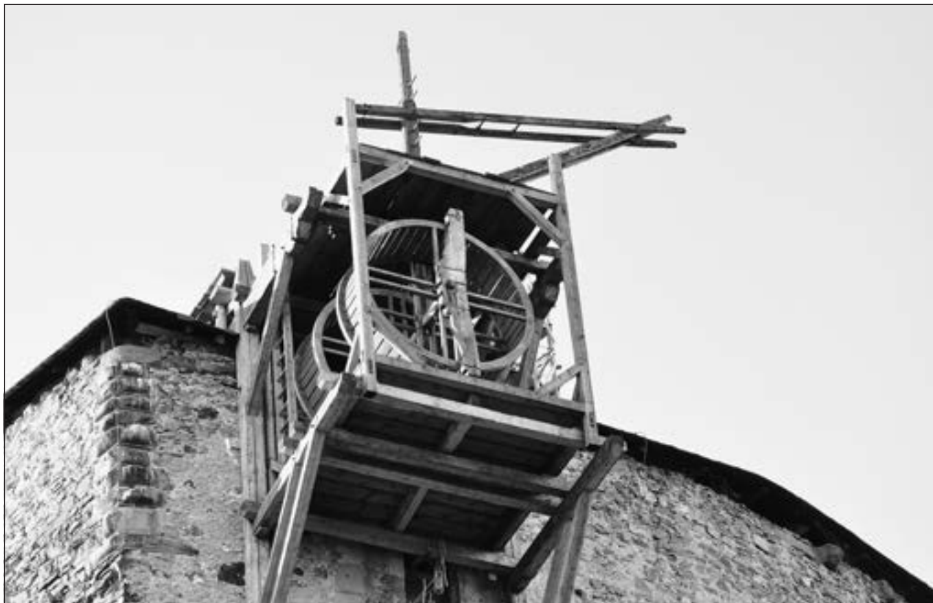
Točník (okres Beroun), na brad se vrátila replika středověkého šlapacího jeřábu, který byl použit i při opravě blavní věže hradu Kost a krovu Královského paláce na Točnicku (foto V. Razím).
