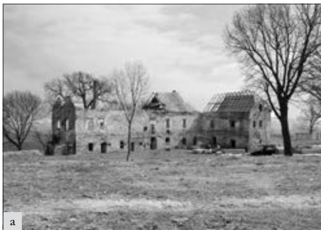
Studénka (okres Mladá Boleslav), zámek: a – zámek obsahující v jádře renesanční tvrz byl dlouhodobě v bavorském stavu bez střechy s propadlými stropy a staticky narušenými obvodovými stěnami. Objekt bezprostředně ohrožený zánikem se konečně podařilo zabezpečit; b – v letošním roce byla dokončena obnova krovů nad oběma křídly, položení definitivní krytiny by mělo být dokončeno v příštím roce (foto E. Vyletová).
