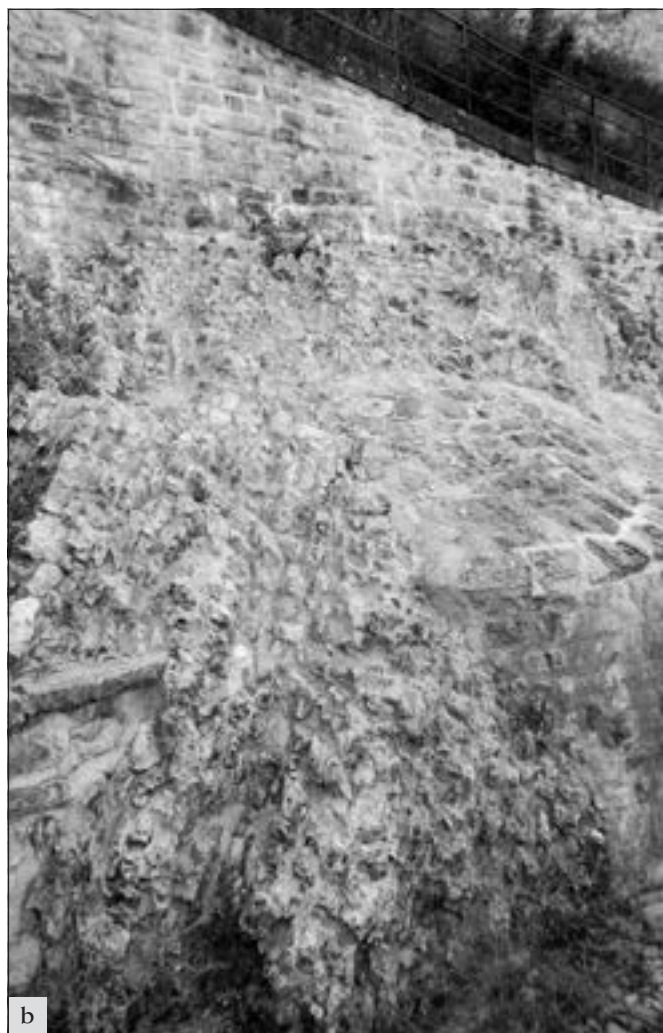
Karlštejn, brad, svahy za vstupní branou: a-d – finální úprava povrchu opěrné zdi a skalního vstupu za vstupní branou; e – pohled na opravu opěrné zdi svahů za vstupní branou (foto V. Komárek).
