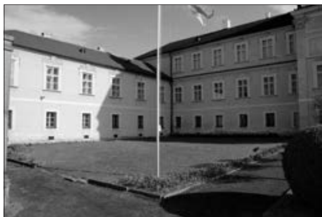
Hořovice, zámek, buxusy na vstupním nádvoří po zmlazovacím zásahu.
