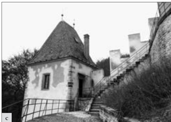
Karlštejn, brad: a–i – opravy omítek a korun zdiva bradeb nad vstupní branou (foto V. Komárek).
