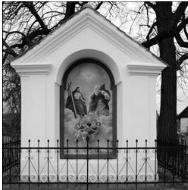
Nosálov (okres Mělník), návesní výklenková kaple – stav po opravě. Tato drobná stavba vyžadovala nejen opravu krytiny a částečně opadavých omítek, ale zejména obnovu obou obrazů malovaných na plechovém podkladu, osazených v nikách kaple. Šlo o obraz Ukřižování, který byl v minulosti přemalován a jeho podklad nesl četné stopy poškození střelbou, a novodobý obraz s motivem Nejsvětější Trojice osazený na čelní straně (foto J. Berková).
