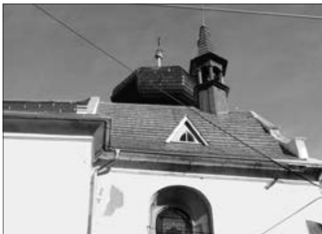
Počepice (okres Příbram), střecha presbytáře kostela sv. Jana Křtitele. Oprava krovů a střechy kostela, rozdělená na několik malých etap v roce 2012 svým způsobem vyvrcholila položením nové šindelové krytiny. Krov byl opraven kvalitně, tradičním tesařským způsobem (foto H. Řepková).
