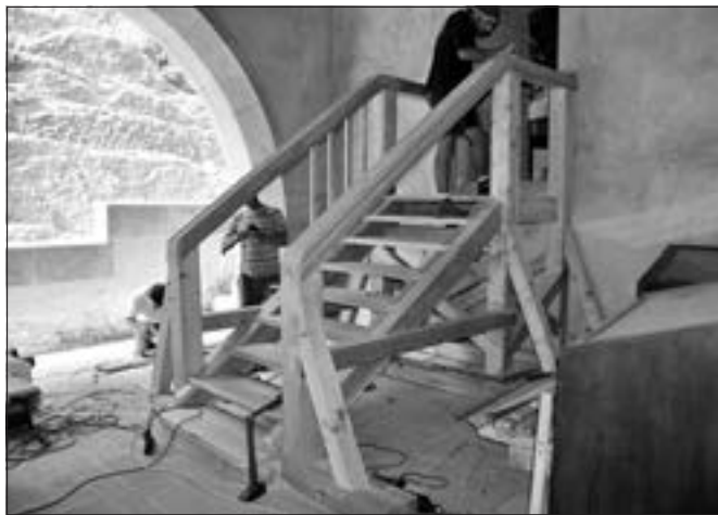
Karlštejn, hrad, byly zhotoveny rozebratelné dřevěné schody pro vstup z arkádového přístavku do prostor koníny při pořádání výstav.
