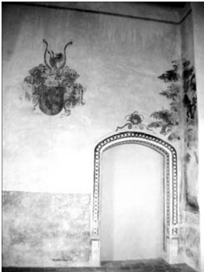
Křepenice (okres Příbram) tvrz, 1. etapa restaurování renesančních nástěnných maleb prvního patra tvrze. Na snímku je celkový záběr na část tzv. Dětského pokoje, kde byla zrestaurována celá jeho dřívější stěna s částí již ubourané příčky. Ta zahrnuje erb Konehvězdských z Koněhvězd a listnatý strom s chlapcem, který by mohl být stromem se zlatými jablky ze zabradý Hesperidek. Malbu datovanou do doby po roce 1588 pod vedením Jana Vojtěchovského citlivě zrestaurovala (včetně ikonografického průzkumu) Hedvika Herbsová (foto M. Kuldová).
