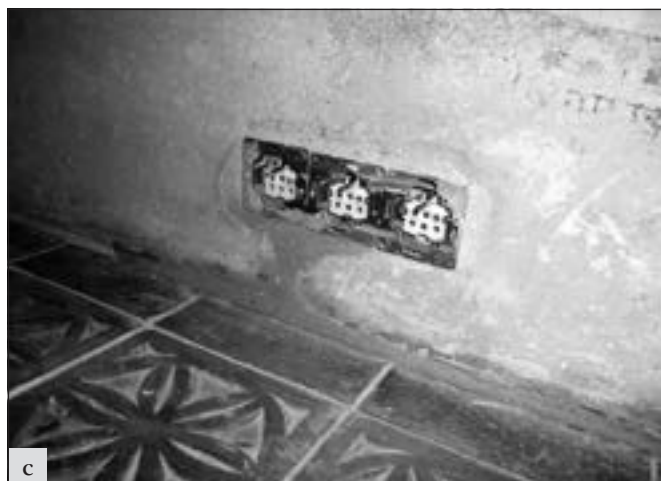
Karlštejn (okres Beroun), hrád, elektrifikace Mariánské věže: a, b, e – detaily ukládání silnoproudých a slaboproudých rozvodů do vrtu hlavní obvodovou zdi a do koryta v podlaze interiéru; c – detail instalace zásuvek do obvodové zdi v interiéru Mariánské věže; d – krycí dvířka rozvaděče; f – informační tabulka vtipně umístěná správou objektu na staveništi (foto V. Komárek).
