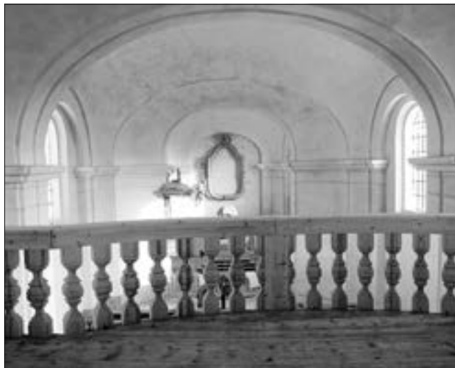
Všesulov (okres Rakovník), kostel sv. Martina, interiér varbanní kruchty v pohledu od věže směrem k presbytáři. V roce 2011–2012 pokračovala dlouhodobá obnova kostela opravami varbanní kruchty. Kuželky balustrádového zábradlí byly natolik napadeny červotočem, že se je před veškerou snabu nepodařilo zachránit a byly nabazeny kvalitně provedenými kopii. Na obnovu zábradlí navázala oprava prkenné podlahy (foto E. Volfová).
