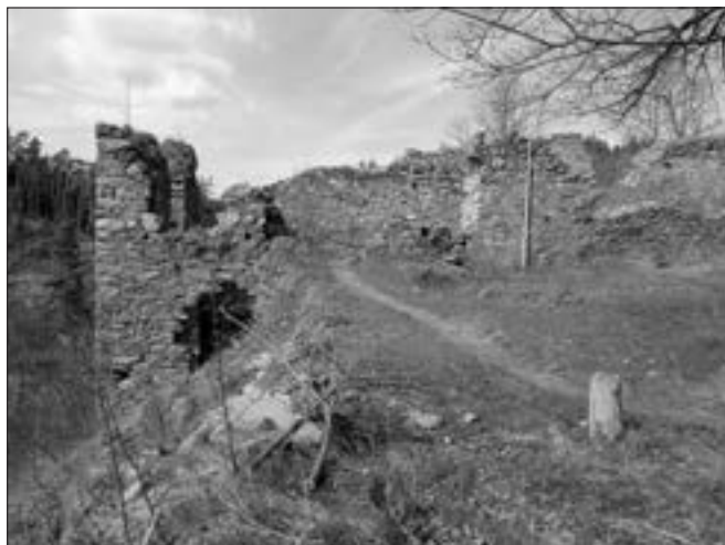
Hrad Dívčí Kámen (okres Český Krumlov, k. ú. Křemže), obytná stavba v parkánu. Zřícenina rozsáhlého rožmberského bradu dosud nebyla podrobena detailnímu stavebněhistorickému průzkumu. Byť každoročně v důsledku samovolné destrukce zdiva dochází k úbytku její výpovědní hodnoty, ještě dnes ji lze považovat za jeden z nejdůležitějších pramenů ke studiu kultury bydlení v elitním sociálním prostředí pozdního středověku. Proto byla v rámci výzkumného úkolu zevrubně zdokumentována jedna vytipovaná stavba v parkánu bradu, u níž lze studovat stopy po zaniklé výdřevě obytných místností (foto J. Kypta).
