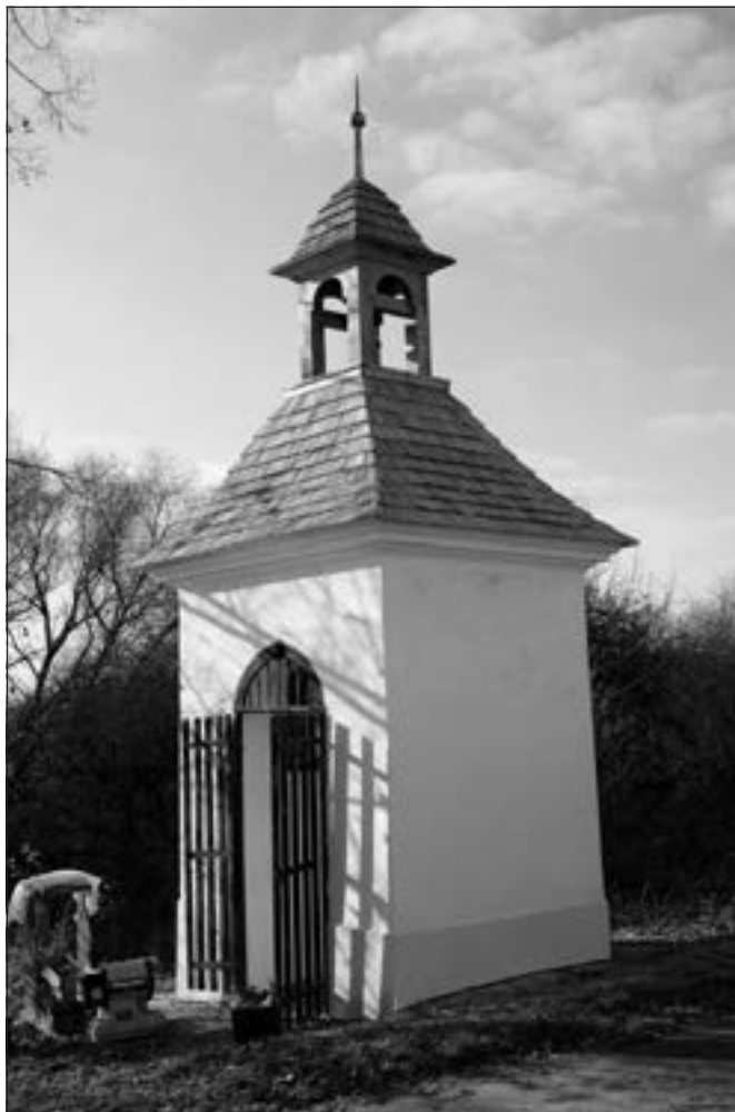
Teletín (okres Benešov), kaplička se sochou sv. Jana Nepomuckého, celková obnova. Při opravě byl kapličce navrácen původní vzhled. Byl opraven krov a střecha byla zakryta štípaným šindelem. Stávající zakrytí bobrovkami s nárožními břebenáči bylo příliš robustní a plechové zakrytí zvoničky pouze provizorní. Při opravě fasády byla objevena původní profilace římsy, která byla obnovena. Součástí akce bylo také restaurování pís-kovcové sochy v interiéru (foto D. Primusová).
