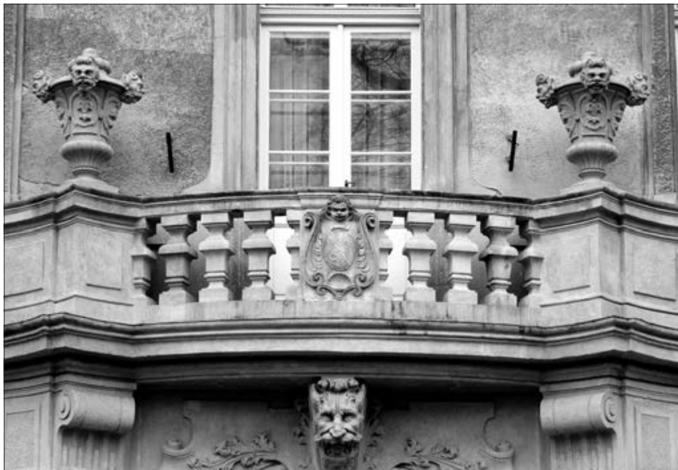
Kosmonosy (okres Mladá Boleslav), zámek, východní průčelí východního křídla, detail balkonu, stav po osazení kopií váz z pískovce z lokality Libná (foto L. Maděrová).
