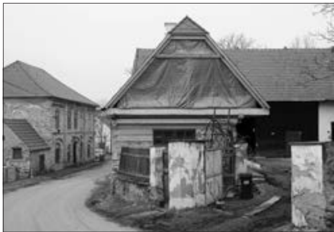
Zbyslav (okres Kutná Hora), usedlost čp. 57. Celková obnova obytného stavení představuje poměrně radikální zásah do původních konstrukcí. Čelní stěna světnice byla provedena nově, stejně tak i krov. Prkna původního štítu byla demontována k opětovnému použití (foto J. Berková).
