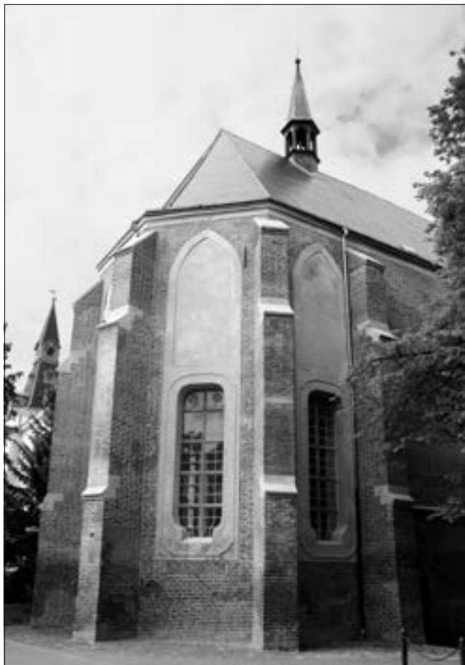
Nymburk, kostel sv. Jana Nepomuckého, pohled od severovýchodu. V roce 2012 probíhala první etapa obnovy kostela sv. Jana Nepomuckého, někdejšího gotického presbytáře konventního kostela dominikánů, zasvěceného Panně Marii. Opraven byl raně barokní krov a provedena rozsáhlá oprava cibelného zdiva včetně omítkových paspart, šambrán a dalších detailů, při respektování úpravy z 19. století. Oprava, prováděná pod dohledem restaurátora a odborného dohledu pracovníka ÚOP SČ NPU, zachovala přiměřenou živost povrchů (foto A. Burešová).
