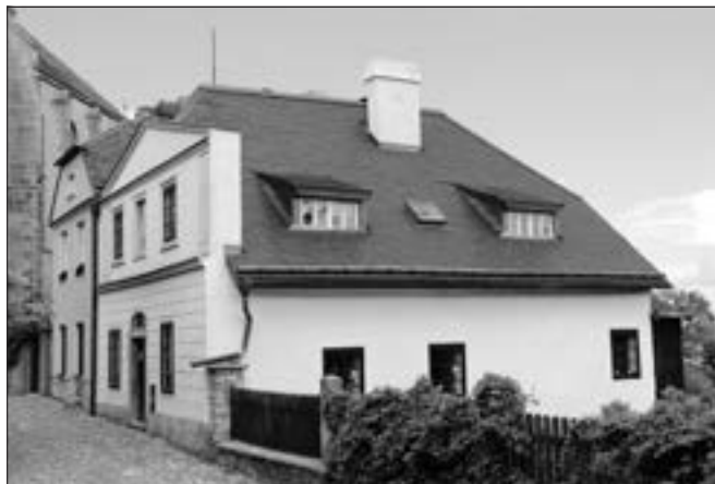
Kutná Hora, dům čp. 13. Významnou realizací v oblasti obnovy střech byla výměna břidlicové krytiny domu, exponovaného v rámci panoramatu města. Zvolena byla maloformátová šablona, uplatňující se i na bocích starších pultových vikýřů. Uplatnění drobnějšího formátu břidlice přineslo pozitivní zkušenosti, jak technického charakteru, tak bezesporu estetického výrazu (foto A. Pospíšil).
