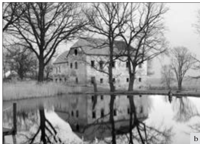
Studénka (okres Mladá Boleslav), zámek: a – zámek obsahující v jádře renesanční tvrz byl dlouhodobě v bavorském stavu bez střechy s propadlými stropy a staticky narušenými obvodovými stěnami. Objekt bezprostředně ohrožený zánikem se konečně podařilo zabezpečit; b – v letošním roce byla dokončena obnova krovů nad oběma křídly, položení definitivní krytiny by mělo být dokončeno v příštím roce (foto E. Vyletová).
