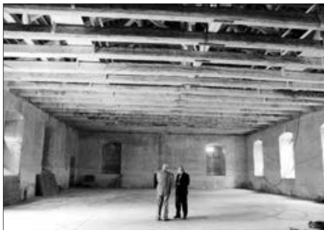
Mnichovo Hradiště zámecká konírna po obnově trémového stropu a krovů (foto V. Láška).
