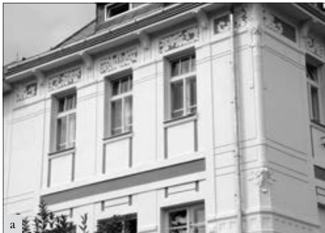
Mnichovo Hradiště (okres Mladá Boleslav), dům čp. 744: a – oprava fasády s výraznou barevností obnovenou podle původního stavu na základě výsledků průzkumu z lešení vrátila zanedbané fasádě její původní vzhled a noblesu. Tu poněkud snižuje nedostatečná kvalita štukatérských prací, kterou se nepodařilo i přes opakované korekce na místě a dobrou spolupráci s investorem u prováděcí firmy zajistit; b – detail původní štukové výzdoby s patrnou podkresbou (foto E. Vyletová).
