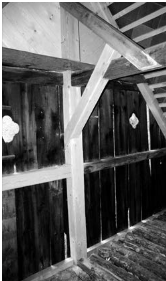
Tupadly (okres Mělník), čp. 65. Hospodářské stavení v areálu usedlosti má velmi dobře dochovaný krov s jednou vaznicí podpiranou sloupky s horními a spodními pásy, charakteristickou pro lidové stavby této oblasti. Při obnově krovu a střechy proto bylo dbáno na pečlivou tesařskou práci. Nově byly doplněny poškozené části a chybějící prvky (foto J. Berková).
