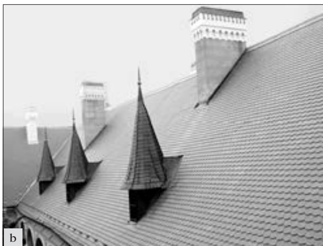
Mníchovo Hradiště (okres Mladá Boleslav), zámek: a – opravený krov jízdárny; b – pohled na opravené valby; c – pohled na celou střechu (foto J. Fialová).
