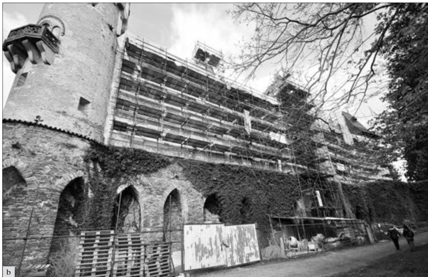
Žleby (okres Kutná Hora), zámek, v průběhu roku pokračovaly práce na rozsáblé stavební akci: a – oprava střechy; b – opravy fasád východního křídla.
