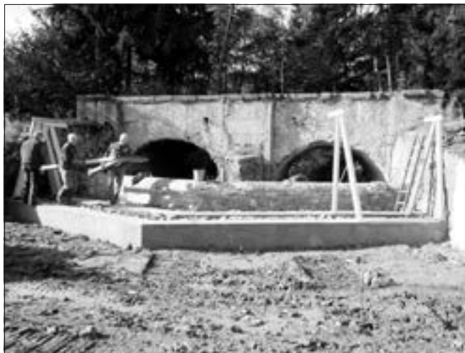
Martinice u Votic (okres Benešov), rybník Velký Mastník s barokním mostkem. Déle než celý rok probíhala oprava rybníka, jebož součástí je kamenný barokní most sloužící také jako rybníční výpust. Přestože vlastní zdivo mostu bylo v průběhu obnovy rybníka opraveno a zajištěno, nové konstrukce vystavěné podle moderních vodoprávních požadavků v těsném sousedství mostku narušily estetickou kvalitu dosud malebného prostředí (foto J. Svobodová).
