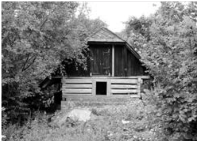
Bobuliby (okres Praha-západ), čp. 10. Obnovené roubené stěny světnice (foto M. Hanzlíková).
