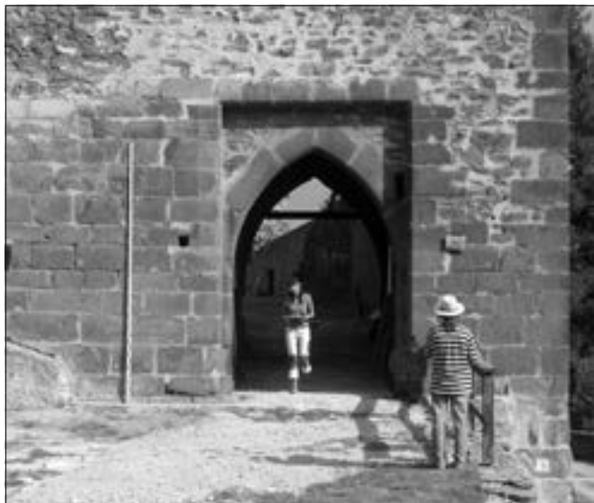
Hrad Lipnice nad Sázavou (okres Havlíčkův Brod), letní dílna OPD zaměřená na měřickou dokumentaci (foto J. Veselý).
