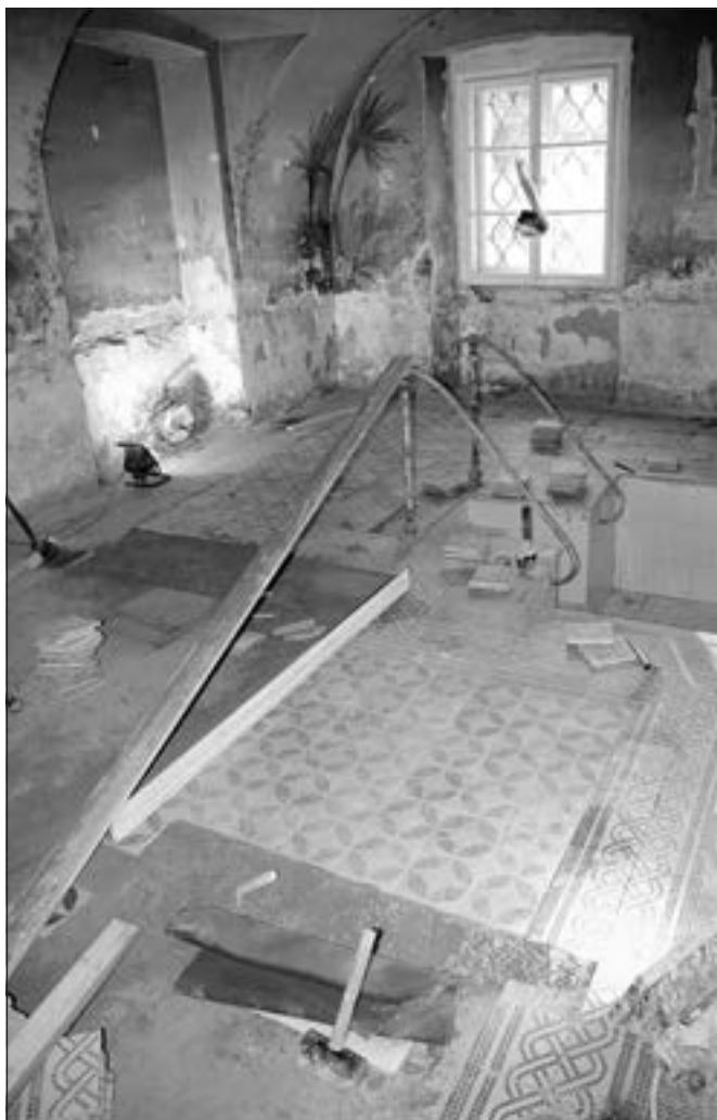
Hořovice, zámek, opravy dlažby v tzv. Egyptské koupelně.
