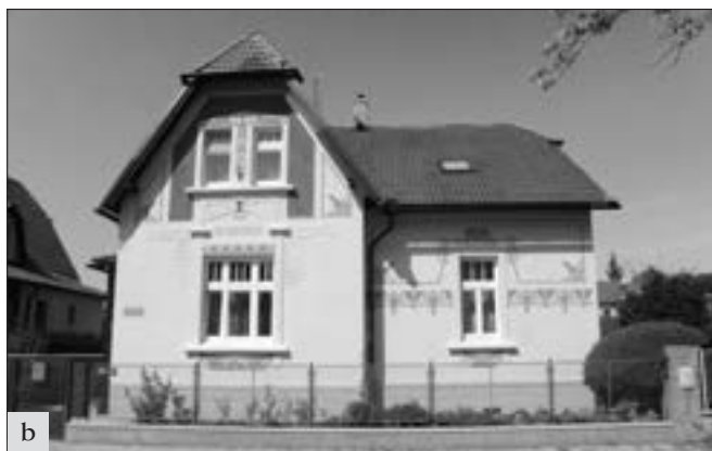
Poděbrady (okres Nymburk), dům čp. 228. Jeden z mnoha secesních domů, stojících v centru Poděbrad – v městské památkové zóně, který není nemovitou kulturní památkou. Fasády řady domů z tohoto období zdobil rytý, tak jako u tohoto domu často výrazně polychromovaný ornament. Stav ornamentu před opravou zachycuje první obrázek. V žádosti o vydání závazného stanoviska bylo navrhováno zateplení fasád domu. Po jednáních bylo nalezeno kompromisní řešení, kdy zateplovací systém byl uplatněn pouze na zadní a bočních fasádách. Přes počáteční výbrady vzala nakonec majitelka obnovu výzdoby průčelí za své a sama se na ní aktivně podílela. Výsledek zachycuje celkový pohled na průčelí. Zřejmě jen bedlivému pozorovateli neunikne nevýrazné odsazení výzdoby od nároží, dané tloušťkou zateplovací vrstvy (foto A. Burešová, J. Žižka).
