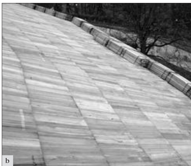
Březnice (okres Příbram), zámek: a, b – obnova šindelů (všechny snímky z památkových objektů jsou z archivu NPÚ ÚOP SČ, není-li uvedeno jinak).
