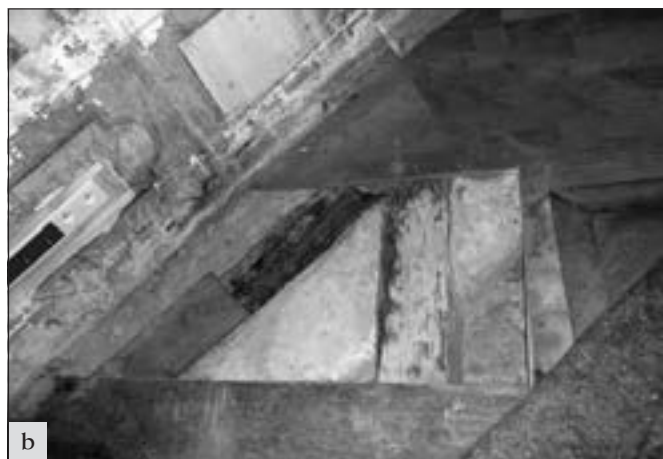
Veltrusy, zámek: a, b – ukázka podlahy po sejmutí nášlapné vrstvy v přízemí hlavní budovy (foto V. Komárek).
