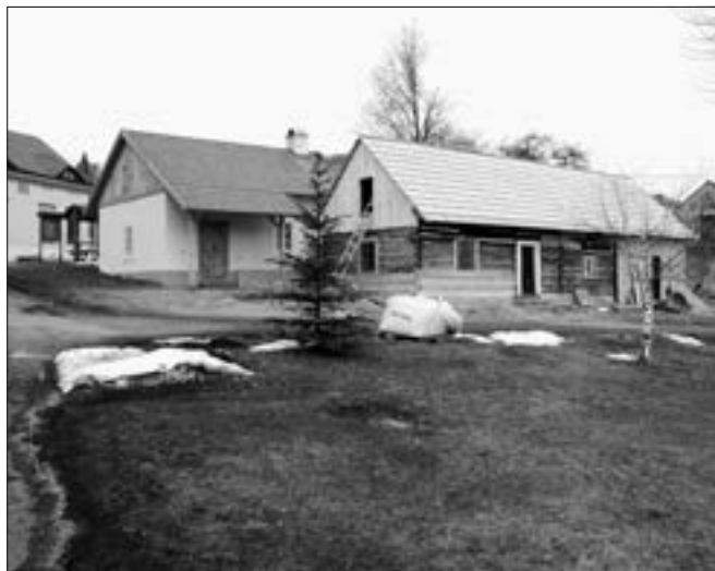
Vinařice (okres Beroun), roubený dům čp. 8 a sousední objekt kovárny tvoří historicky jeden celek. Jsou situovány v návesním prostoru, který podstatnou měrou dotvářejí. V rámci obnovy domu, která byla zahájena péčí obce jako vlastníka, byly nabazeny dožilé prvky roubeného pláště i krovu a obnovena krytina ze štípaného šindele (foto J. Berková).
