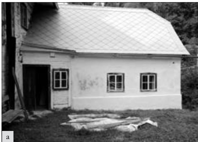
Vicmanov (okres Mladá Boleslav), Blazkův mlýn. Unikátně dochovaný celoroubený mlýn prochází postupnou obnovou. Po dokončení vnějších bliněných omítek na tzv. šalandě – a (srov. ročenka 2011, s. 51), pokračovaly práce na obnově roubených stěn hlavní budovy – b (foto J. Berková).
