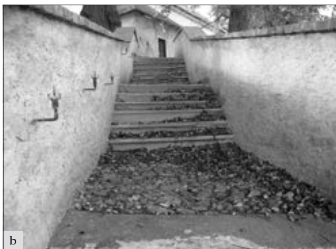
Malíkovice (okres Kladno), přístupové schodiště ke kostelu bylo v havarijním stavu (rozvolněné kamenné stupně, rozpadlé parapetní zdi). Schodiště prošlo celkovou obnovou, avšak citlivě, bez ztráty původního malebného charakteru. Stupně byly napevno usazeny, v chybějících partiích doplněny, parapetní zdi byly dozděny z původního a dalšího sborného kamenného materiálu, koruna byla obnovena z cibulí (foto E. Mikešová).
