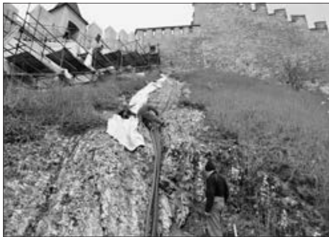
Karlštejn, hrad, elektrifikace Mariánské věže včetně vnitřních rozvodů silnoproudů a přípravy pro slaboproudy v prostorách Mariánské věže.
