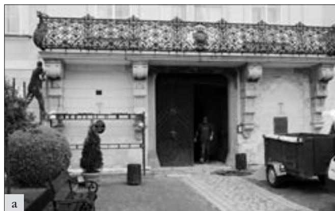
Hořovice, zámek: a – oprava fasády při hlavním vstupu; b – stav po dokončení obnovy.
