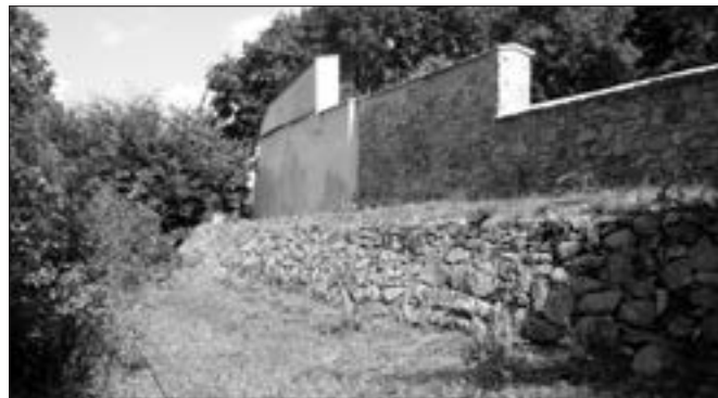
Vrchotovy Janovice (okres Benešov). V roce 2012 byly obnovovány zdi tzv. nového skleníku, který stál na místě zámeckého parku od roku 1886 do 50. let 20. století (foto R. Bočková).
