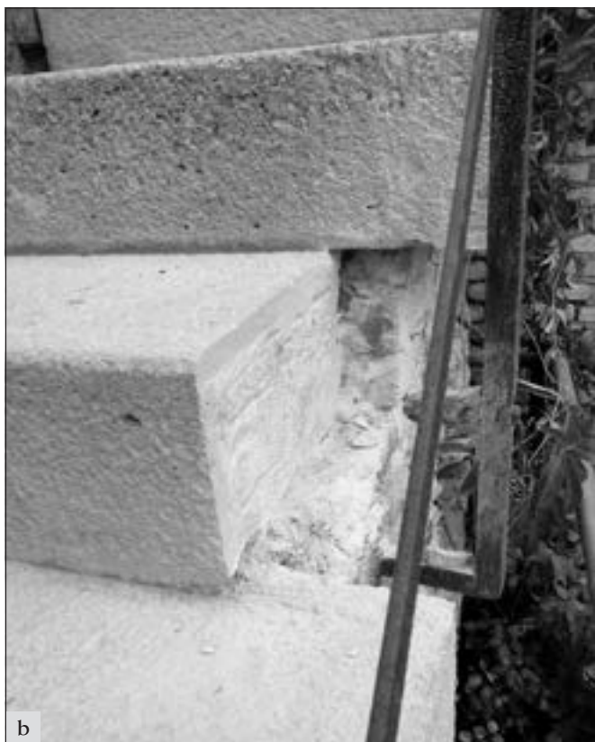
Karlštejn, brad: a, b – detaily opravy schodiště přileblého k bradební zdi (foto V. Komárek).
