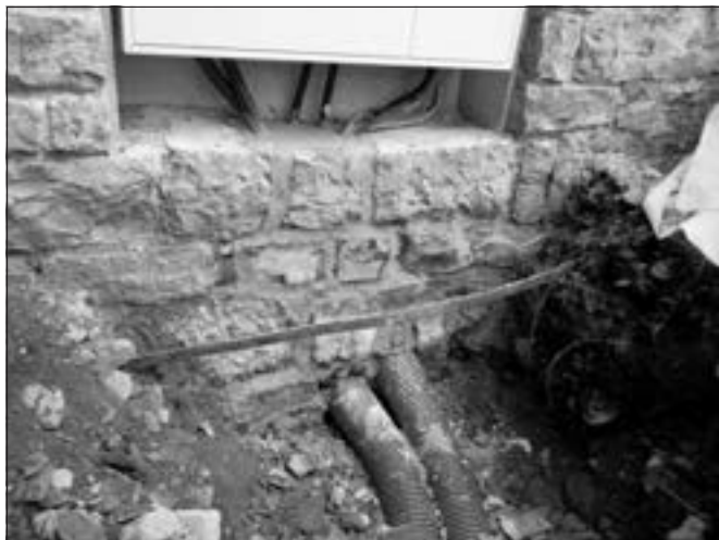
Karlštejn, brad, kabelovod (foto V. Komárek).
