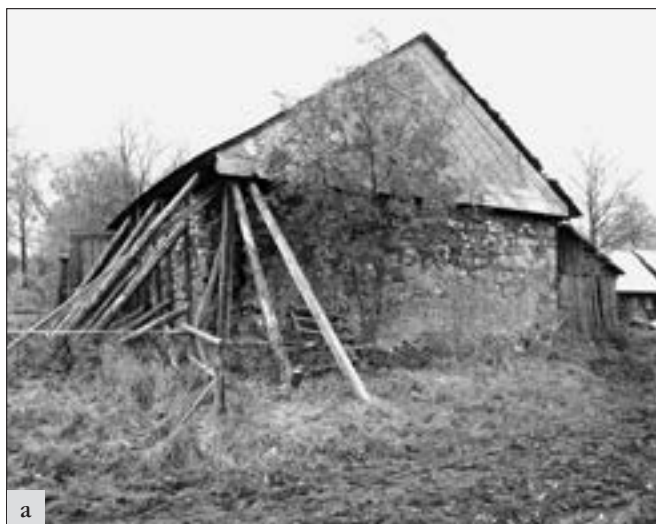
Vinařice (okres Beroun), roubený dům čp. 8 a sousední objekt kovárny tvoří historicky jeden celek. Jsou situovány v návesním prostoru, který podstatnou měrou dotvářejí. V rámci obnovy domu, která byla zahájena péčí obce jako vlastníka, byly nabazeny dožilé prvky roubeného pláště i krovu a obnovena krytina ze štípaného šindele (foto J. Berková).
