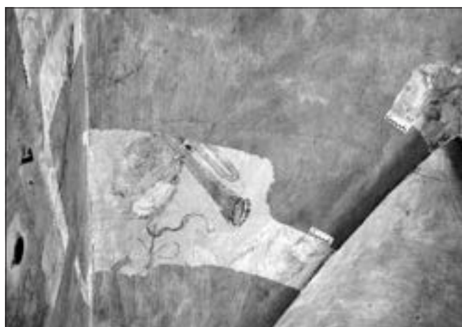
Králův Dvůr (okres Beroun), přízemí jižního křídla zámku, odkryté části renesanční výmalby, kolem 1586. Předpokládaný rozsah dochování renesanční výmalby v jižním křídle zámku byl částečně prokázán sondážním průzkumem. Odkryté detaily mají na rozdíl od dříve restaurovaných maleb zářivou barevnost, v níž převládají zlatavé okry (foto M. Pařízek).
