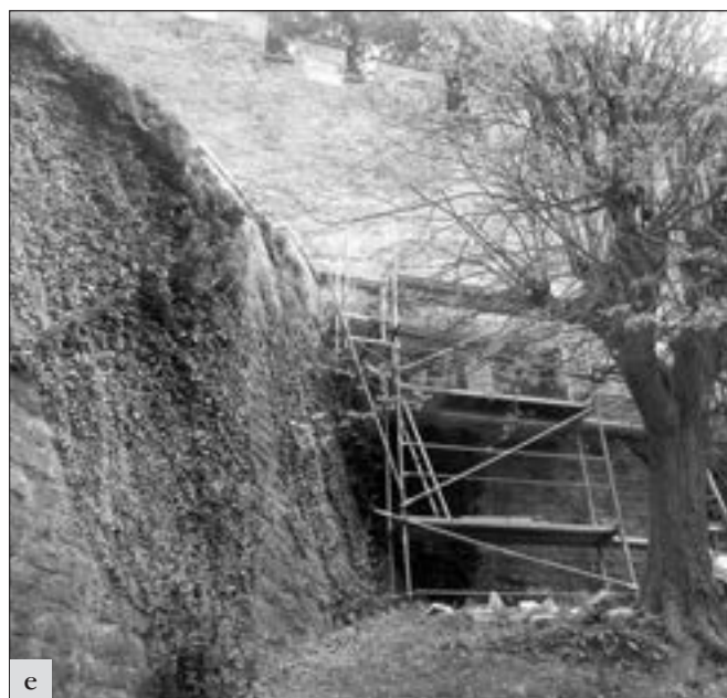
Karlštejn, brad, svahy za vstupní branou: a-d – finální úprava povrchu opěrné zdi a skalního vstupu za vstupní branou; e – pohled na opravu opěrné zdi svahů za vstupní branou (foto V. Komárek).
