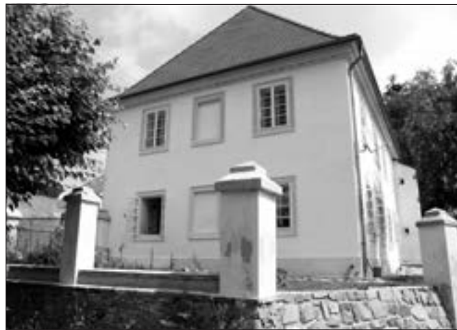
Drabenice (okres Příbram), čp. 56. Ačkoli budova tzv. Staré školy není kulturní památkou, vykazuje všechny její znaky a současně velmi pozitivně dotváří celkový charakter návsi. Obnova fasády má proto velký význam pro celé jádro této mimořádně hodnotné vesnické památkové rezervace (foto M. Hanzlíková).
