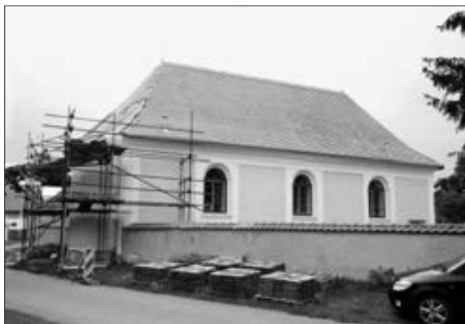
Velenice (okres Nymburk) toleranční kostel, pohled v závěru I. etapy obnovy. Na základě průzkumu omítek byla obnovena vrstva s hrubě bozenou plochou, odpovídající době výstavby. Požadované struktury hrubě bozené plochy se podařilo docílit až po řadě zkoušek, a to zejména díky citu a schopnostem pracovníků zhotovitele i náročnosti odborného památkového dohledu. Po opravě krovu, při které bylo řešeno zachování a alespoň konzervace zdobeného záklopu stropu z původní výstavby, byla dobře položena krytina z pálených tašek bobrovek (foto J. Žižka).
