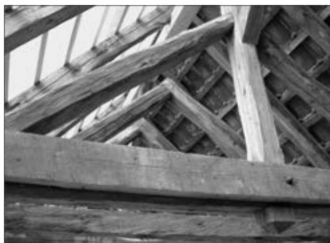
Černovičky (okres Praha-západ), kostel sv. Vavřince, pobled do krovu nad blavní lodí kostela. Podkrovní prostor zde ukrývá zajímavou konstrukci staršího a nového krovu, vzniklou při historizující obnově kostela na začátku 20. století, za účasti architekta Kamila Hilberta. Nový krov sedlové střechy s výše umístěným břebenem do sebe ze staršího krovu pojal plné vazby, přičemž krokve jalových vazeb staršího krovu byly ponechány volně v prostoru. Celý krov byl v letošním roce obleduplně opraven systémem protézování (foto E. Zápalková).
