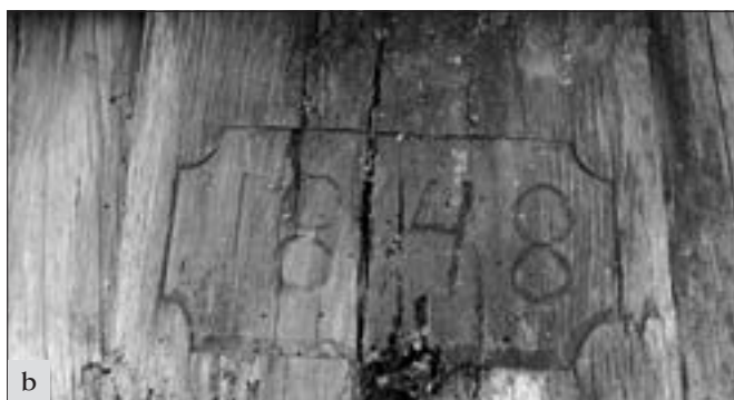
Olešno (okres Mělník), VPR. Sloupková dřevěná zvonička stojící na návsi měla u paty sloupku dataci, která byla po léta skrytá pod ocelovou příložkou. Při tesařské opravě musela být tato napačená část sloupku odstraněna, proto byla vlastní kartuše s datací vyříznuta, poškozený povrch zpevněn a poté byla vsazena do nově nastavené části sloupku, aby zůstalo původní vročení 1848 zachováno pro budoucí generace (foto J. Berková).
