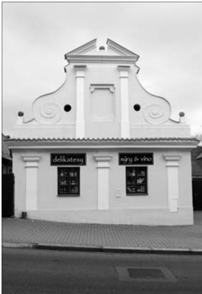
Říčany (okres Praha-východ), dům čp. 26. Pobled na rekonstruované západní uliční průčelí domu. Dům je situován do historického jádra města, do Široké ulice. Je posledním dochovaným barokním domem tohoto typu v Říčanech, jeho historický význam je nezastupitelný. Dům vytváří prostředí této části města, jeho uliční průčelí je bohatě architektonicky členěno. Při obnově průčelí byly obnoveny architektonické články a omítky včetně vrchního barevného nátěru. Obnova západního průčelí domu čp. 26 v Říčanech je významným přínosem pro udržení historického prostředí jádra města (foto P. Kroupa).
