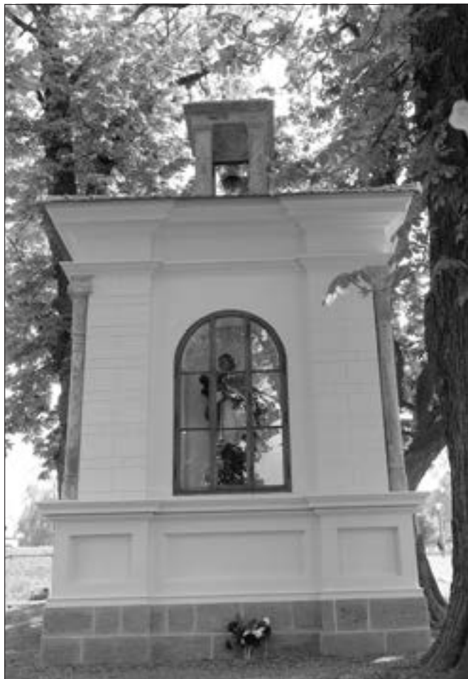
Honice (okres Kladno), návesní kaple sv. Jana Nepomuckého, opravená kaple od severovýchodu. V průběhu oprav byla věnována zvláštní pozornost rehabilitaci původní náročné architektonické výbavy stavby, zejména římsovým profilům a článkům. Podařilo se tak napravit zkomolenou podobu, která byla výsledkem několika neodborně provedených oprav v minulých desetiletích (foto E. Volfová).
