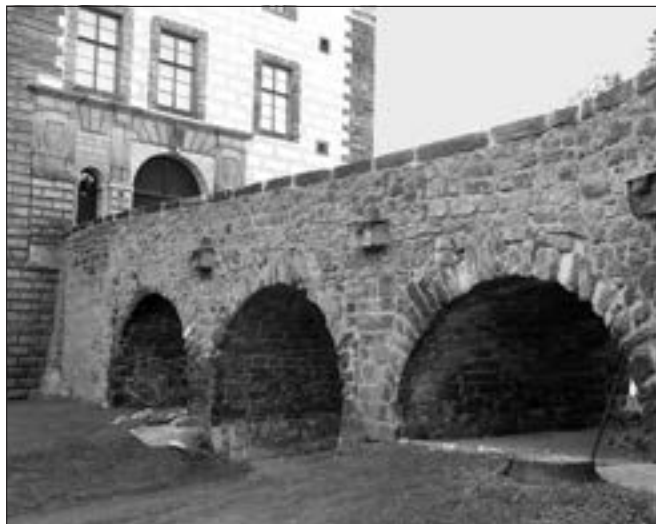
Nelabozevs (okres Mělník), most do zámku. Náročná a rozsáhlá oprava mostu, respektující dochovanou podobu povrchů si vyžádala rozdělení do dvou stavebních etap. V roce 2012 byla opravena mostovka, zábradlí a položena dlažba. Zásadní bylo vyřešení odtoku vody z povrchu a izolace mostovky. Obnovení původní tradiční úpravy izolace mostu se však ukázalo jako málo účinné a budou nutné další úpravy (foto A. Burešová).
