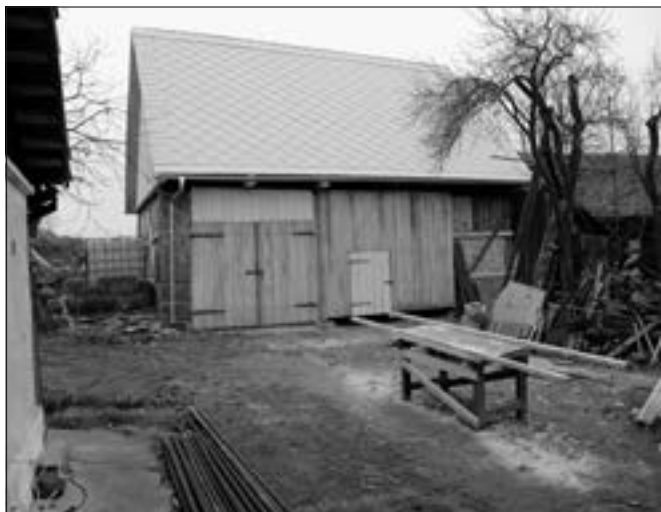
Nové Osinalice (okres Mělník), čp. 7. Oprava krovu a položení nové krytiny zakončily celkovou obnovu této mimořádně hodnotné hrázdné stodoly, poslední na území této památkové rezervace (foto J. Berková).
