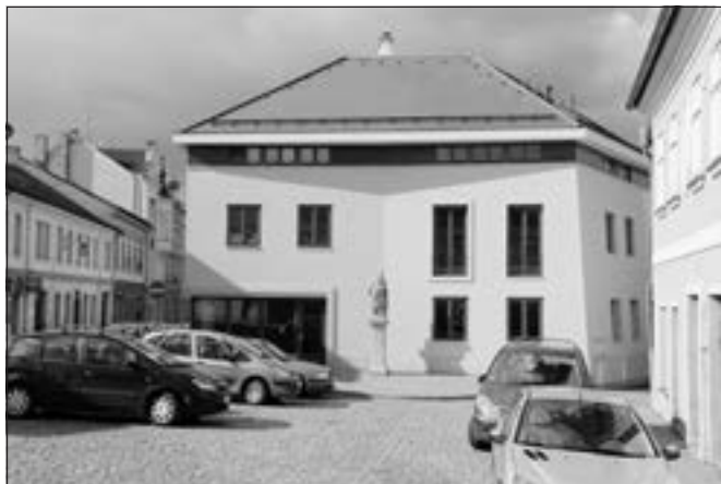
Kutná Hora, Anenské náměstí. Po kolaudaci byla uvedena do provozu novostavba na místě proluky vzniklé zbořením gotického domu se srubovým patrem v roce 1981. V půdorysném založení hlavní fasády nebo šikmou stěnou do boční ulice novostavba parafrázuje charakteristické prvky zaniklého domu na této parcele. Ústřední místo před domem znovu po padesáti letech zaujala restaurovaná socha sv. Anny (foto A. Pospíšil).
