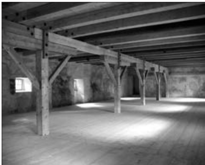
Lobeč (okres Mělník) bývalý pivovar. Součástí rozsáhlé obnovy hlavní budovy v roce 2012 byla také rekonstrukce zaniklých nosných prvků v prostoru sýpky, tzv. valeček a ječných púd nad sladovnou. Původní vazné trámy a průvlaky, které je podíraly, byly na konci minulého století, kdy byl nezabezpečený objekt ponechán volné devastaci, vyřezány a odvezeny. Nově provedené tesařské prvky vrátily tomuto prostoru původní charakter i nemalou estetickou hodnotu (foto J. Berková).
