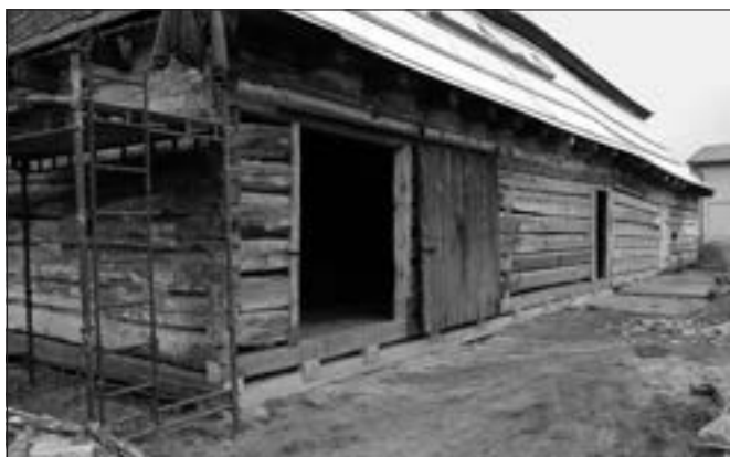
Bělá pod Bezdězem, (okres Mladá Boleslav), Panin dvůr. Poměrně zásadní etapa obnovy této unikátně dochované roubené panské sýpky z roku 1680 zahrnovala výměnu uhnílych prvků roznášecího roštu a patních trámů. Snímek dokumentuje rozsah výměn v době před položením eternitové krytiny (foto J. Berková).
