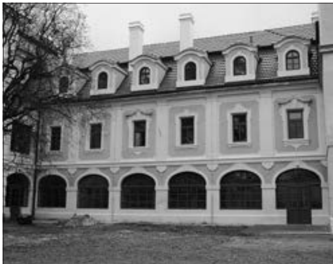
Vidim (okres Mělník), východní průčelí středního křídla zámku po dokončení opravy fasády (foto J. Berková).
