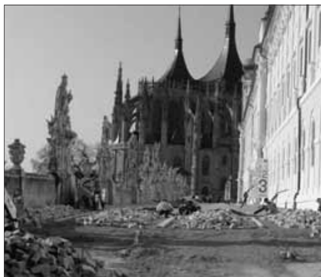
Kutná Hora, Barborská ulice. V roce 2011 byla dokončena výjimečná akce, a to rekonstrukce komunikací historického jádra města, která nemá v celorepublikovém měřítku srovnání: za dva a půl roku bylo zrekonstruováno 20 ulic, 4 náměstí a jeden park. Některé ulice změnilý svůj charakter, například zrušením chodníků, čímž byla obnovena jejich starší podoba. Příkladem může být velice významný prostor, tzv. most s galerií barokních soch podél jezuitské koleje (foto A. Pospíšil).
