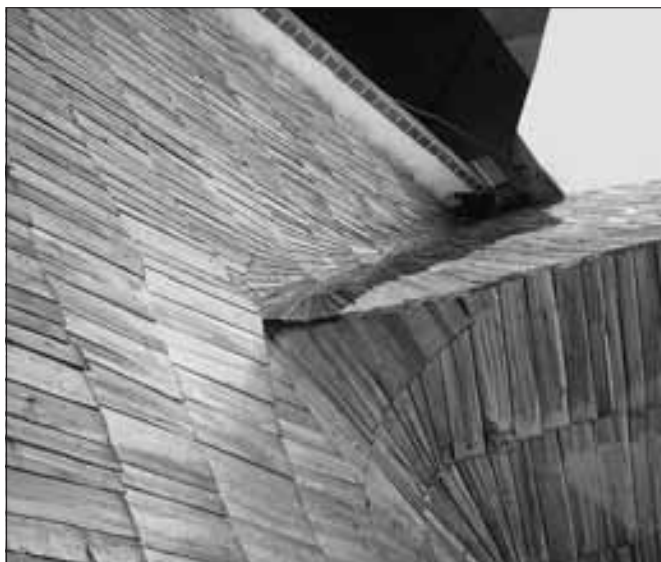
Počepice (okres Příbram), kostel sv. Jana Křtitele, detail šindelové krytiny, během další etapy dlouhodobé postupné opravy kostela (foto H. Řepková).
