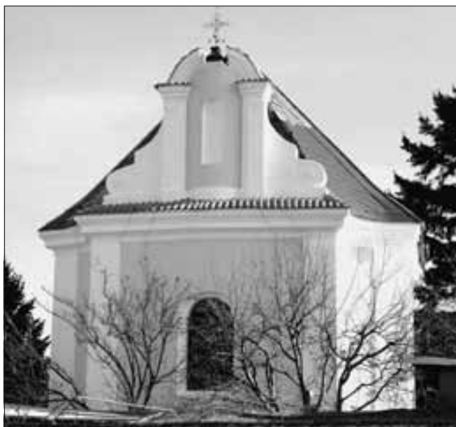
Kostelec nad Černými lesy (okres Praha-východ), kostel sv. Jana Křtitele, západní průčelí. V roce 2011 bylo obnoveno mimo jiné toto západní průčelí, jebož stav byl silně bavarijní (foto P. Kroupa).
