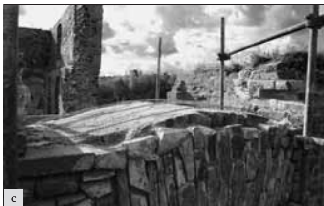
Krakovec, brad, odstranění bavárie utrženého nadpraží okna nad vstupní bránou: a – stav před opravou; b, c, d – průběh prací; e – stav po opravě (foto J. Sobek).
