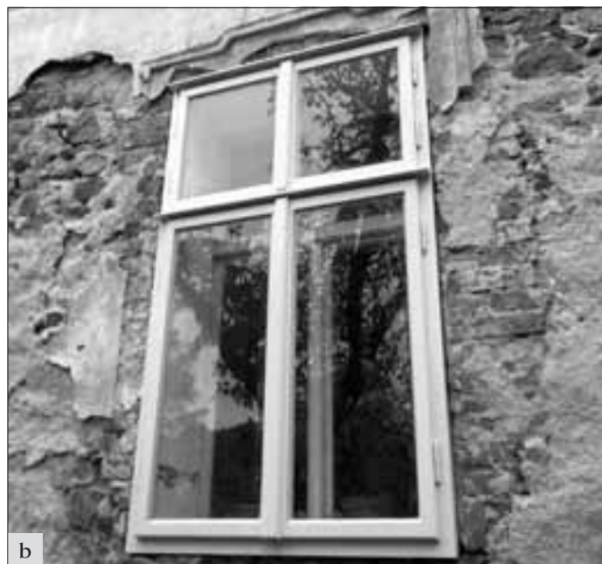
Sázava (okres Benešov), klášter: a – pohled na prelaturu; b – osazení repliky okna v budově prelatury (foto V. Komárek).
