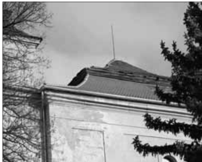
Týnec (okres Mladá Boleslav), kostel sv. Anny, pobled na část mansardové střechy. V roce 2011 se podařilo zabývat opravu výrazně narušené střechy jedné z nejobroženějších církevních památek ve správním obvodu Mladá Boleslav. Byly úspěšně provedeny tesařské opravy krovu v jihozápadním nároží kostela, včetně laťování a položení krytiny z bobrovek (foto D. Linhartová).
