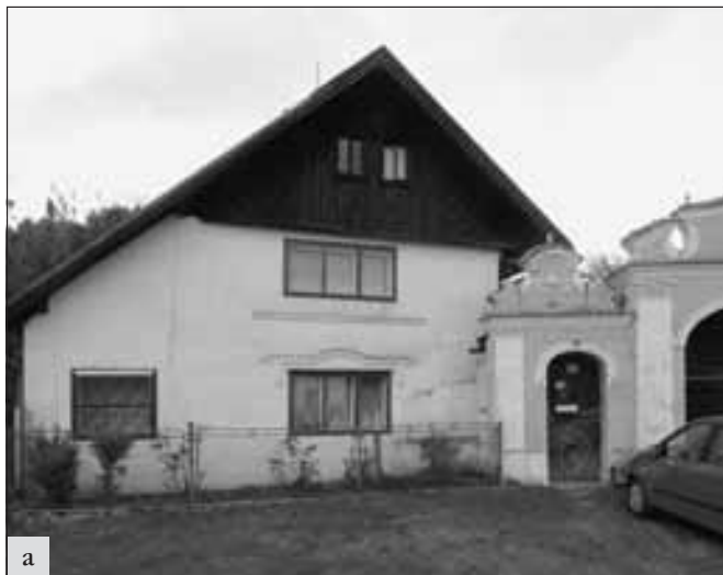
Víska (okres Mladá Boleslav). Usedlost čp. 5 ve Vísce se díky svému umístění na návsi a bonosné vstupní bráně velmi výrazně podílí na utváření charakteru VPR: a – štítové průčelí vlastního domu usedlosti však bylo několik desetiletí narušeno drubotnými širokými okenními otvory, které degradovaly podobu této hodnotné památky; b – v roce 2011 se uskutečnila obnova původního řešení průčelí s dvojicemi oken v obou podlažích, které znamenají jeho rehabilitaci a kladně ovlivňují charakter celé návsi. Obnova fasády bude dokončena v následujícím roce (foto J. Svobodová, srov. obr. na s. 138).
