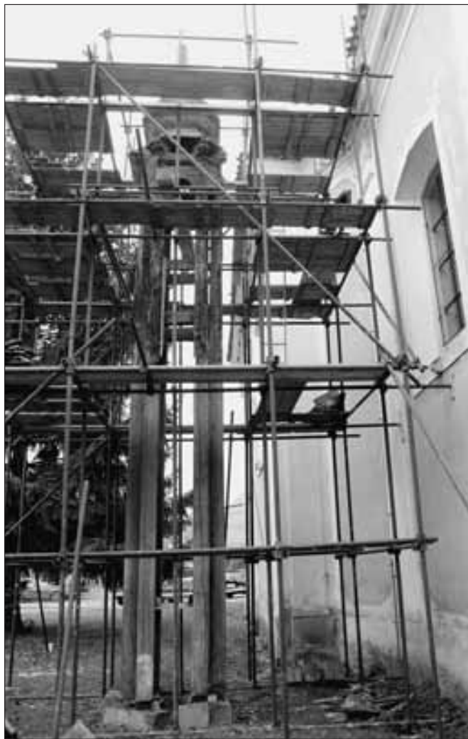
Bratronice (okres Kladno), kostel Věch svatých, jeřábem snesená konstrukce sanktusové věžičky byla po dobu oprav provizorně postavena do lešení. Zde po odstrojení bednění parapetů lucerny, na počátku opravy (foto E. Volfová).
