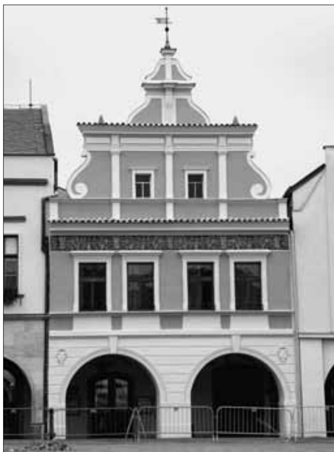
Mělník, průčelí domu čp. 3 po obnově. Dům čp. 3 je součástí severovýchodní zástavby hlavního mělnického náměstí Míru, nachází se vpravo od budovy mělnické radnice. Štítové orientovaný dům s podloubím je v jádru gotického původu (stěny, sklep) s renesančními úpravami (klenby, podloubí). Další barokní úpravy proběhly v interiéru. Vnější podoba štítu je ve stylu neorenesance. Dům prodělal v 2. polovině 20. století opravu, při níž byl značně zjednodušen tvar štítu. Ještě v roce 1935 měl štít sgrafitovou neorenesanční výzdobu nejen v prostoru pásu nad okny, ale v prostoru celého štítu i mezi okny (figurální sgrafita). Během opravy fasády se podařilo navrátit štítu původní tvar a zakonzervovat zbytky figurálních sgrafit mezi okny a restaurátorsky obnovit sgrafitový pás nad okny (foto A. Burešová).
