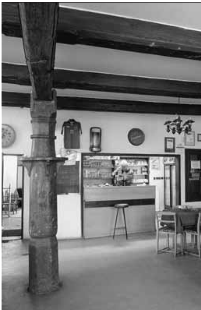
Kněžves u Rakovníka (okres Rakovník), hostinec čp. 102. Atraktivní soustružený sloup, podpírající průvlak trámového stropu, v sále hostince zaujal již na počátku 20. století autory soupisu památek historických a uměleckých. Dodnes spoluvytváří neopakovatelnou atmosféru stavby (foto J. Veselý, 2011).
