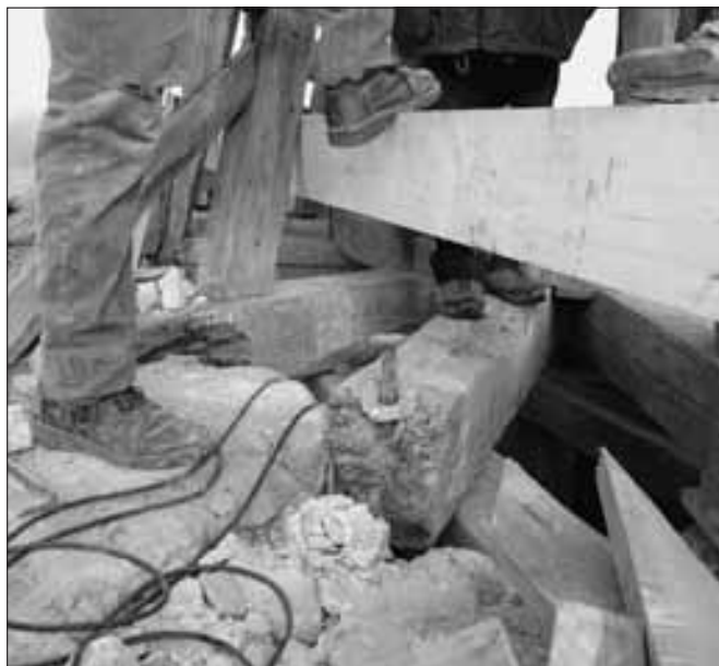
Slatina (okres Kladno), zvonice při kostele sv. Vojtěcha, oprava zvonice představovala mimořádně náročný úkol. Střecha s rozložitou bání byla před opravou v horní části vykloněná o 20° z vertikální osy. Protézovala se ubítlá zhlaví, ale musely se podvlékat i celé nové prahové trámy, což představovalo ve stísněném prostoru náročný úkol (foto E. Volfová).
