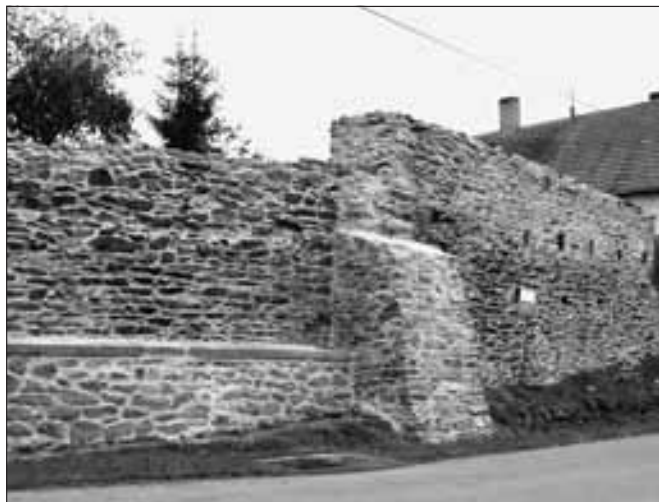
Louňovice pod Bláníkem (okres Benešov), fragment zdiva kláštera premonstrátek, obnova. V roce 2011 byla za přispění Krajského úřadu dokončena obnova gotického zdiva, které bylo v bavijském stavu – na mnoha místech se začal uvolňovat jeho líc a koruna zdiva se rozpadala. Zeď byla podle návrhu statika posílena opěrným pilířem. Narušená místa byla citlivě doplněna a koruna zdi osázena suchomilnými rostlinami (foto D. Primusová).
