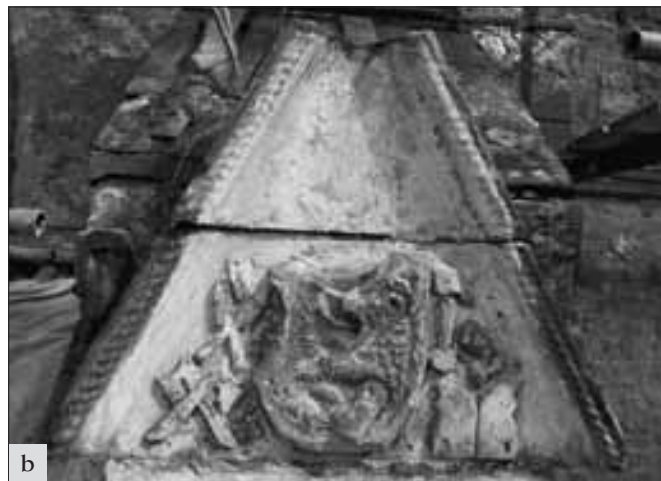
Kostelec nad Labem (okres Mělník), příležitost k poznání historie památky bývají zejména opravy fasád, při nichž dochází k odkrytí historických omítek a často i zdíva. Oprava kostela sv. Víta se v roce 2011 omezila na západní průčelí, průzkum však přesto přinesl řadu zajímavých výsledků. Kostel sv. Víta je stavbou se složitou historií, k níž zpracovaný stavebněhistorický průzkum nedokázal zaujmout jednoznačné stanovisko: a, b – Velice cenným svědectvím jsou v tomto případě znakové a nápisové desky, často datované, jako městský znak s letopočtem 1492 na průčelí závěru, resp. snadno časově zařaditelné (desky s erbem Sekerků ze Sedčic, kteří město zástavně drželi v letech 1482–1497). Na druhé straně právě tyto desky klamou, neboť jádro kostela je starší. Podle stavebně historického průzkumu může mít starší základ především střední loď. Zpracovaný operativní průzkum to podle průběhu trhlin a zazděných okenních ostění potvrdil a nevyhloučil přítom, že k tomuto jádru náleží i část zdíva severní lodi (foto K. Kibic, úkol č. 21 301).
