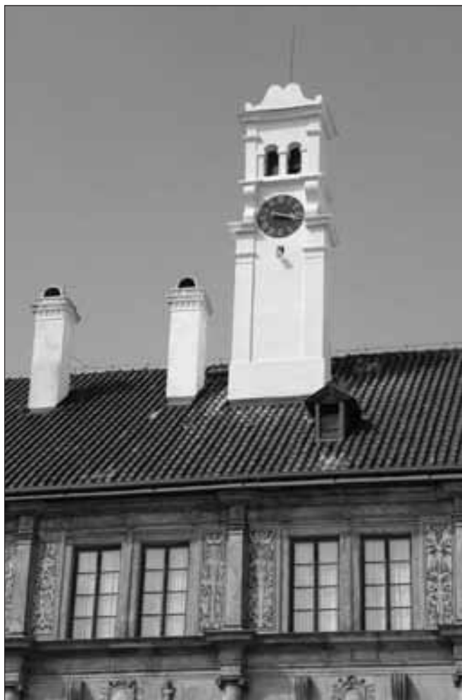
Nelabozeves (okres Mělník), zámek, bodinová věžička po opravě. Opravu bodinové věžičky na zámku v Nelabozevsi provázely zpočátku problémy s kvalitním vytažením všech profilací, ale ve výsledku lze tuto opravu hodnotit jako zdařilou, včetně vhodného výběru vápenného nátěru a kvalitního provedení oplechování olovem (foto A. Burešová).
