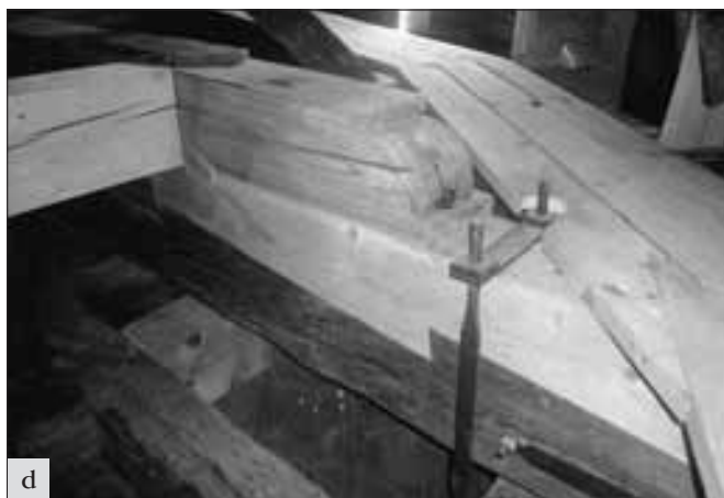
Veltrusy, zámek, hlavní budova: a – lešeňová věž pro opravu krovu a stropních trámů kopule; b–d tesařské práce v kopuli (foto V. Komárek).
