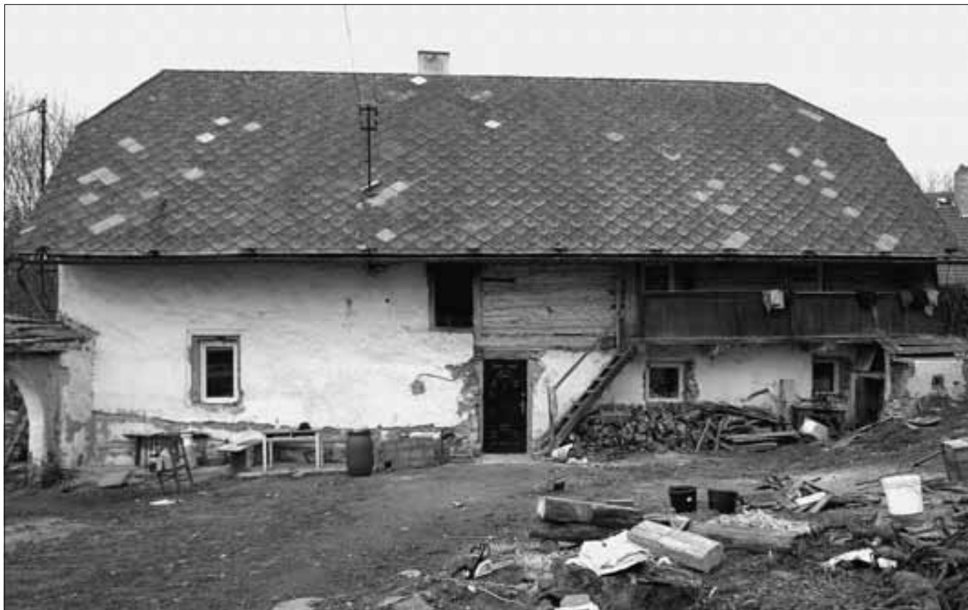
Zderadice (okres Benešov), zemědělská usedlost čp. 4. Obytné stavení usedlosti po léta budilo svým archaickým uspořádáním pozornost znalců venkovské architektury. Teprve změna vlastníka však umožnila provedení alespoň základní prohlídky stavby a odběr vzorků pro dendrochronologickou analýzu. Ta přinesla dataci dřevěné srubové části do poloviny 16. století (foto J. Kypta, 2011).
