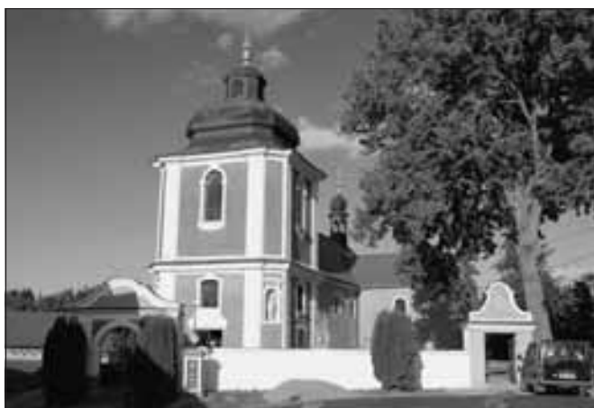
Hrádek (okres Benešov), kostel sv. Matouše, oprava fasád. S pomocí dotace ORP byla v roce 2011 dokončena oprava vnějších omítek na lodi a presbytáři (foto D. Primusová).
