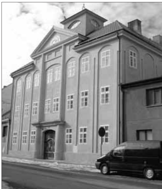
Březnice (okres Příbram), oprava fasády čp. 48. Původní klasicistní fasáda budovy postavené v roce 1825, ve stejném půdorysu se objevuje na mapě stabilního katastru z roku 1830, jako budova pošty – odtud název Na staré poště. V současné době je využívána k bytovým účelům. Fasáda, později zjednodušená, zachovává původní vysoký řád, úprava pravděpodobně pochází z 30. let 20. století a lze ji považovat za poslední dochovanou celistvou úpravu. Z této skutečnosti vycházel i návrh na opravu fasád. Z původního členění zůstal schematicky naznačený vysoký řád, odlišný ve struktuře omítky od základní plochy a celé stavbě dominuje věž (foto E. Kosová).
