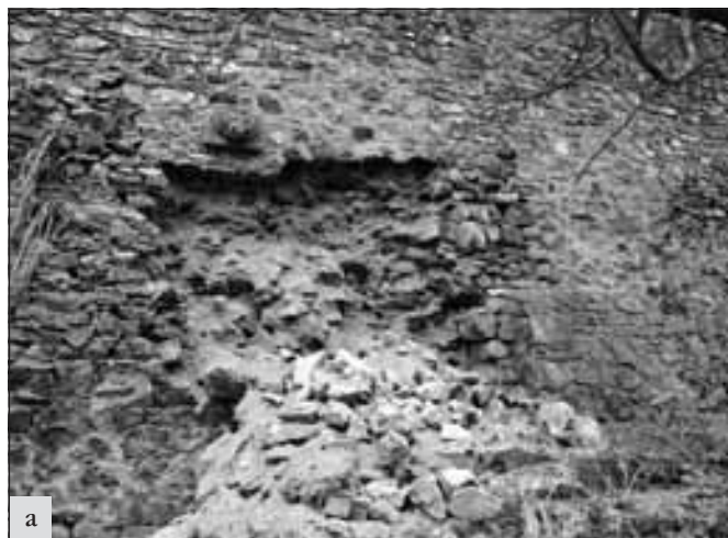
Krakovec, brad: a – havárie východní obvodové stěny; b – stav po opravě (foto J. Sobek).
