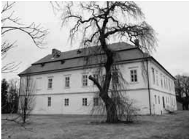
Liteň (okres Beroun), zámek. Na zámku v Litni probíhá oprava střech hlavní budovy, v roce 2011 bylo provedeno zajištění dvorní části, v roce 2012 bude oprava pokračovat za přispění Havarijního fondu MK ČR (foto E. Kosová).
