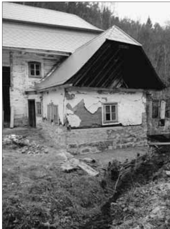
Vicmanov (okres Mladá Boleslav). Roubený mlýn v údolí pod obcí Vicmanov – tzv. Blažkův je výjimečně autenticky dochovanou stavbou, jejíž postupná celková obnova pokračuje už několikátou etapou. Po obnově krovu a střech obou částí mlýna se v roce 2011 uskutečnila obnova roubení šalandy, jejíž součástí byla i izolace podezdívky jílovou vrstvou nabíjenou do batového rámu. Na rok 2012 je plánováno pokračování obnovy – výměna roubení obytné části a celková výměna oken (foto J. Svobodová).
