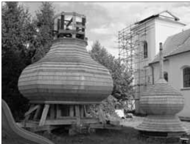
Kamberk (okres Benešov), kostel sv. Martina, oprava střechy na věži. Krovová konstrukce bane byla na zemi nově postavena za použití původních prvků a částečně zakryta šindelem. Po té byla vyzvednuta jeřábem na věž, kde byla pokládka šindelové krytiny dokončena (foto D. Primusová).
