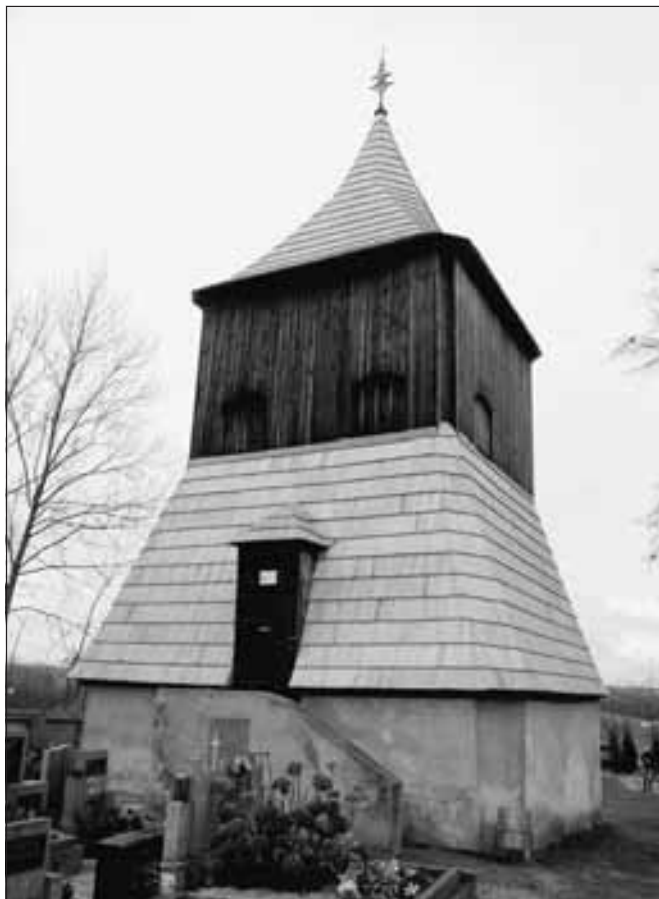
Tuřany (okres Kladno), zvonice při kostele Nanebevzetí Panny Marie. Roku 2011 došlo k opravě krovu a krytiny, s částečnou výměnou. Velmi kvalitně provedené práce spočívaly v lokální výměně krovových prvků a v položení šindele na mnohých chybějících místech (foto E. Spárová).
