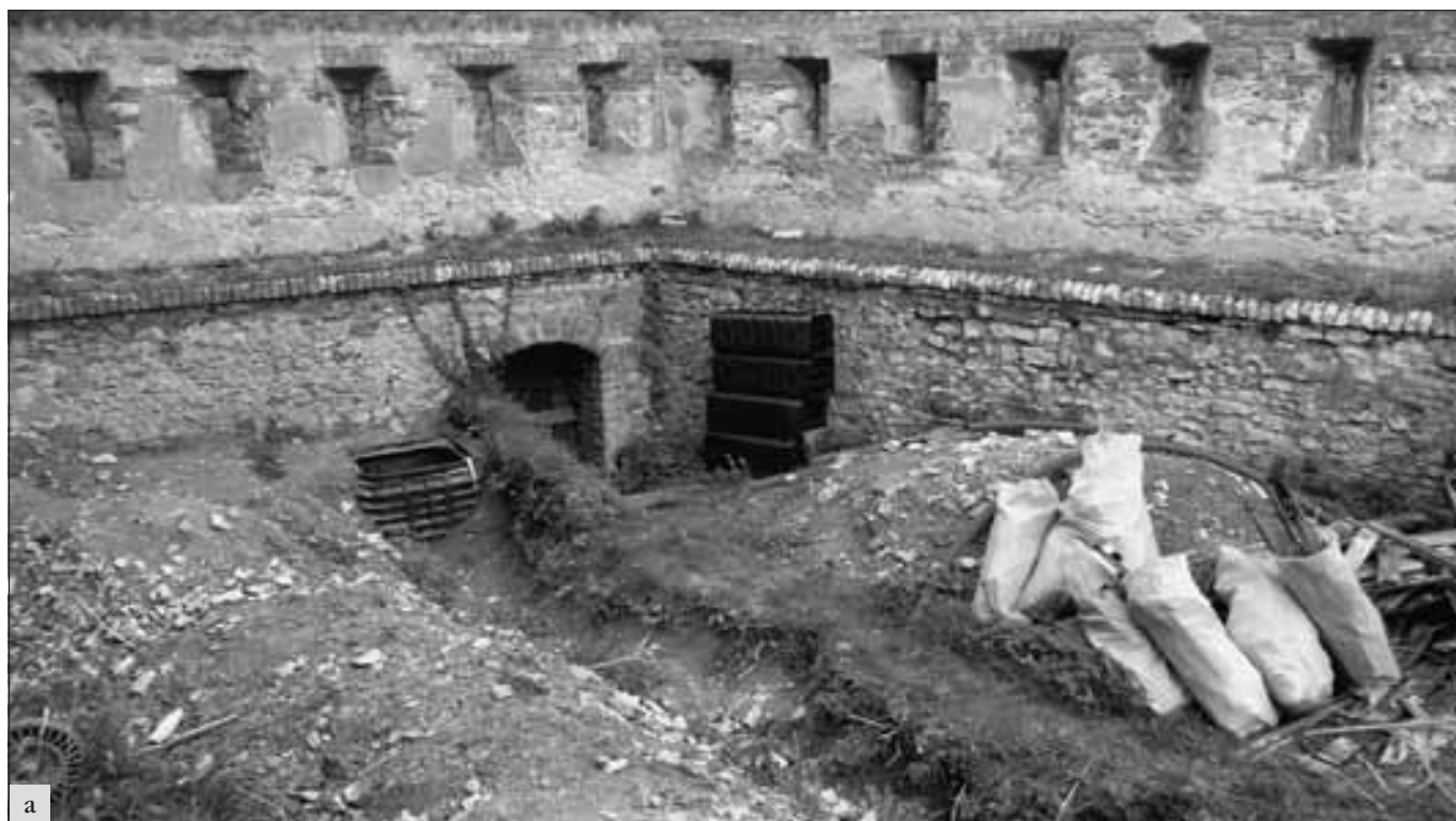
Karlštejn (okres Beroun), brad: a – výkopy pro kabelovod a kabelová komora na tzv. Hřbitůvku; b – trasa uložení chráničků kabelovodu v severním svahu (foto V. Komárek).
