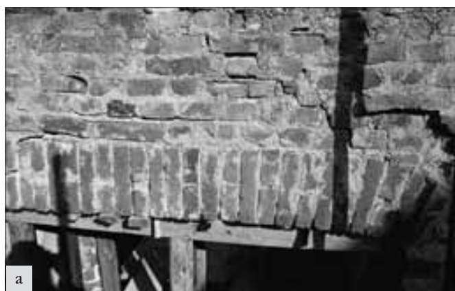
Krakovec, brad: a – havárie východní obvodové stěny; b – stav po opravě (foto J. Sobek).
