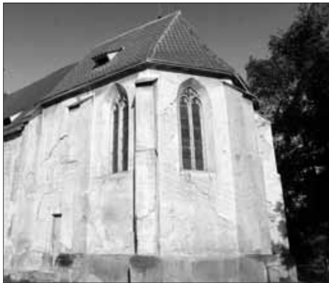
Hostín u Vojkovic (okres Mělník), kostel Nanebevzetí P. Marie, presbytář. Poslední etapa opravy krovu nad presbytářem kostela Nanebevzetí Panny Marie, kde proběhla též obnova prejzové střešní krytiny. Zpočátku se diskutovalo o možnosti pokrýt presbytář pálenou střešní taškou bobrovkou, ale nakonec se přistoupilo k výběru prejzové střešní krytiny tak, jak zde byla použita v minulosti. Návrat různorodé pálené krytiny podtrhl skladbu bmot kostela danou jeho stavebním vývojem (foto A. Burešová).
