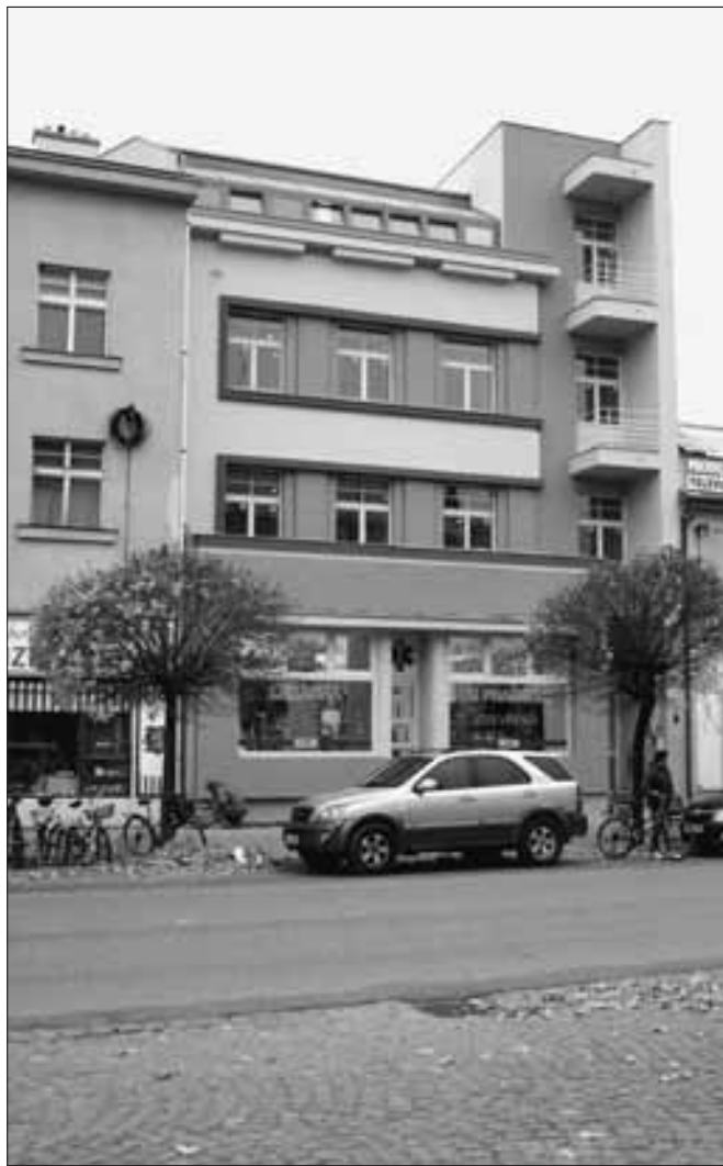
Poděbrady (okres Nymburk), objekt bývalého hotelu Praha čp. 178, Riegrovo náměstí. Součástí záměru generální opravy a adaptace objektu na lékařský dům byla i obnova uličního průčelí. Barevné řešení a povrchová úprava jednotlivých ploch byly určeny na základě operativního průzkumu fasády a komparace s dobovými fotografiemi a původními plány (foto M. Zemková).
