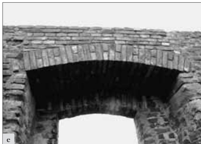
Krakovec, brad, odstranění bavárie utrženého nadpraží okna nad vstupní bránou: a – stav před opravou; b, c, d – průběh prací; e – stav po opravě (foto J. Sobek).
