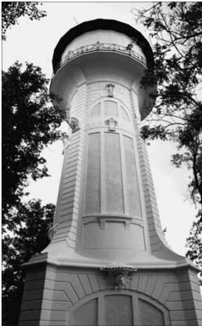
Nymburk, secesní vodojem, Vodárenská ulice. Vzhledem k věžovitě hmotě objektu s předsazeným přízemím musely být udržovací práce na vnějším plášti prováděny borolezeckou technikou (foto M. Zemková).
