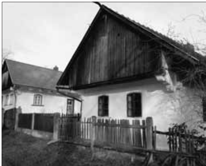
Bošín (okres Nymburk) dům čp. 35 na návsi v Bošíně je zástupcem starší vrstvy zástavby dané lokality s několika fázemi vývoje. V roce 2011 probíhala 2. etapa obnovy obytné části chalupy. Po obnově roubení v roce 2010 následovala obnova truhlářských prvků (podlah a bednění) a vnitřních i vnějších bliněných omítek. Obnova exteriérů domu do jeho původní podoby výrazně přispívá k obnově autentického charakteru severní části bošínské návsi (foto J. Svobodová).
