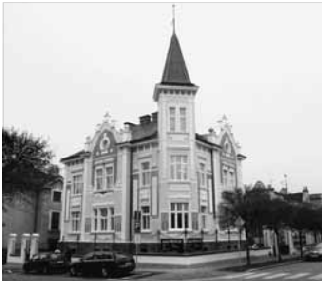
Kolín, vila čp. 249 v Heverově ulici. V roce 2011 byla dokončena náročná celková obnova této secesní vily včetně obnovy interiéru, která je centrem ochranného pásma vyhlášeného kolem ní a zahrnujícího architektonicky velmi hodnotnou čtvrt' dalších secesních vil (foto M. Glosová).
