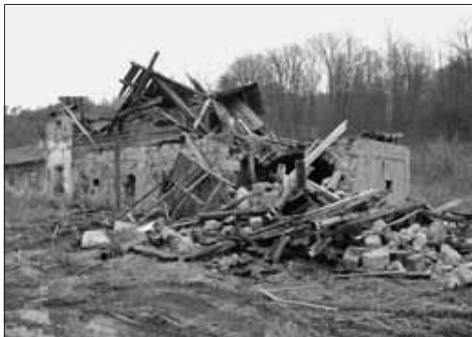
Chudolazy (okres Mělník). Budova s roubeným patrem v areálu bývalého mlýna, datovaná rokem 1785, byla dlouhou dobu sledována jako mimořádně obrozená památka. Ačkoli se nachází v atraktivním místě ve známé rekreační oblasti Kokořínska, byla ponechána v havarijním stavu a neexistovala zde vzblédem ke složitým vlastnickým vztahům možnost záchrany. V roce 2011 skutečně došlo ke zřícení podstatné části této památky, a tím k jejímu faktickému zániku (foto J. Mrázek).
