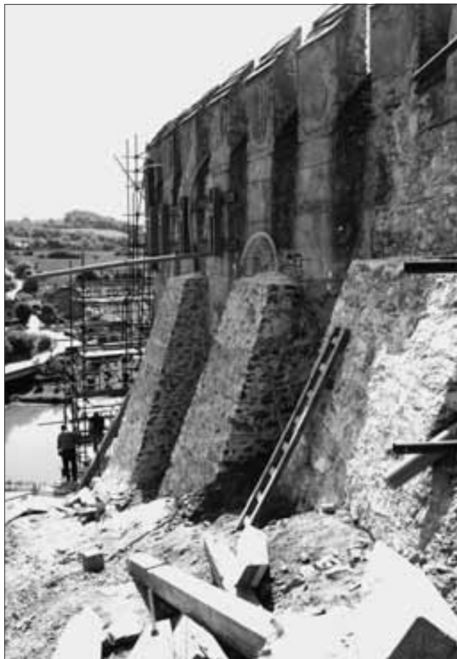
Český Šternberk (okres Benešov) hrad, bradba severního parkánu, příklad náročné opravy bradebního zdiva. V roce 2011 byla po pečlivé předprojektové a projektové přípravě provedena 3. etapa mimořádně náročné havarijní akce – statického zajištění východní a severní hradby severního parkánu. Vzhledem k rozsáhlým poruchám bradební zdi bylo nutné kromě stažení zajistit základovou spáru mikropilotami (foto M. Glosová).
