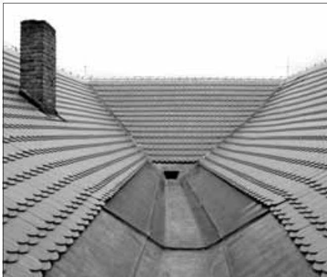
Skrýšov (okres Příbram), zámek, pohled do úžlabí po opravě. Zámecká budova je zastřešena dvojicí souběžných sedlových střech na čelech propojených valbovými úseky. Odvodnění středního úžlabí, které představovalo letitý problém, se neobešlo bez rozsáhlejší klempířské práce (foto H. Řepková).
