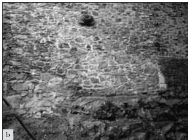
Krakovec, brad: a – havárie východní obvodové stěny; b – stav po opravě (foto J. Sobek).
