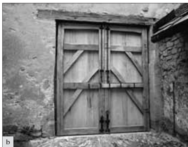
Točník, brad. Nová vrata zadní brány, dvoukřídlá vrata mají rámovou konstrukci z hranolů a jsou oplášťena fošnami. Tesařské spoje jsou zajištěny kolíky. Veškeré kování vrat je provedeno kovářsky (foto J. Fialová).
