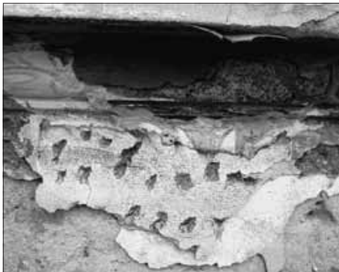
Vínarice (okres Mladá Boleslav), zámek, detail ze severního průčelí. Při zabíjení obnovy průčelí zámku byl proveden operační průzkum a dokumentace. Kromě jiného byl zachycen malý fragment malované úpravy hlavní římsy a zřejmě pozůstatky hlavičky iluzivního „pilastru“, pocházející nejspíše z první třetiny 17. století. Nález naznačil bohatost fasády tehdy nově přestavěného zámku (foto J. Žížka).
