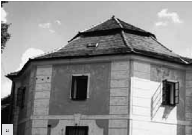
Horušice (okres Kutná Hora) střecha záměčku čp. 19: a – stav před opravou, b – stav po opravě střechy. Na střechu byla vrácena volská oka a mansardová římsa. Hlavice komínu byla doplněna dle archivních fotografií. Nesporný pozitivní dopad na vzhled střechy má i vykryté úžlabí v pálené krytině (foto J. Černochovej).
