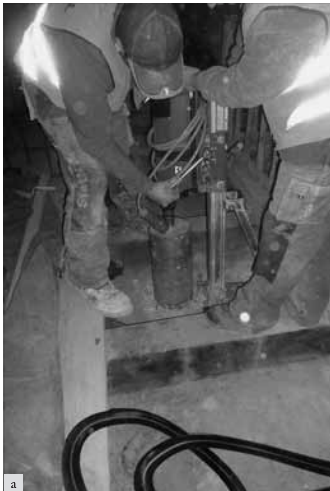
Karlštejn, brad: a – začínáme vrtat svislý jádrový vrt v obvodu Mariánské věže; b – jádrový vrt (foto V. Komárek).
