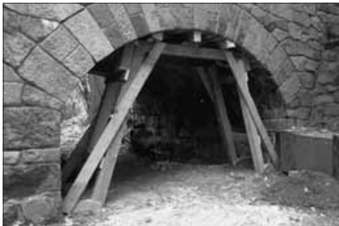
Konopiště, zámek, západní mostek je v bavarijním stavu – podpora klenebních oblouků (foto z archivu zámku).
