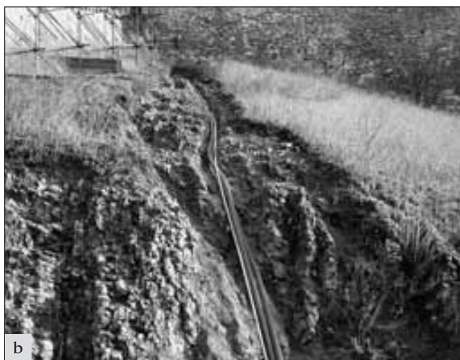
Karlštejn, brad: a – začínáme vrtat svislý jádrový vrt v obvodu Mariánské věže; b – jádrový vrt (foto V. Komárek).
