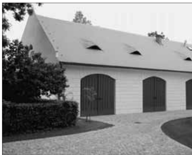
Benátky nad Jizerou (okres Mladá Boleslav), kočárovna v areálu zámku je jedním z posledních objektů, které byly v rámci celkové obnovy areálu opraveny. Objekt, stojící v těsné blízkosti zámeckého kostela, působí příznivě kvalitně provedenou opravou a čistotou detailů. K nim patří nejen obnova krytiny s vikýři ve tvaru „volských ok“ a štítu, který byl zbaven rušivých novodobých zásahů, ale i truhlářská oprava vrat (foto E. Vyletová).
