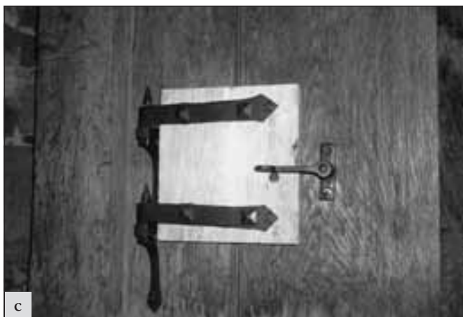
Krakovec (okres Rakovník), brad: a – detail opravy klenby portálu; b – nová vstupní vrata a opravený portál (borní klenba); c – nová vrata, detail dvířek v průhledu vraty (foto V. Komárek)
