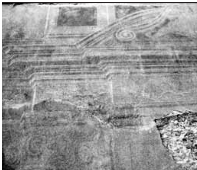
Dobříš (okres Příbram), detail iluzivní malované výzdoby průčelí oranžerie. V roce 2011 byla zahájena po obnově atiky obnova iluzivního malovaného průčelí zámecké oranžerie v Dobříši, která uzavírá formální zabradu a současně tvoří výraznou architektonickou protiváhu budově vlastního zámku. Na snímku je patrná malovaná, zdánlivě dobře dochovaná architektura, která je však výsledkem technologicky problematické rekonstrukce ze 70. let 20. století. Narušena je jak malba, tak celoplošně i omítková novodobá vrstva. Na základě průzkumů, důkladného posouzení a zvážení bude tedy nutné provést radikální obnovu – rekonstrukci malované výzdoby včetně omítkových vrstev (foto J. Žižka).
