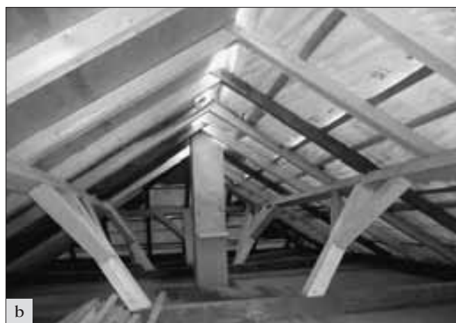
Veltrusy, zámecký areál, domy u brány: a – pohled na poškozený krov; b – krov po obnově (foto V. Komárek).
