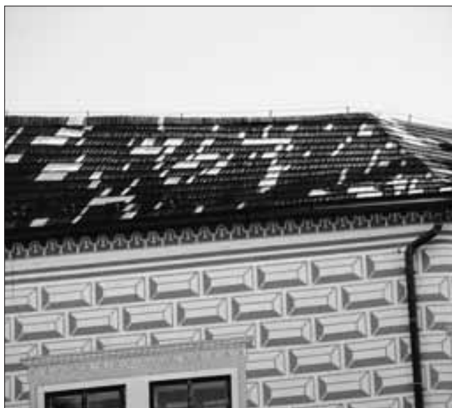
Březnice, zámek, oprava části šindelové střešní krytiny severozápadního křídla zámku (foto z archivu zámku).
