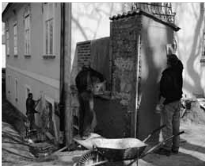
Hořovice, zámek, oprava fasády jižního křídla a vstupu do parku (foto z archivu zámku).
