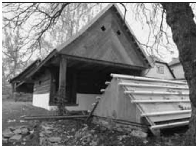
Olešná (okres Beroun), usedlost čp. 8. V další etapě celkové obnovy byl dokončen špýchar přenesený z usedlosti čp. 10 v Ceko- vě. Podstřň špýcharu částečně překrývá sklep, který zůstal zachován po zaniklé hospodářské stavbě. Zbývající část sklepa je překryta samostatnou stříškou (foto M. Hanzlíková).
