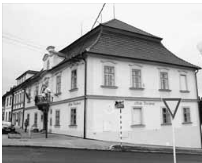
Zdice (okres Beroun), oprava fasády čp. 2 – měšťanského domu U krále Václava IV. s hostincem, nyní MÚ města Zdice. Oprava byla provedena ve dvou etapách, dokončena v listopadu 2011. Oprava navázala na řešení z 90. let 20. století. Štuková výzdoba byla opravena v nezbytném rozsahu a barevné řešení fasády navázalo na řešení provedené na základě průzkumů z 90. let (foto E. Kosová).
