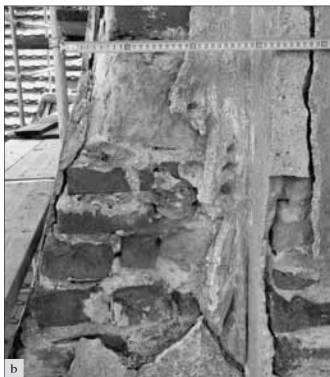
Bělá pod Bezdězem (okres Mladá Boleslav), zámek. Součástí opravy střech zámku byla i oprava věže: a – zahrnovala výměnu šindelové krytiny, opravu omítek a restaurování kamenných prvků; b – i přes značné narušení omítek se v rámci prováděného operativního průzkumu podařilo zachytit fragmenty původního povrchové úpravy křídel po stranách věže, které pokrývala strukturovaná omítka s dekorativním motivem. Fragmenty byly restaurátorsky zajištěny a podle nich provedena obnova. Také barevnost byla obnovena podle výsledků sondážního průzkumu prováděného v rámci OPD. Barevnost s červenými aktivními články podtrhuje monumentalitu raně barokního vstupního průčelí navrženého J. B. Matheyem, jehož hlavním kompozičním akcentem je tříosý rizalit s věží (foto E. Vyletová).
