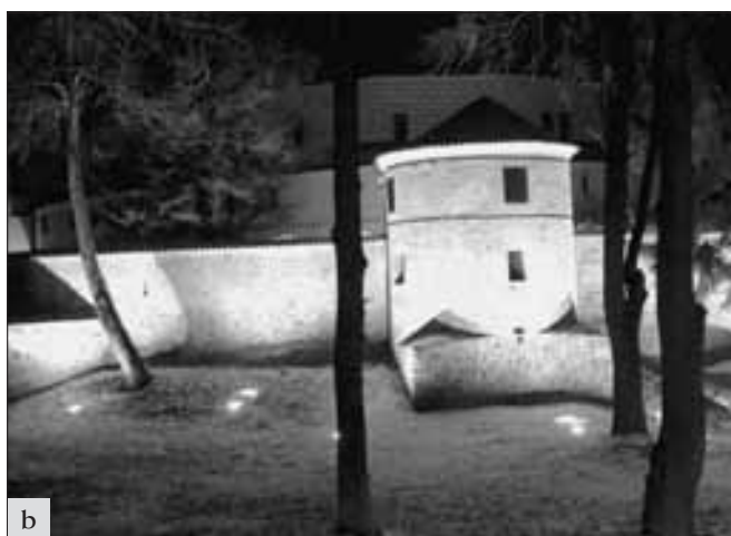
Březnice (okres Příbram), zámek: a – instalace slavnostního osvětlení hradeb zemními svítidly Light Up – Garden; b – noční osvětlení zámku (foto R. Barták).
