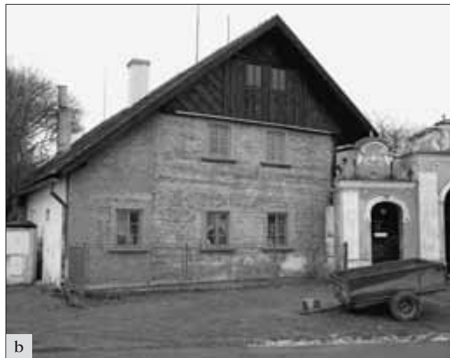
Víska (okres Mladá Boleslav). Usedlost čp. 5 ve Vísce se díky svému umístění na návsi a bonosné vstupní bráně velmi výrazně podílí na utváření charakteru VPR: a – štítové průčelí vlastního domu usedlosti však bylo několik desetiletí narušeno drubotnými širokými okenními otvory, které degradovaly podobu této hodnotné památky; b – v roce 2011 se uskutečnila obnova původního řešení průčelí s dvojicemi oken v obou podlažích, které znamenají jeho rehabilitaci a kladně ovlivňují charakter celé návsi. Obnova fasády bude dokončena v následujícím roce (foto J. Svobodová, srov. obr. na s. 138).
