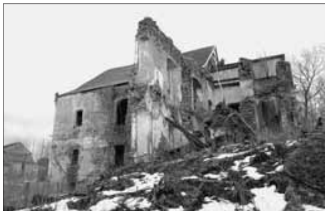
Zvěstov (okres Benešov), budova zámku. Renesanční stavba se zajímavými historickými souvislostmi beznadějně chátrá a přes veškerou snahu není v podstatě šance na její záchranu (foto J. Mrázek).
