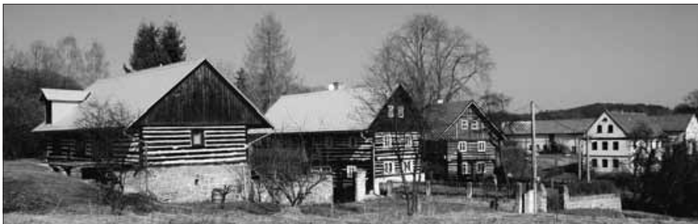
Dobřeň (okres Mělník), špýchar č. e. 01. Bývalá hospodářská budova usedlosti čp. 16 (první zleva) dotváří skladbu zástavby západního okraje vesnice. V rámci výměny střešní krytiny byly použity stejné šablony jako na obytném stavení, které jsou v dané oblasti tradičně používanou krytinou již od 20. let 20. století (foto J. Berková).
