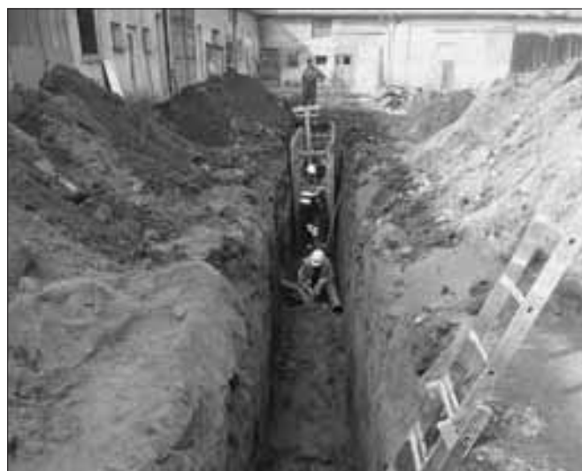
Veltrusy, zámecký areál, stavba dešťové kanalizace (foto V. Komárek).
