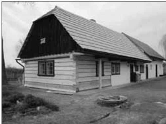
Habrkovice (okres Kutná Hora), dům usedlosti čp. 4. Roubená obytná část domu byla v minulosti částečně obezděna plentami, z části byla nabazena zdivem. Zbývající trámy byly ve stavu, který nedovoľoval jejich další zachování. V rámci obnovy byly proto vnější stěny světnice sroubeny nově při zachování tradičních tesařských spojů a detailů. Snímek zachycuje nové stěny s původními okenními ostěními před provedením vymazávek spár a celkového vápenného nátěru (foto J. Berková).
