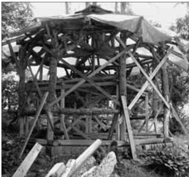
Konopiště, Růžová zahrada, oprava korkového pavilonu, 3. etapa prací (foto z archivu zámku).
