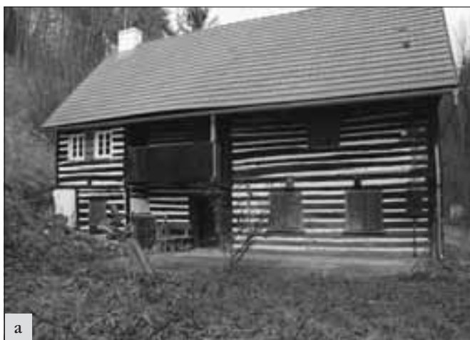
Vidím (okres Mělník), chalupa čp. 78: a – postupná celková obnova chalupy směřuje nejen k opravě poškozených konstrukcí, ale také k eliminaci nevhodných zásahů provedených v 2. polovině 20. století. V rámci druhé etapy obnovy proto bylo, vedle dalších prací, nahrazeno nevhodné trojdílné okno v komorové části dvojicí menších tradičních oken, což velmi prospělo celkovému vzhledu průčelí. Obnova veškerých konstrukcí je prováděna tradičními technologiemi; b – na detailu je patrný obnovený záklop nad zápražím z loupané kulatiny zalité bliněnou mazaninou (foto J. Berková).
