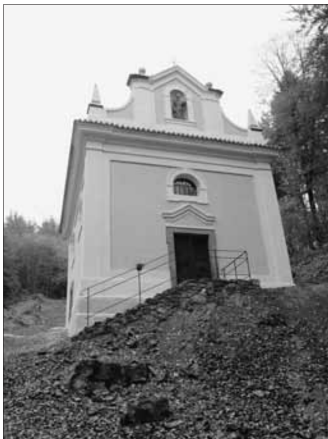
Kounov (okres Rakovník), kaple sv. Vojtěcha v lese Na Rovinách s dokončenou opravou obvodového pláště, opraveným krovem a položenou novou taškovou krytinou, restaurovanou sochou patrona ve štítě, kamenicky opravenými pískovcovými články a opravenou fasádou s novým nátěrem, listopad 2011 (foto E. Volfová).
