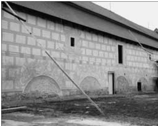
Košátky (okres Mladá Boleslav), areál zámku, budova sýpky. V roce 2011 výrazně pokročila celková obnova budovy sýpky v hospodářském dvoře v předzámčí. Až na soklovou část se podařilo dokončit restaurátorskou obnovu bohaté sgrafitové výzdoby severního průčelí. Obnově předcházela řada průzkumů, zkoušek i odborné diskuse o koncepci a způsobu provedení (foto J. Žižka).
