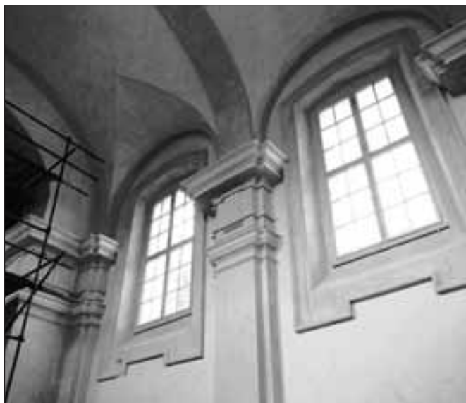
Choteč (okres Praha-západ), interiér kostela sv. Kateřiny Alexandrijské, detail. Po dlouhodobé obnově exteriéru kostela se v roce 2011 podařilo realizovat opravu architektonicky bohatého barokního interiéru (foto V. Ottová).
