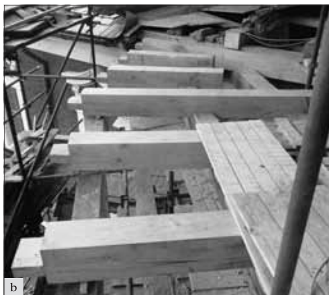
Veltrusy (okres Mělník), zámek, hlavní budova: a – lešení pro opravu balkonu; b – oprava balkonu (foto V. Komárek).
