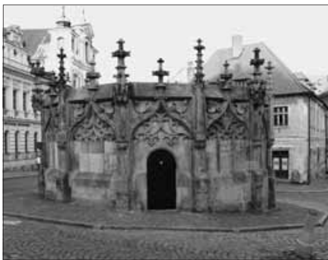
Kutná Hora, Kamenná kašna po restaurování v letech 2010–2011. Po zhruba dvaceti letech bylo realizováno náročné restaurování Kamenné kašny v Kutné Hoře. Především byla odstraněna tvrdá vrstva, kterou byl povrch zádiva a článků sjednocen při předchozím restaurování. Následně byly řešeny a postupně realizovány dílčí plastické, případně barevné retuše. Jejich rozsah určovala a limitovala především zásada zachování nebo obnovy tektonické, tedy i optické celistvosti jednotlivých architektonických článků, například lípaných kružeb. Navrhovaná ochrana horních ploch olověným plechem byla omezena na nejnútnejší míru. Výsledkem je příznivě působící celistvé architektonické dílo, zachovávající materiálovou autenticitu, která ostatně úzce souvisí s názvem této významné pozdně gotické památky (foto A. Pospíšil).
