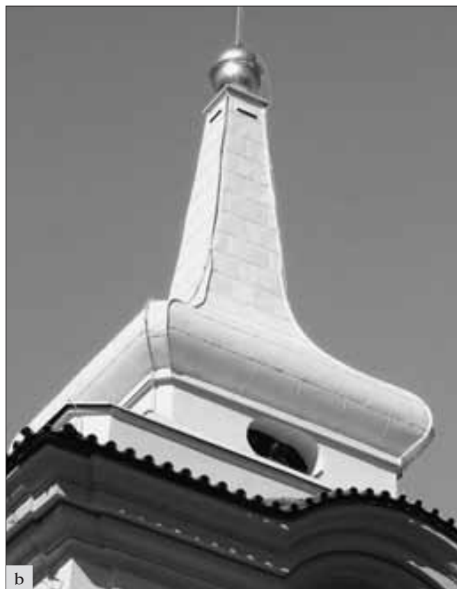
Tuřany (okres Kladno), zvonice při kostele Nanebevzetí Panny Marie. Roku 2011 došlo k opravě krovu a krytiny, s částečnou výměnou. Velmi kvalitně provedené práce spočívaly v lokální výměně krovových prvků a v položení šindele na mnohých chybějících místech (foto E. Spárová).
