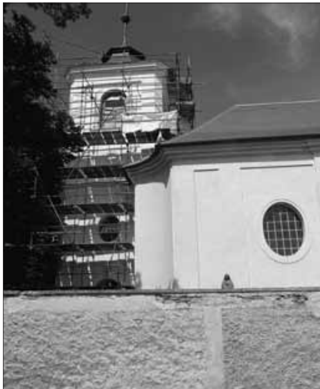
Brežany (okres Rakovník), kostel sv. Markéty, západní věž s novými fasádními omítkami po provedené rekonstrukci architektonických článků a říms v srpnu 2011 (foto E. Volfová).
