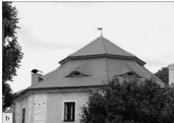
Horušice (okres Kutná Hora) střecha záměčku čp. 19: a – stav před opravou, b – stav po opravě střechy. Na střechu byla vrácena volská oka a mansardová římsa. Hlavice komínu byla doplněna dle archivních fotografií. Nesporný pozitivní dopad na vzhled střechy má i vykryté úžlabí v pálené krytině (foto J. Černochovej).
