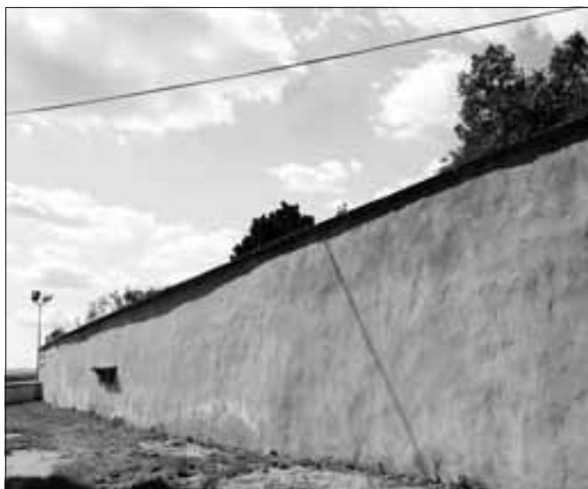
Sadská (okres Nymburk), kostel sv. Apolináře. V roce 2011 došlo k zajištění obradní zdi v areálu kostela, která se v části svého rozsahu zřítíla na sousední pozemek. Vnější plášť celé konstrukce byl ve finální úpravě opatřen reznou jednovrstvou hrubě zatočenou vápennou omítkou (foto M. Zemková).
