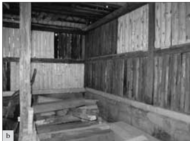
Nové Osinalice (okres Mělník) usedlost čp. 7. Stodola v areálu usedlosti byla v bavijském stavu: a – v rámci obnovy byla na nový základ vyžděna podezdívka z původních pískovcových kvádrů, na kterou byla osazena nosná konstrukce brázděných stěn s částečným použitím původních prvků. Nové části brázdění byly provedeny tradičními tesařskými postupy; b – výplně stěn zde byly historicky provedeny z poměrně silných štípaných kuláčů bez hliněné omazávky (foto J. Berková).
