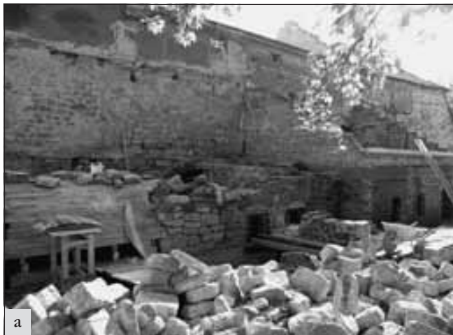
Vepřek (okres Mělník), čp. 19. Celková obnova rozsáhlého areálu vodního mlýna byla zahájena obnovou domu: a – celkový pohled na severní průčelí domu s přízemní přístavbou černé kuchyně a komory zachycuje probíhající obnovu částečně propadlých kleneb; b – výsledek rekonstrukce při pohledu z interiéru (foto M. Hanzlíková).
