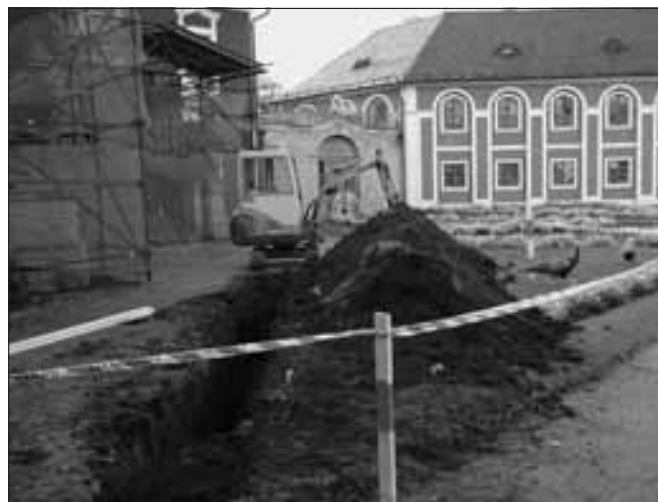
Veltrusy (okres Mělník), zámek, oprava dešťové kanalizace (foto z archivu zámku).
