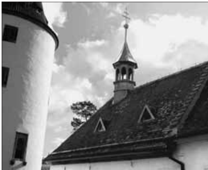
Křivoklát, brad, dokončení poslední etapy opravy střešního pláště jižního křídla – střechy nad kaplí (foto J. Fialová).
