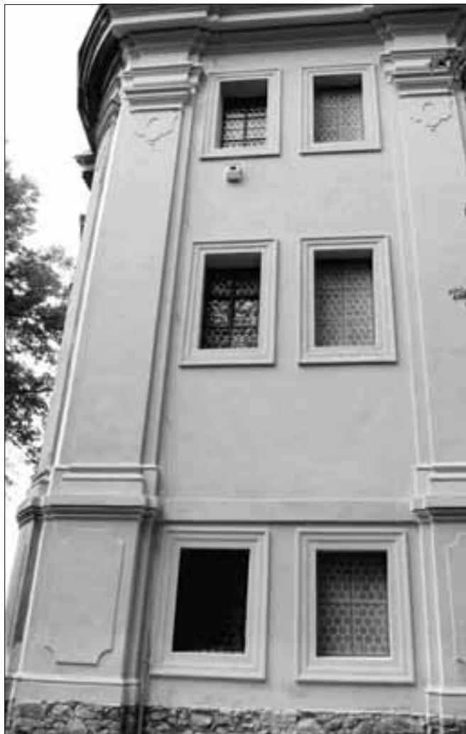
Osov (okres Beroun), kostel sv. Jana Křtitele, část bočního průčelí. V Osově proběhla velmi náročná oprava další části bočních průčelí vrcholně barokního kostela Narození sv. Jana Křtitele, v rámci které byla vyměněna dřevěná okna včetně restaurování vitráží a dále s úspěchem restaurována šestice iluzivních barokních oken (foto V. Ottová).
