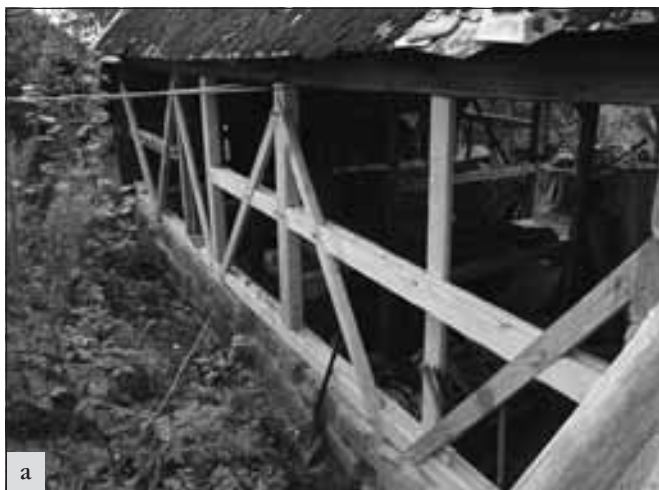
Nové Osinalice (okres Mělník) usedlost čp. 7. Stodola v areálu usedlosti byla v bavijském stavu: a – v rámci obnovy byla na nový základ vyžděna podezdívka z původních pískovcových kvádrů, na kterou byla osazena nosná konstrukce brázděných stěn s částečným použitím původních prvků. Nové části brázdění byly provedeny tradičními tesařskými postupy; b – výplně stěn zde byly historicky provedeny z poměrně silných štípaných kuláčů bez hliněné omazávky (foto J. Berková).
