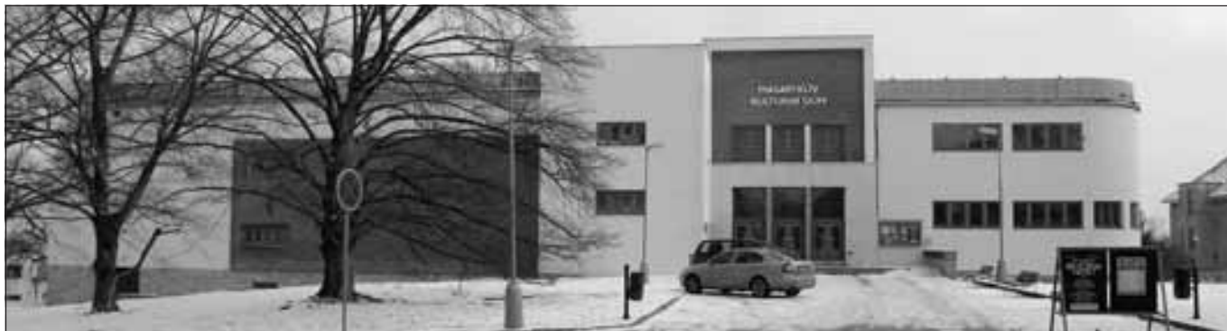
Mělník, kulturní dům. Funkcionalistická stavba ing. arch. Josefa Širce ml. a ing. arch. Bedřicha Zemana z roku 1936 je umístěna na vyvýšenině ve východní části MPZ Mělník. V letošním roce proběhla celková rekonstrukce objektu, která zahrnovala opravu střechy, výměnu střešních svodů a dalších klempířských prvků, rekonstrukci fasády, repasi a někde i výměnu oken, dále pak výměnu nevhodných dveří v bočních vstupech a očištění kamenného soklu (foto A. Burešová).
