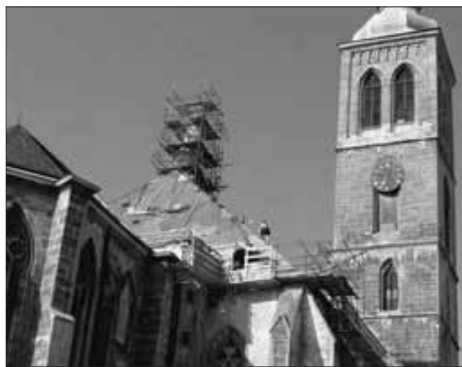
Kutná Hora, kostel sv. Jakuba. Postupná obnova střešního pláště kostela představuje jednu z nejvýznamnějších akcí tohoto druhu v rezervaci. V roce 2011 akce pokračovala obnovou krovu lodi ve východní části, kde byly pokleslé vazby heverovány a při opravě tesařské konstrukce uplatněny tradiční celodřevěné spoje podobné jako před lety v sedlecké katedrále. V této etapě byl obnoven sanktusník, krytina z přírodní břidlice bude položena v následujícím roce (foto A. Pospíšil).
