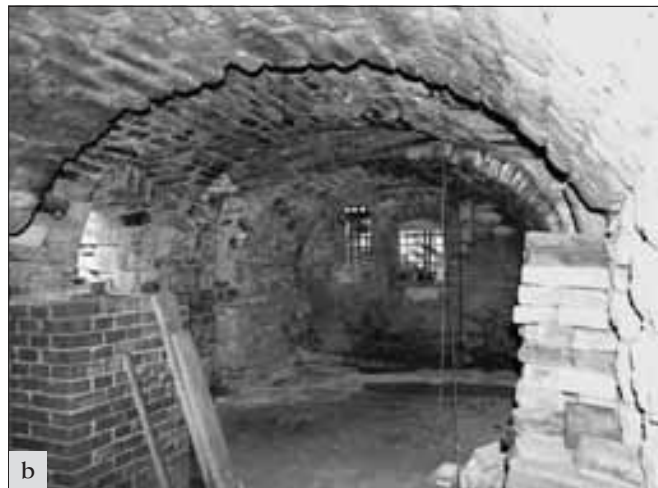
Vepřek (okres Mělník), čp. 19. Celková obnova rozsáhlého areálu vodního mlýna byla zahájena obnovou domu: a – celkový pohled na severní průčelí domu s přízemní přístavbou černé kuchyně a komory zachycuje probíhající obnovu částečně propadlých kleneb; b – výsledek rekonstrukce při pohledu z interiéru (foto M. Hanzlíková).
