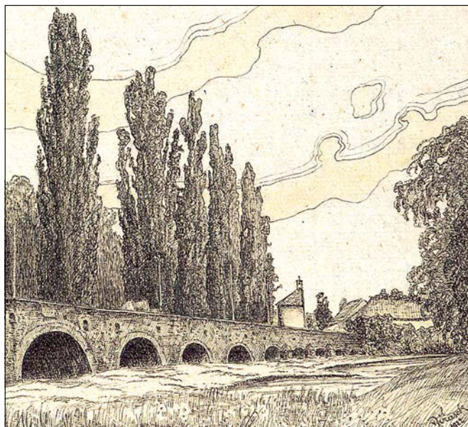
Obr. 13: Pohled přes most směrem ke kapli sv. Rocha, 1922 (Městský úřad Brandýs nad Labem-Stará Boleslav, sign. 60XU, Pamětní kniha obce Staré Boleslavi 1836–1951, s. 43.).
