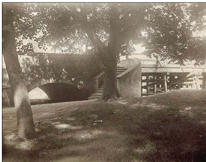
Obr. 4: Poslední oblouk Borgorelliho mostu před dřevěným mostem přes Staroboleslavskou tůň a schodiště pro sestup do Hluchova, 1924 (MÚ Brandýs nad Labem-Stará Boleslav, o. c. v pozn. 14, s. 579).
