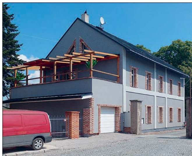
Obr. 9: Důl Ronna v Hnidousích, vstup k bývalému dolu (foto J. Vyšín, 2022).
