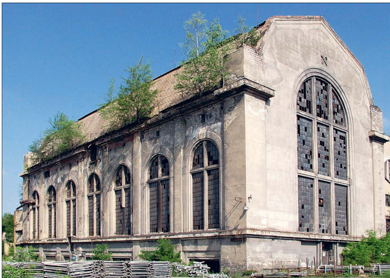
Obr. 7: Důl Dubí, strojovna dolu Prago (foto J. Vyšín, 2004).
