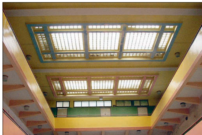
Obr. 3: Důl Tuchlovice, interiér administrativní budovy (foto J. Vyšín, 2004).
