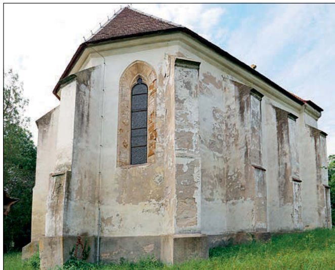
Obr. 7: Markovice, kostel sv. Marka, polygonální závěr presbytáře v pohledu od severovýchodu, stav 2023 (foto H. Prixová Dvorská).
