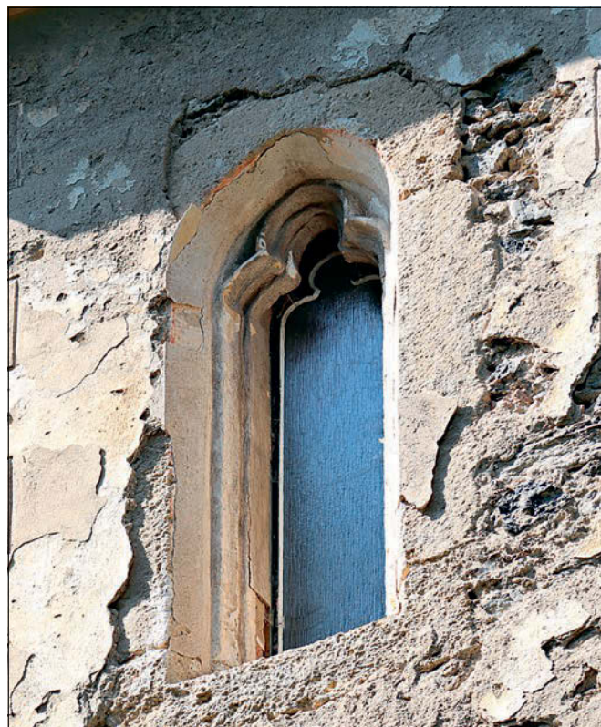
Obr. 19: Lochy (okres Kutná Hora), kostel sv. Bonifáce, jihovčochodní okno presbytáře, okolo 1370–1380, stav 2023.
