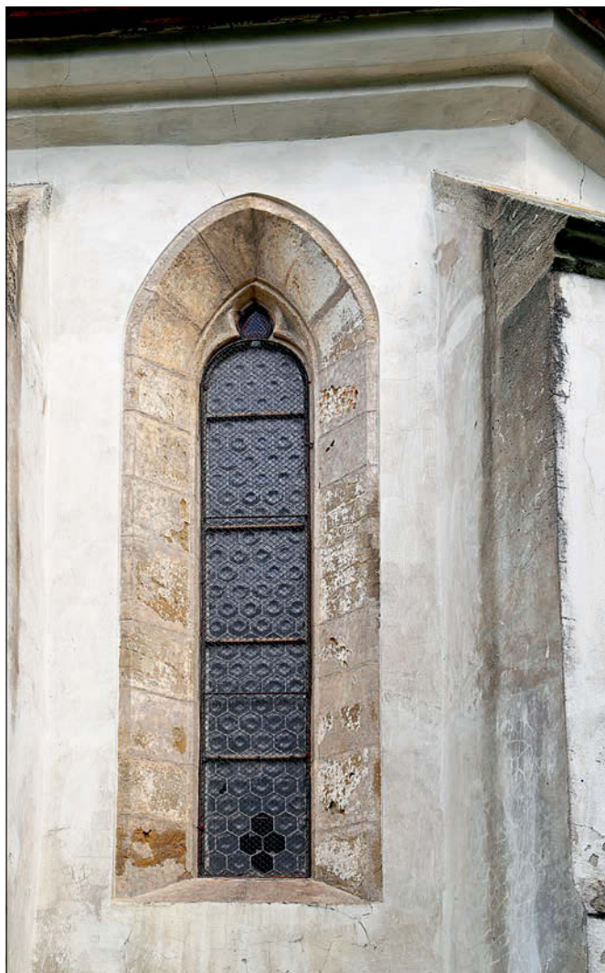
Obr. 11: Markovice, kostel sv. Marka, jižní gotické okno závěru kostela, stav 2023.
