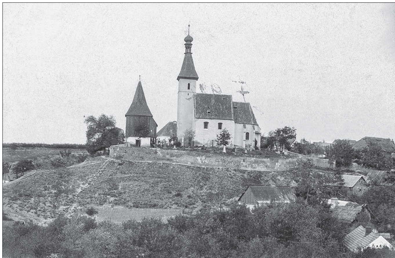
Obr. 1: Vitice (okres Kolín), celkový pohled na areál kostela sv. Šimona a Judy se zvonicí a hřbitovem od jihu (foto Unie Vilím, Praha; před 1907; z pozůstalosti A. Podlahy; sbírka fotografické dokumentace NPÚ GnŘ).
