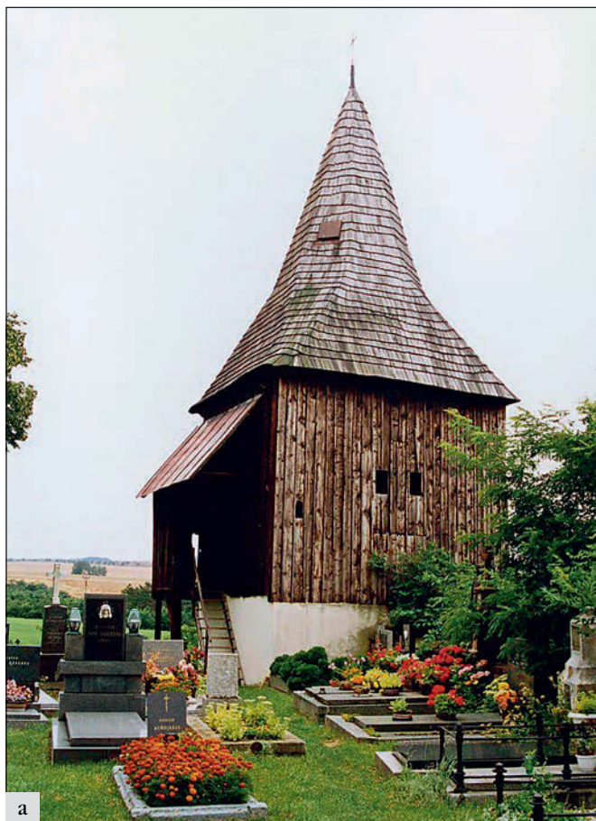
Obr. 3: Vitice, zvonice u kostela sv. Šimona a Judy, celkové pohledy na zvonici od severovýchodu, v současnosti a před poslední opravou. Patrné jsou rozdíly v počtu otvorů a uspořádání prkenného pláště patra, zejména v patní části. Původně dosahovala prkna na severní straně níže než na východní, v souladu s výškovou úrovní uložení patních trámů stěn (a – foto H. Hermannová, 2001; b – foto J. Veselý, 2023).
