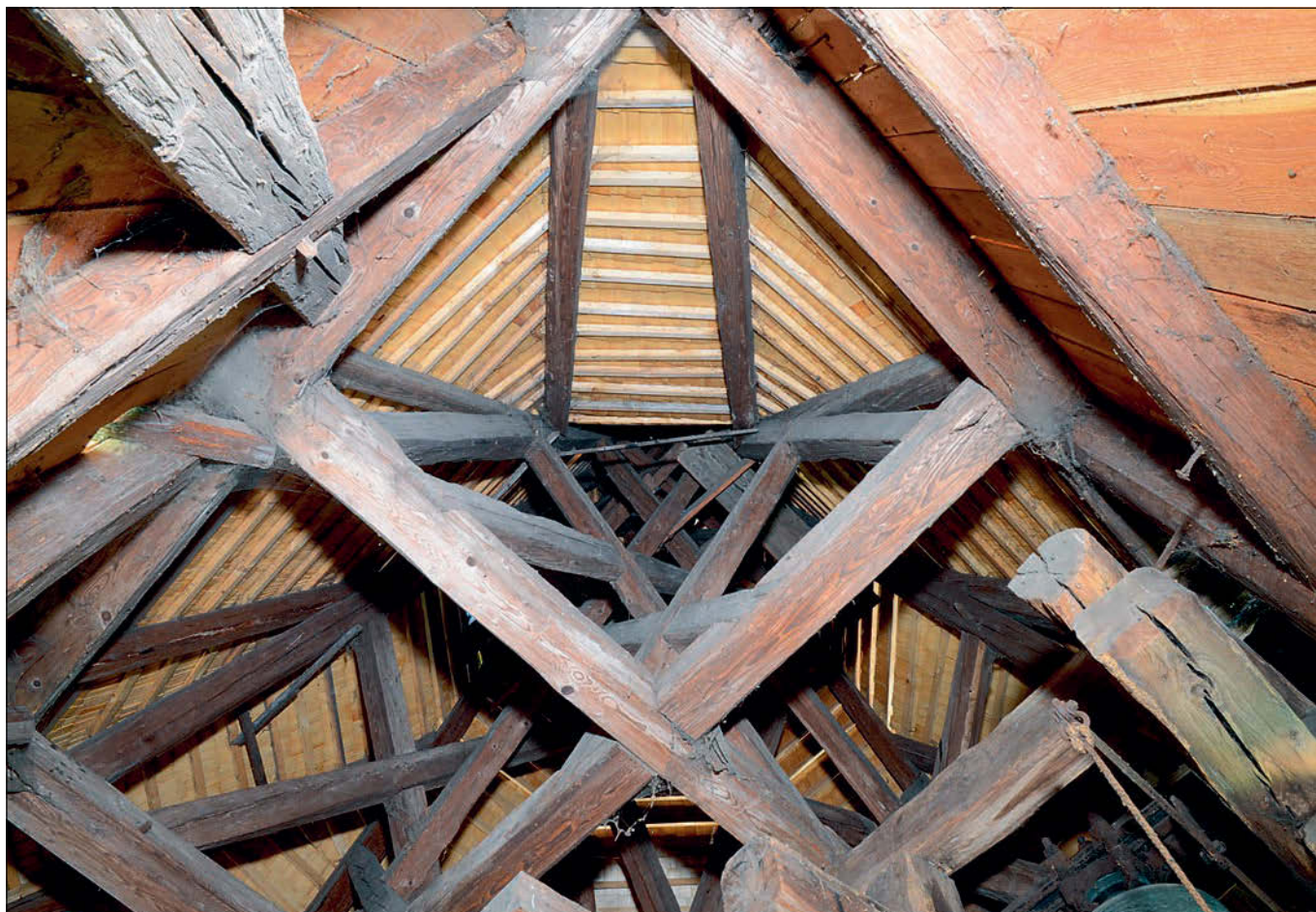
Obr. 14: Vitice, zvonice u kostela sv. Šimona a Judy, průhled ze severovýchodního kouta patra vzhůru do krovu, na pronik východní vazby č. 4 a severní vazby č. 2. V popředí konstrukce východní a severní stěny patra a čtveřice námětků při východním nároží.
