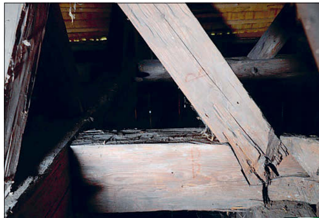
Obr. 17: Vítice, zvonice u kostela sv. Šimona a Judy, krov, pata krátké vzpěry levého ondřejského kříže jižní vazby s plátovým spojem s vazným trámem. Na obou prvcích je patrná stejná značka kreslená rudkou.
