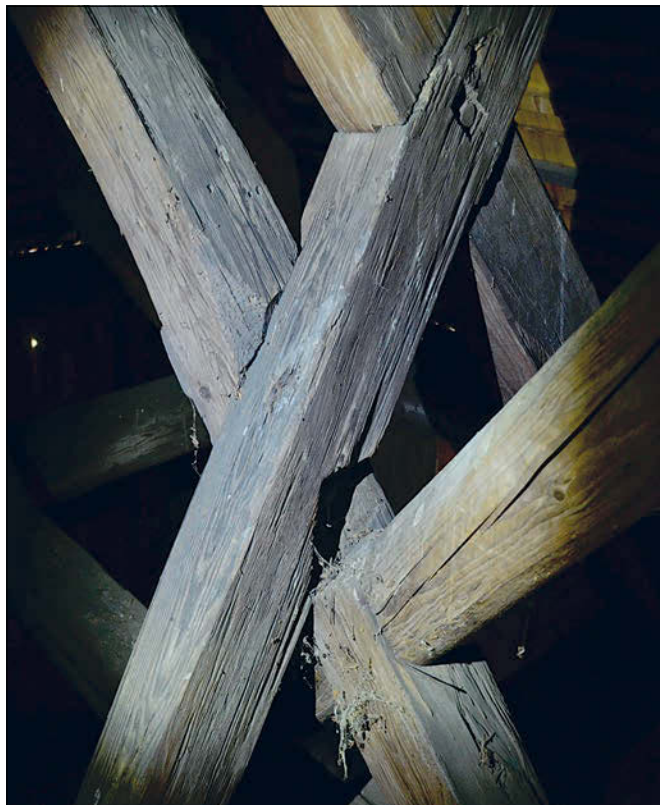
Obr. 16: Vítice, zvonice u kostela sv. Šimona a Judy, krov, detail míjení křížící se dvojice ondřejských křížů s patrným zeslabením na styku nejbližších prvků.
