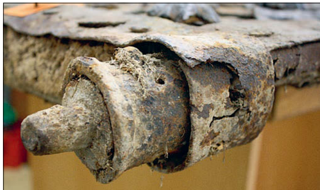
Obr. 21: Vitice, zvonice u kostela sv. Šimona a Judy, detail gotických dveří. Náboje s trnem, osazený na spodní hraně dveřního křídla. Patrné je, že spodní pás okování dveří je v místě, kde náboj obepíná, deformovaný (foto L. Veselý, 2019).
