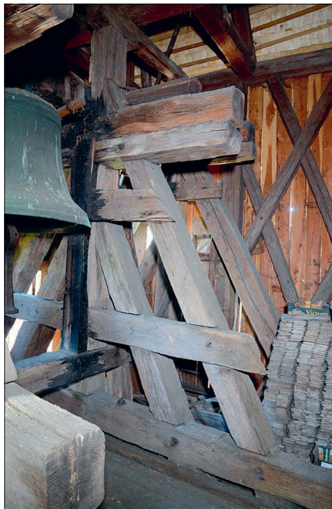
Obr. 13: Vitice, zvonice u kostela sv. Šimona a Judy, vzpěradlová zvonová stolice. Pohled na druhou vazbu od jihu.
