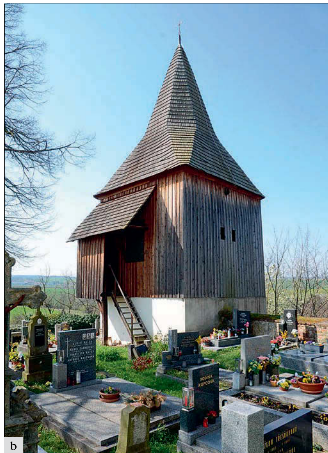
Obr. 3: Vitice, zvonice u kostela sv. Šimona a Judy, celkové pohledy na zvonici od severovýchodu, v současnosti a před poslední opravou. Patrné jsou rozdíly v počtu otvorů a uspořádání prkenného pláště patra, zejména v patní části. Původně dosahovala prkna na severní straně níže než na východní, v souladu s výškovou úrovní uložení patních trámů stěn (a – foto H. Hermannová, 2001; b – foto J. Veselý, 2023).
