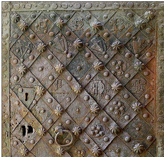
Obr. 24: Vitice, zvonice u kostela sv. Šimona a Judy, detail kovaného pláště gotických dveří s řadou aplikací ve formě liter a heraldických štítků. Také je patrné uspořádání otvorů klíčových dírek v místě zmizelého štítku (foto L. Veselý, 2019).
