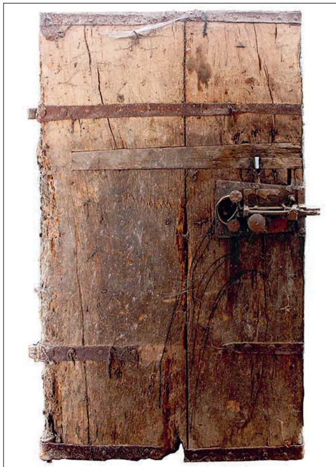
Obr. 20: Vitice, zvonice u kostela sv. Šimona a Judy, rubová strana gotických dveří po vysazení ze závěsů. Dobře patrné je konstrukční uspořádání popsané v textu (foto L. Veselý, 2018).
