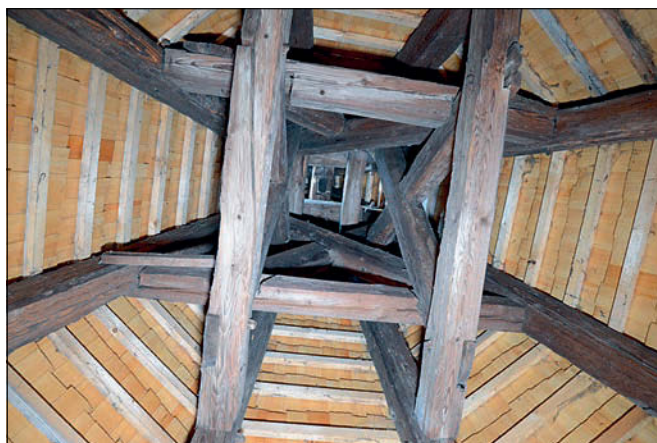
Obr. 15: Vitice, zvonice u kostela sv. Šimona a Judy, pohled od jihu na horní část krovu s křížícími se dvěma úrovněmi hambalků a čtveřicí menších ondřejských křížů. Uprostřed patrná převážka s čepem hrotnice.
