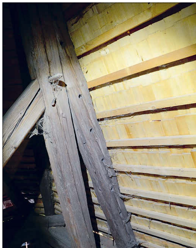
Obr. 18: Vítice, zvonice u kostela sv. Šimona a Judy, krov, severní námetek západní vazby s pravidelně rozmístěnými otvory po žebříkových příčlích.
