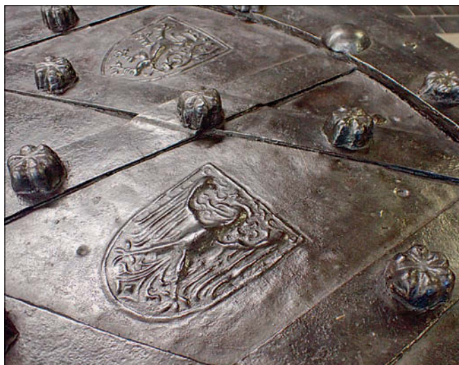
Obr. 4: Kladno, původní kostel Nanebevzetí Panny Marie, malé dveře – kovový povrch malých dveří po tanátování a konzervaci voskem.
