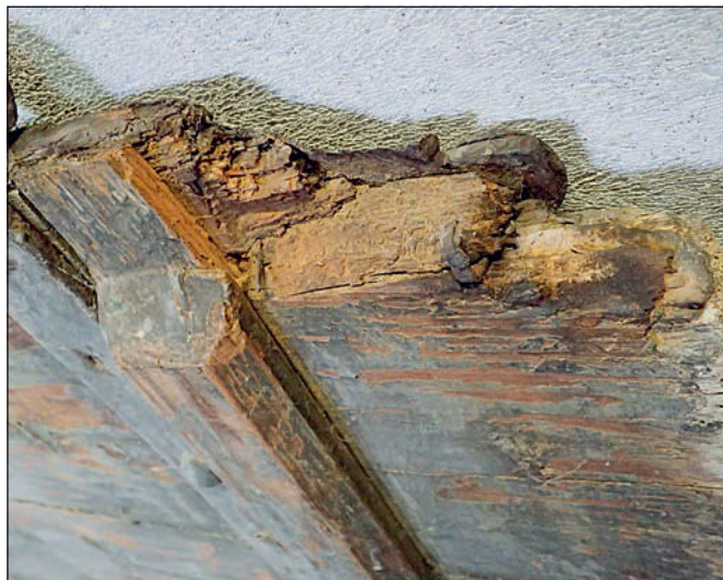
Obr. 3: Kladno, původní kostel Nanebevzetí Panny Marie, dveře do sakristie. Dolní část malých dveří s degradovanou dřevní hmotou.
