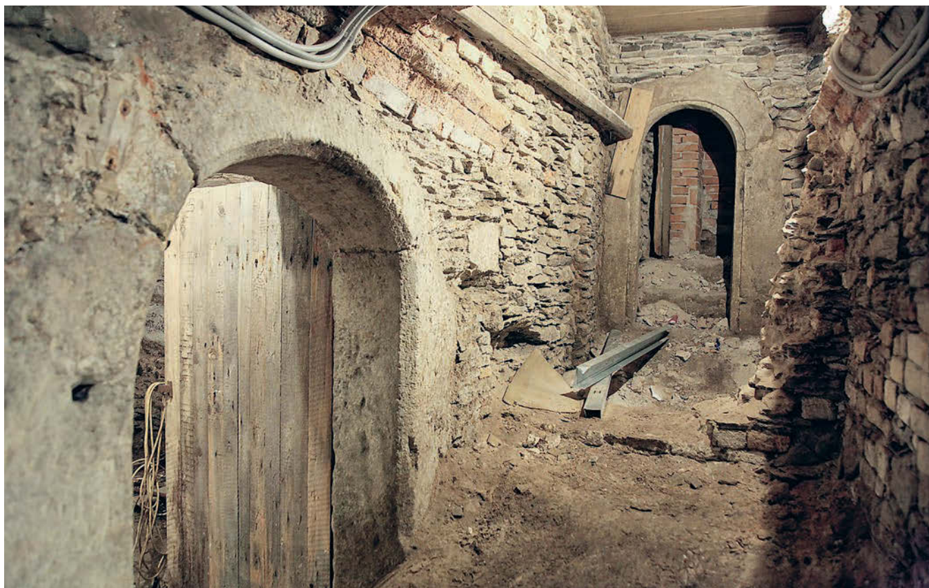
Obr. 5: Kolín, arciděkanství (Brandlova čp. 25), prostor mezi dnešním schodištěm do sklepa a jižními sklepy, vlevo gotický portál do středního sklepa, vzadu gotický portál ze zrušeného schodiště z přízemí (foto R. Šulc, 2016).
