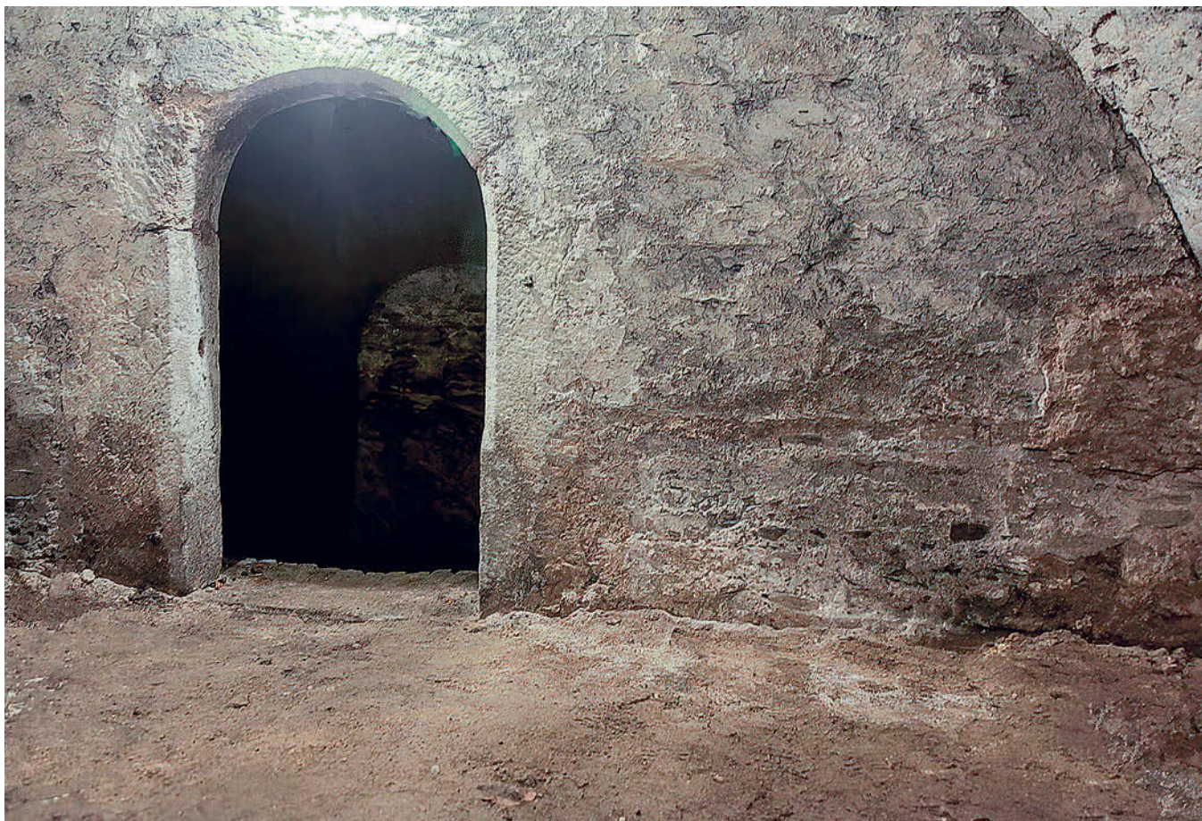
Obr. 9: Kolín, arciděkanství (Brandlova čp. 25), gotický portál ze schodiště do středního sklepa v jižní části suterénu (foto R. Šulc, 2008).
