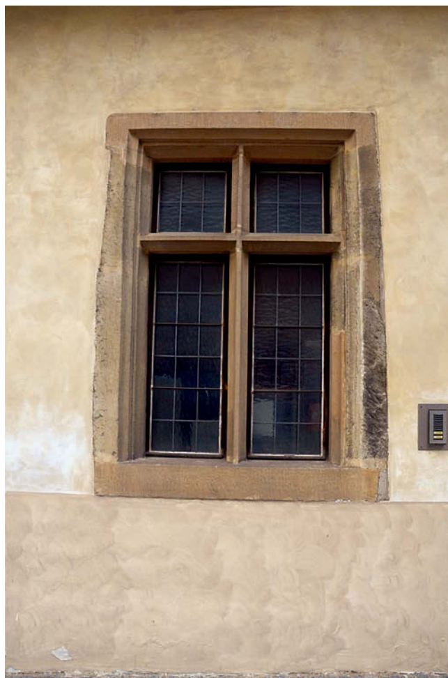
Obr. 16: Kolín, dům čp. 27 (Brandlova ul.), jižní okno přízemí, stav 2019.
