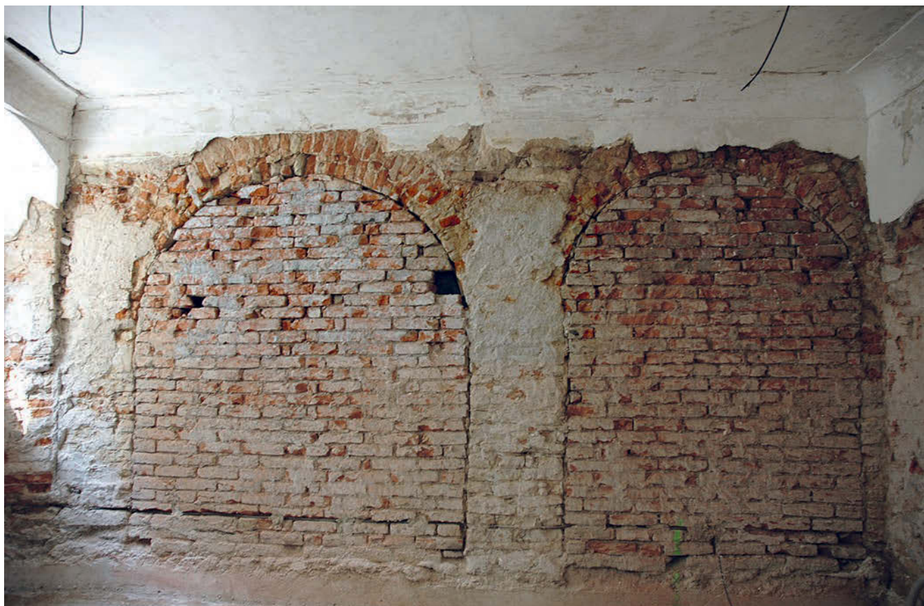
Obr. 23: Kolín, arciděkanství (Brandlova čp. 25), západní stěna jižní místnosti západního traktu s pozůstatkem vložené valené klenby s výsečemi, stav 2015.
