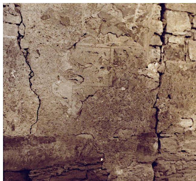
Obr. 16: Bylany, kvádrování u severovýchodního(?) nároží márnice (foto V. Kopecký, 1967; Podlipanské muzeum v Českém Brodě, Pozůstalost Vojtěch Kopecký).
