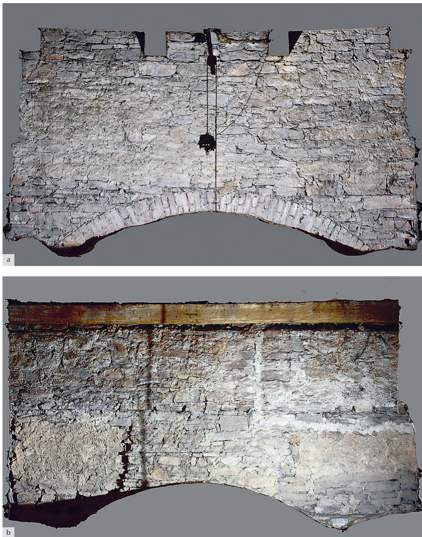
Obr. 14: Bylany, kostel sv. Bartoloměje, fotogrammetrie západní (a) a severní (b) stěny patra věže (zpracováno v programu Agisoft Metashape, K. Kibic, 2024).
