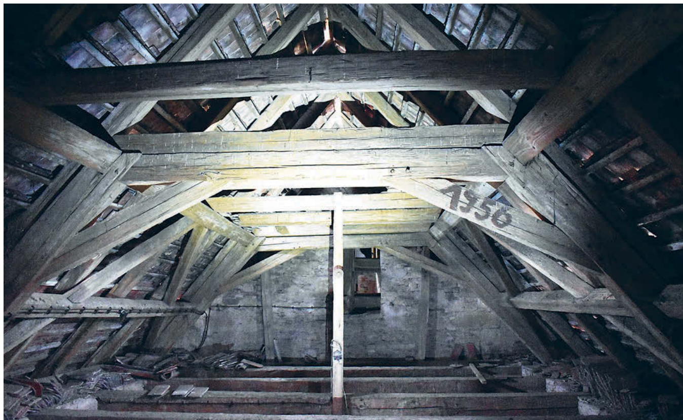
Obr. 12: Bylany, kostel sv. Bartoloměje, krovová konstrukce nad lodí, stav před opravou, únor 2022, pohled k východu (foto K. Kibic).
