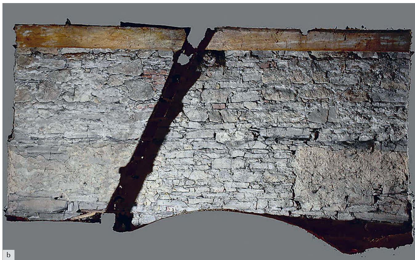
Obr. 15: Bylany, kostel sv. Bartoloměje, fotogrammetrie východní (a) a jižní (b) stěny patra věže (zpracováno v programu Agisoft Metashape, K. Kibic, 2024).
