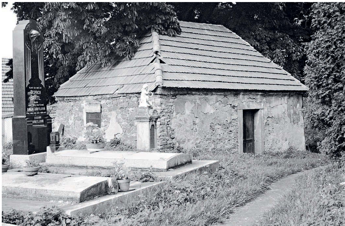
Obr. 18: Bylany, márnice u kostela sv. Bartoloměje, stav září 1987 (foto P. Vácha, fotoarchiv NPÚ ÚOP SČ v Praze).
