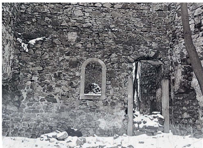
Obr. 11: Fotografie zachycuje některé otvory v prostorách hradu, které byly taktéž během historizující úpravy zřícenin opatřeny novogotickým ostěním (převzato z Muk – Novosadová 1976, přílohy).
