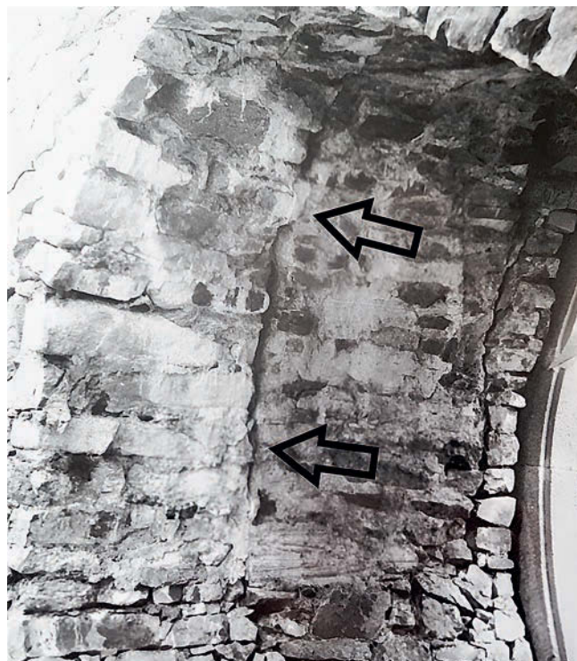
Obr. 10: Fotografie prostoru brány s dobře patrnou spárou (vyznačena šipkami), kde došlo během novogotické úpravy k dozdění líců zdiva (převzato z Muk – Novosadová 1976, přílohy, úpravy autor).
