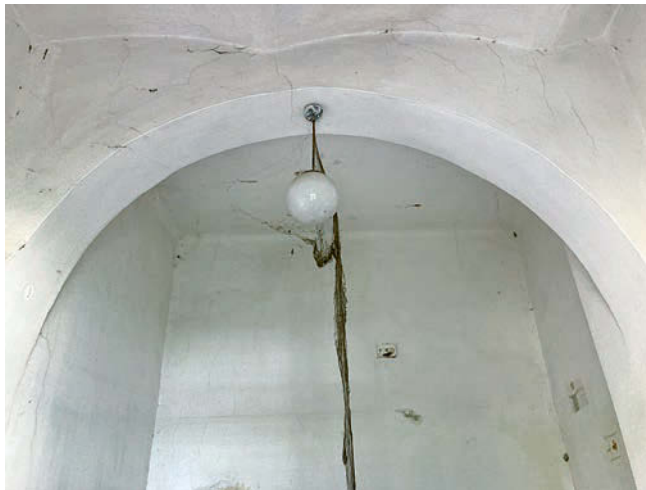
Obr. 30: Hořovice, Starý zámek, přízemí spojovacího traktu. Pohled na klenutý pas arkády. Nahoře strop mladší přístavby (č. 1.23) klenutý do travers, stav 2024.
