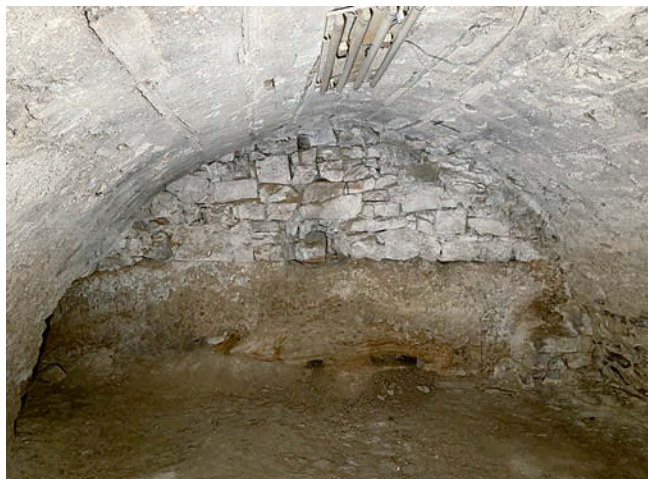
Obr. 18: Hořovice, Starý zámek, západní místnost (č. -1.01) v suterénu severního křídla. Uprostřed je dobře patrná základová spára starší západní hradby založené přímo na terénu v úrovni 1,20 m nad dnešní podlahou suterénu, stav 2024.
