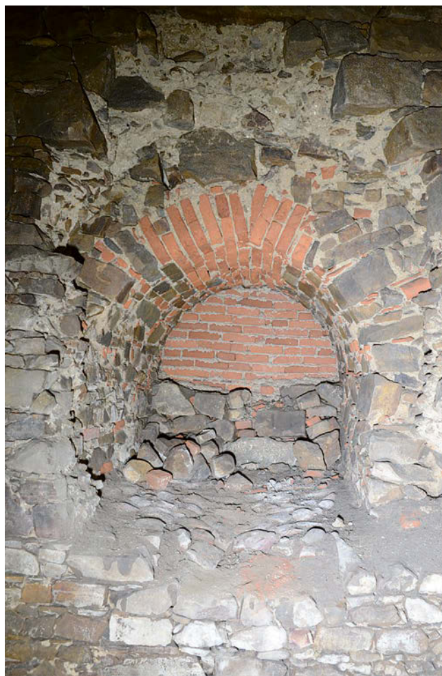
Obr. 14: Hořovice, Starý zámek, sklepení ve věži. Průraz západní stěnou z původní úrovně suterénu severního křídla uzavřený cihelnou zazdívkou z roku 1869, stav 2023.
