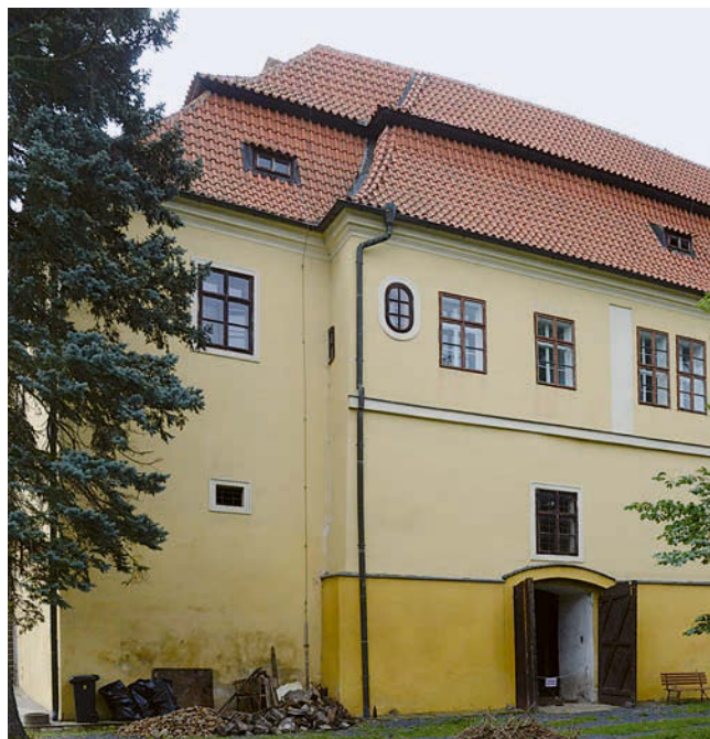
Obr. 7: Hořovice, Starý zámek, pohled od severu. Patrný je ústupek mezi severním a východním křídlem, odpovídající odsazení věže od severovýchodního nároží starší obvodové hradby, (všechny snímky J. Veselý, není-li uvedeno jinak, stav 2024).
