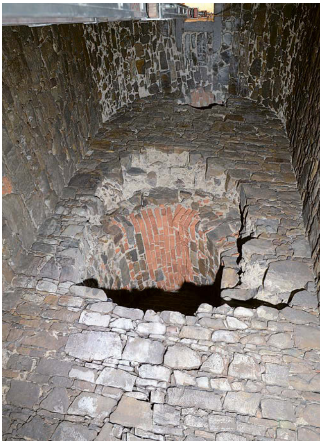
Obr. 12: Hořovice, Starý zámek, sklepení ve věži, pohled odspodu. Uprostřed průraz západní stěnou z původní úrovně suterénu severního křídla, nahoře průraz z přízemí severního křídla, zcela nahoře hasičský žebřík procházející otvorem v podlaze zvyšeného přízemí věže, stav 2023.
