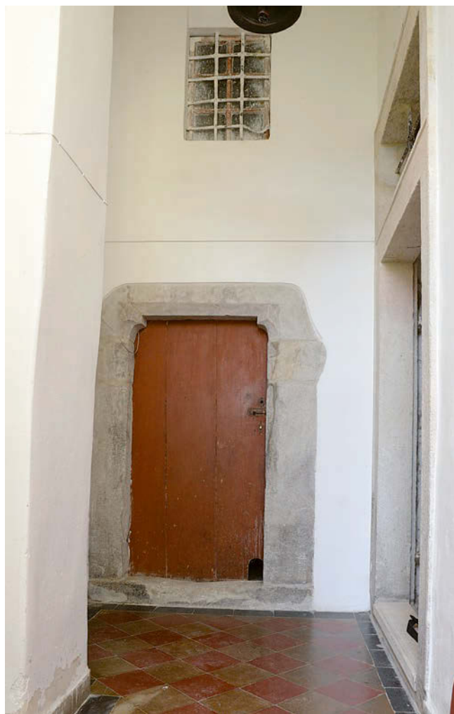
Obr. 24: Hořovice, Starý zámek, vstupní chodba (č. 1.01) ve spojovacím traktu. Pohled na pozdně gotický sedlový portálek a okno v jižní stěně severního křídla, ústící do místnosti č. 1.21, stav 2024.
