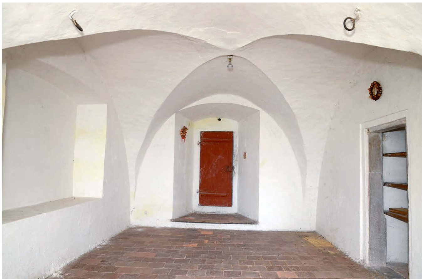
Obr. 26: Hořovice, Starý zámek, střední místnost (č. 1.20) v přízemí severního křídla. Vlevo široká nika ve východní příčné stěně, uprostřed nika s novějšími dveřmi v jižní stěně, vpravo nika s otočeným pozdně gotickým portálkem, stav 2023.
