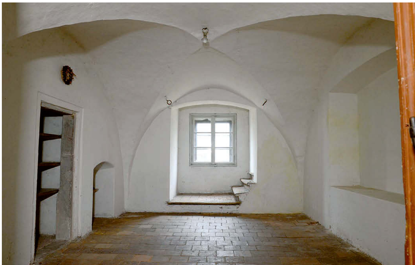
Obr. 25: Hořovice, Starý zámek, střední místnost (č. 1.20) v přízemí severního křídla. Vlevo nika s portálkem, uprostřed okenní nika se spodními stupni zazděného schodiště v severní stěně, vpravo široká segmentově klenutá nika ve východní příčné stěně, stav 2023.
