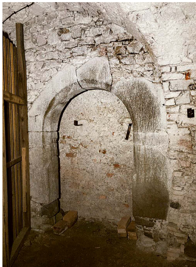
Obr. 17: Hořovice, Starý zámek, střední místnost v suterénu severního křídla. Zazděný portálek ve východní příčné stěně, stav 2024.
