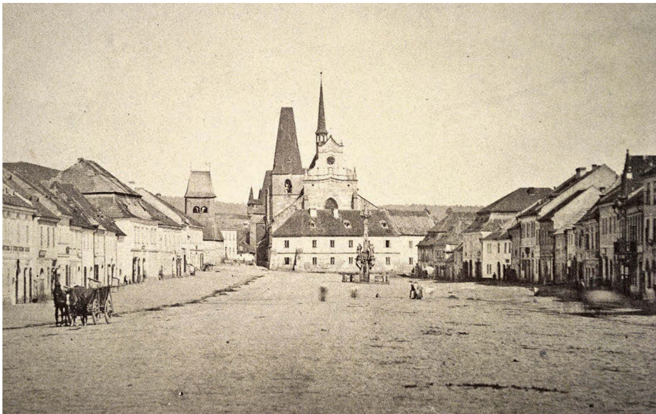
Obr. 7: Celkový pohled na kostel přes náměstí (od západu), průčelí kostela zakrývá budova staré školy, vlevo od kostela zvonice, za ním patrná Pražská brána, foto 1867 (Muzeum T. G. M. Rakovník, č. 1031).
