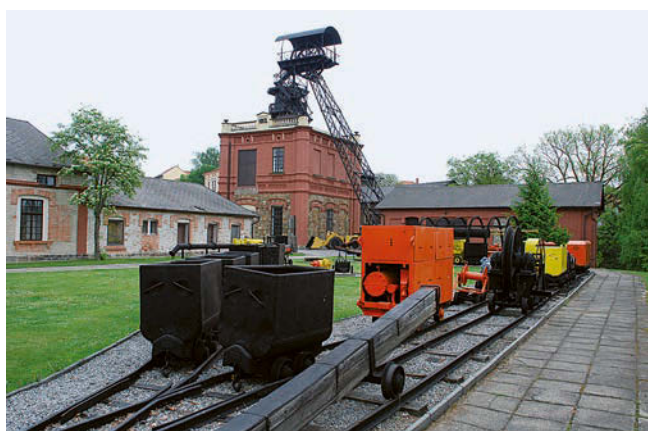
Obr. 15: Nádvoří dolu s expozicí důlní techniky. Vlevo v pozadí budova sypů – pozdější sokolovna v průběhu opravy, uprostřed šachetní budova s těžní věží a vpravo budova strojovny, stav 2009.
