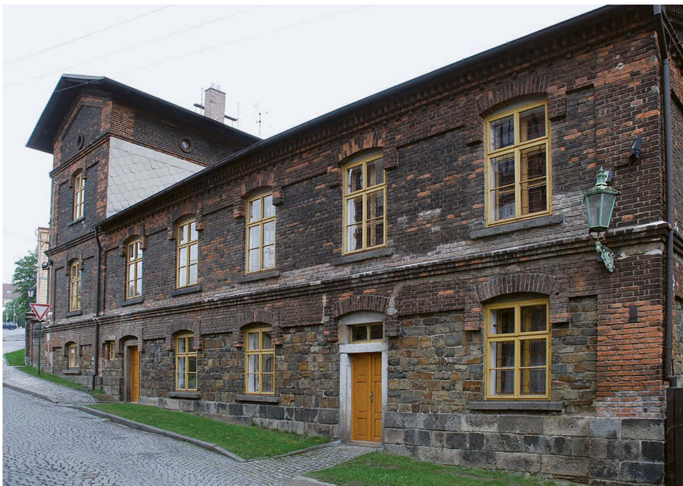
Obr. 13: Severní uliční průčelí budovy cáčovny se zachovalou fasádou z režných cihel a kamenného zdiva, stav 2009.
