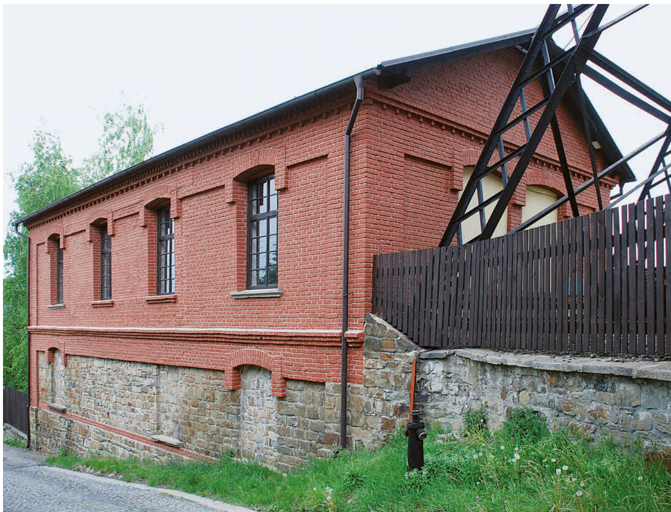
Obr. 11: Budova strojovny od jihovýchodu, stav 2009.
