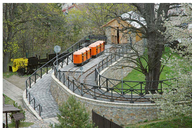
Obr. 16: Nově postavená nástupní stanice úzkokolejné dráhy, rekonstruované v trase ulice Pod Struhami k bývalé úpravně u dolu Vojtěch, stav 2007.
